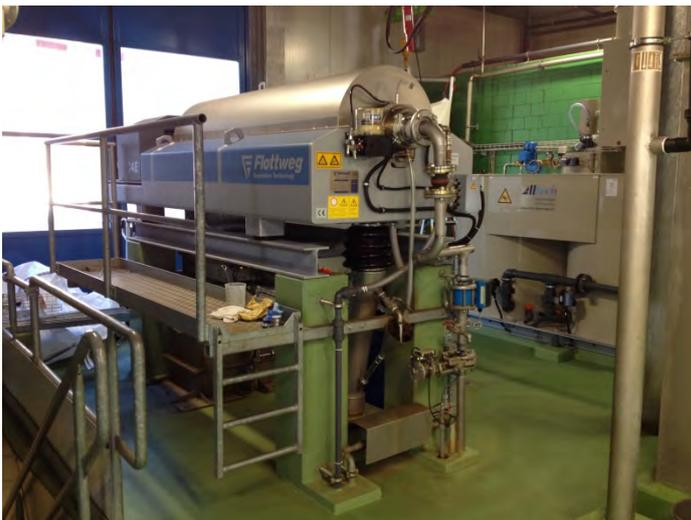
*Neue Zentrifuge zur Schlammentwässerung.*
