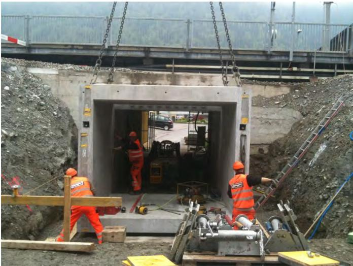
*Einschieben der Fertigbetonelemente für die Unterführung.*
