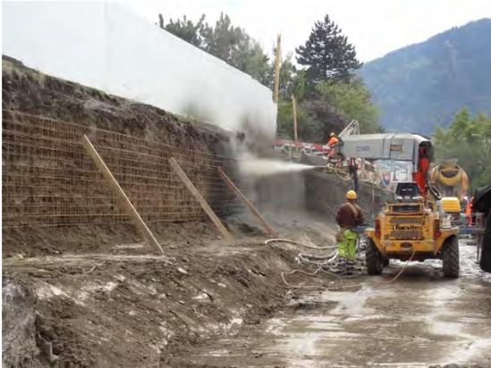
*Baugrubensicherung mit Spritzbeton.*
