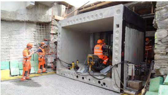
*Einschieben der Fertigbetonelemente für die Unterführung.*
