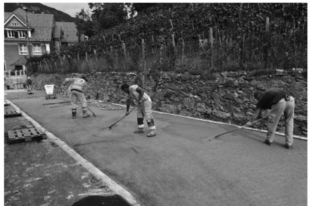
Ausfügen der Pflasterung mit Traskalk.
