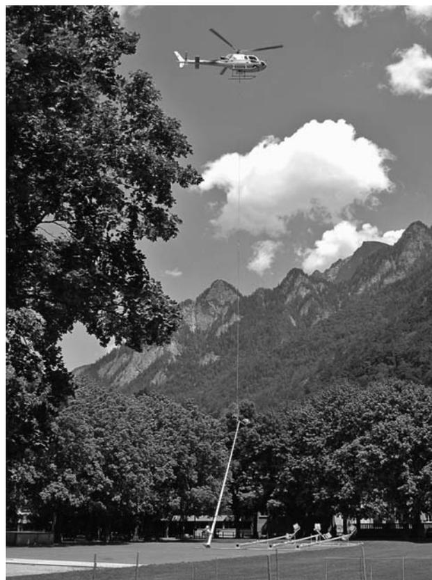
Versetzen der Kandelaber mit Helikopter.
