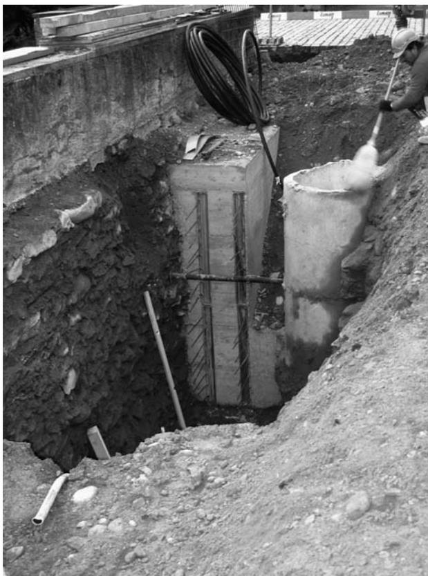
*Etappenweise Hinterbetonierung und Sicherung der Stützmauer.*
