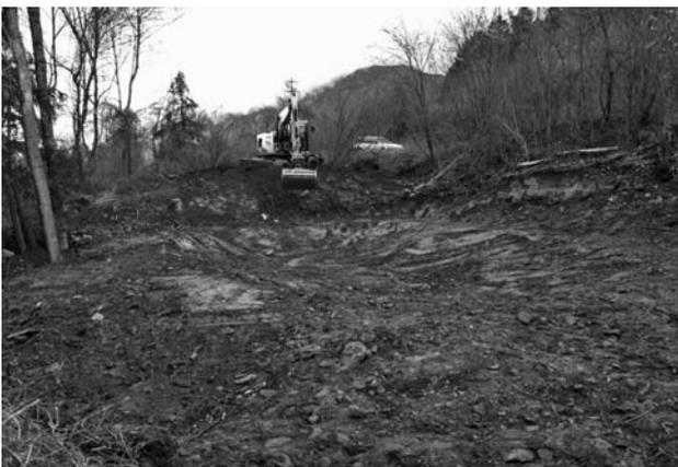
Weihermodellierung mit Hydraulikbagger.
