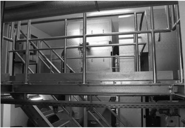
Rauchgasreinigungsanlage im Dachgeschoss des Krematoriums.
