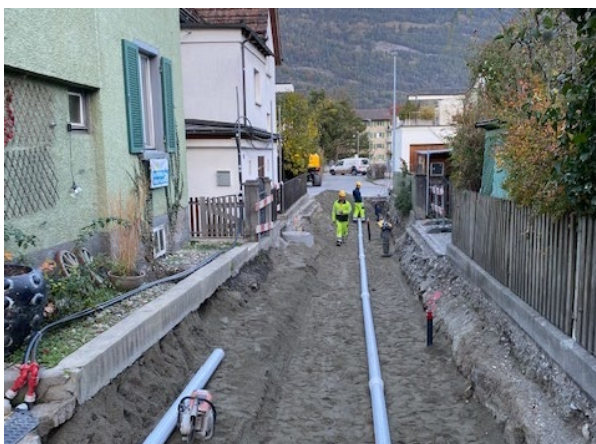
Verlegen der Rohre für Steuerung der Fernwärme
