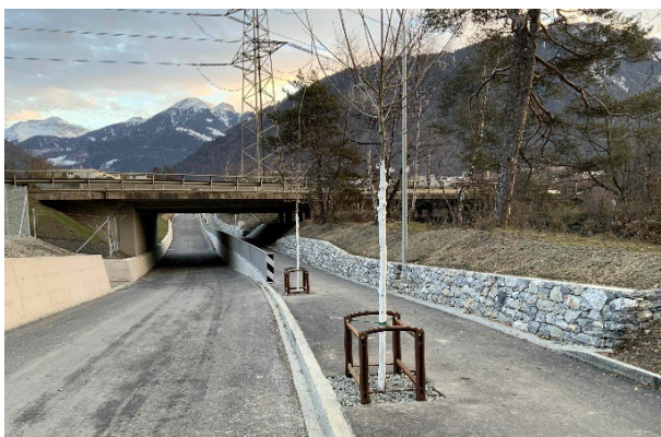
Neu erstellte Unterführung Blickrichtung Stadt
