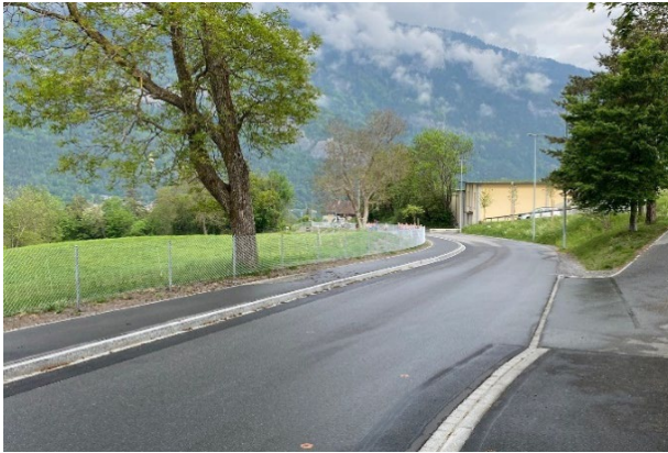
Fertig erstelltes Trottoir Blickrichtung Jüstliweg
