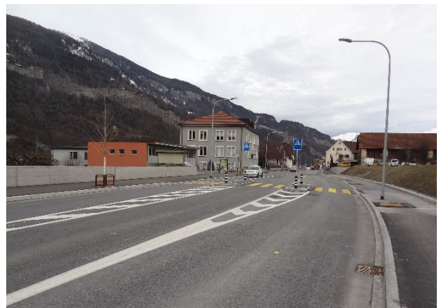
Fussgängerübergang mit zwei Verkehrsinseln
