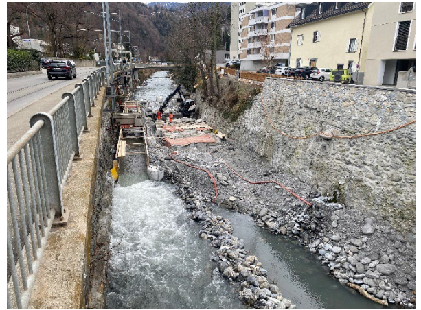
Umleitung der Plessur in einem Kanal
