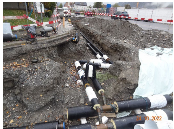
Neubau Fernwärmeleitung der IBC
