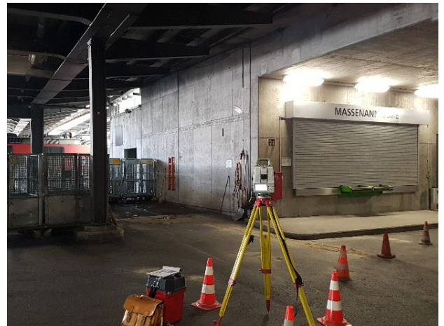
Bestandesaufnahme mit 3D-Laserscanner, Tivolibrücke
