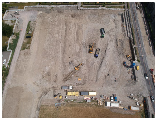
Baugrubenaushub
