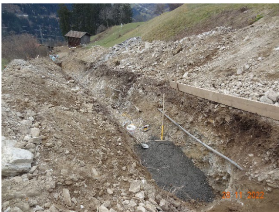
Graben für die neue Abwasserleitung
