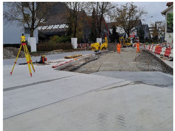
Vorarbeiten für den Belageinbau
