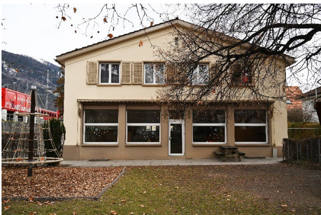
Südfassade mit neuem Dachkranz
