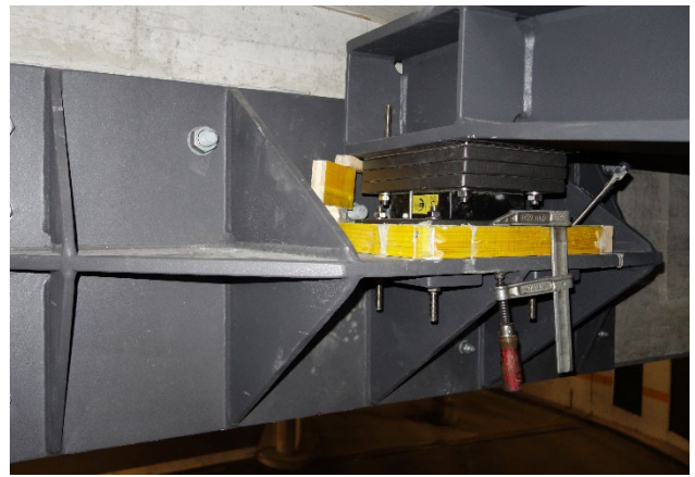
Untergossenes Elastomerlager
