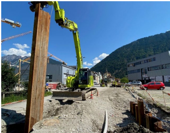
Arbeiten mit Spundwänden
