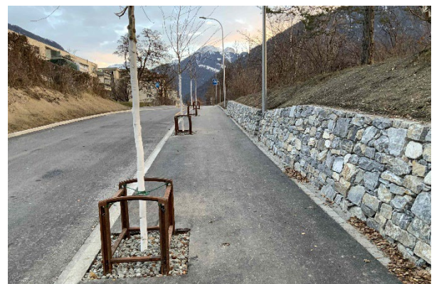
Neu erstelltes Trottoir mit Natursteinmauer
