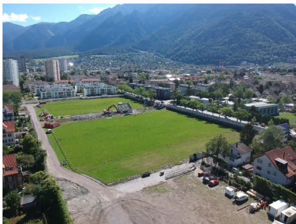
Abtragung und Rückbau bestehender Sportplatz Ringstrasse
