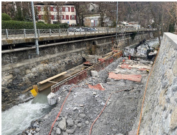
Umleitung der Plessur in einem Kanal
