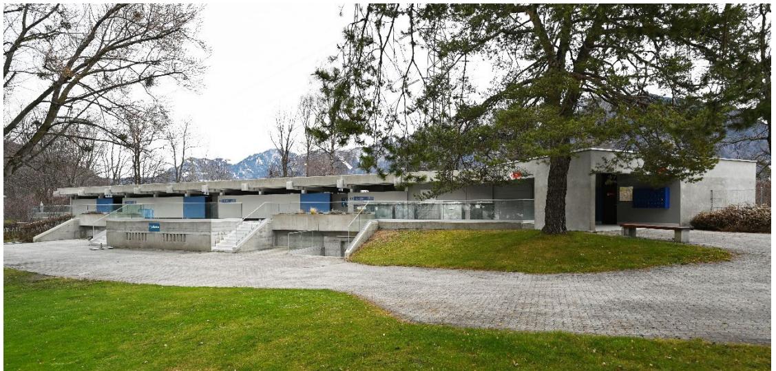
Westfassade mit Treppenaufgängen zu den Garderoben und Duschen
