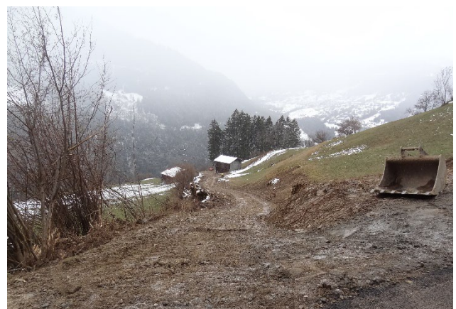
Instandstellung Gelände nach Einbau der Leitung
