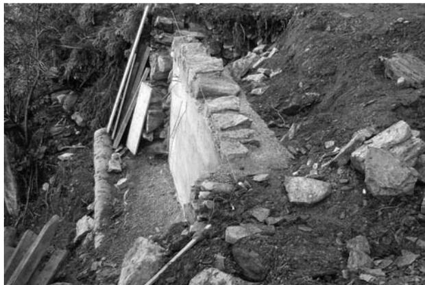
*Instandstellung einer alten Trockensteinmauer am Heckenhüttenweg.*
