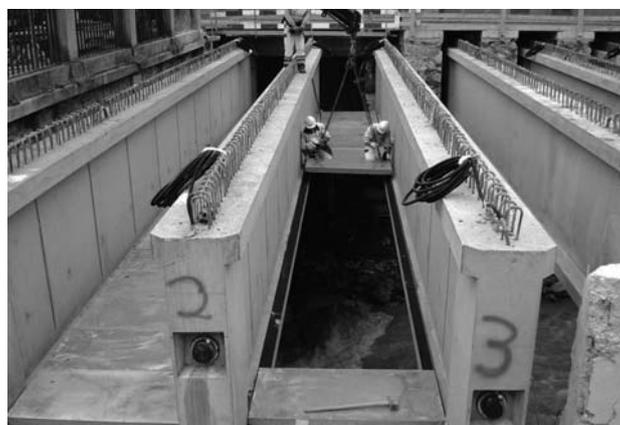
Versetzen der vorfabrizierten Stahlbetonträger.
