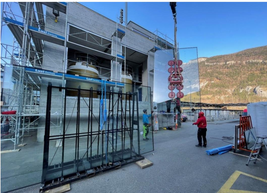
Silogebäude, Einbau neue Glasfassade mit deutlich besserer Wärmedämmung
