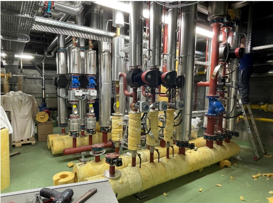
Heizverteilung mit Hoch- und Niedertemperaturwärmetauscher (Hintergrund)
