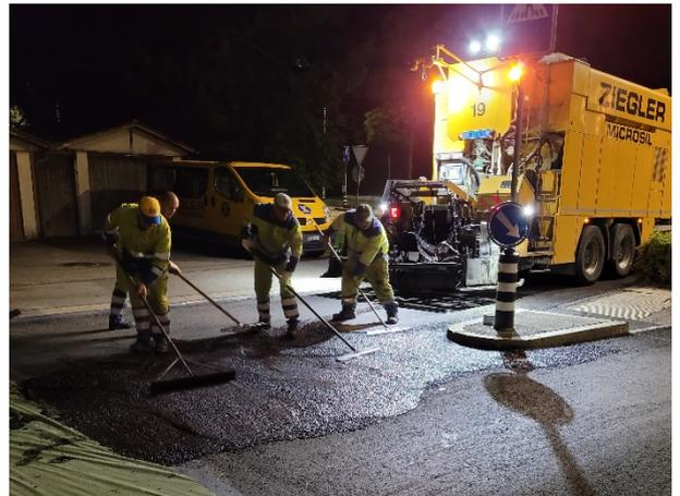
Einbau Kaltmicrobelag im Kreisel Ring-/Pulvermühlestrasse
