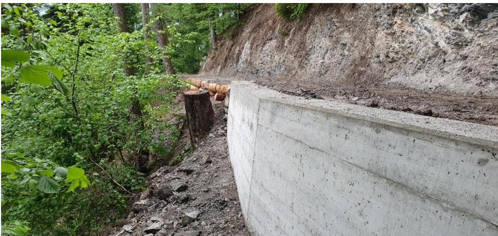
Valpargheraweg, sanfter Ausbau in Eigenregie ausgeführt. Alte Bruchsteinmauer ersetzt mit Betonmauer, alter Holzkasten mit Neuem.
