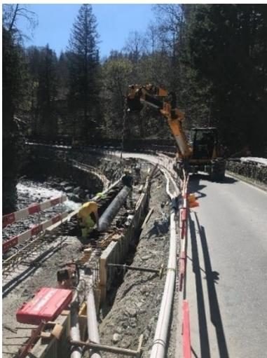
Neue Abwasserleitung integriert unter dem Kragtrottoir
