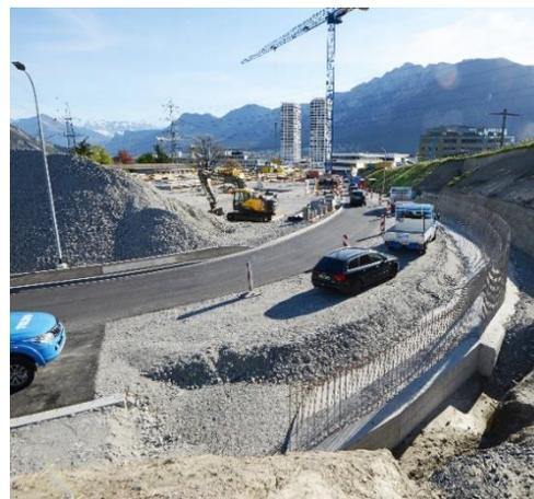
Erschliessung Trist, Anschlussbewehrung Stützmauer
