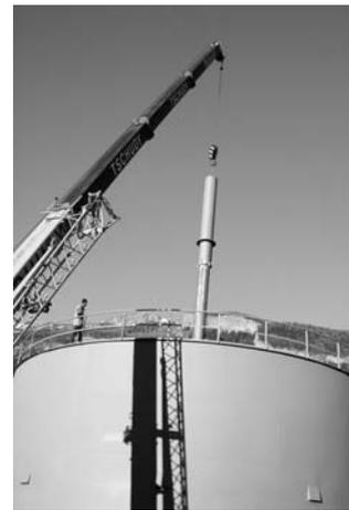
Reparaturarbeiten am Gasometer, Ausbau des Teleskops.
