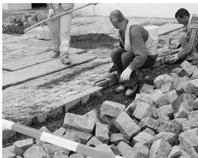
Auf engstem Raum werden Werkleitungen erneuert und anschliessend die Pflasterung verlegt.
