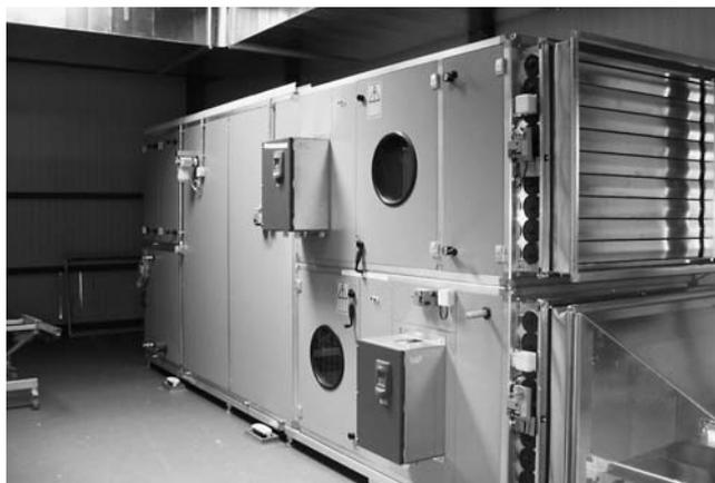
Neue Lüftungsanlage der Sportanlagen Obere Au (Monoblock).
