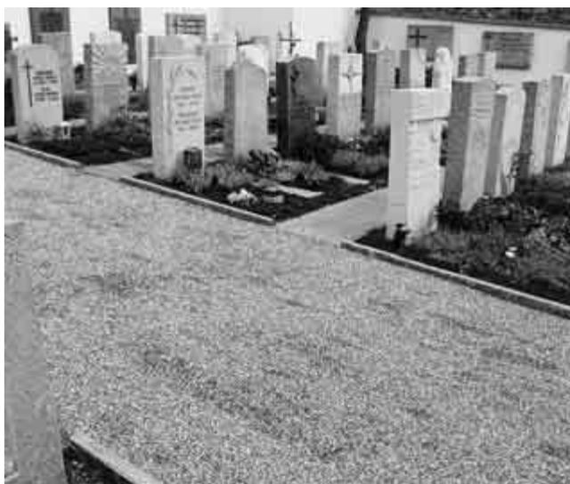
Neue Naturstellplatten, Wegplatten und sanierte Wegfläche.
