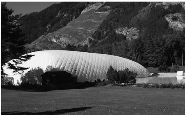
Traglufthalle über dem Schwimmbecken im Freibad Obere Au.
