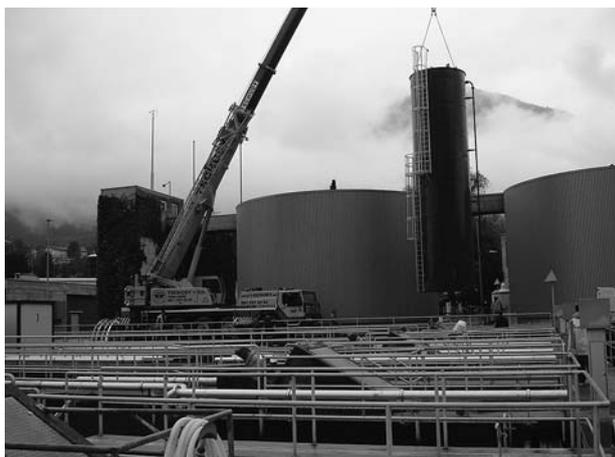
Lagersilo für gelöschten Kalk bei der Montage.
