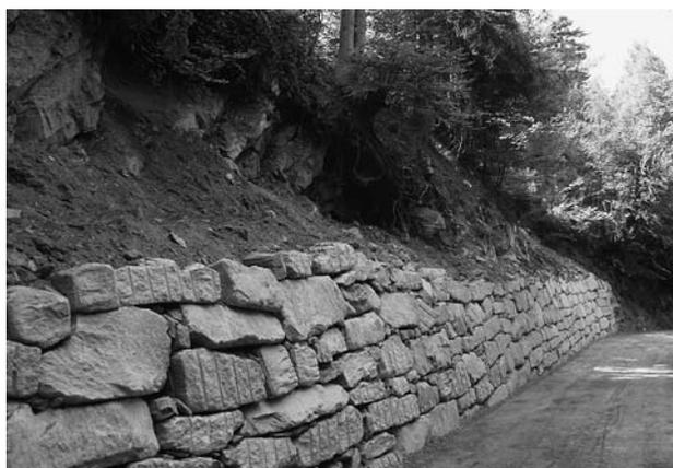
*Instandstellung Erschliessung: Eine neue Blocksteinmauer sichert am Juchserweg Böschung und Trasse.*
