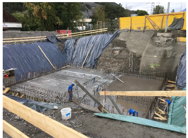
Bodenplatte Energie HUB
