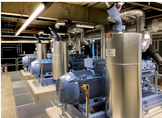
Neue Kältekompressoren
