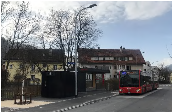
Neuer Personenunterstand Bus und öffentliches behindertengerechtes WC
