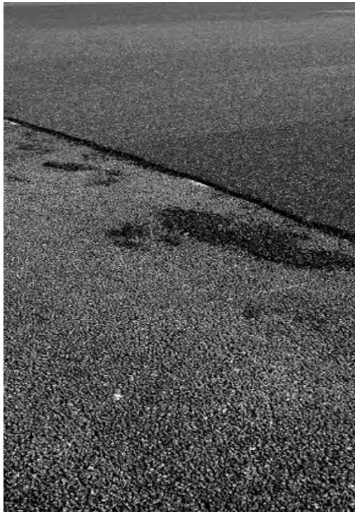
Sickerasphaltschicht mit Elastiktragschicht
