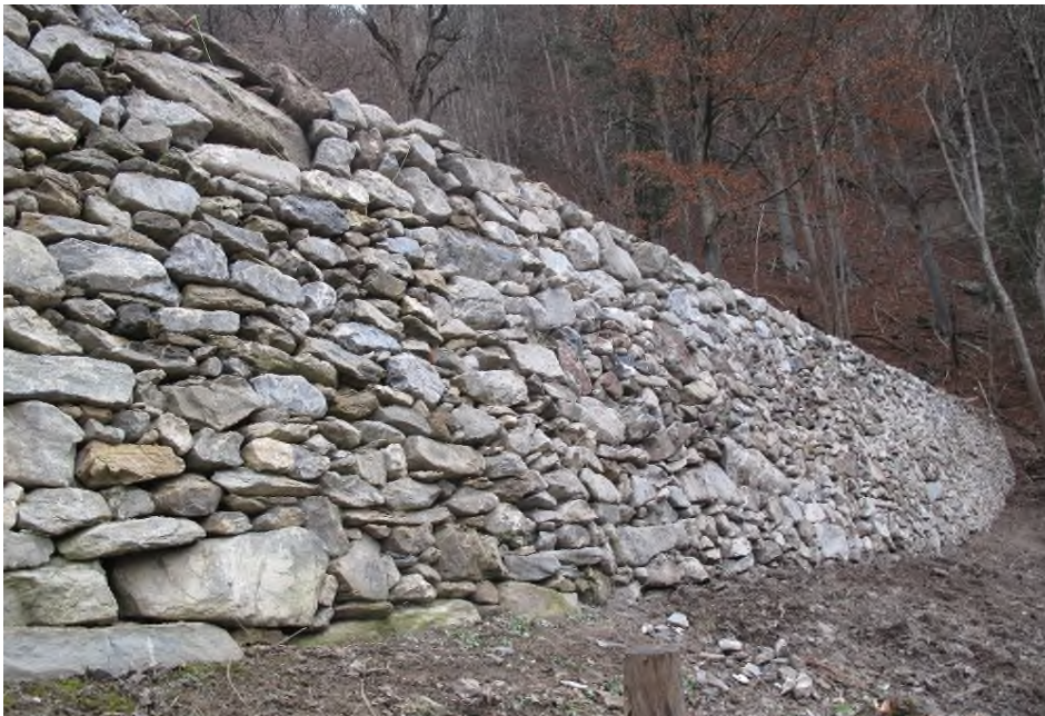
Fast 4 m hohe Trockenmauer im Seidengut nach der Sanierung
