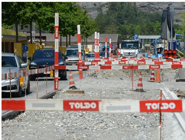
Verkehrsführung während Baustelle
