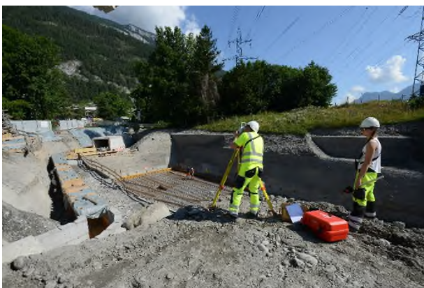
Aufnahme Baugrube Regenrückhaltebecken Obere Au
