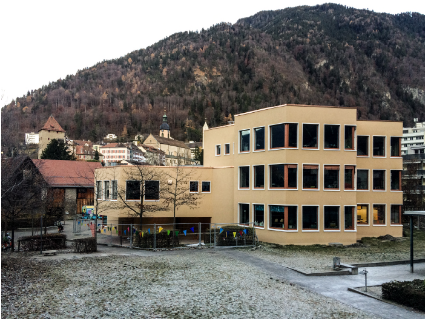
Neue Fassade Schulhaus Türligarten
