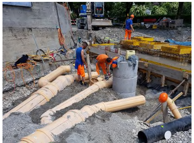
Pumpendruckleitungen Abwasserpumpwerk
