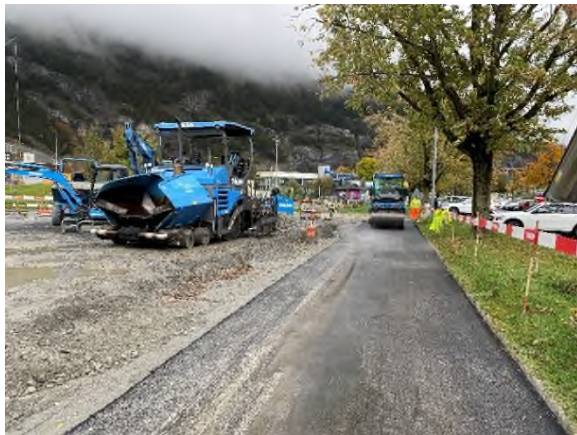
Belagseinbau LV Obere Au
