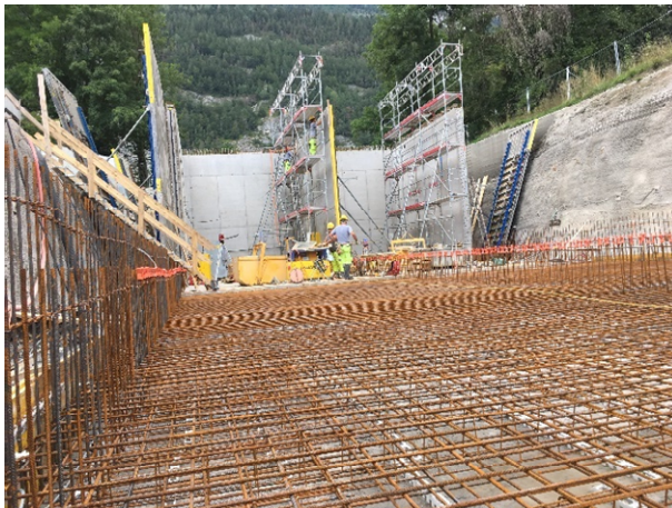
Betonierarbeiten Regenbecken Obere Au
