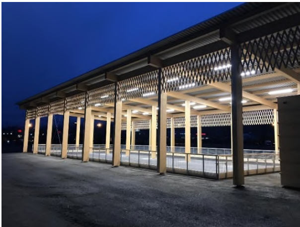
Boccia-Anlage mit vier Spielbahnen
