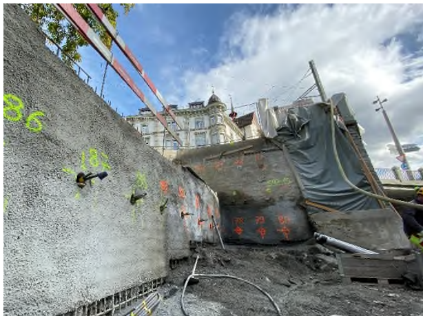
Baugrubensicherung Seite Obertor
