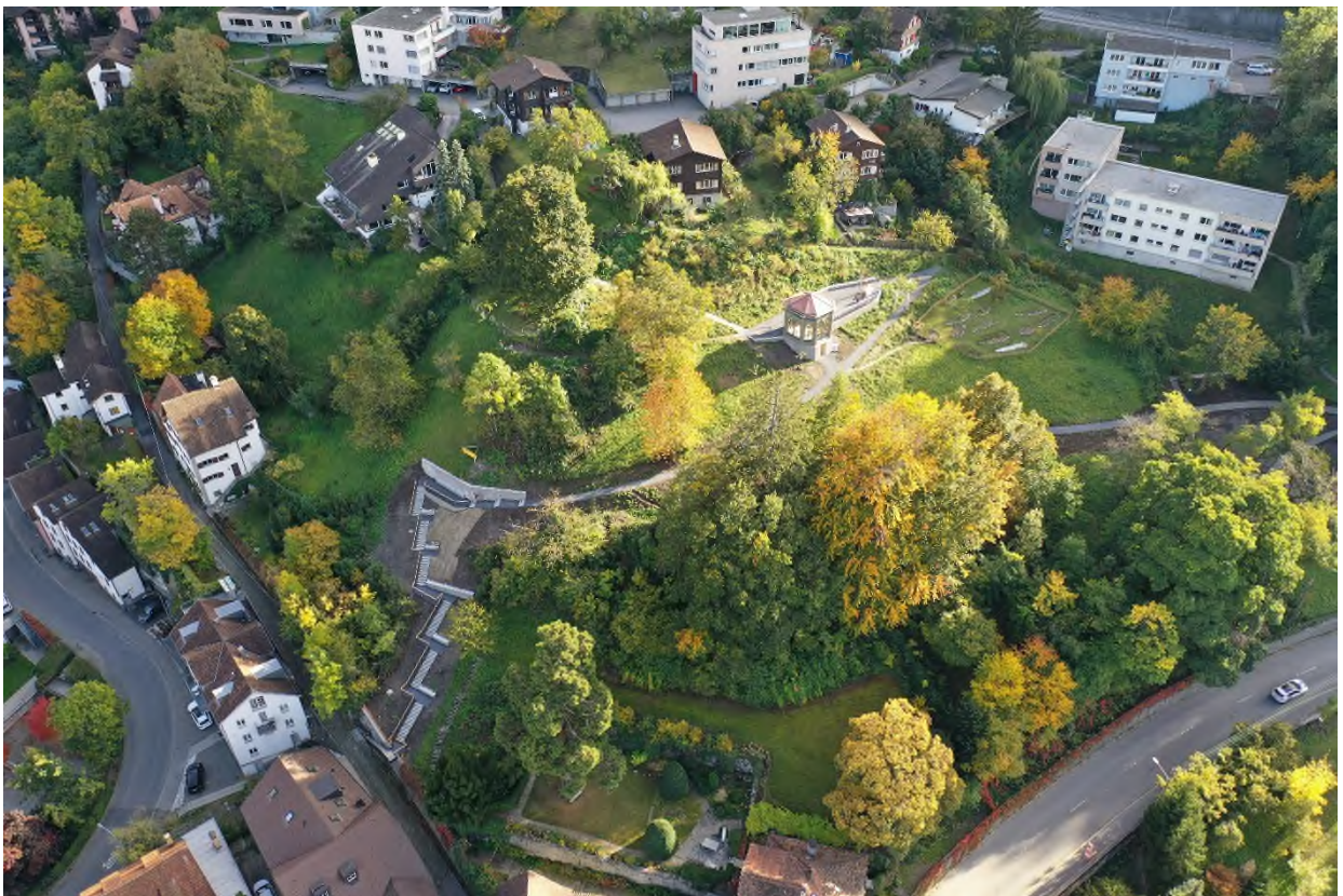
Luftaufnahme mit fertiggestelltem Treppenaufgang und Gabentempel, Herbst 2019
