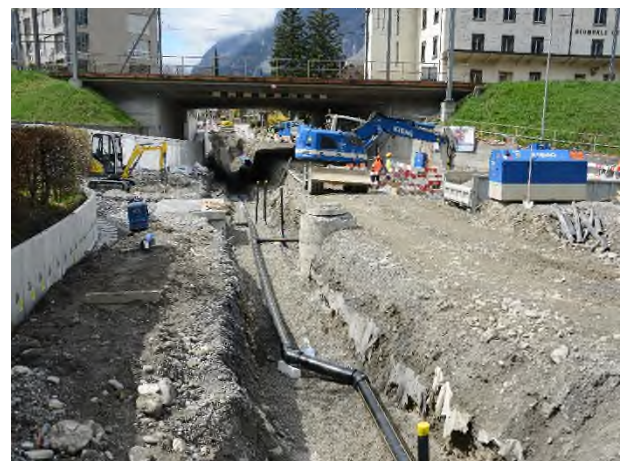
Einlegen Werkleitungen
