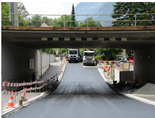
Einbau Tragschicht
