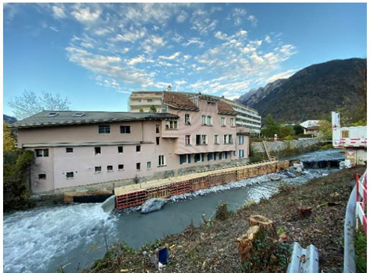
Wasserhaltung für den Bau der Blocksteinrampe
