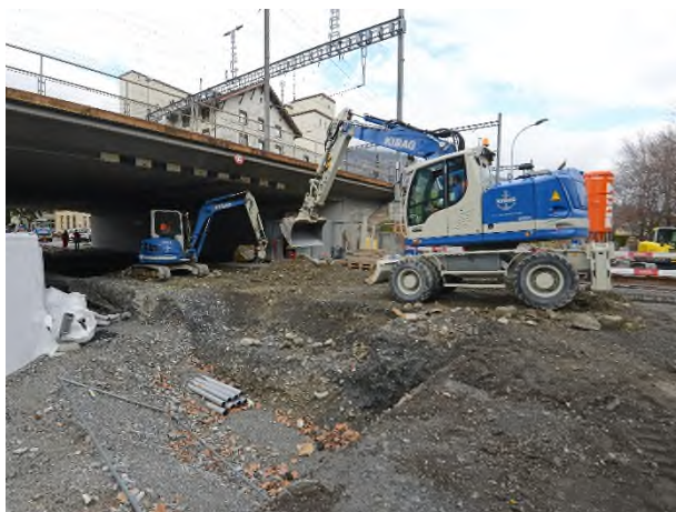
Aushubarbeiten Unterführung
