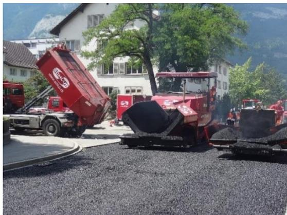
Verlegen der Asphaltarmierung und Belagsarbeiten
