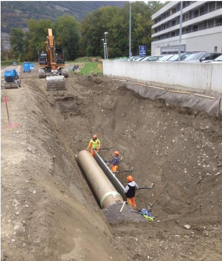
V-Grabenprofil mit Abwasserleitung 900 mm
