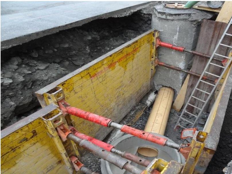
Bestehender Kanalisationsschacht mit Verbindung zu neuem Bodenelement/Kontrollschacht
