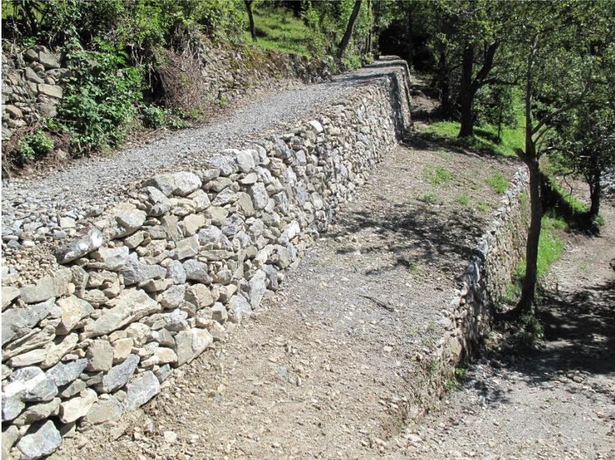
Sanierte Trockenmauern entlang der Alten Schanfiggerstrasse
