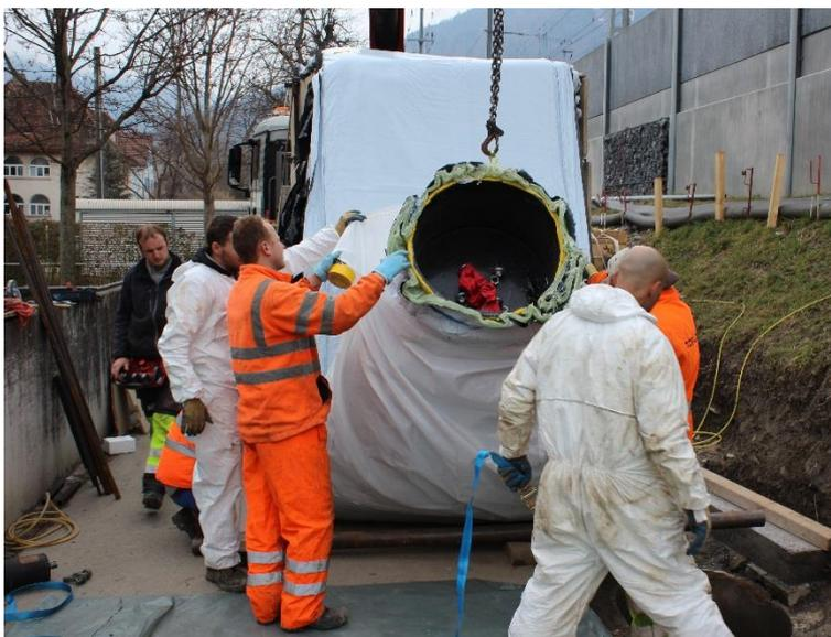
Einziehen des Inliners in die Kanalisation
