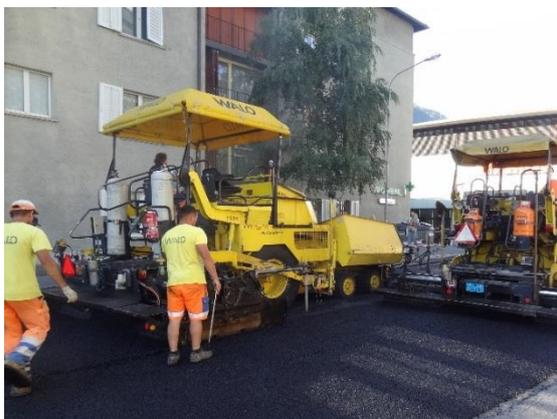
Einbau des Asphaltbelages (Stützgerüst)
