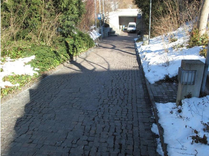
Turnhallenzugang mit defekter und loser Porphyr-Pflasterung vor der Sanierung
