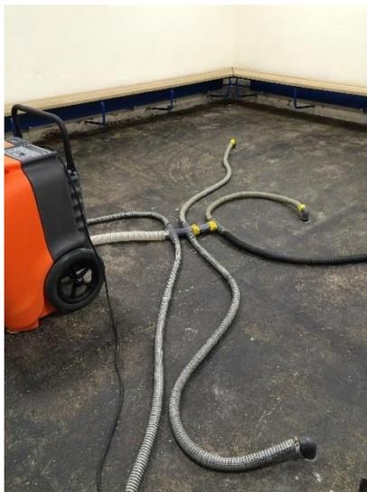
Trocknungsgeräte nach Wasserschaden
