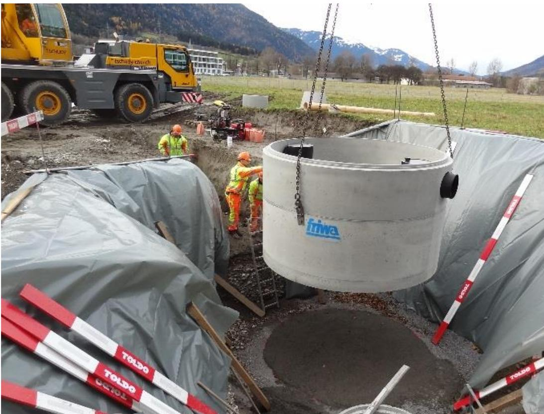
Ölabscheider vorgelagert dem Sickerschacht
