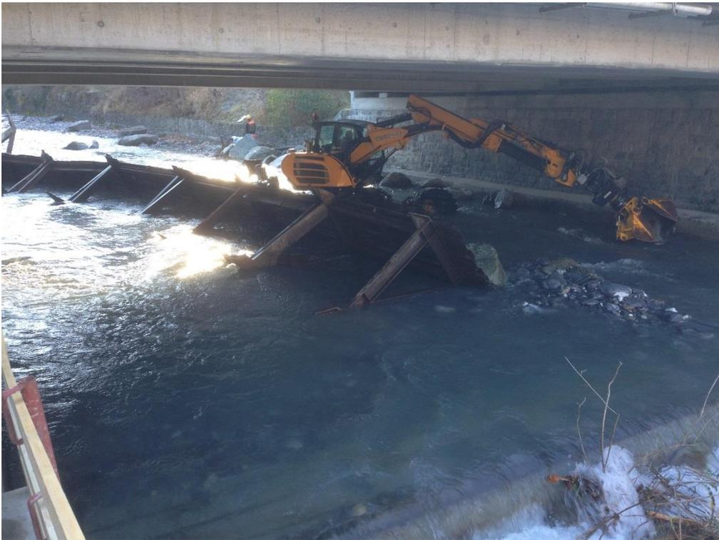
Wasserhaltung für die Sanierungsarbeiten
