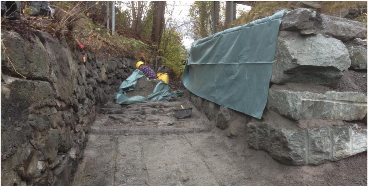
Auslaufbauwerk mit neuer Sohle und Vermauerung mit schweren Granitsteinen
