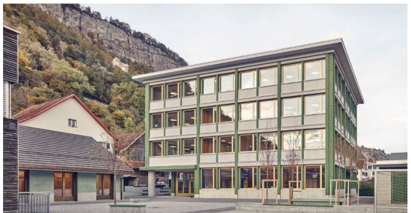
Neubau Schule und Kindertagesstätte Haldenstein (Lucas Murer)
