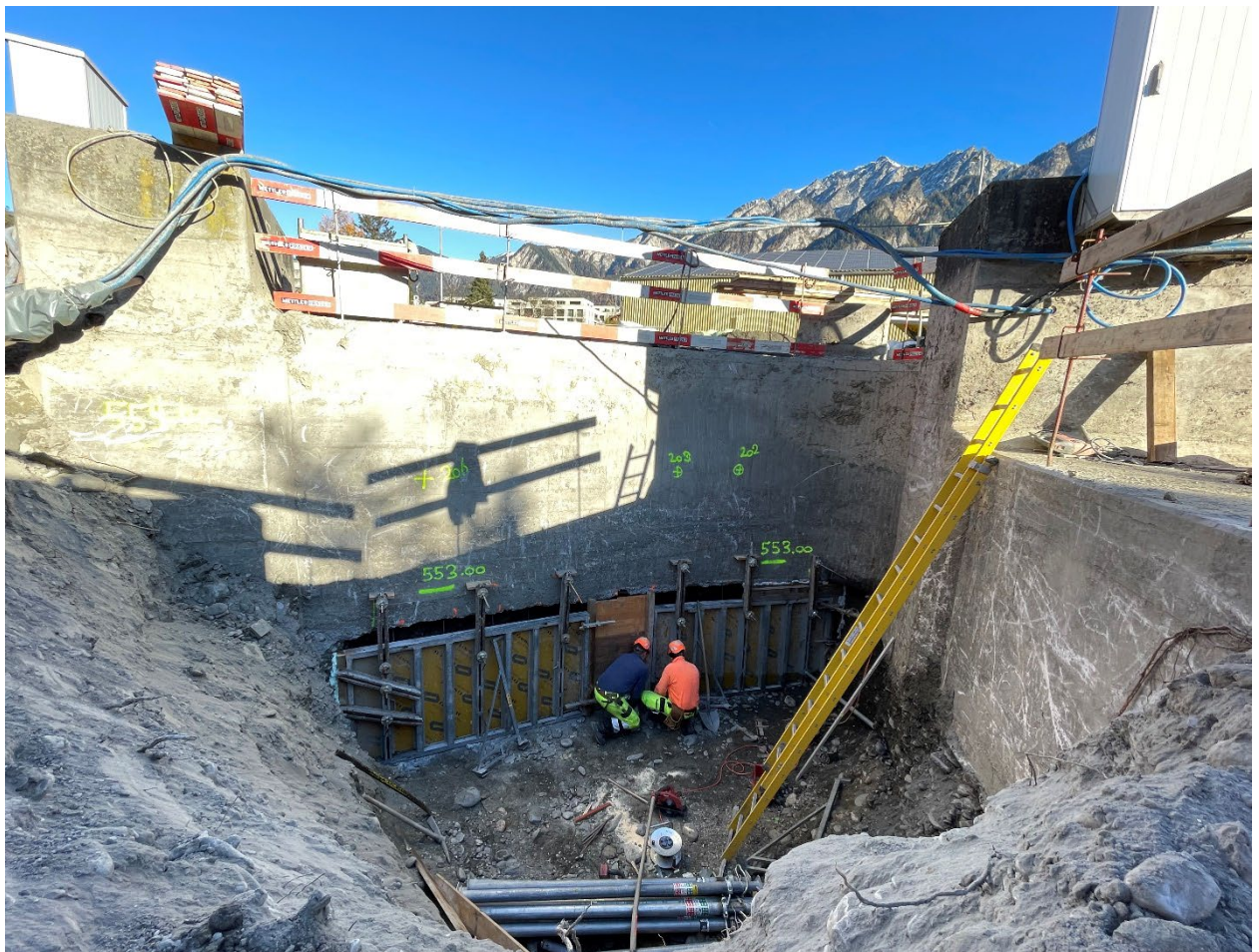
Unterfangen des bestehenden Zuflusskanals zum Regenüberlaufbecken
