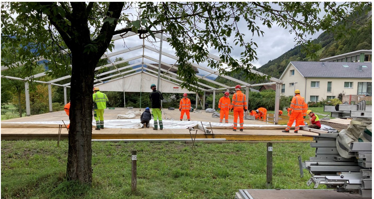
Aufbau der Infrastruktur in Haldenstein (Quelle: Werkbetrieb)
