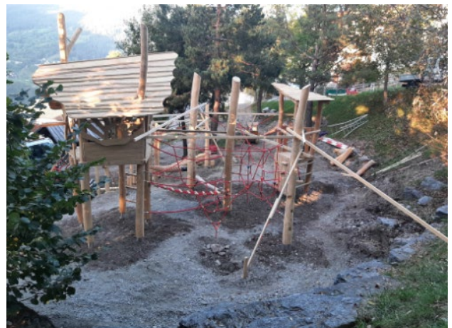
Spielplatz Maladers während des Baus
