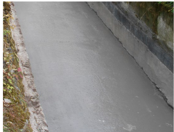
Sanierter Zulaufkanal Pulvermühle
