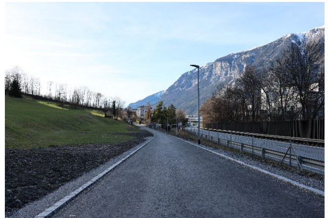
Foralweg mit neuer öffentlicher Beleuchtung
