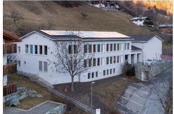
Süd- und Westfassade nach Gebäudehüllensanierung
