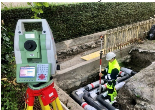
Aufnahme Fernwärmeleitung Loëstrasse
