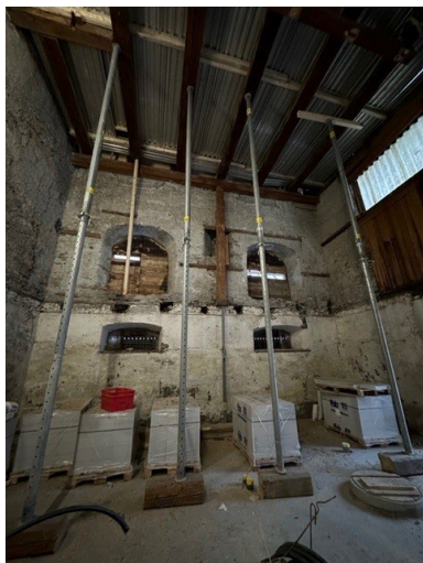
Deckenarbeiten für die Gruppenräume
