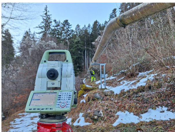
Überwachungsmessung Wasserleitung Malixerstrasse
