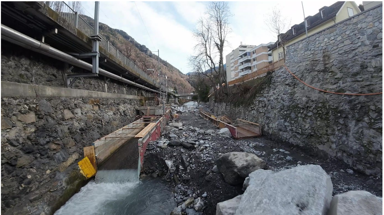
Wasserhaltung für Blockrampenbau bei km 2.809
