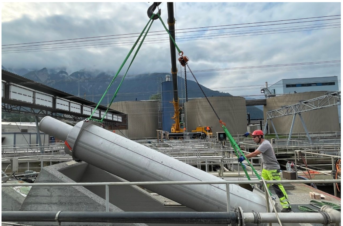
Einbau der neuen Rücklaufschlammumpen in sanierten Betontrög
