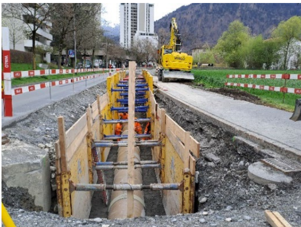
Verlegung Kanalisation DN 1100
