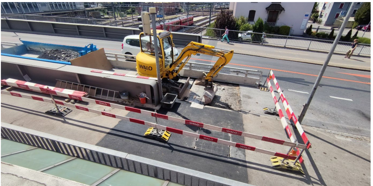
Tivolibrücke, Erneuerung Fahrbahnübergang Seite Neustadt
