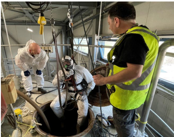
Eintritt ins Silo nur mit geprüfter PSA und durchgehender Überwachung
