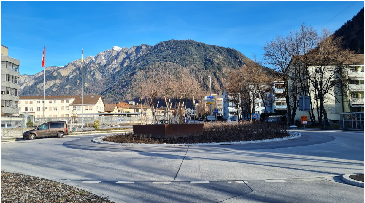
Neuer Betonkreisel Kasernenstrasse/Ringstrasse mit neuer Gestaltung Innenkreisel
