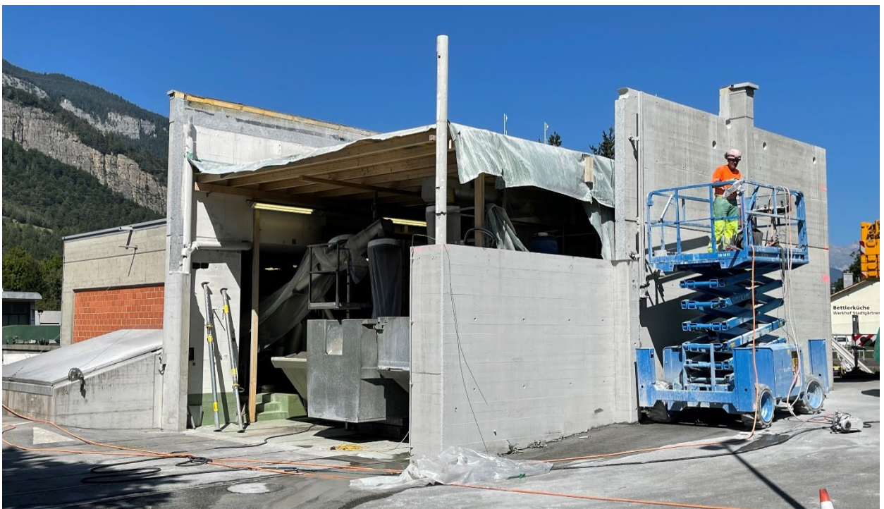
Abbruch Rechengebäude, Holzverslag im Innern als Witterungsschutz
