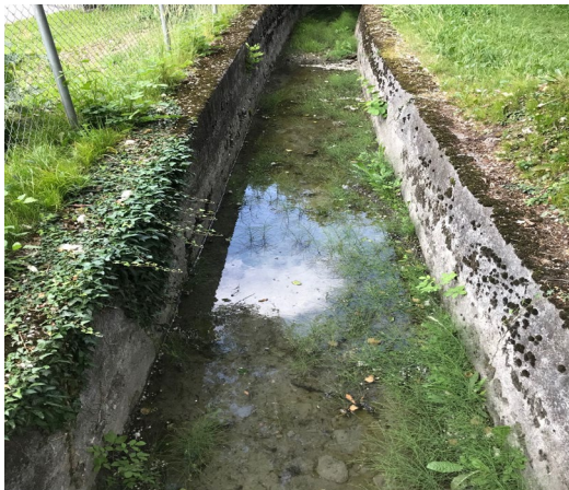
Alter Zulaufkanal Pulvermühle
