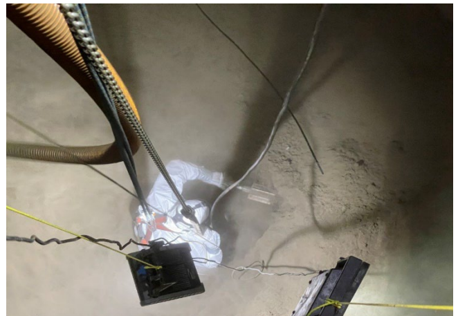
Arbeiten im Trockengranulat-Silo unter erschwerten Bedingungen
