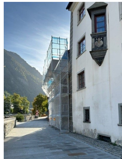
KITA Türligarten im Gerüst plessurseitig
