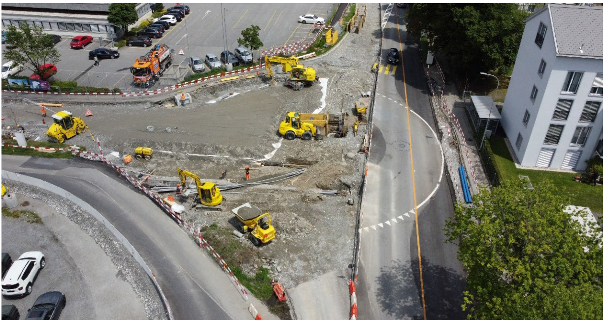
Bau des neuen Kreisels Kasernenstrasse/Ringstrasse
