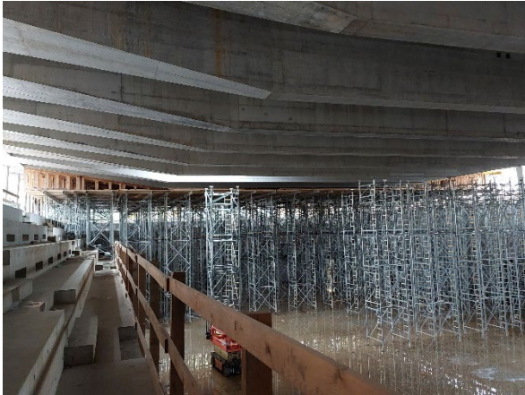
Träger mit Leererüst 3-fach-Turnhalle, 24.11.2023
