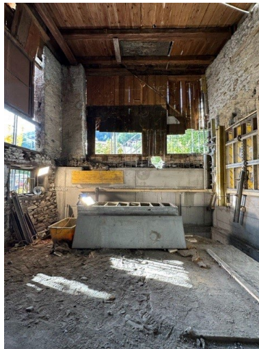
Das Fundament für den Lift steht
