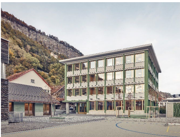
Südostansicht Schulhausneubau Haldenstein mit Mittagstisch
