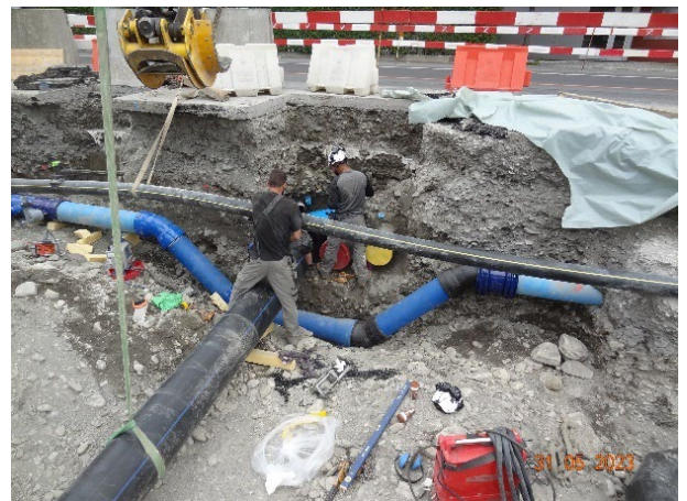
Verlegung der Werkleitungen Ringstrasse
