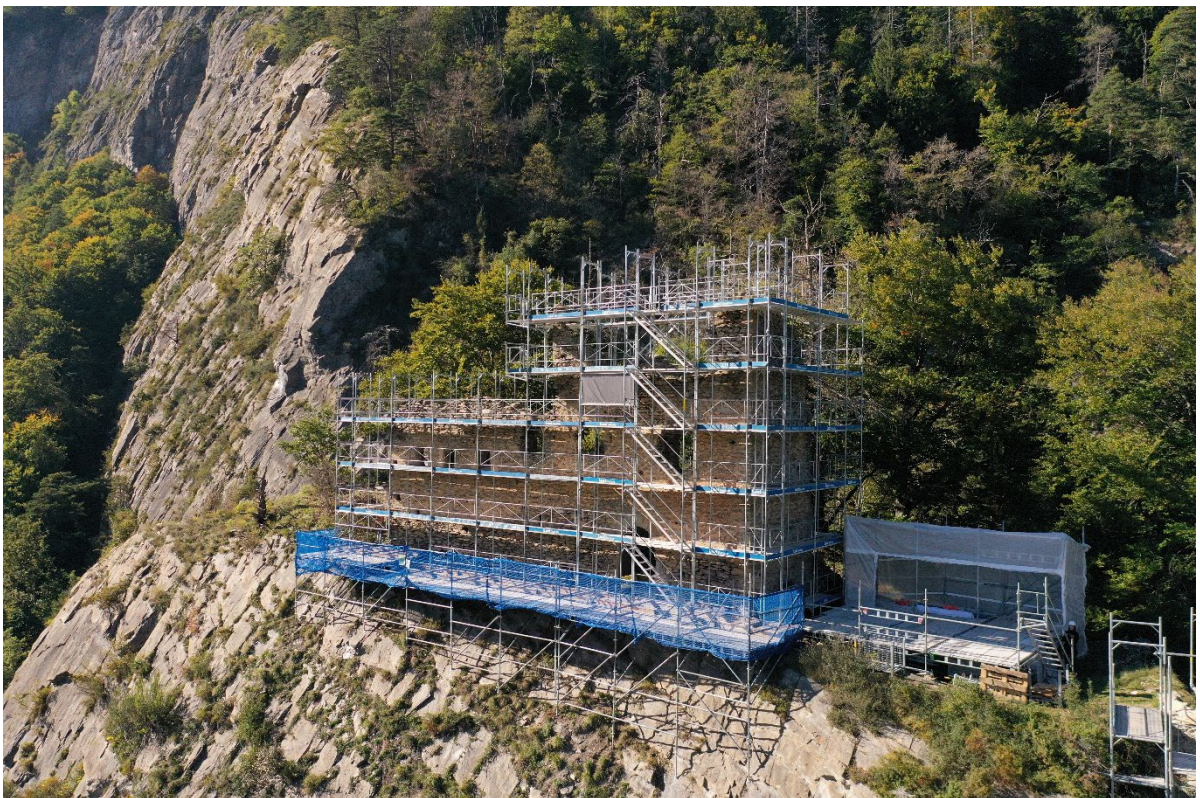
Burgruine Lichtenstein im Gerüst
