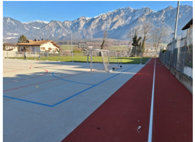
Neben dem Allwetterplatz wurden die Laufbahn, der Ballfang und die Aussenbeleuchtung saniert
