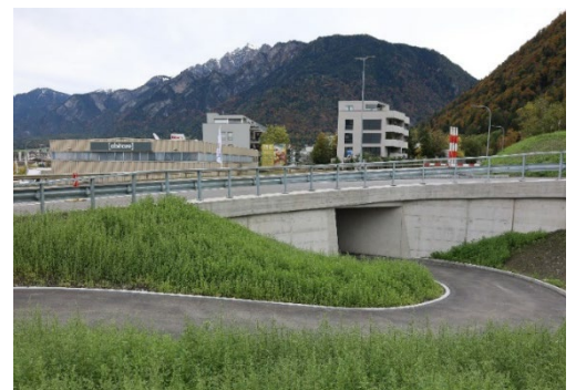
Fertig erstellter Veloweg, Unterführung Trist
