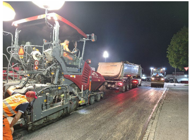
Deckbelagseinbau Haldenstein
