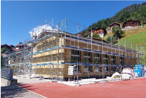
Süd- und Ostfassade im Baugerüst
