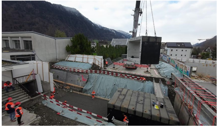
Unterirdischer Verbindungstunnel zwischen Schulhaus Herold und der Schul- und Sportanlage Ringstrasse
