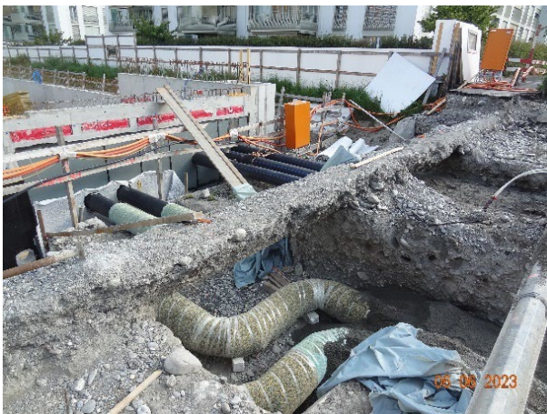
Fernwärmeleitungen Ringstrasse
