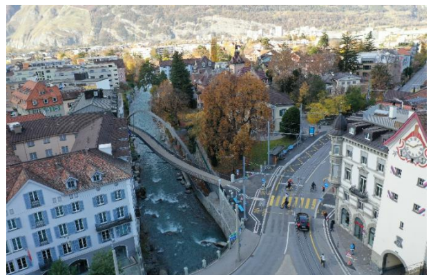
Italienische Brücke mit Fussgänger-Lichtsignalanlage
