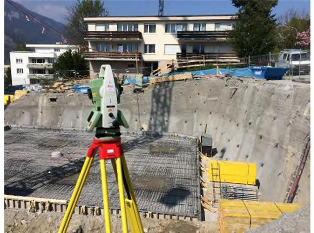
Deformationsmessung Baugrube Carmennaweg
