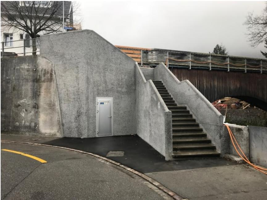
Neuer Treppenaufgang mit integrierter Verteilkabine EW der IBC
