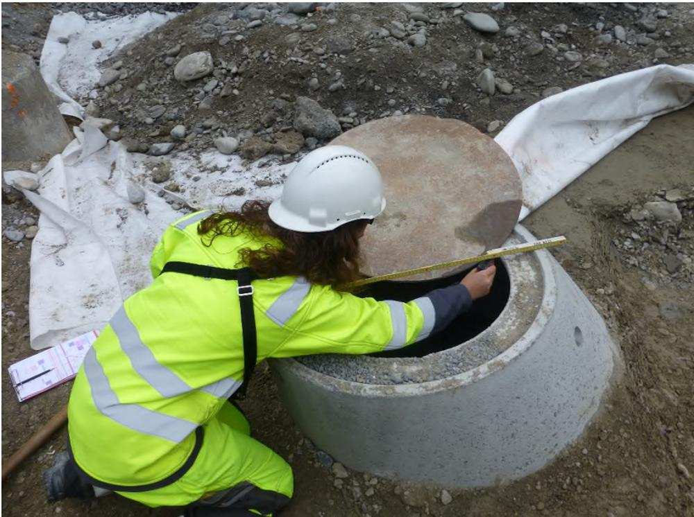
Einmessen der Sohlenhöhe im Abwasserschacht mit einem Leica Distometer
