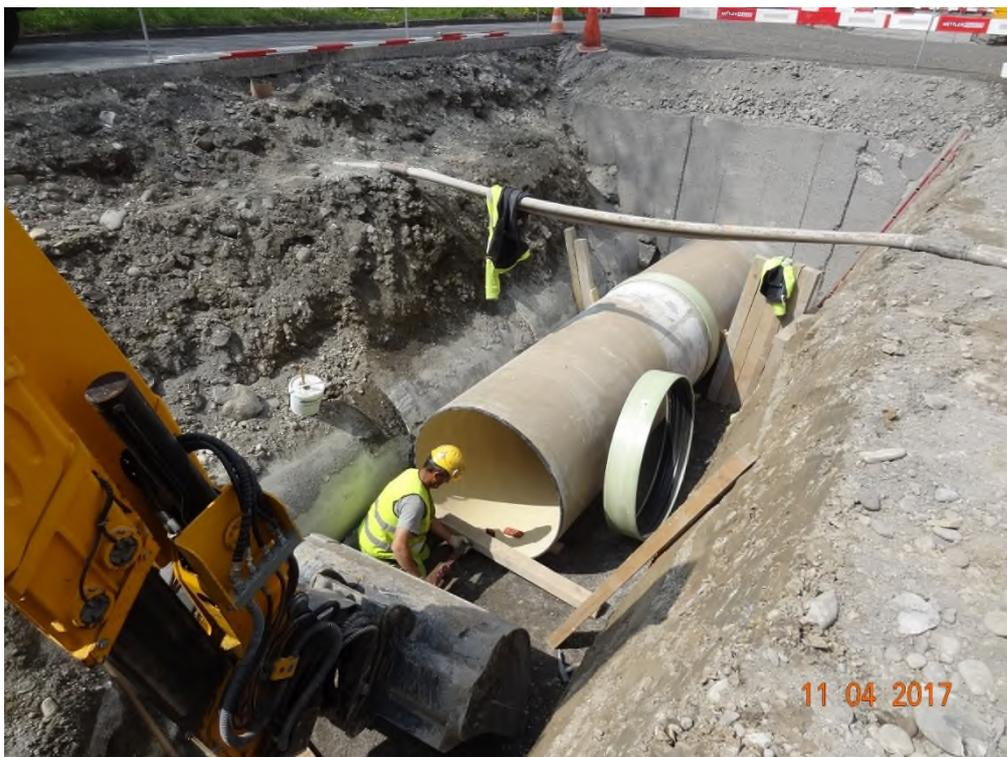
Die neue Abwasserleitung aus GFK mit dem eindrucklichen Durchmesser von 1200mm entsteht in einem V-Graben
