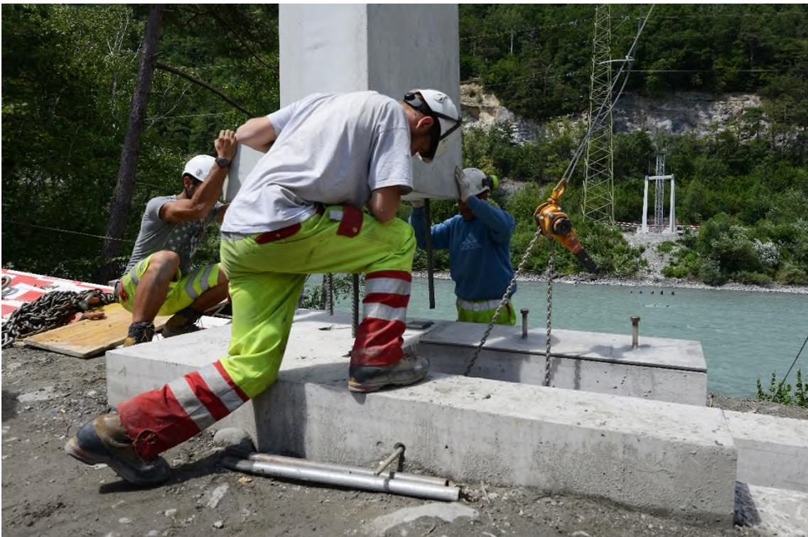
Montage der Pylone die als Tragelemente der Hängeseile dienen
