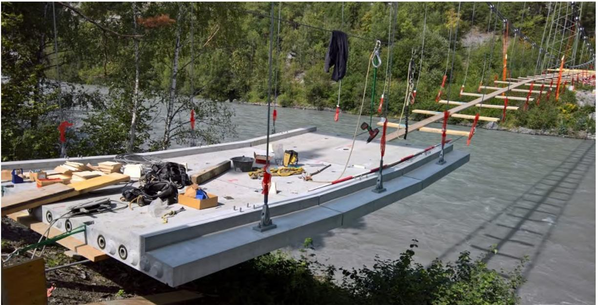
Einbau der Fahrbahnplatten Stück um Stück
