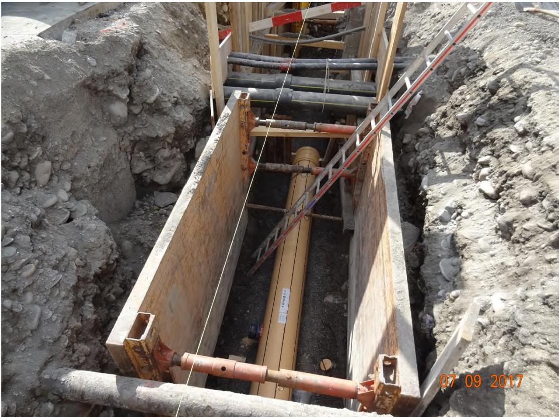
Die Spriessung für die neue Abwasserleitung in 3m Tiefe wird erstellt
