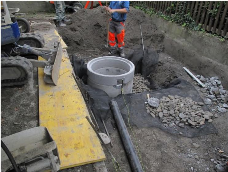
Einbau des Sickerschachtes für den künstlichen Bachlauf und das Dachwasser
