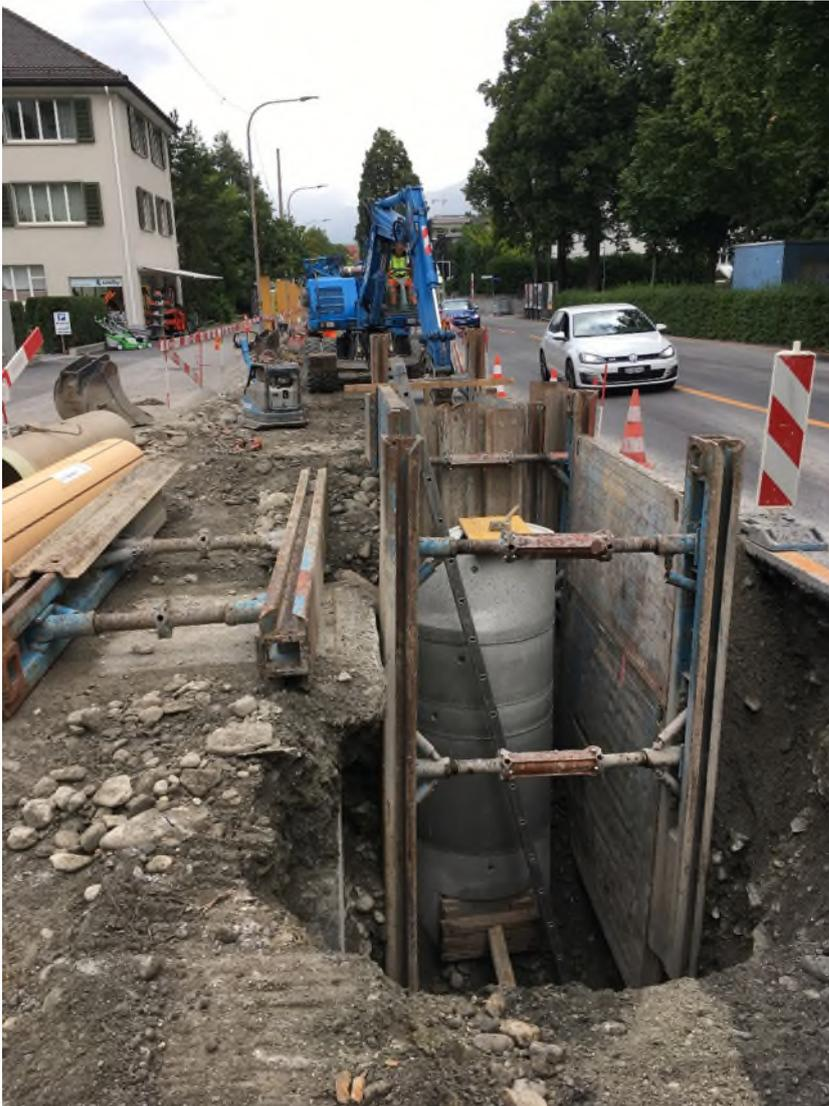
Kontrollschacht mit 4 Meter Höhe der neuen Abwasserleitung
