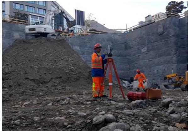
Absteckung in Baugrube UW Quader
