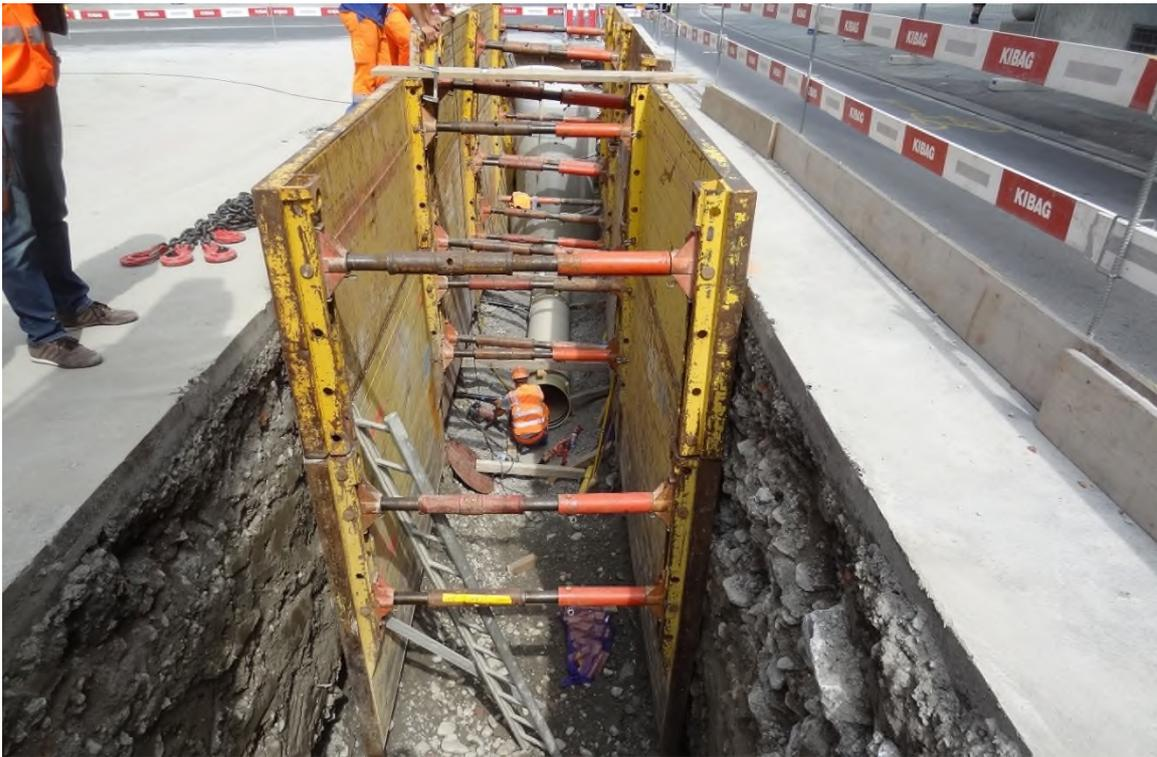
Die neue Abwasserleitung mit Durchmesser von 600mm
