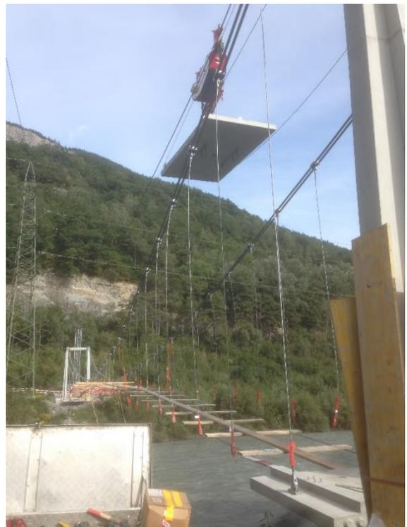
Montage der Fahrbahnplatte per Seilbahn
