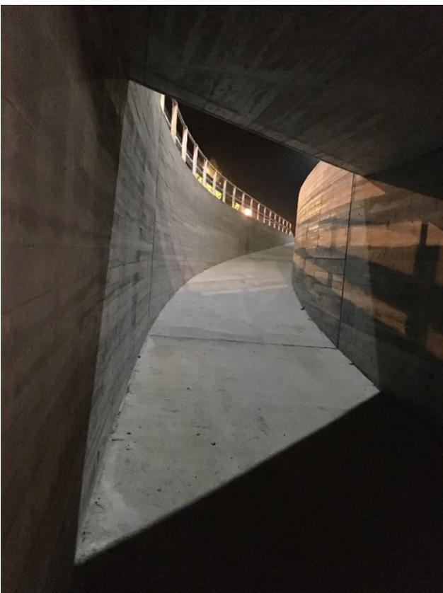
Rampe im Rohbau der Rad- und Fußgängerunterführung in Richtung Plankis
