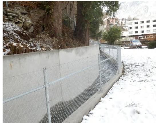
Bereich zwischen Bodmer und Aquädukt. Hier drohte der Hang in den Mühlbach zu rutschen, da die bergseitige Mauer fehlte. Dieser Abschnitt wurde zusammen mit den Tiefbaudiensten komplett neu erstellt.
