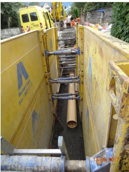
Die neue Abwasserleitung mit einem Durchmesser von 400mm in einer Tiefe von 3.5 Meter
