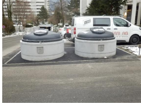
Tittwiesenstrasse 70. Einen Molok entfernt und die zwei verbleibenden nach den Vorgaben des Gleichstellungsgesetzes Behinderten gerecht neu eingebaut.
