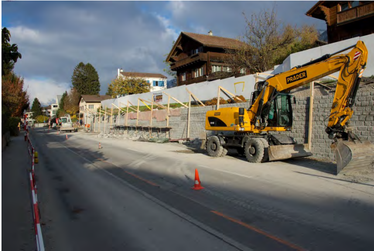
Ausbau Bus- und Radspur Masanserstrasse, Abschnitt Ringstrasse / Giacomettistrasse.
