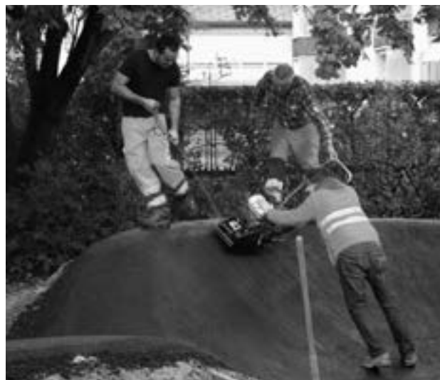
Erschwerter Belageinbau für den Pumptrack.
