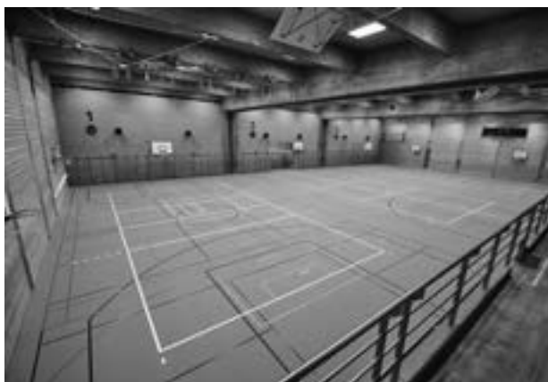
Der neue Hallenboden der Dreifach-Sporthalle.
