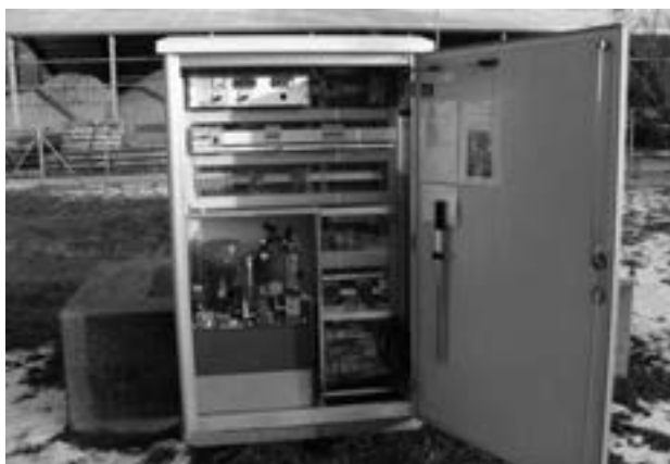
Steuerkabine mit eingebautem Hydraulikaggregat.
