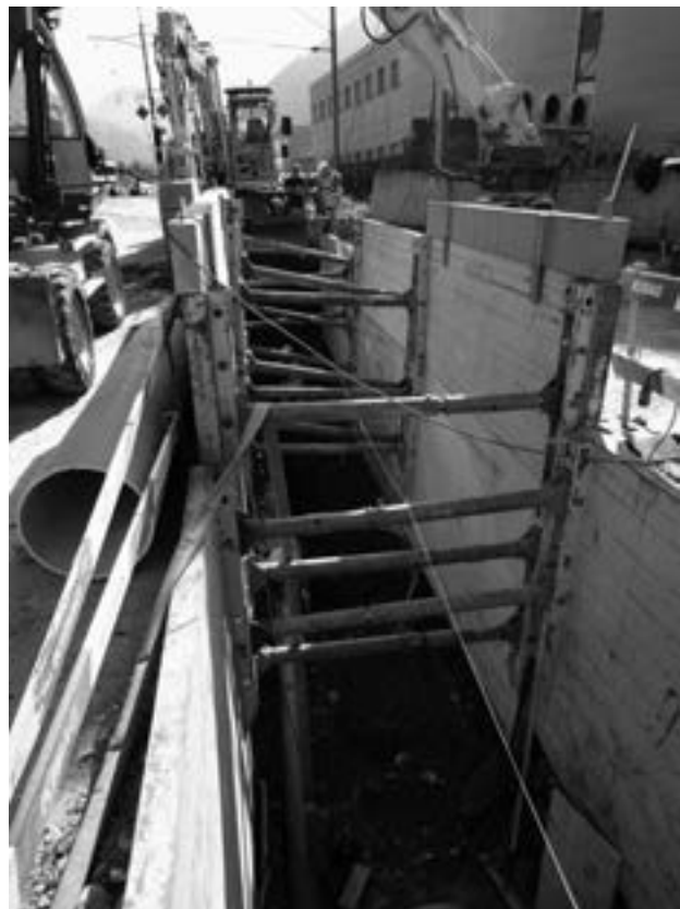
Spiessung für Kanalisationsgraben.
