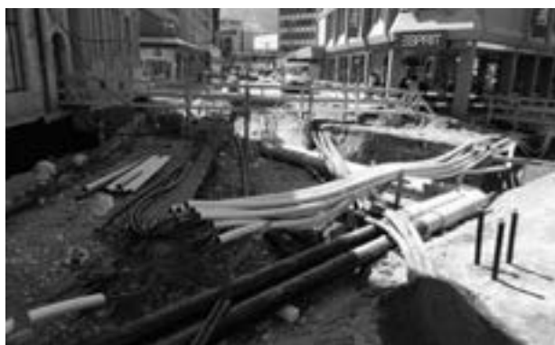
Werkleitungsbau an der unteren Bahnhofstrasse.
