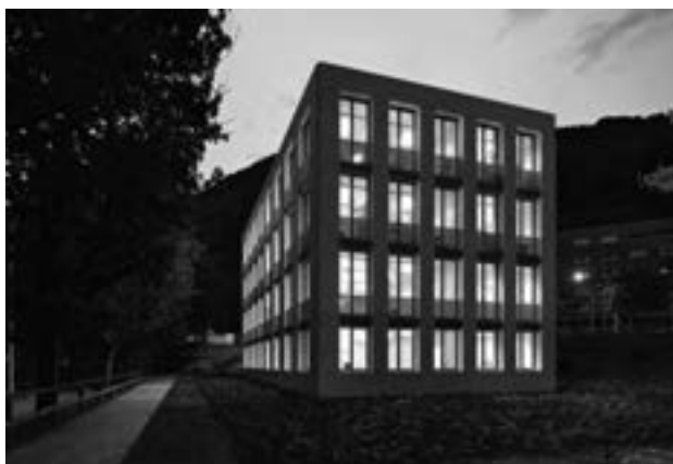
Erweiterungsbau Schulhaus Quader. (Aufnahme: R. Feiner)
