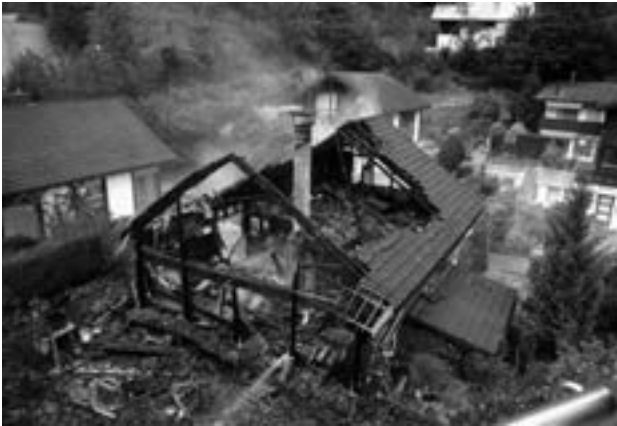
Hausbrand im Seidengut vom 30. Juli. Ein technischer Defekt bei einem elektronischen Gerät war die Ursache für diesen Brand.
