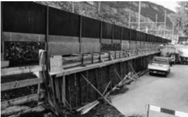
Steinkörbe sorgen für guten Halt.
