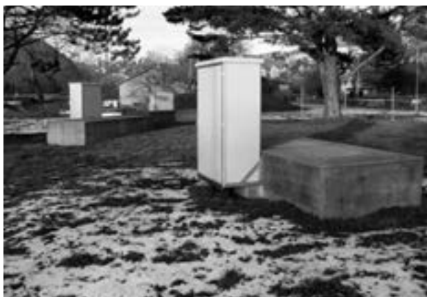
Freistehende Kabinen zur Steuerung der Abwassermengen.
