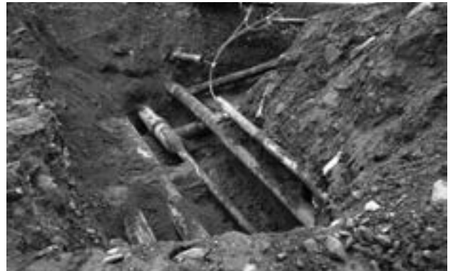
Werkleitungsbau Deutsche Strasse.
