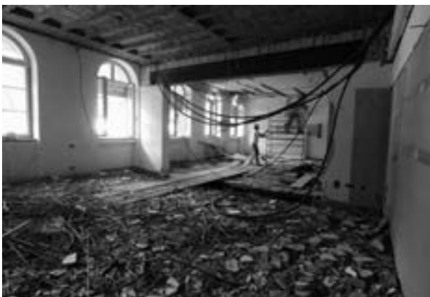
Abbrucharbeiten im Altbau Quader.
