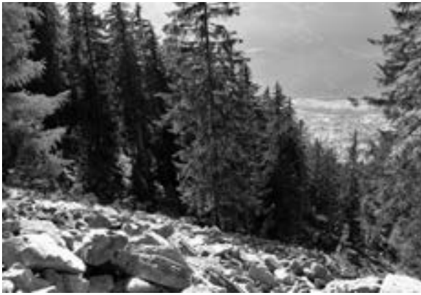
Ein Felssturz verschüttete am 5. Juni den obersten Teil des Wanderweges vom Lürlibad zum Fühörnli.
