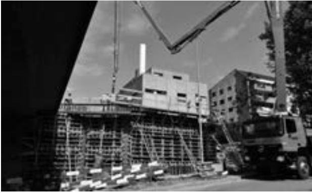
Betonieren mit Pumpe.
