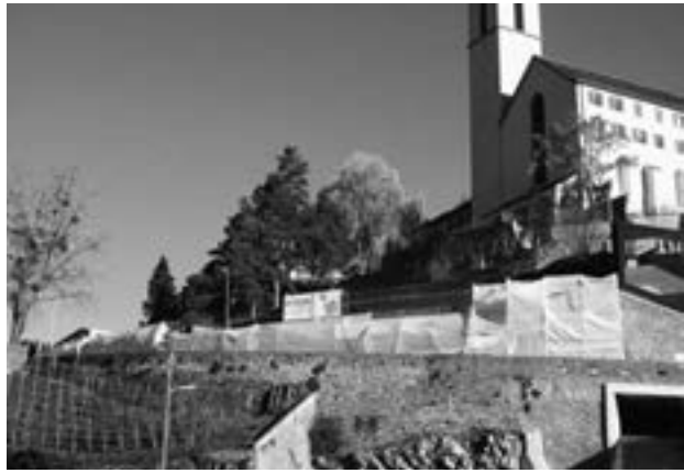
Eingerüstete Stützmauer entlang St. Luzistrasse.
