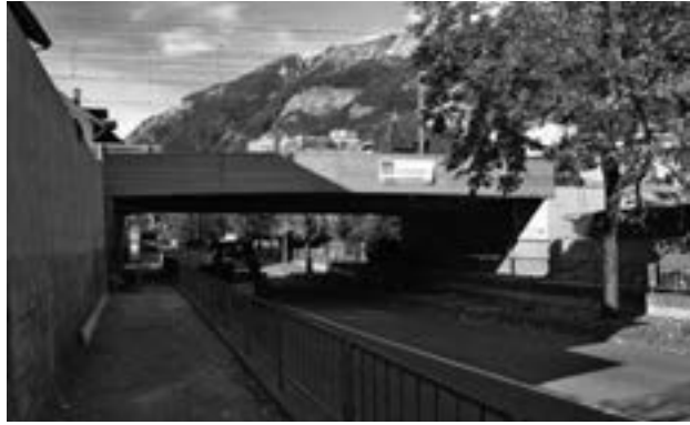
Die neu erstellte Holzbrücke über die Ringstrasse.
