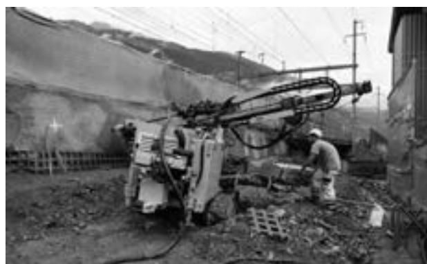
Erstellen der Nagelwand entlang der Bahngleise.
