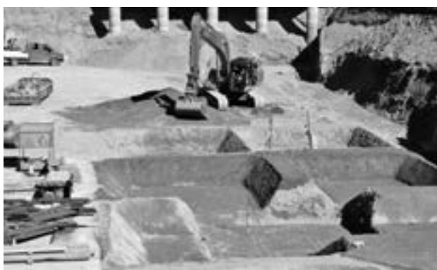
Rheinfels III, GPS gesteuerter Bagger erstellt Aushub.
