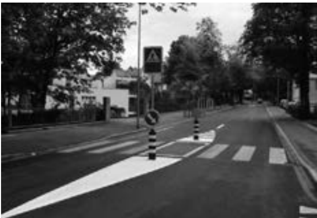
Eindruck eines sanierten Fussgängerstreifens.
