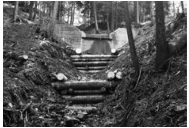
Instandstellung des Kolkschutzes für eine Bachsperre im Gattertobel mittels Holzkästen.
