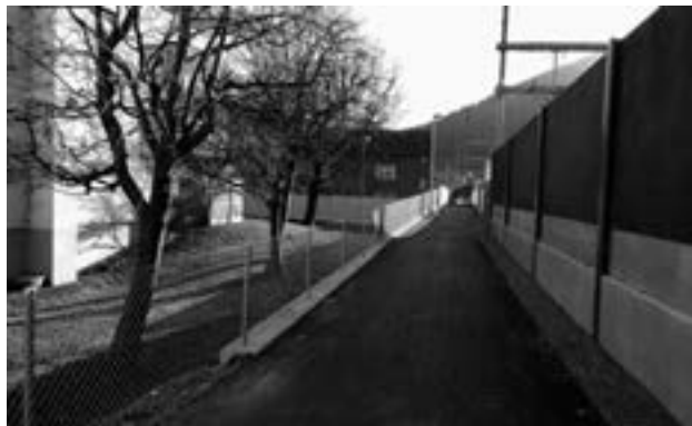
Fertiger Rad- und Fussweg.
