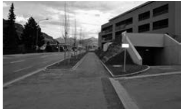
Das fertig erstellte Trottoir an der Deutschen Strasse.
