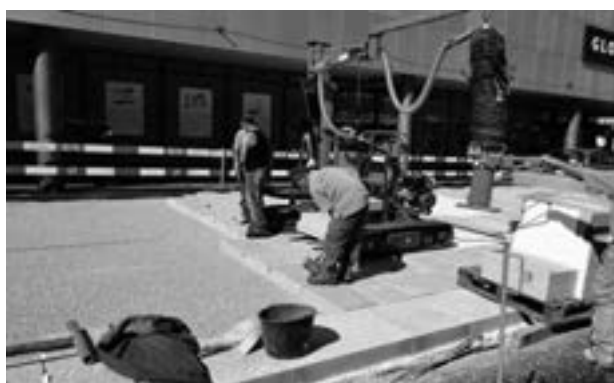
Erstellung des Plattenbelags mit Andeerer Granit.
