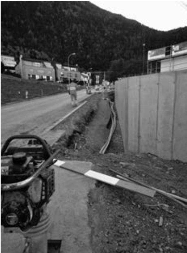
Werkleitungen im Trottoir, Böschenstrasse.
