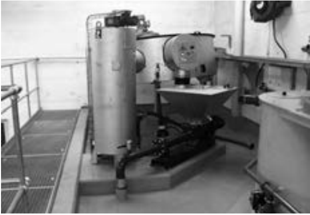
Neuer Scheibeneindicker zur Schlammmentwässerung.
