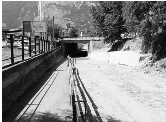
... vor dem Belagseinbau.
