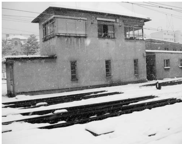
Beheizte Weichen beim Rangierbahnhof Chur.
