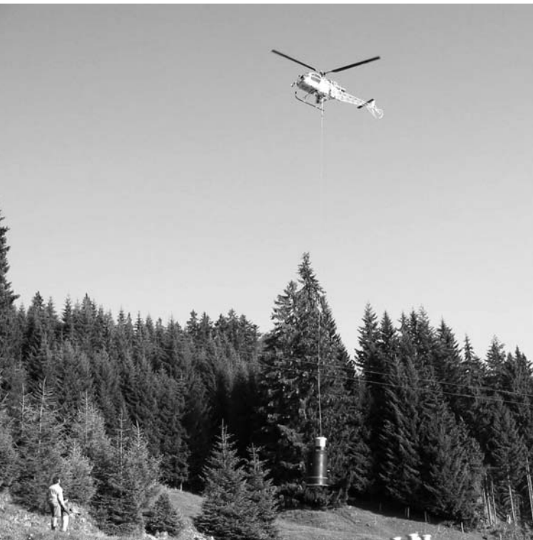
Versetzen einer Brunnenstube ins Quellgebiet Brambrüesch.
