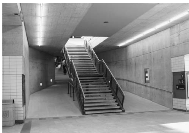
Die neue Personenunterführung als moderne und grosszügige Verbindung von Alt- und Neustadt.
