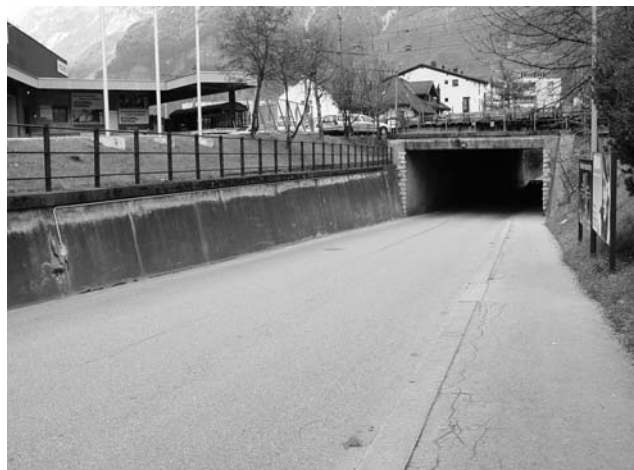
Die Sägenstrasse mit Bahnunterführung vor der Sanierung...
