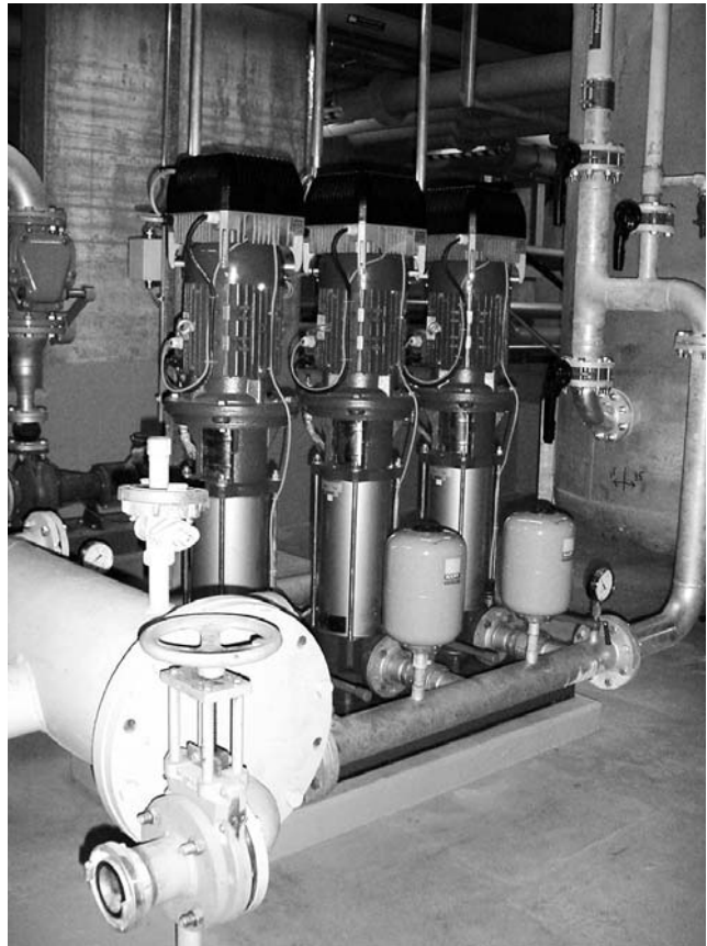
Brauchwasseranlage für die Bereitstellung des Kühlwassers.
