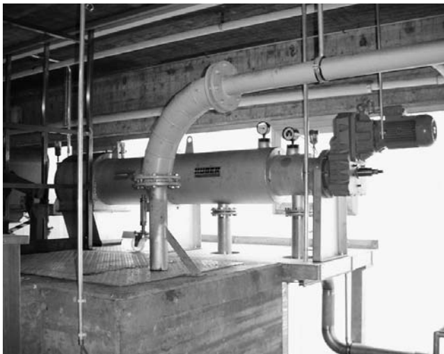
Neue Frischschlamm Siebung im Rechengebäude.
