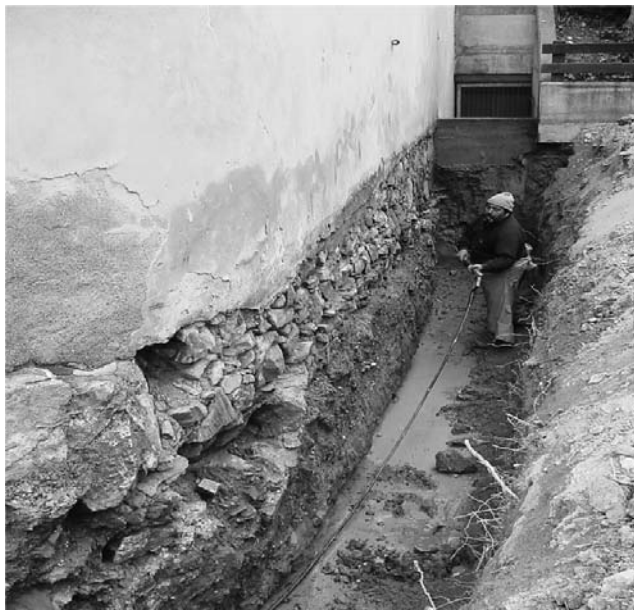
Beim Weinbaumuseum mussten vor allem Feuchtigkeitsschäden behoben werden.
