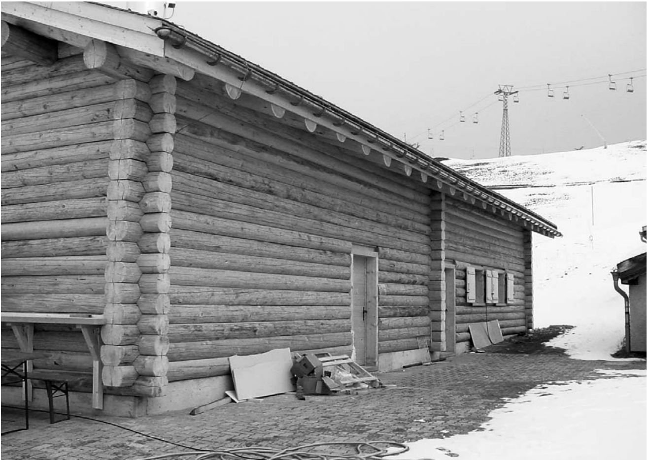
Der neue «Stall» bei der Tschuggenhütte in Form eines Holzblockhauses kurz vor der Fertigstellung im Spätherbst. Er beherbergt einen «Mountainmac» und ein Raclette-Stübli sowie Infrastruktur-Anlagen.
