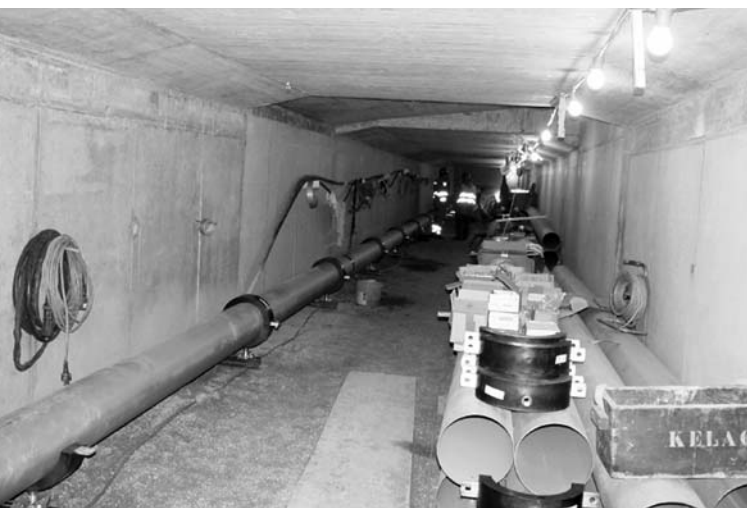
Die alte Personenunterführung dient heute als wichtige Werkleitungsverbindung zwischen Alt- und Neustadt.
