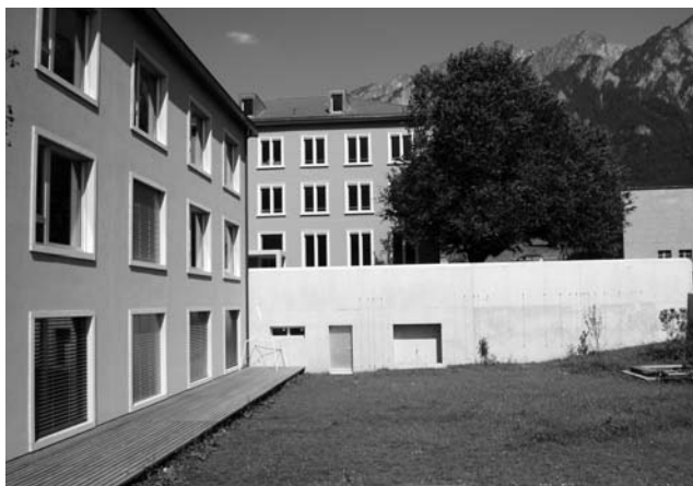
Nach der Renovation erstrahlt das Schulhaus Masans in neuem Glanz.
