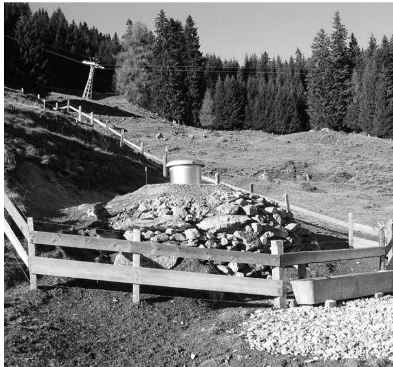
Eingezäunte Quellfassungszone Brambrüesch.
