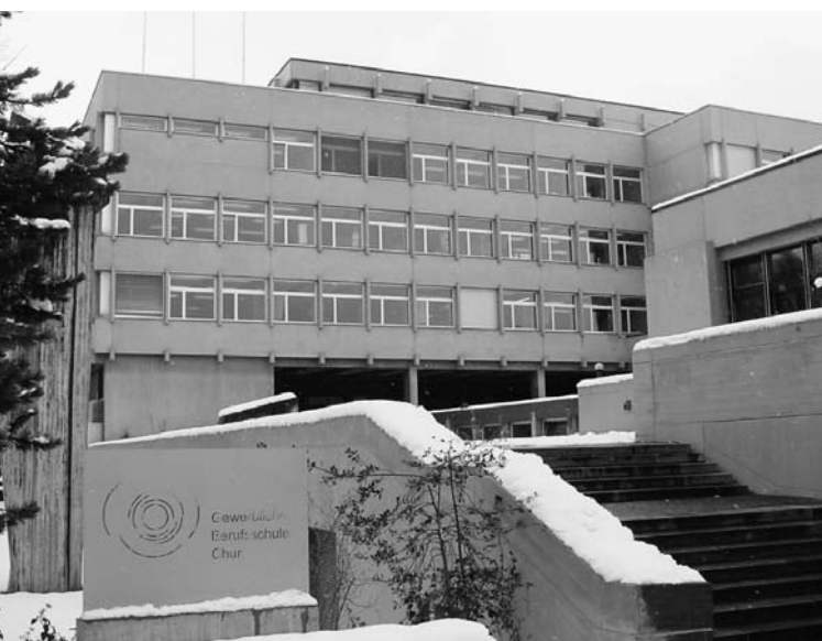
Die Sanierung der GBC-Gebäudehülle konnte termingerecht auf Schulbeginn fertig gestellt werden.
