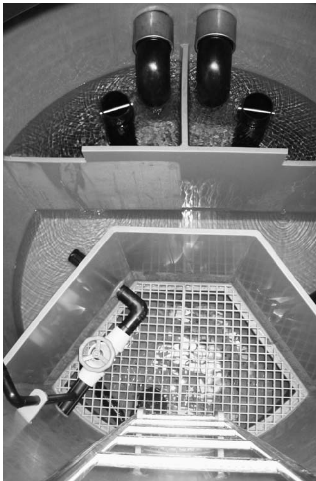
Innenansicht Quellfassung Brambrüesch.
