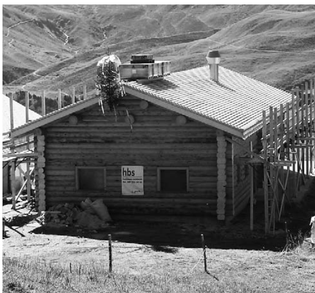
Tschuggenhütte Arosa: Der alte Stall wurde abgebrochen und durch ein neues Blockhaus ersetzt.
