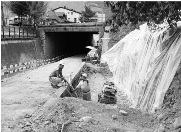
... Arbeiten für das Mauerfundament ...
