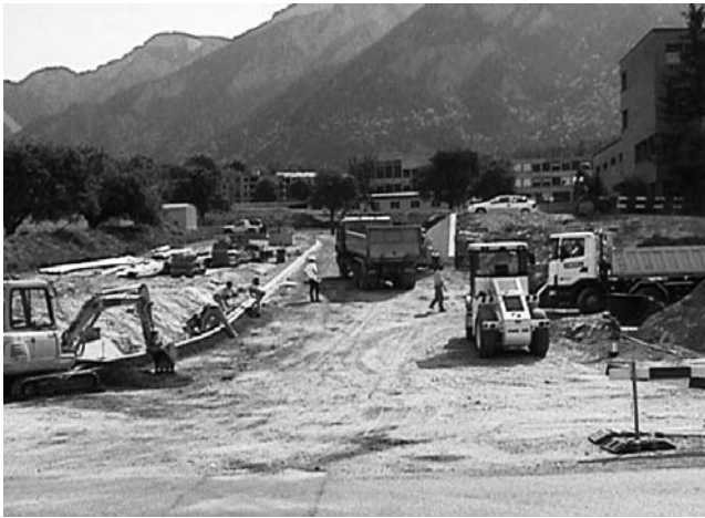
Die Kantenstrasse mit Werkleitungen entsteht.
