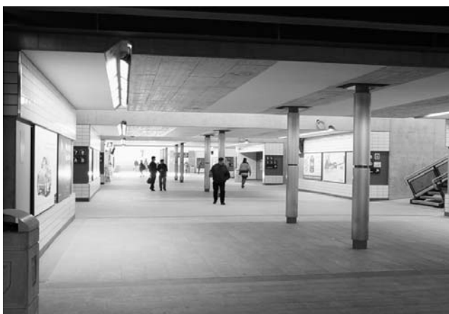
Aufgang und Rampen zu den Perrons mussten bei vollem Bahnbetrieb erstellt werden.
