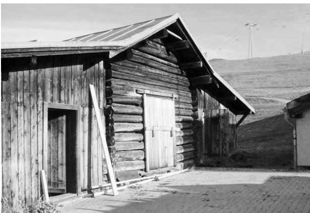
Der alte Stall bei der Tschuggenhütte vor dem Abbruch.
