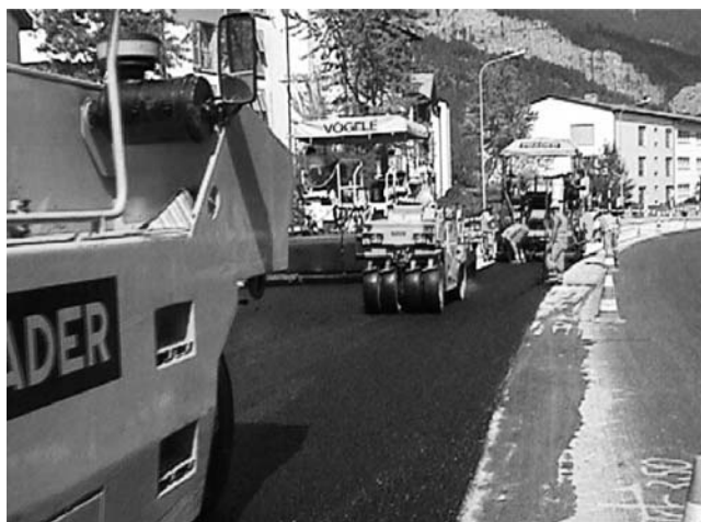
Belagseinbau an der Masanserstrasse unter Verkehr.
