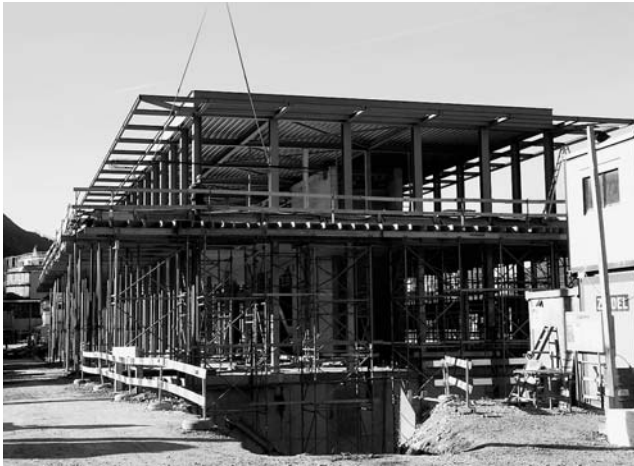
Das Annexgebäude im Rohbau.
