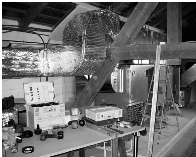
Lüftungszentrale auf dem Dachboden des Restaurants Schützenhaus.
