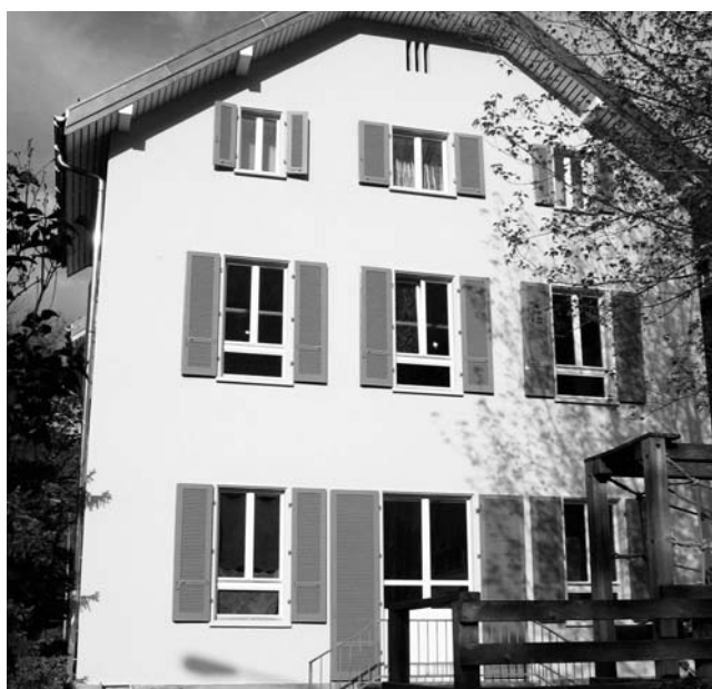
Der Kindergarten Plessurquai wurde innen und aussen saniert.
