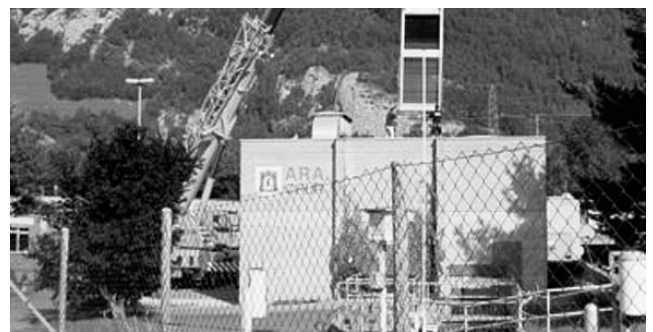
Transport des neuen Stufenrechens für die ARA.
