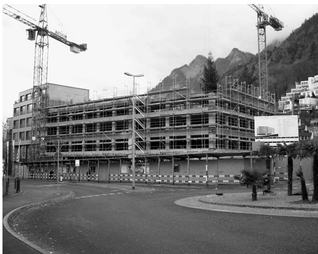
Stand der Arbeiten am Untertor «Stadthaus» am 17. Dezember.
