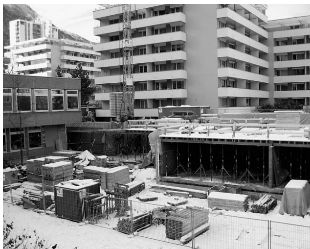
Das Schulhaus Lachen wird um vier Klassenzimmer erweitert.
