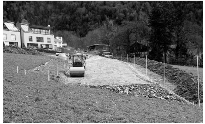
Eine neue Strasse entsteht.
