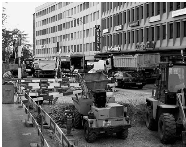
Strassenbau an der Alexanderstrasse unter Verkehr.
