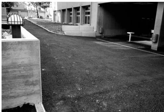
Der Eingang Sennensteinstrasse wurde im Rahmen der Sanierung rollstuhlgängig gestaltet.
