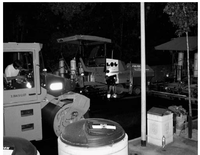
Über Nacht entsteht der Kreisel; Belagseinbau in der Nacht.
