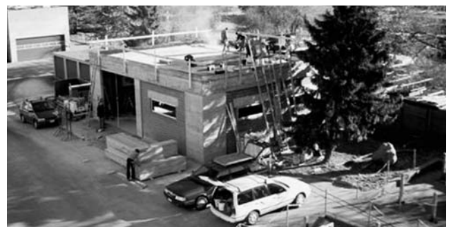
Neubau Lagerhalle bei den Abschlussarbeiten.
