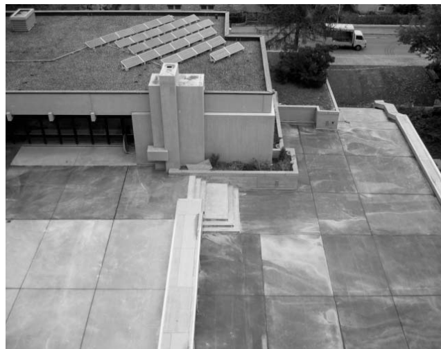
Die erste Etappe der Flachdachsanieierung konnte im Sommer abgeschlossen werden.
