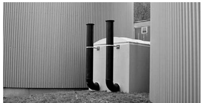
Neue Biofilteranlage zur Reinigung der Abluft.
