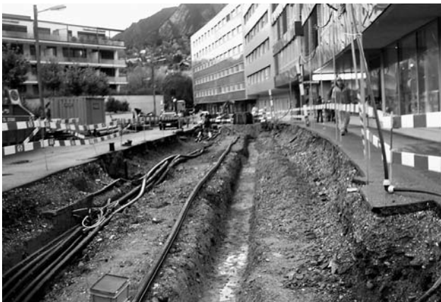
Verlegen der Werkleitungen an der Steinbruchstrasse.
