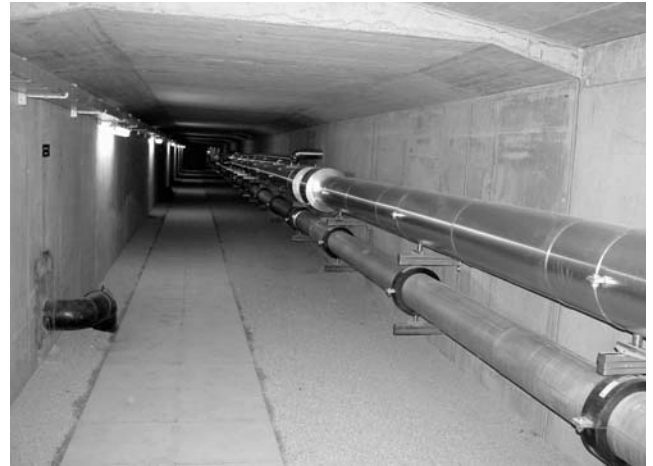
Der neue Energiekanal unter dem Bahnhof.
