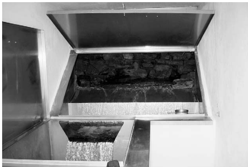
Innenansicht Quelfassung Valbella.
