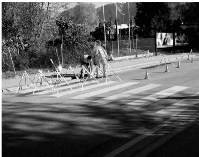
Die Markierungs-Equipe der Stadtpolizei bei der Markierung eines Fussgängerstreifens.
