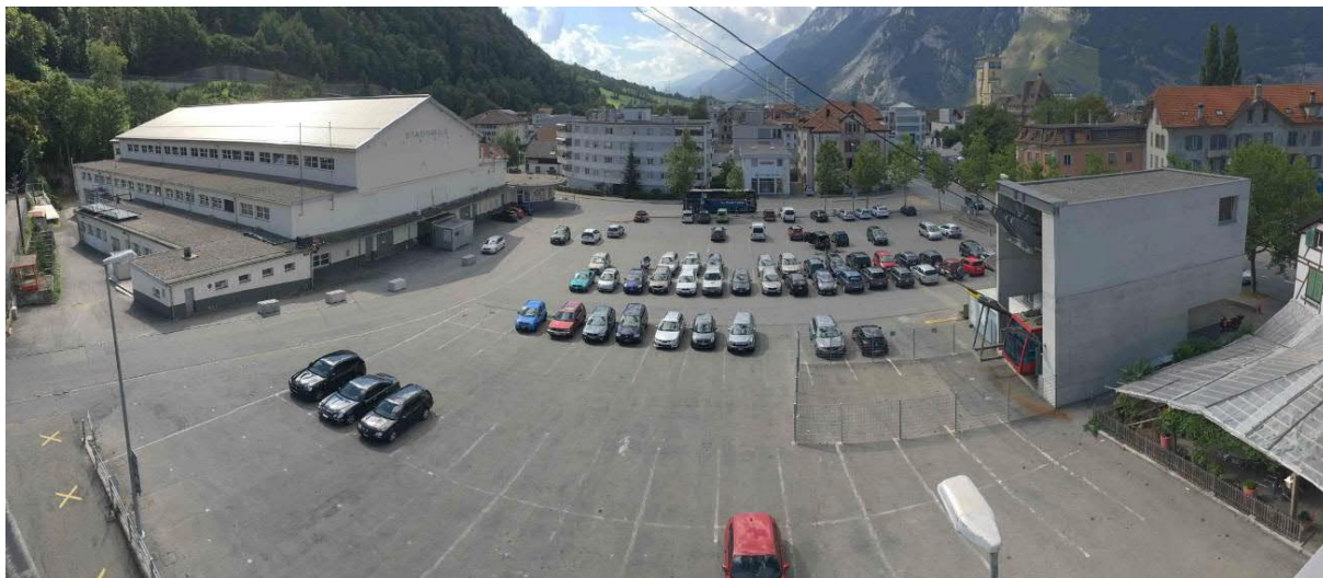
Abb.16: Stadthallen-Areal Chur heute (Quelle: Expo Chur AG, expo.chur.ch/stadhalle-chur/ )
