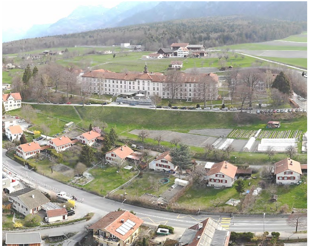
Abb. 1: Luftbild des Gebiets (Hochbauamt Graubünden)
