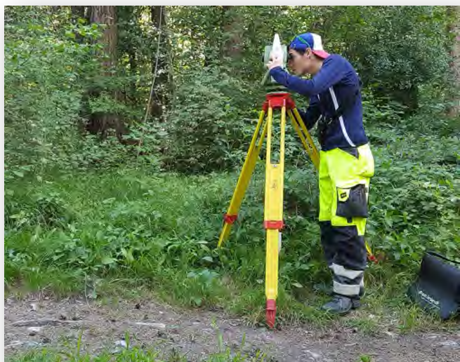
Absteckung Achse Radweg Chur - Trimmis
