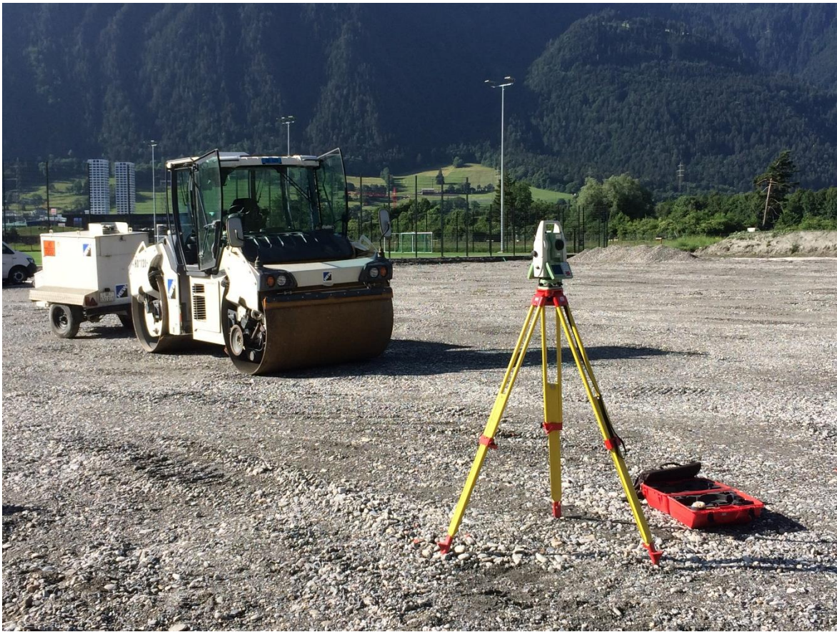
Absteckungsarbeiten Neubau Kunstrasenplätze Obere Au
