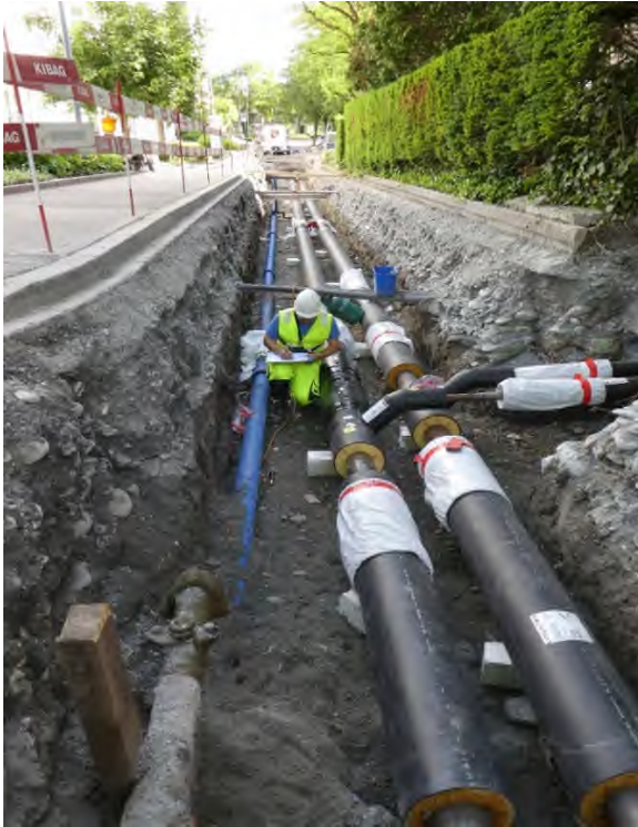
Aufnahme der Wasser- und Fernwärmeleitung Stadtgartenweg
