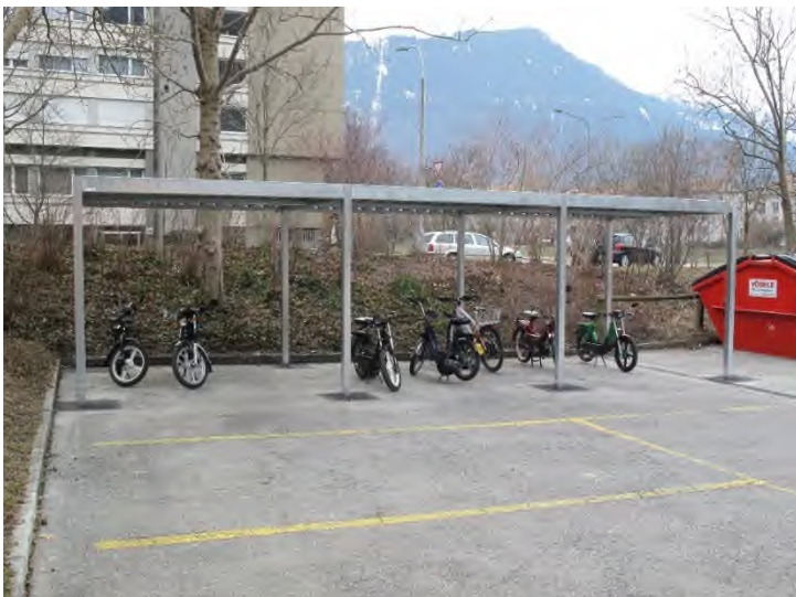
Neuer Rollerunterstand auf dem Parkplatz beim Schulhaus Giacometti
