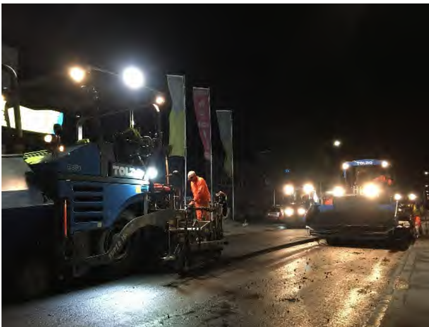
Belageinbau an der Rossbodenstrasse
