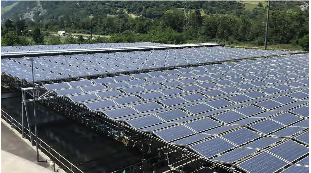
Solar-Faltdach-HORIZON über den Klärbecken der ARA Chur
