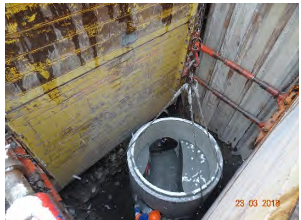
Einbau Schachtboden für Abwasserschacht
