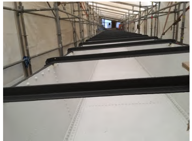
Erste Beschichtungen von neuen Korrosionsschutz
