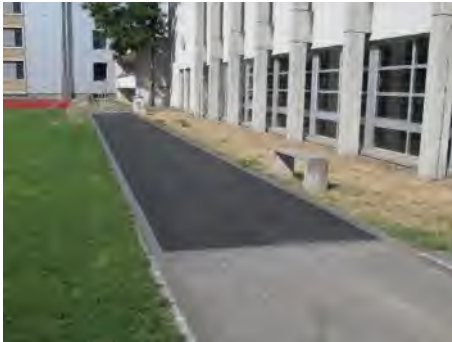
Frisch asphaltierter Zugangsweg entlang der Turnhalle Rheinau
