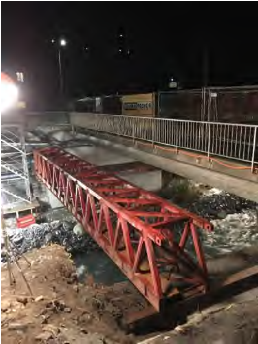
Montage des Leegerüstes in Nachtarbeit für den Brückenabbruch und Wiederaufbau
