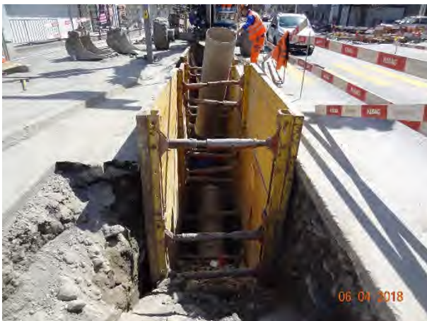
Einbau der Abwasserleitung
