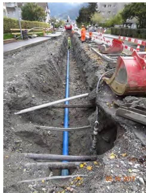
Verlegung der neuen Wasserversorgungsleitung der IBC Energie Wasser Chur
