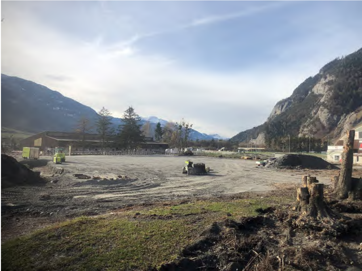
Erste Vorbereitungsarbeiten für die Skateanlage, abhumusierter Perimeter
