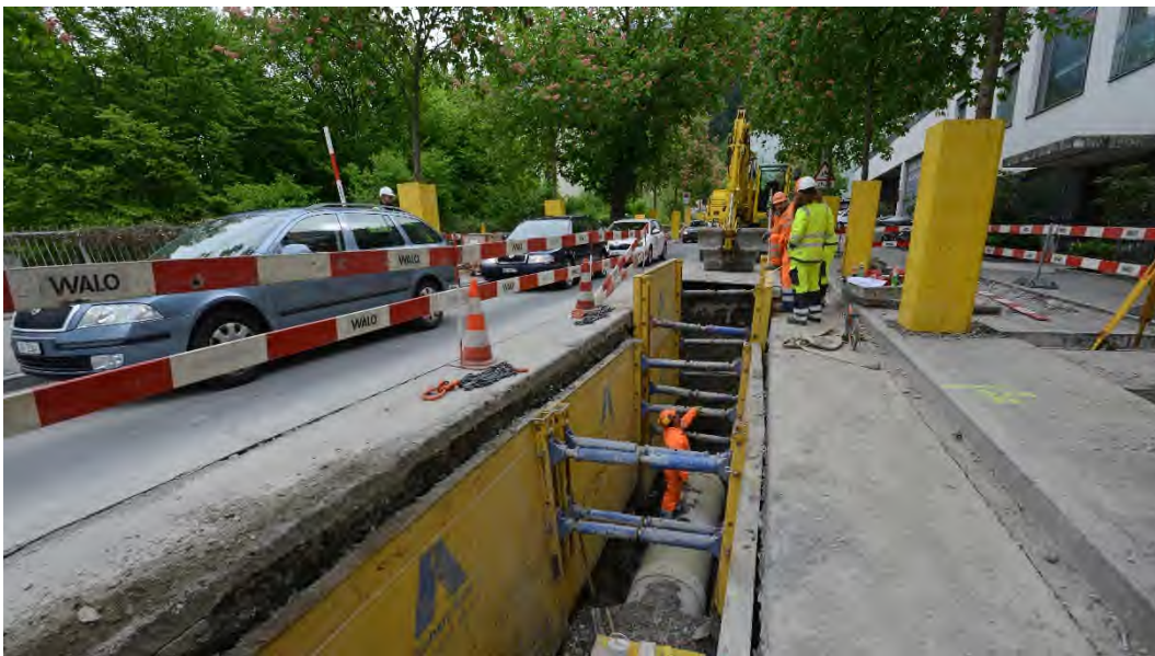
Neubau Abwasserleitung in gespriessten Graben
