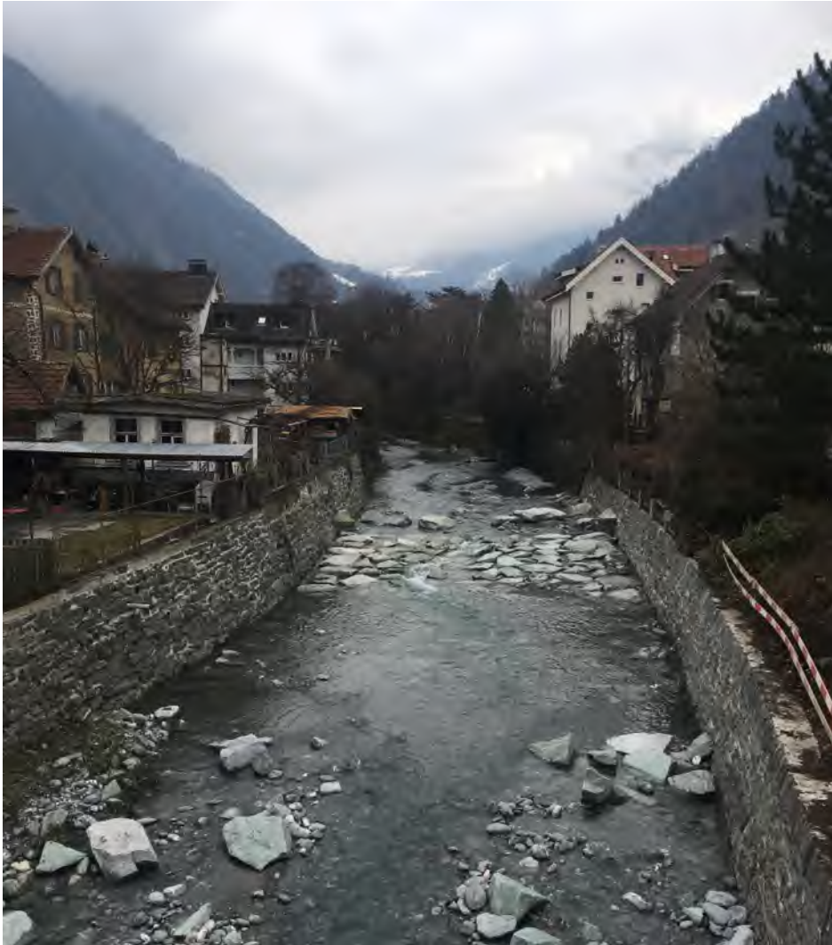
Fertiggestellte Blockrampe
