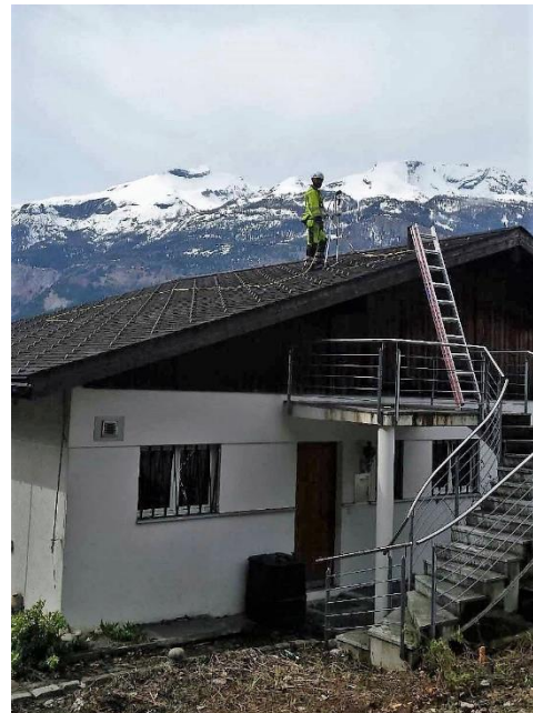
Absteckung Profilierung Heckenweg
