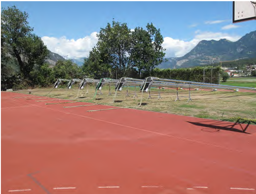
Vorbereitete Kandelaber beim Schulhaus Giacometti vor dem Stellen mit dem Helikopter
