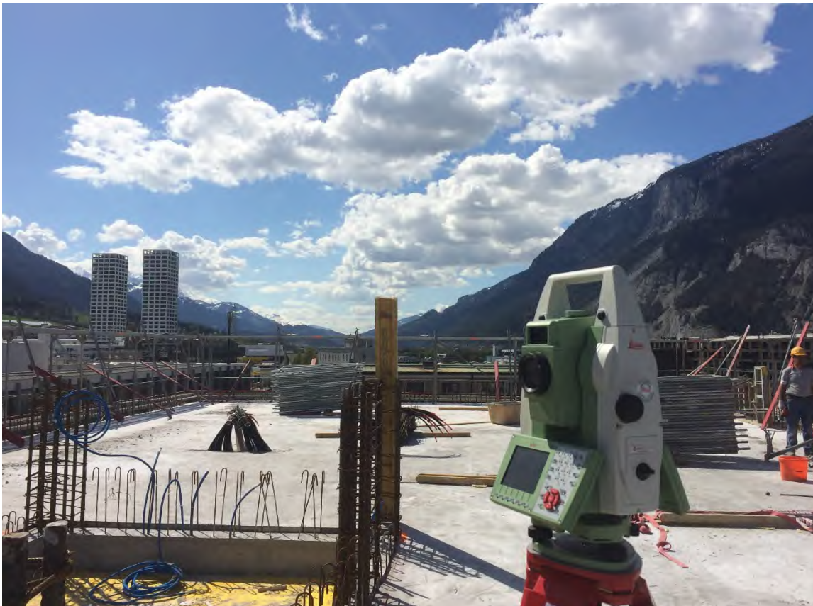
Schnurgerüstabnahmen und Kontrollmessungen Neubau Verwaltungsgebäude Sinergia
