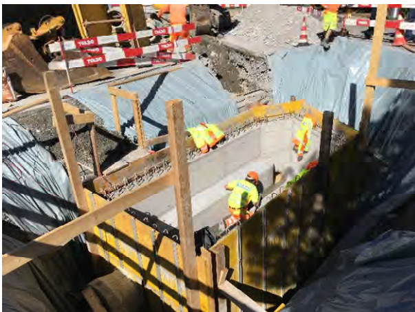
Betonarbeiten an neuer Hochwasserentlastung
