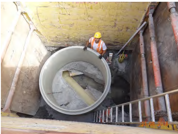
Einbau Abwasserbauwerk
