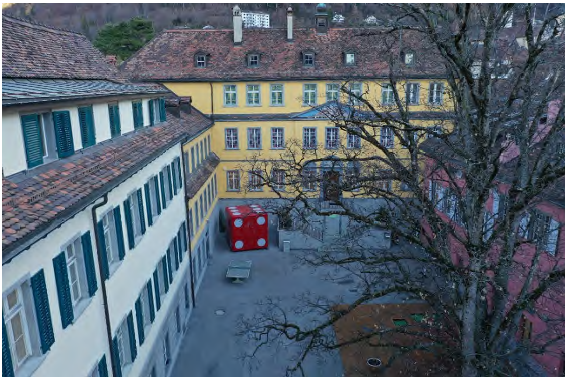
Legende: Fassadensanierung Schulhaus Nikolai
