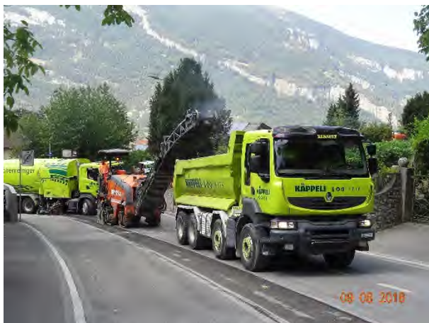
Baulicher Unterhalt Bondastrasse
