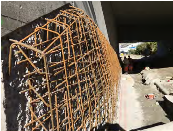
Leitmauer Unterführung Raschärenstrasse
