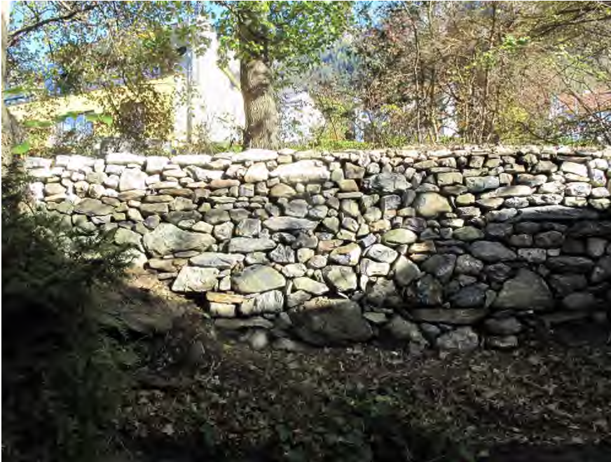
Wieder aufgebaute Natursteinmauer in städtischer Wildhecke
