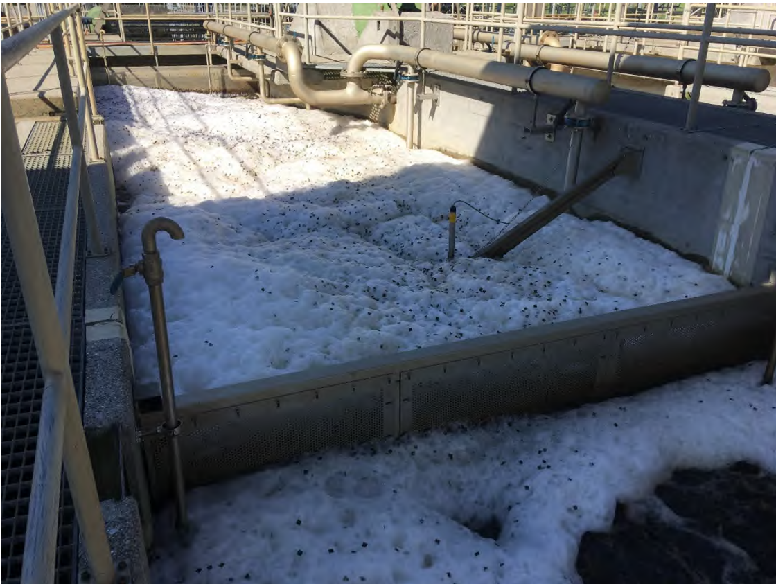
Starke Schaumbildung in der Biologie durch Tenside
