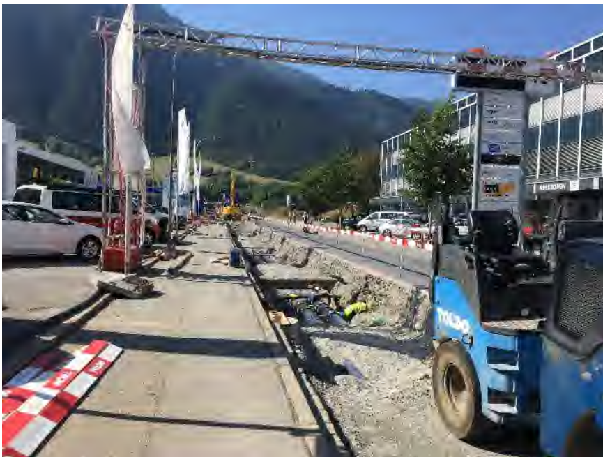
Werkleitungsbau Anergieleitung Rossbodenstrasse
