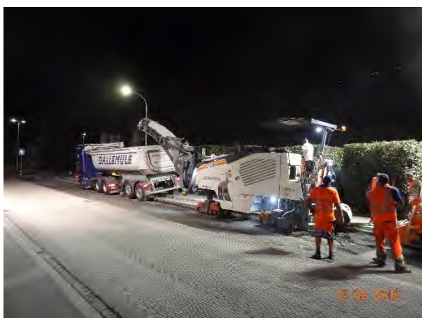
Baulicher Unterhalt Pulvermühlestrasse
