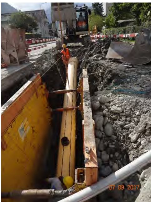
Einbau der Abwasserleitung an der Scalettastrasse
