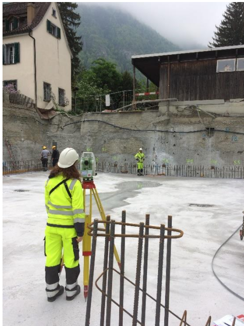
Schnurgerüstabnahme Bodenplatte Alterssiedlung Bodmer
