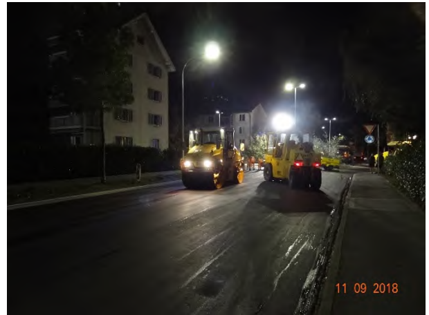
Deckbelagseinbau Ringstrasse, Nordstrasse - Calandastrasse
