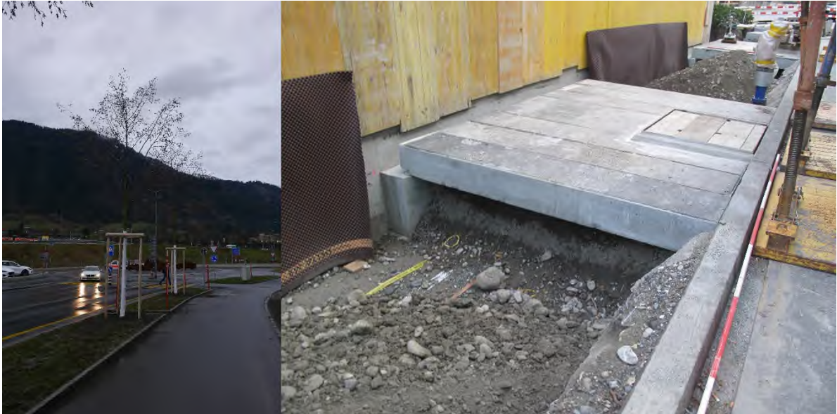
Legende: Neupflanzung an der Rossbodenstrasse / unterirdisches Baumgrubensystem
