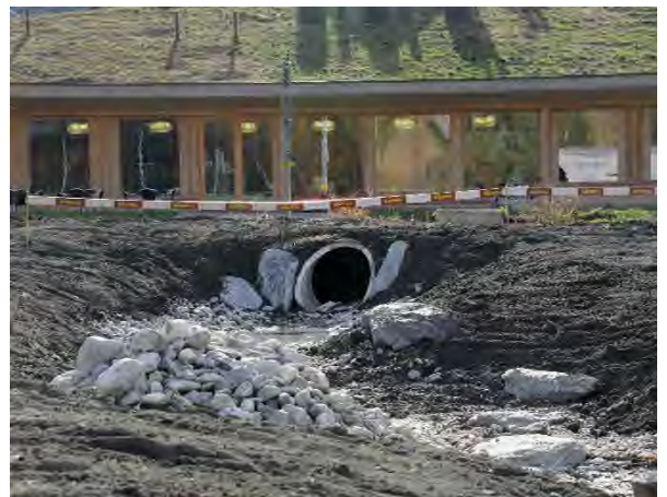
Auslauf kanalisierter Mühlbach
