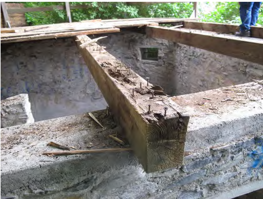
Die gesamte Balkenlage über dem Fundament des Gabentempels im Rosenhügel war morsch
