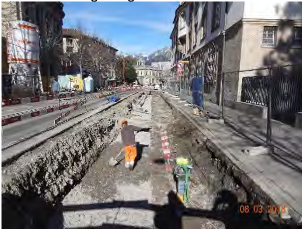
Umhüllung der Werkleitungen mit Sand
