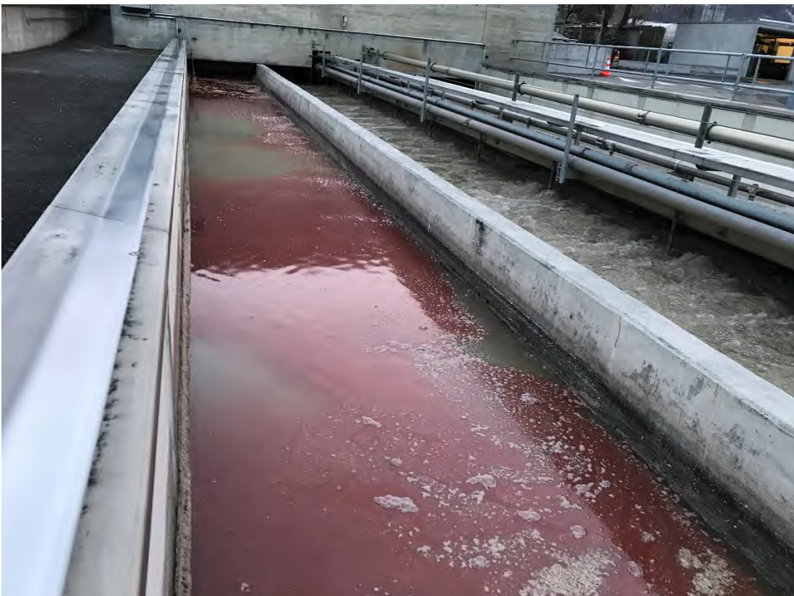
Heizöl im Sand- / Fettfang
