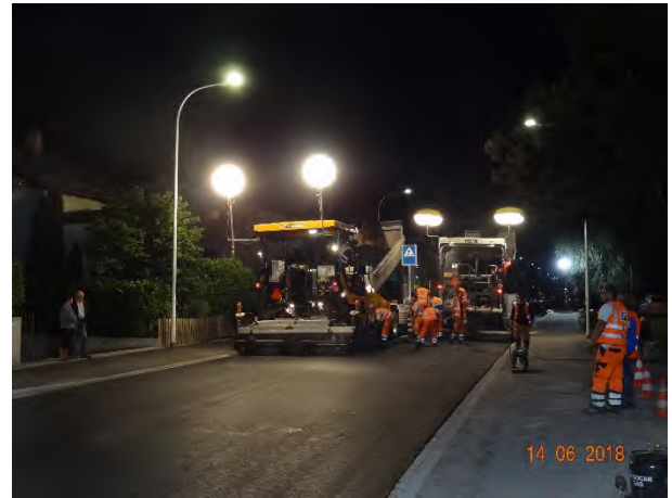
Belageeinbau Scalettastrasse
