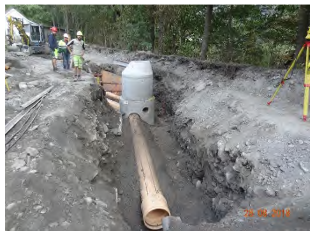
Schachtbauwerk mit Abwasserleitung und Meteorwasserleitung
