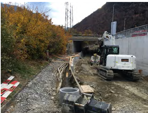
Einbau Abwasserleitung
