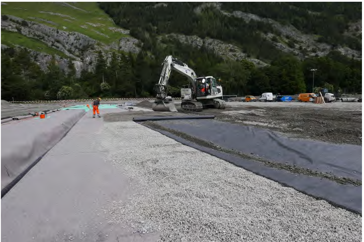
Legende: Unterbau mit Abdichtung und Drainage
