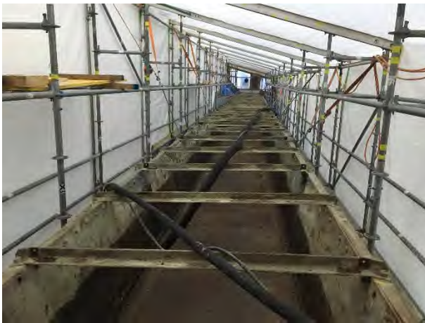
Staubdichte Einhausung für Schadstoffentsorgung
