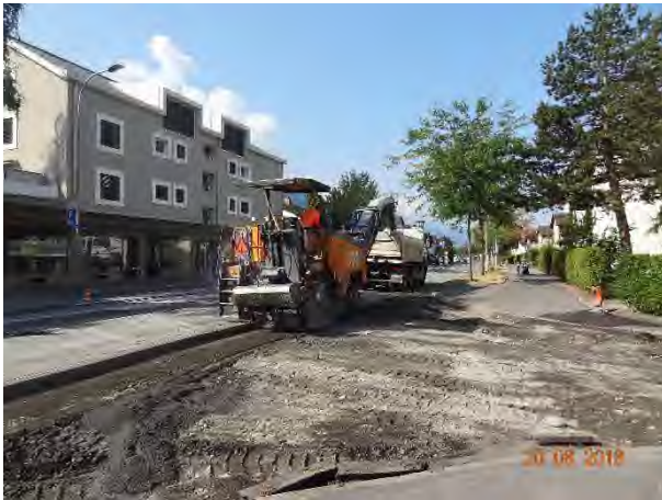
Anpassungsarbeiten Einlenker Dreibündenstrasse, "Fräsarbeiten Asphalt"
