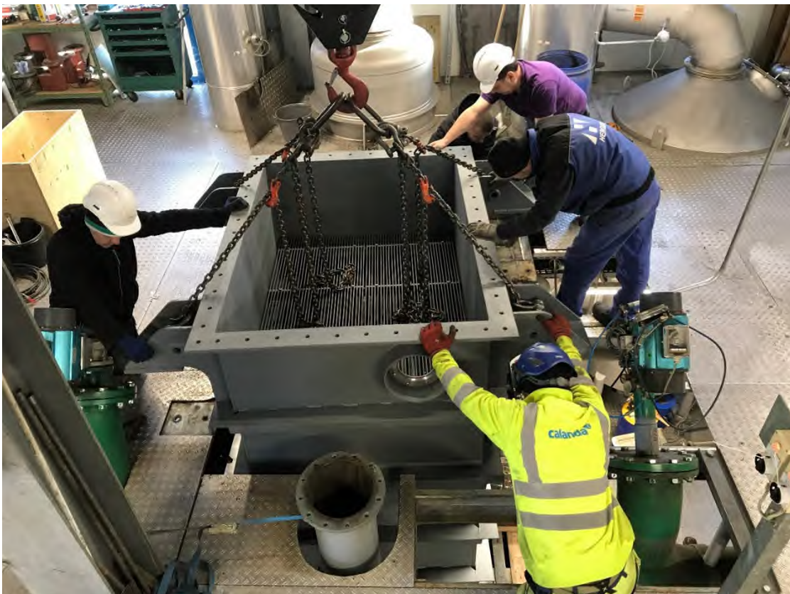
Millimeterarbeit beim Ein- und Ausbau des Rohrbündel-Wärmetauschers
