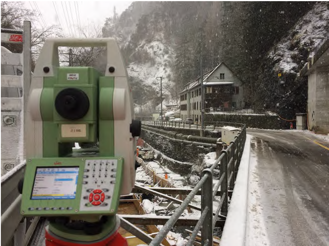
Tachymetrische Überwachungsmessung der Wuhrmauer Sandstrasse
