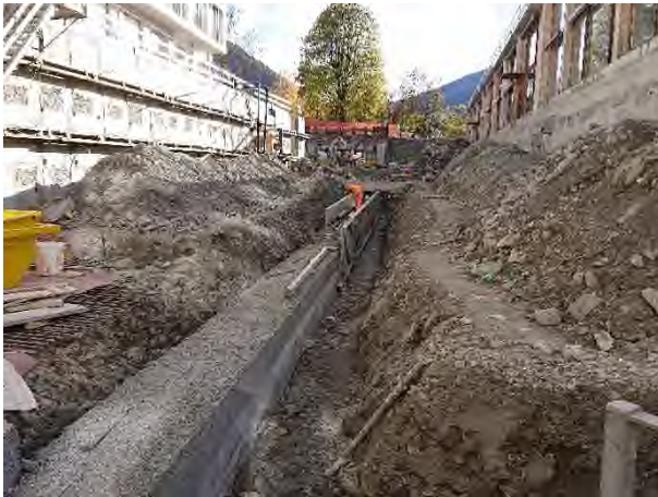
Einbetonierte Abwasserleitung
