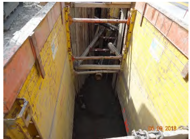
Grabensicherung für Abwasserleitungsbau
