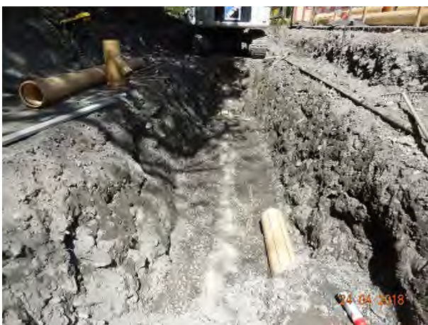
Umhüllung Abwasserleitung
