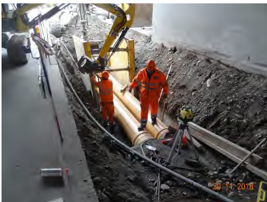
Einbau Abwasserpumpleitung
