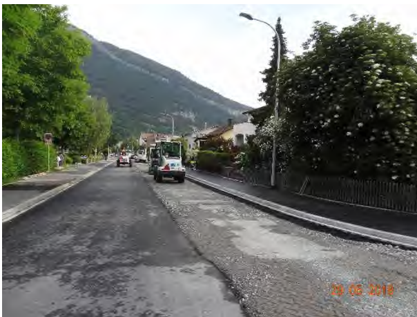
Planum vor Belageseinbau
