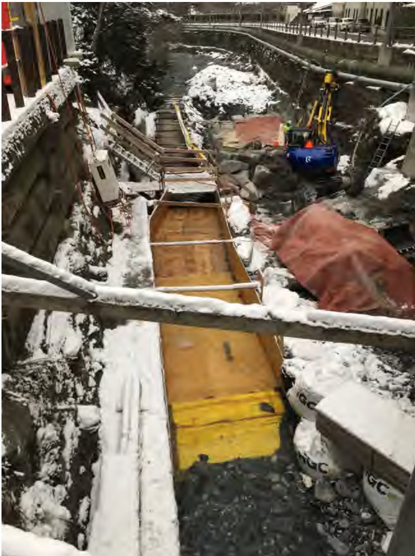
Während den Bauarbeiten
