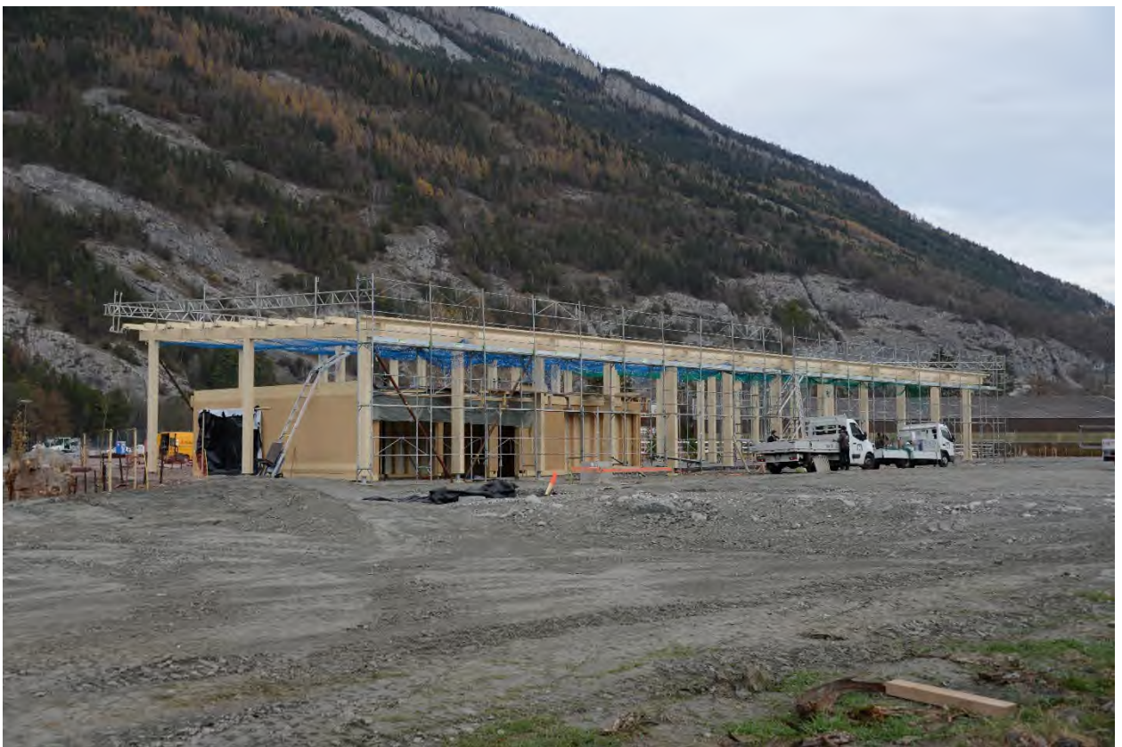
Rohbauzustand Bocciaanlage mit Clubhaus
