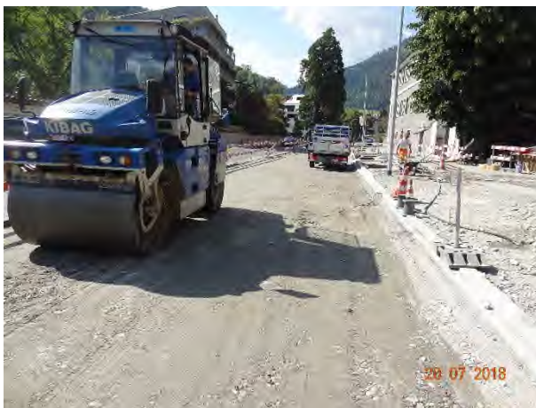
Walzarbeiten vor Belagseinbau
