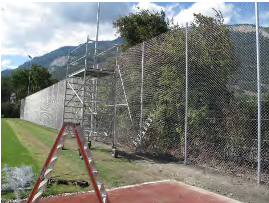
Montage des neuen Zauns mit Rollgerüst zwischen Sportplatz und Wildhecke
