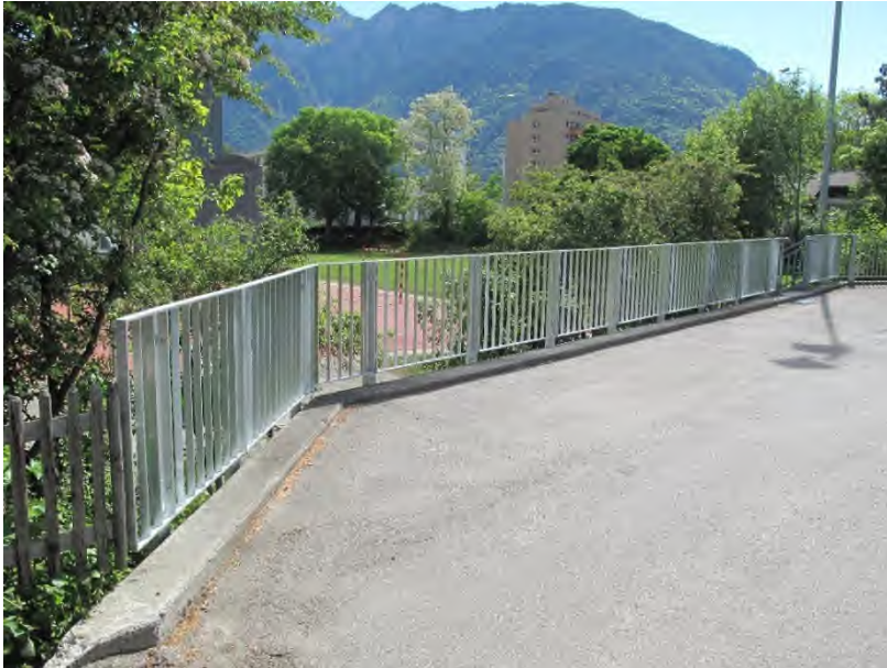
Metallzaun beim Schulhaus Otto Barblan als Absturzsicherung entlang des Föhrenwegs
