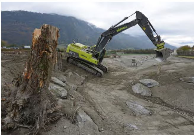
Bauarbeiten Gestaltung Mühlbach
