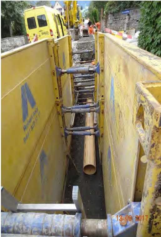
Neubau Abwasserleitung in gespriesstem Graben
