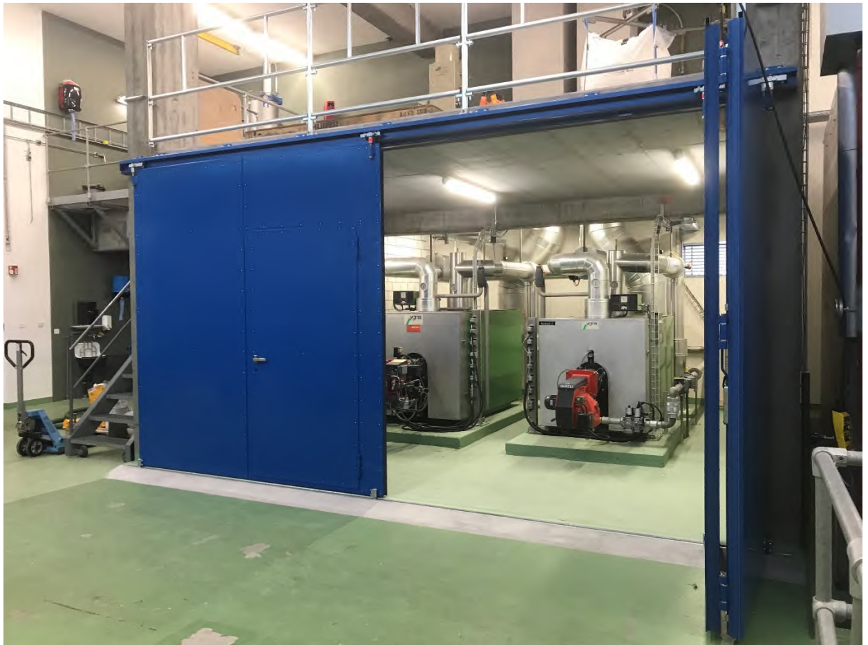
Gasheizung im Heizungsraum
