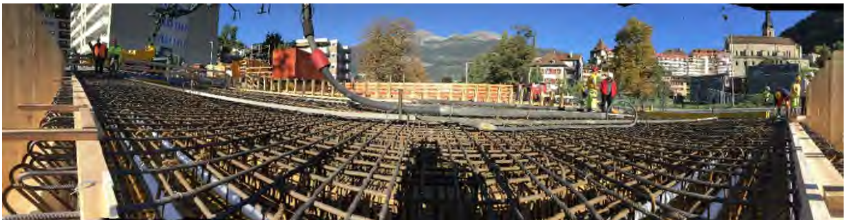
Start der Betonierarbeiten der neuen Brückenplatte
