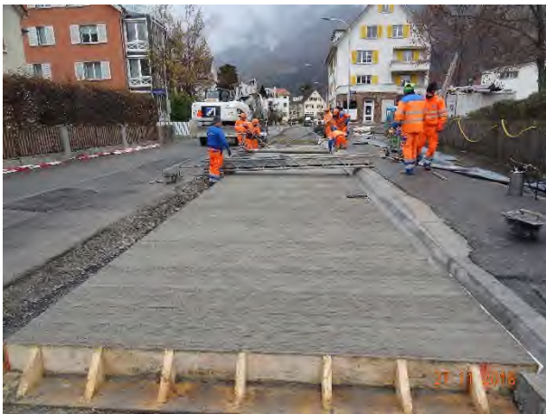
Betonhaltestelle Oberalpstrasse mit Haltekante Bus 22 cm
