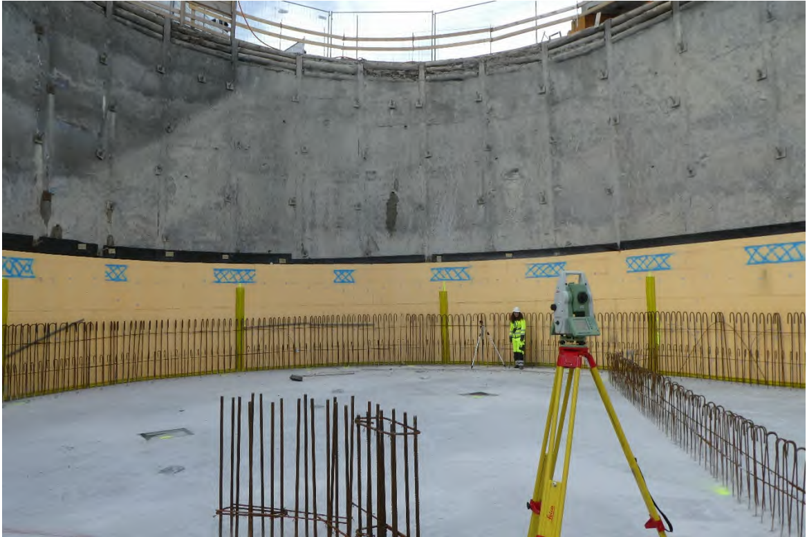
Bauvermessung 3. UG Neubau Wohn- und Geschäftshaus Steinbock
