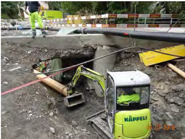
Einbau Abwasserleitung unter best. EW Trasse
