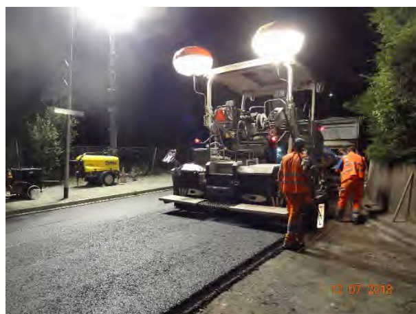
Baulicher Unterhalt Fürstenwaldstrasse
