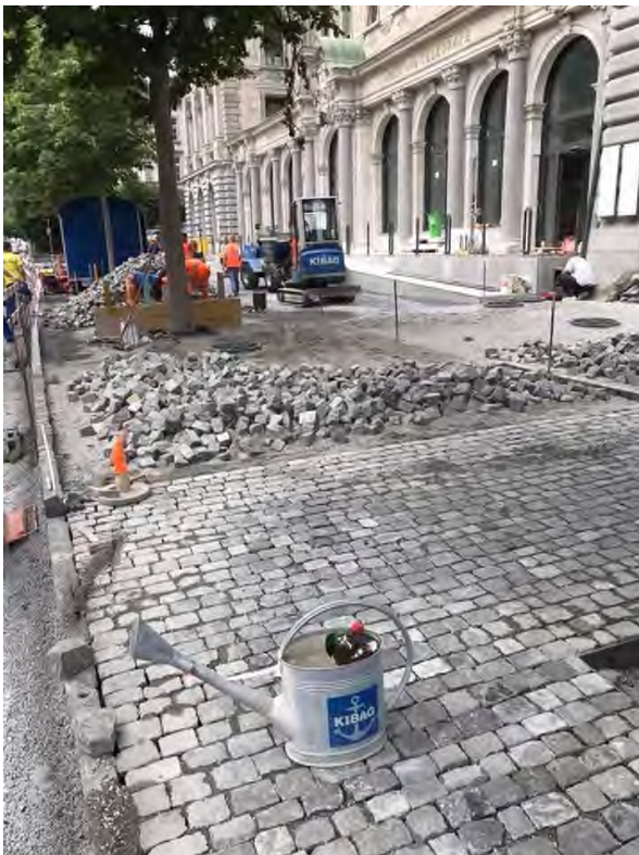
Pflästerungsarbeiten vor der neuen Stadtbibliothek
