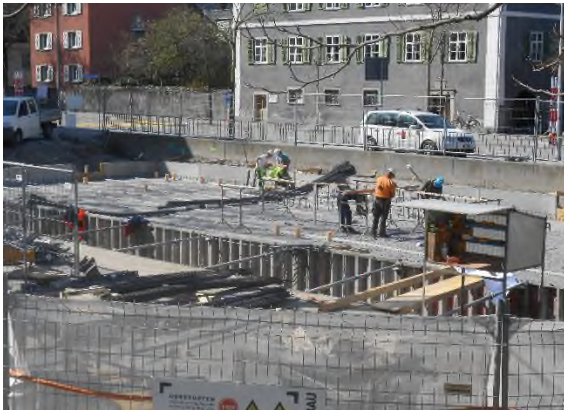
Beginn der Bauphase
