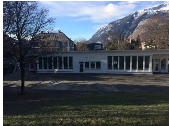
Fertigstellung Kindertagesstätte Montalin im Dezember
