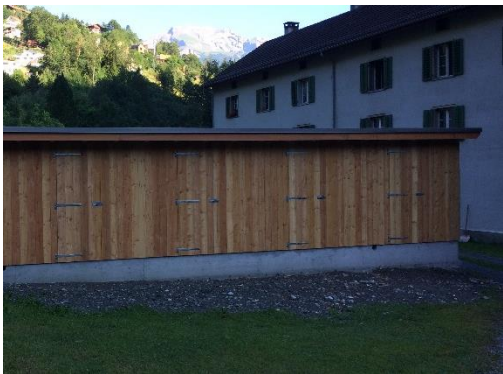
Schöpfe zur Holzlagerung
