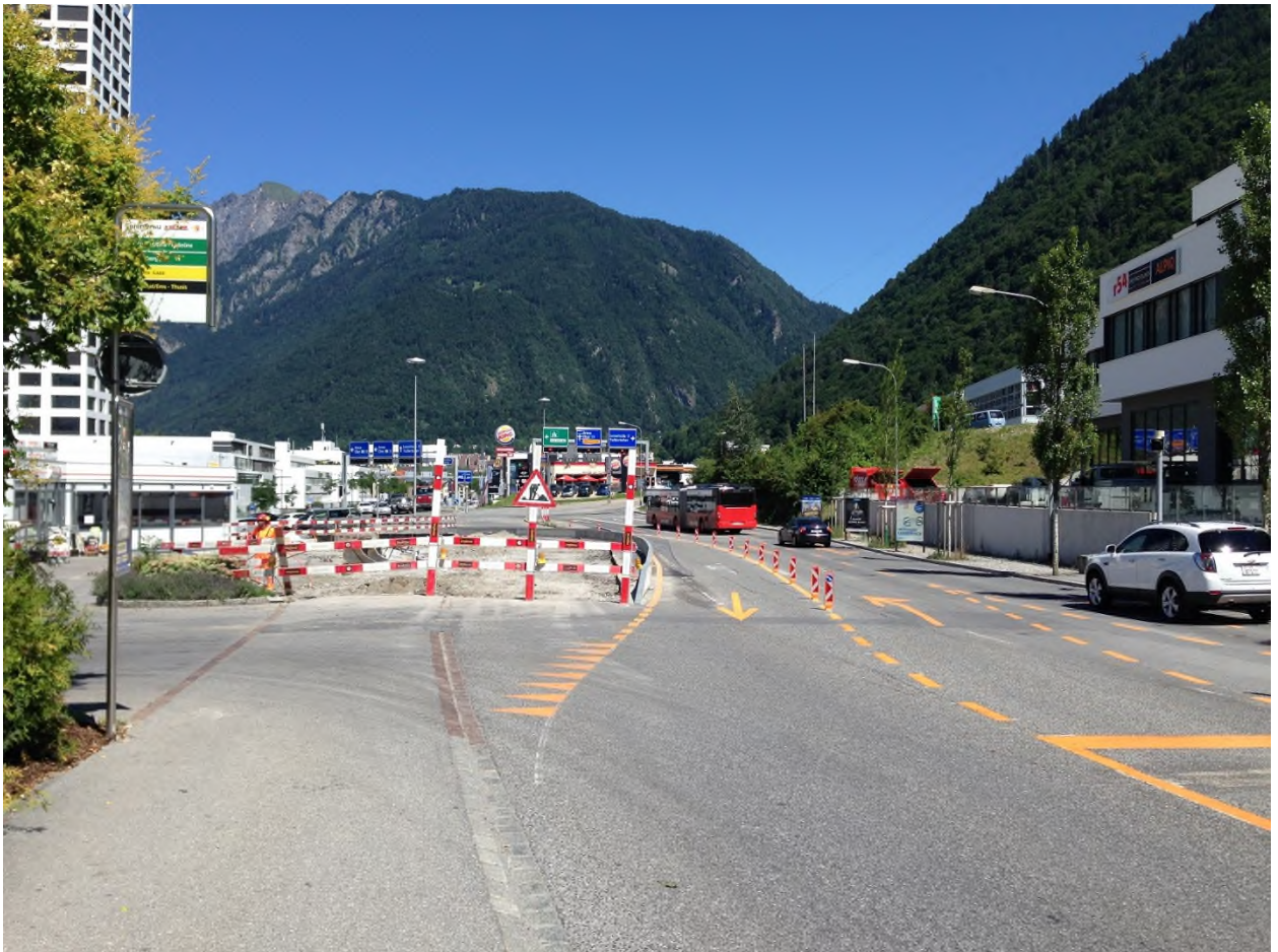
Baustelle Emserstrasse im Bereich der Schützengartenkreuzung
