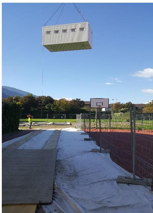
Hebe-/Platzierungsvorgang eines Modulcontainers mit 300t Kran
