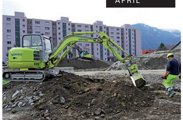
Die mit Schadstoffen kontaminierte Erde beim alten Gaswerk wird ausgehoben, sortiert und abgeführt.
