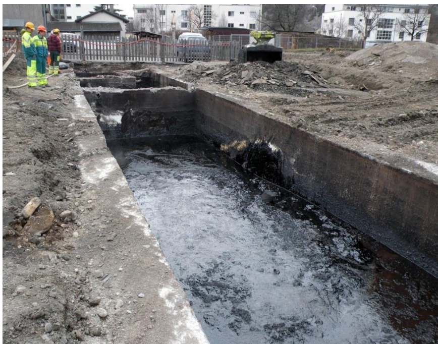
Ammoniakgrube Altes Gaswerk
