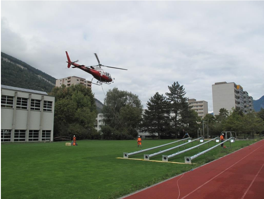
Schulhaus Rheinau: Montage der neuen Beleuchtungsmasten mit Helikopter
