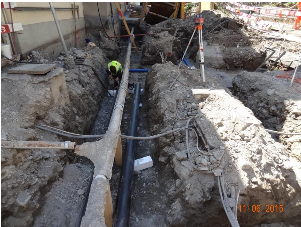
Bestehende Swisscom Leitung und die neue Fernwärmeleitung für das RhB Verwaltungsgebäude sowie Kunsthaus
