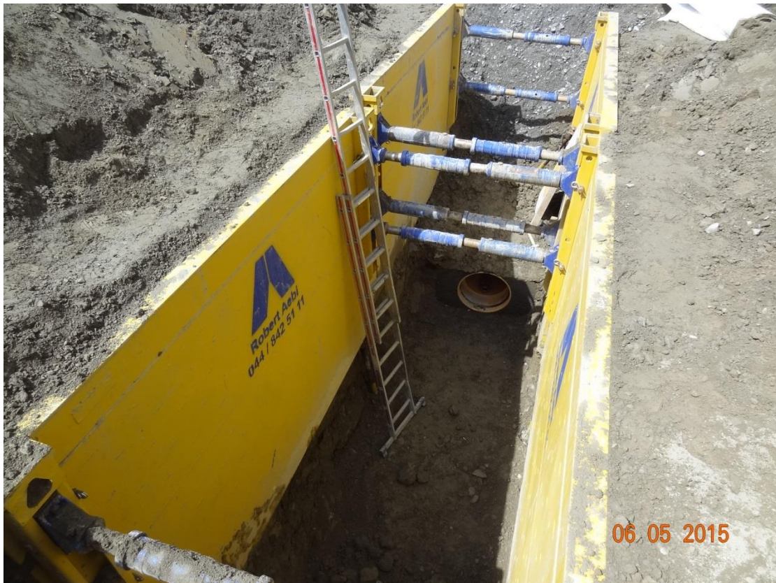
Der Graben für die neue Kanalisationsleitung
