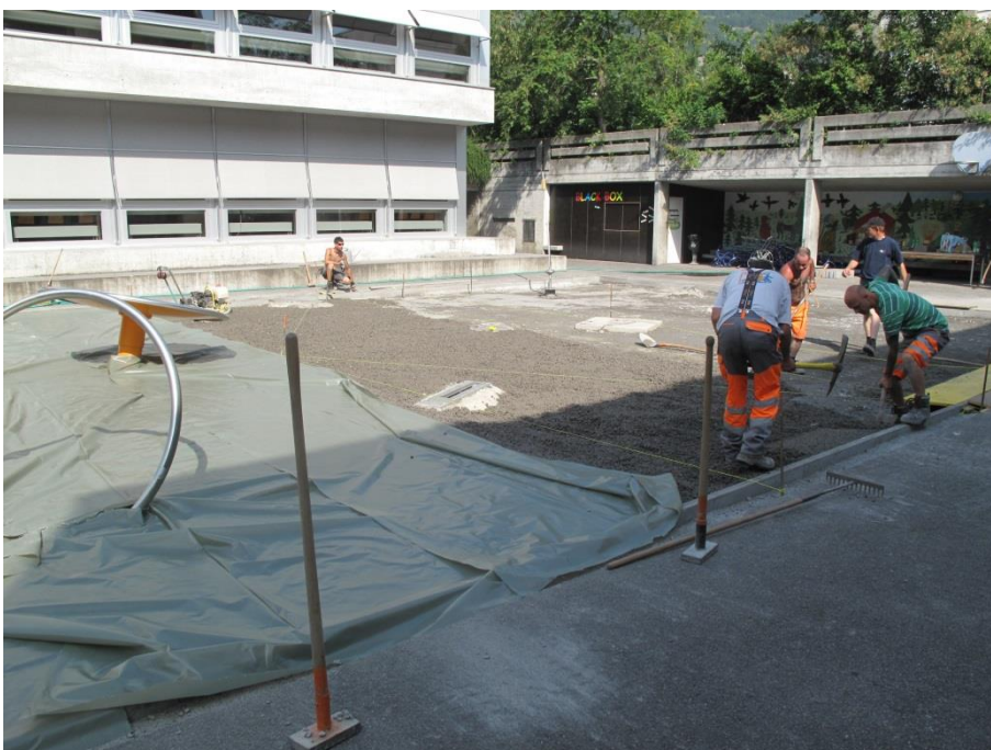
Schulhaus Lachen: Vorbereitungsarbeiten für neuen Fallschutzbelag
