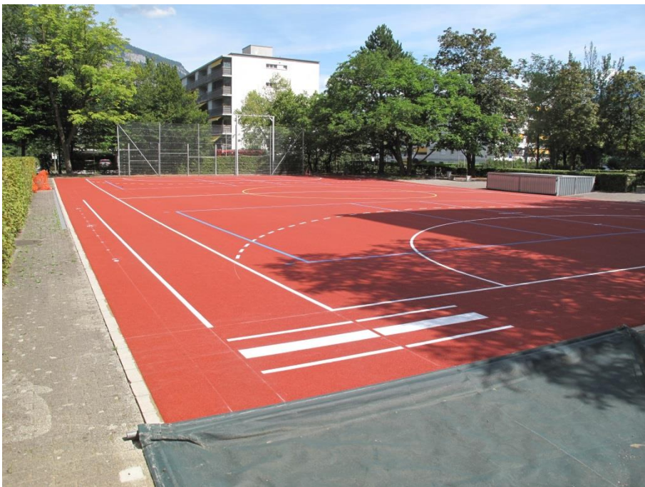
Roter Allwetterplatz im Schulhaus Lachen nach dem Retopping
