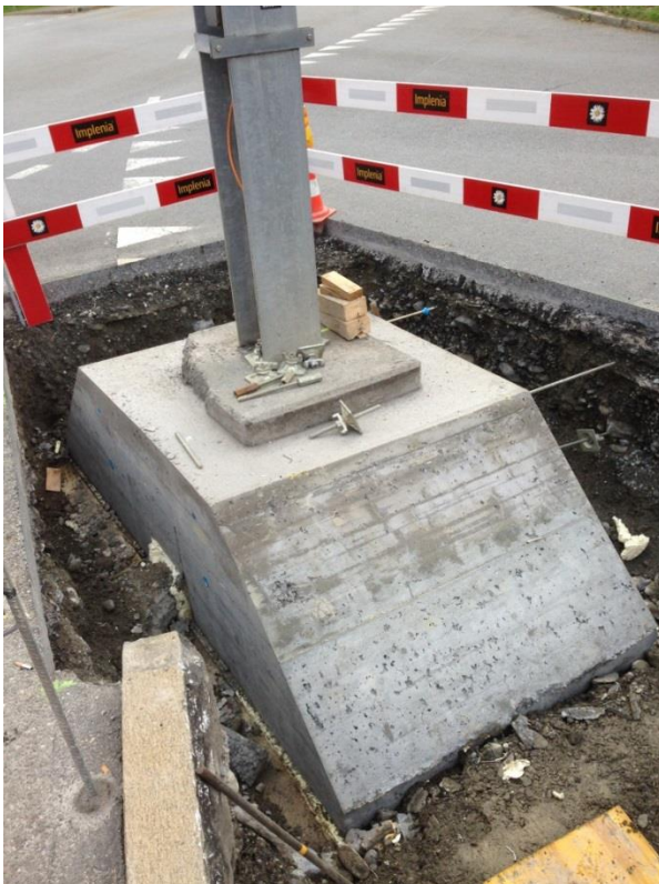
Verstärkung LSA-Fundament in Mittelinsel für die neuen Signaljoch und neue LSA
