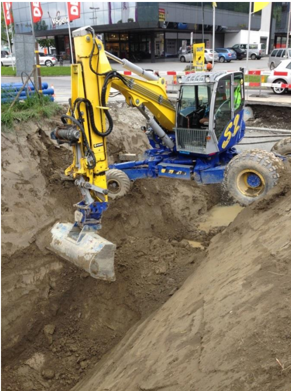
Aushub Anschluss Kanalisationsleitung Rheinfels- / Raschärenstrasse
