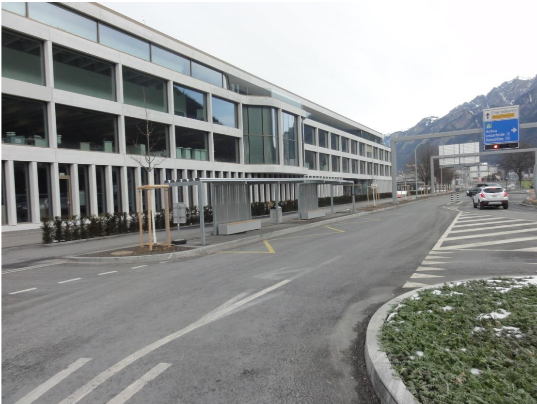
Neubau Rad- und Gehweg mit neuer Bushaltestelle vor dem Medienhaus
