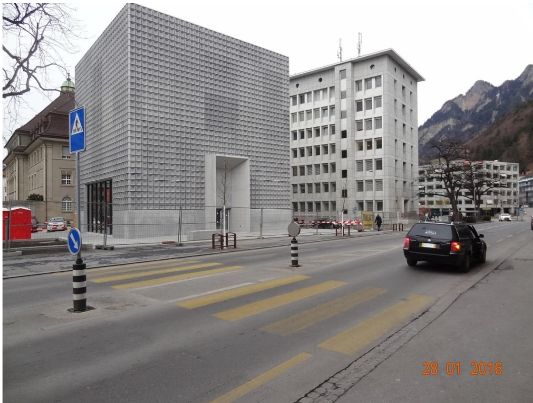
Trottoirneubau vor dem Eingang des neuen Kunsthauses
