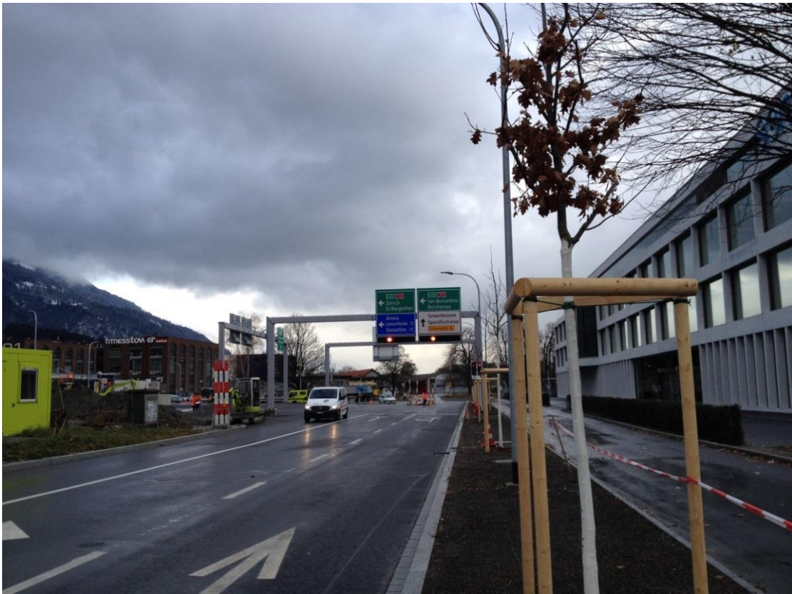
Inbetriebnahme der Lichtsignalanlage (LSA)
