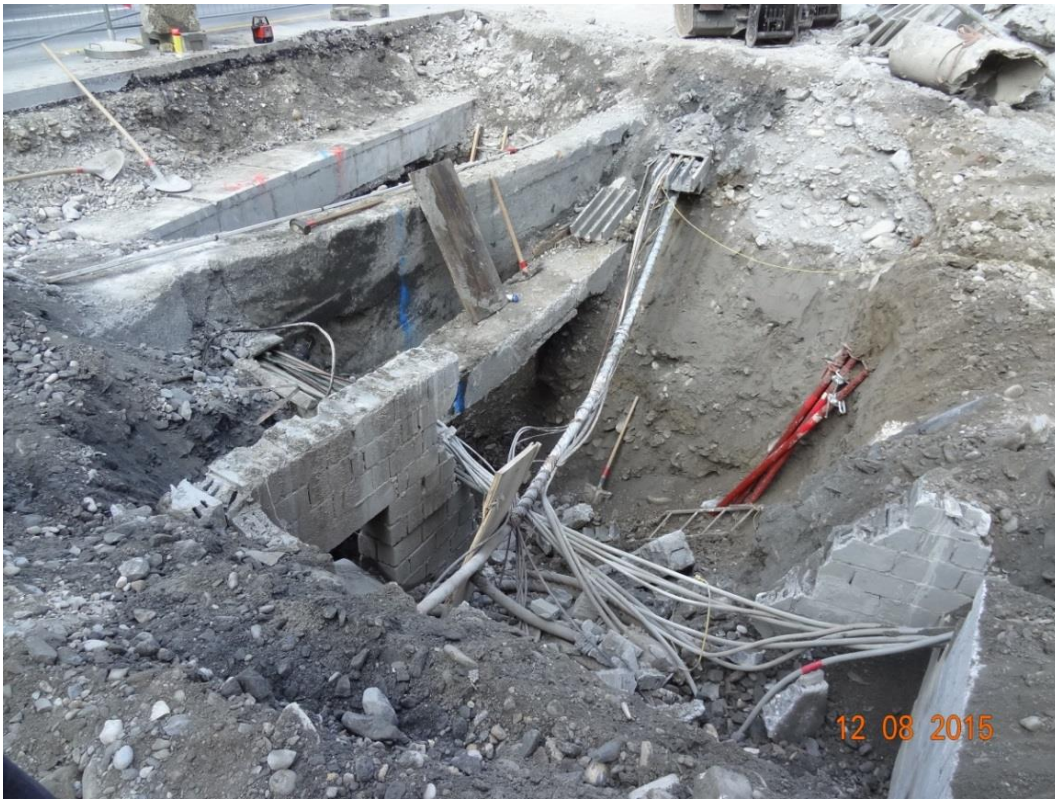
Aushub für neue Kanalisationsleitung
