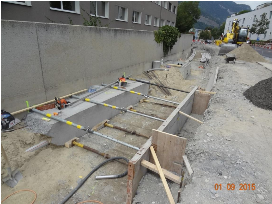
Fundamente für Baumgruben mit EW-Trasse
