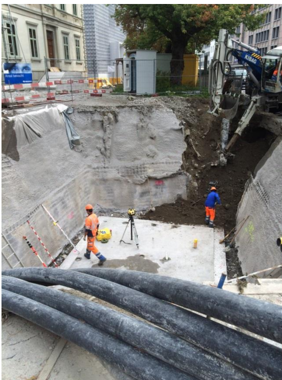
Bodenplatte und Innenleben der neuen unterirdischen Trafostation der IBC
