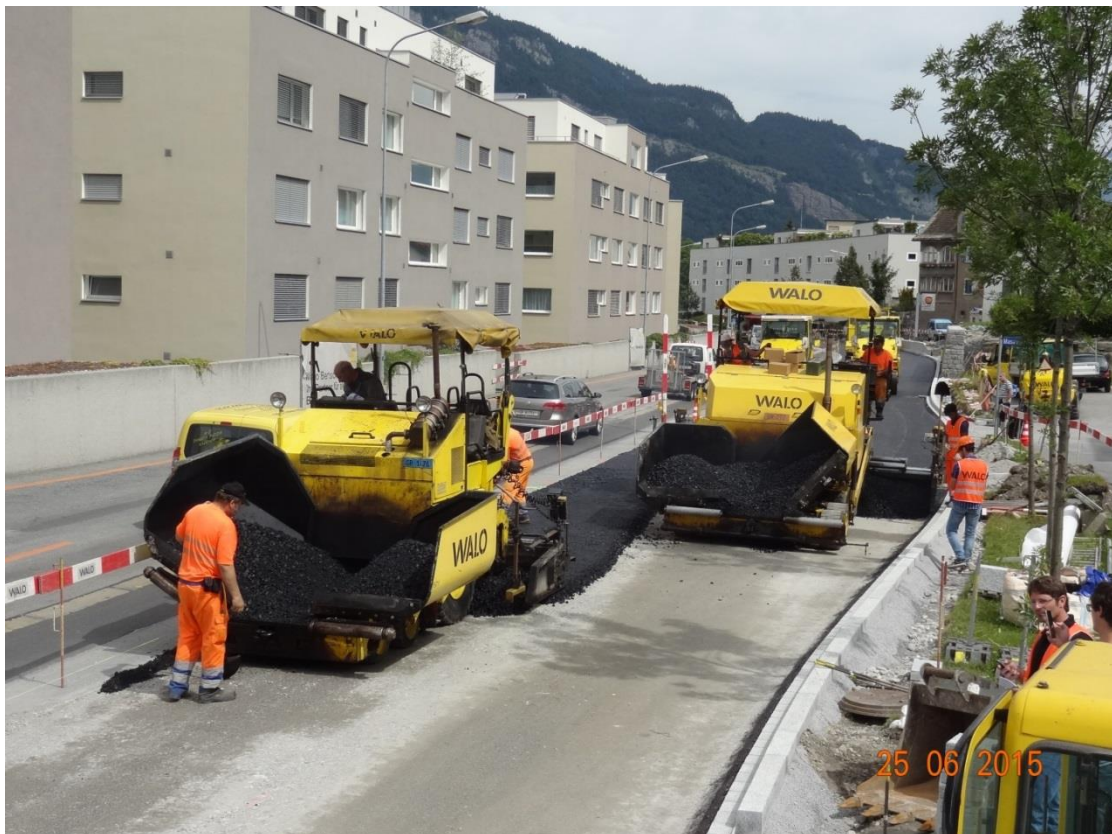
Belagseinbau bergseitige Fahrspuren
