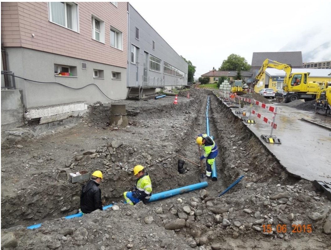
Einbau der Wasserleitung IBC
