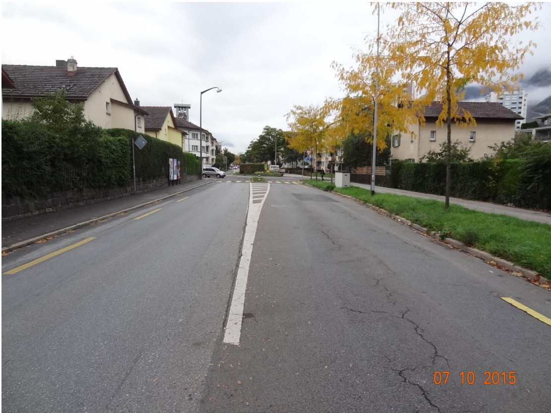
Schadensbild Ringstrasse vor Sanierung Deckbelag (Scalettastrasse – Nordstrasse)
