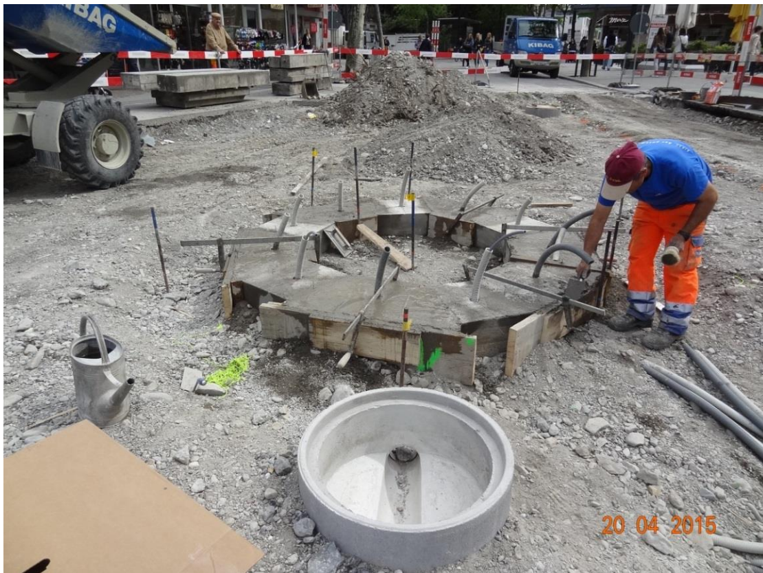
Fundament der elf Düsen des begehbaren Wasserspiels
