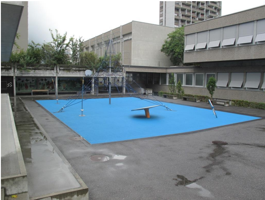
Neuer normgerechter Fallschutzbelag im Innenhof des Schulhaus Lachen
