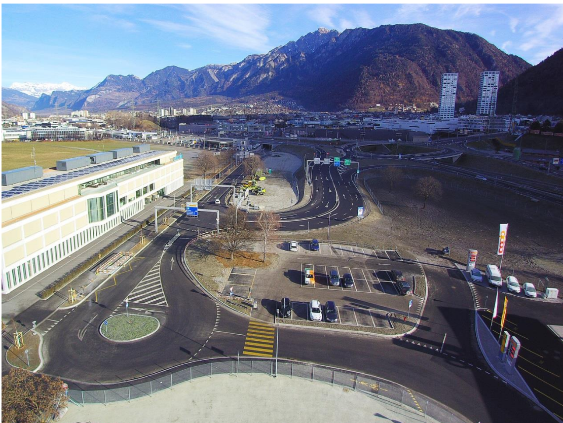
Der Wendekreis Spundisstrasse, die dritte Fahrspur, die neue LSA sowie der neue öffentliche Parkplatz
