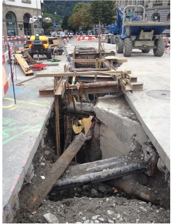
Erstellen der neuen Kanalisationsleitung
