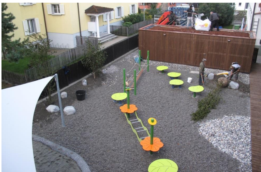
Fertigstellung Aussenraum mit Geräteschopf Kindergarten Calanda
