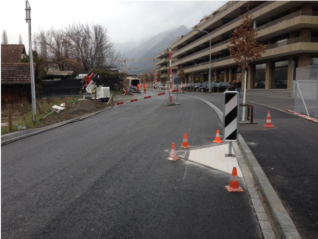
Markierungsarbeiten Einengungen Zone 30
