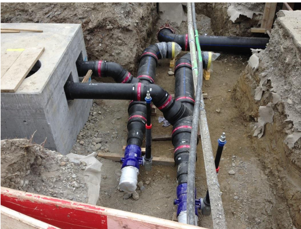
Anergieschacht mit Vor- und Rücklaufleitung
