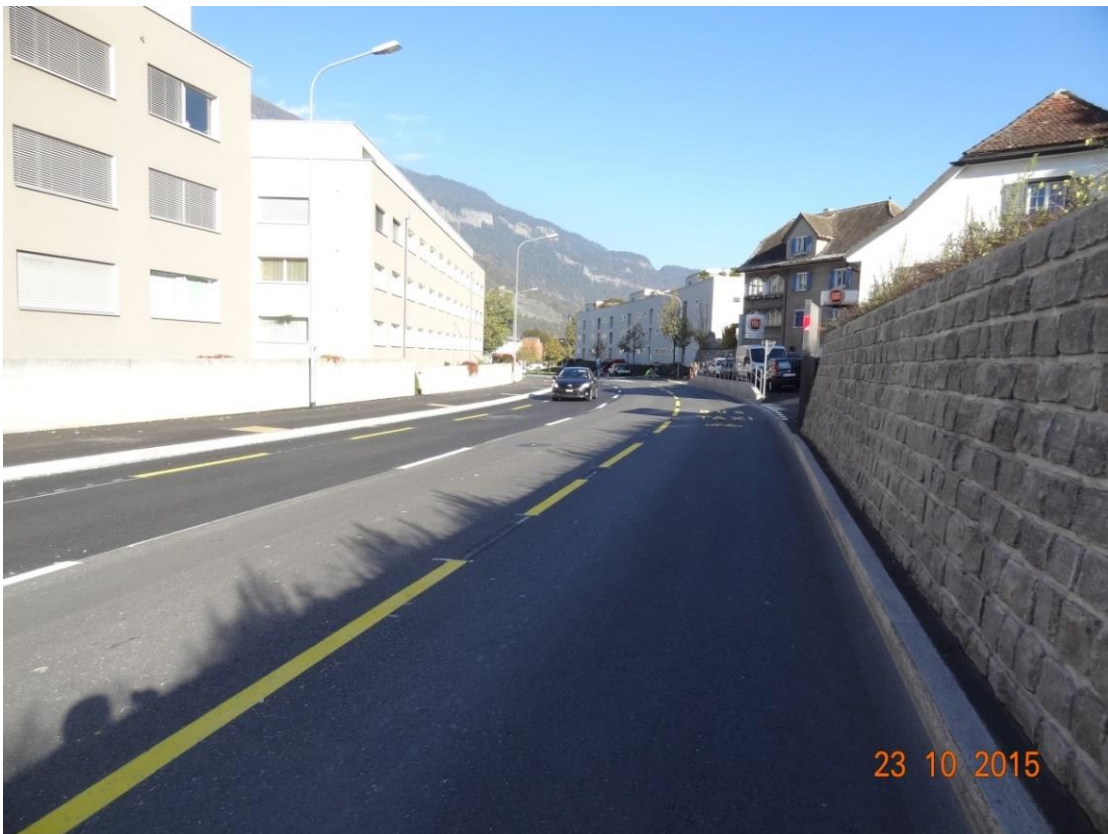
Die fertig erstellte Bus- und Radspur der 2. Etappe
