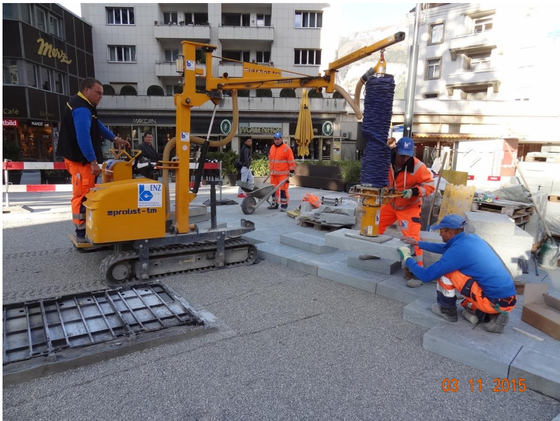
Verlegen der Natursteinplatten mit maschineller Hilfe
