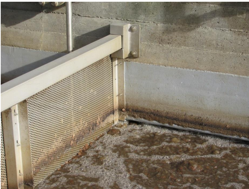
Beschichtete Belüftungsbecken
