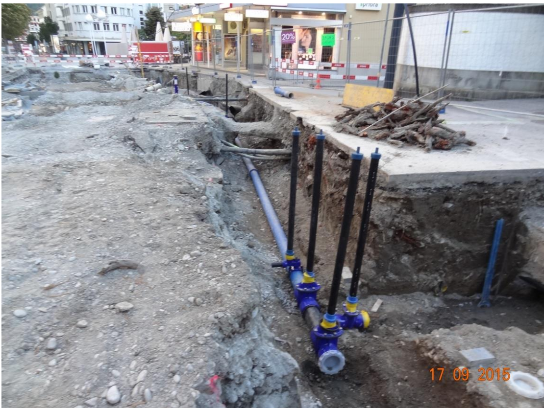
Neue Wasserleitung der IBC Energie Wasser Chur
