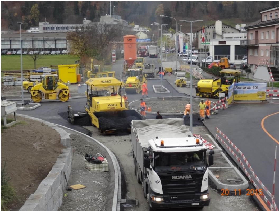
Belagseinbau Kreisell Ringstrasse
