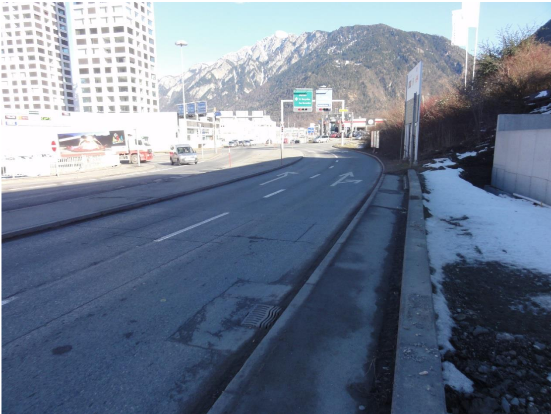
Situation vor Baubeginn
