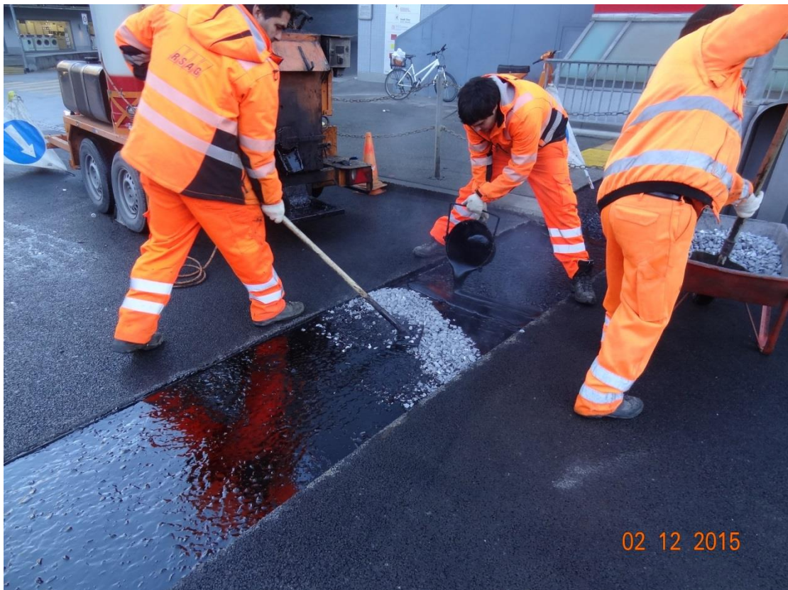
Fugensanierung am Übergang Tivolibrücke
