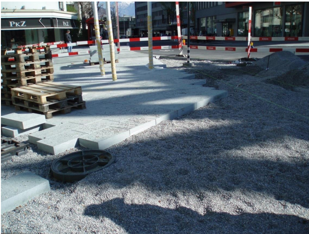
Versetzen der Natursteinplatten um die „Lotusblüten“
