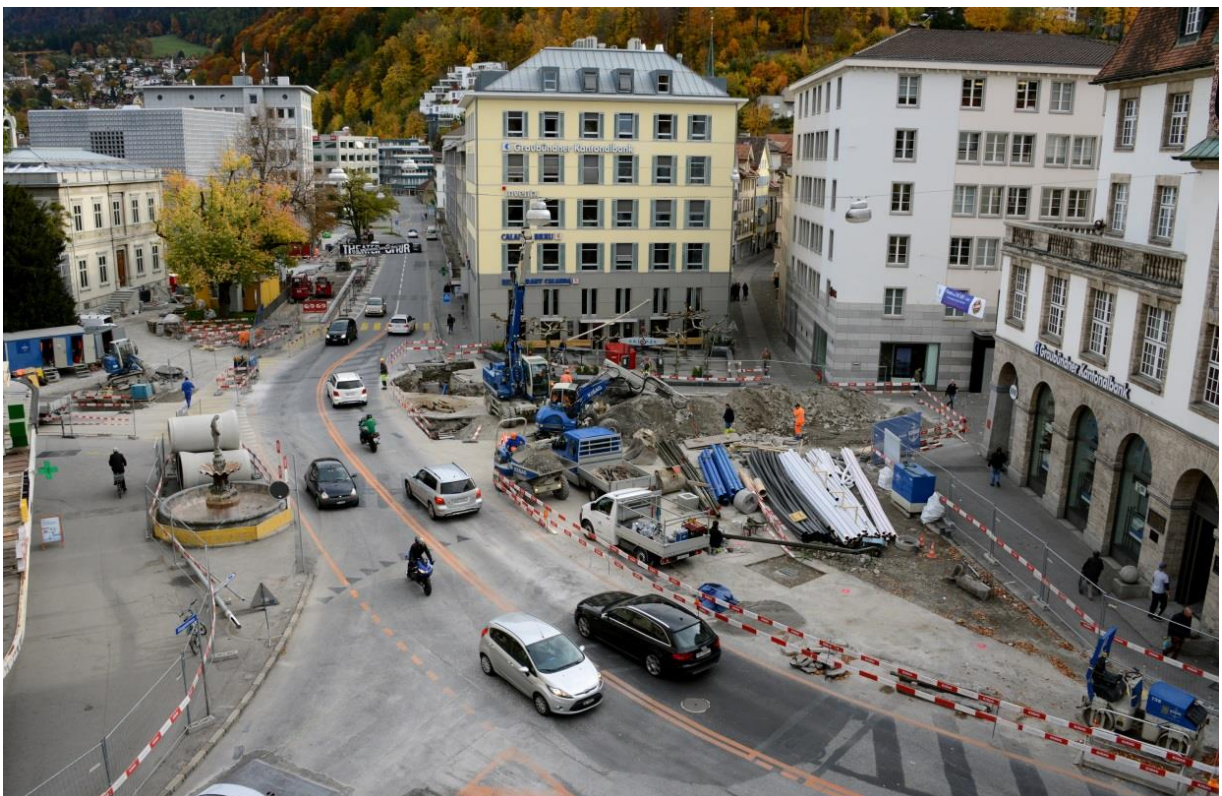
Arbeiten 1. Etappe mit provisorischer Verkehrsführung
