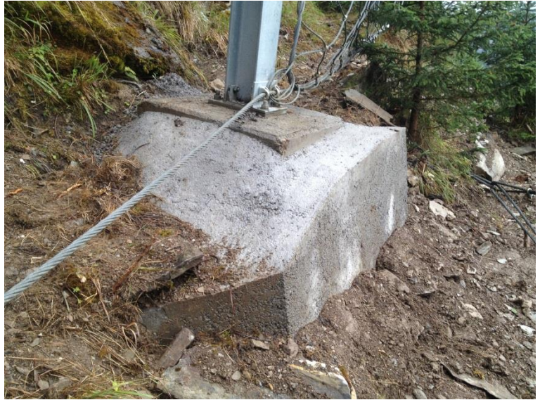
Sockel einer Stütze der Lawinenverbauung Fürstenbrunnen vor und nach Sanierung
