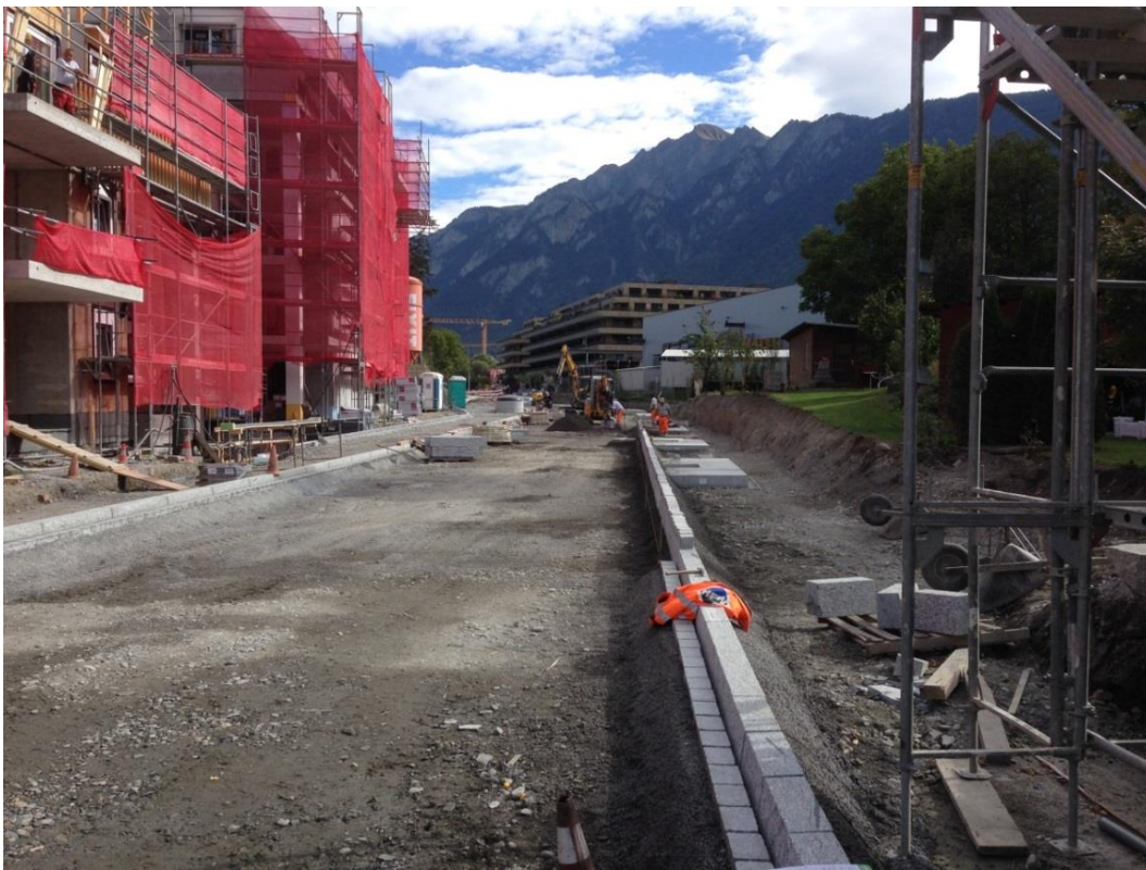
Versetzen der Wasser- und Randsteine
