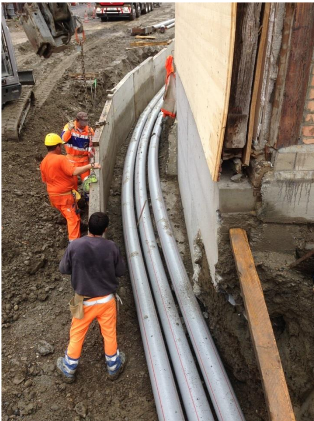
Schalung EW-Kabelblock entlang Haus Passanante
