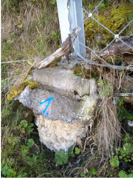
Sockel einer Stütze der Lawinenverbauung Fürstenbrunnen vor und nach Sanierung
