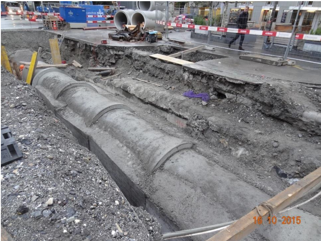
Neue Zementrohre des Mühlbachs
