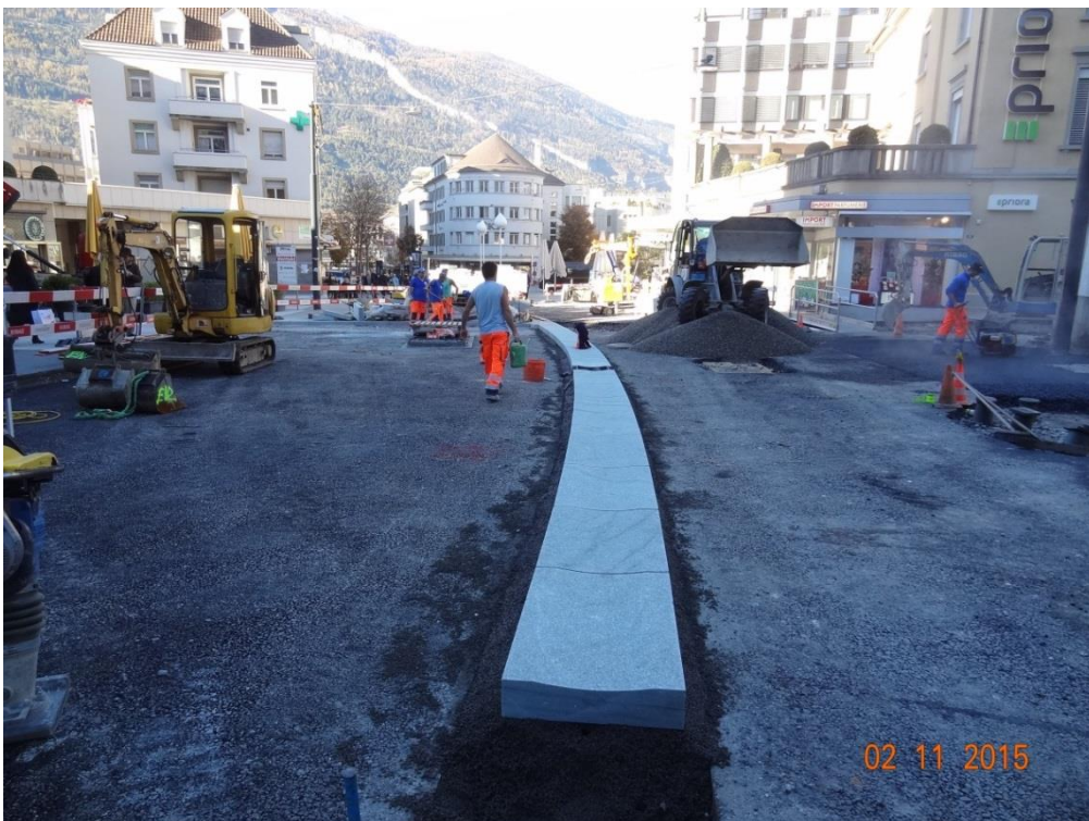
Setzen der Wasserinne, welche auch als Führungselement für Sehbehinderte dient
