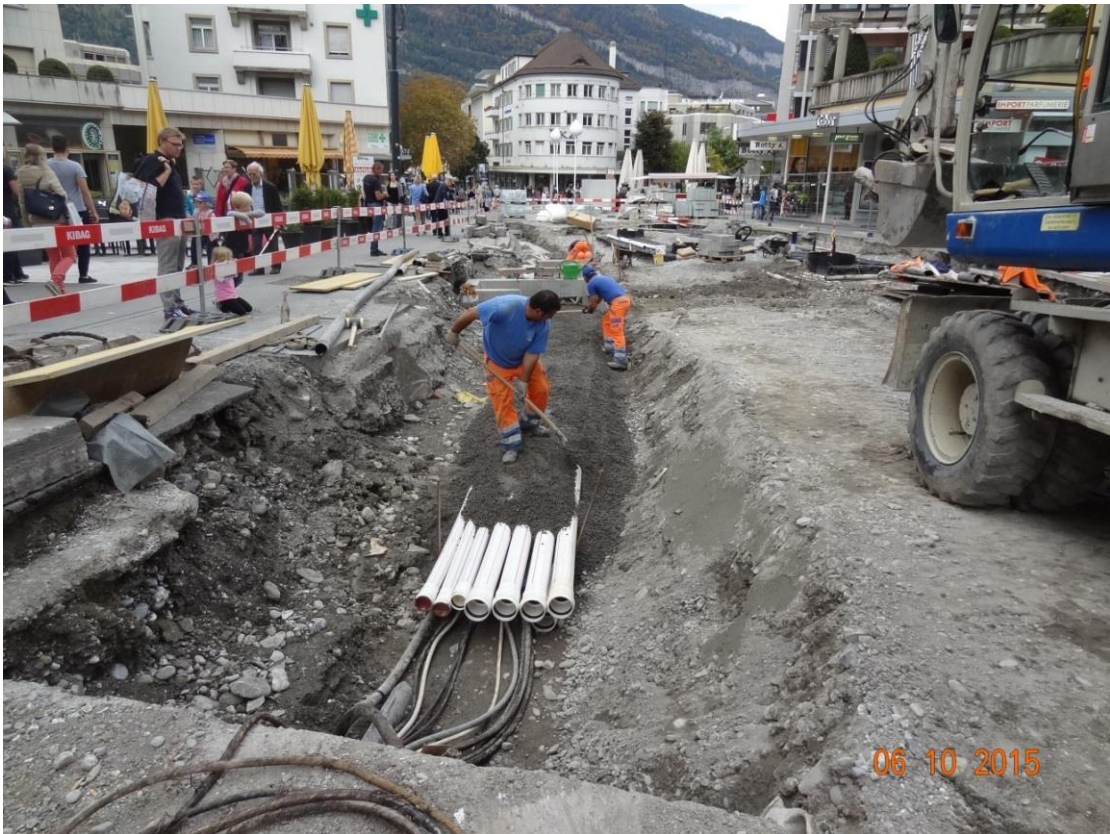
Werkleitungsarbeiten EW-Trasse
