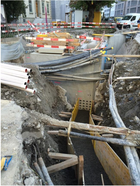
Kabelblock für EW-Trasse
