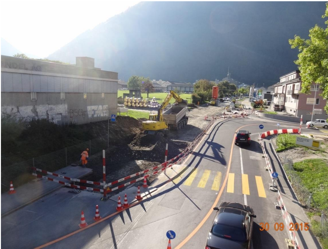
Bauarbeiten Seite Salvatoren- / Ringstrasse
