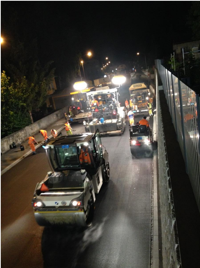
Einbau Deckbelag an der Masanserstrasse
