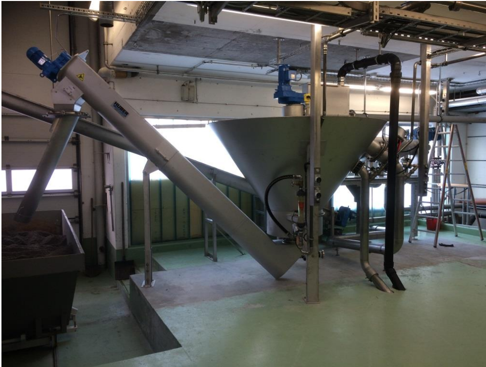
Die erneuerte Sandwaschanlage im Rechengebäude
