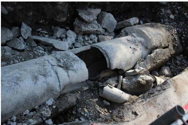
Der eingebrochene Betonkanal
