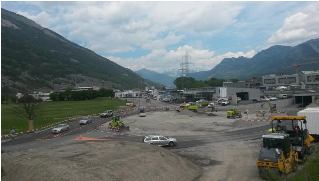
Umfahrung für den Bau des Kreisels
