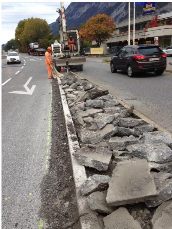
Rückbau der Mittelinsel
