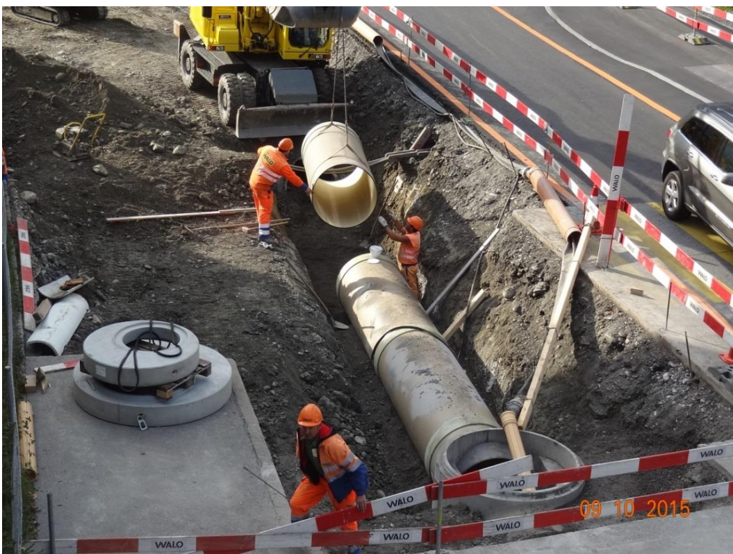
Kanalisationsneubau mit Rohren aus Glasfaser, Durchmesser 1100 mm
