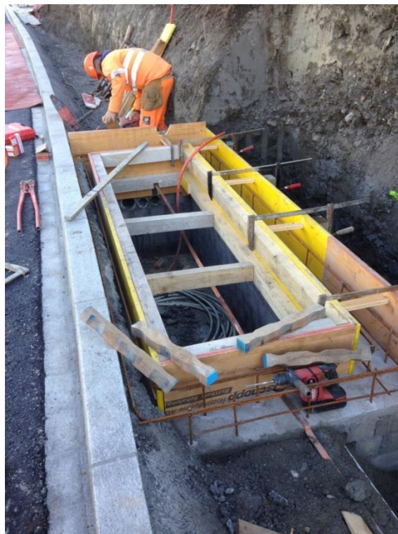
Schalung für Betonkranz EW-Schacht
