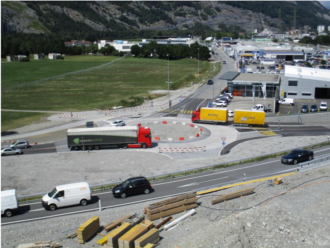
Die fertig erstellte Betonfahrbahn des Kreisels
