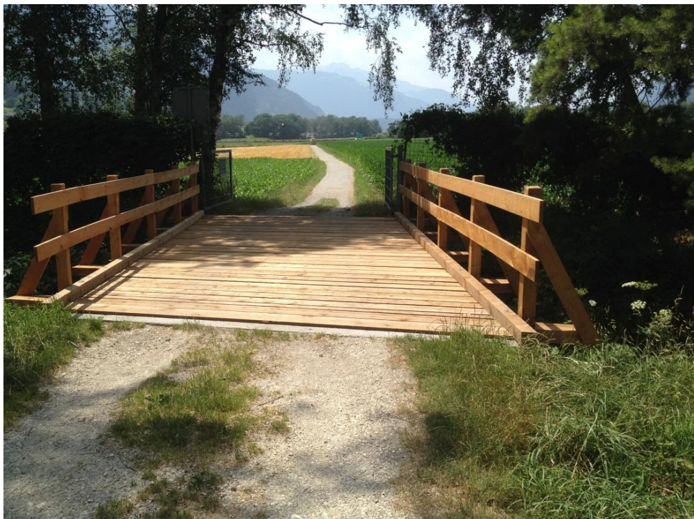
Arbeiten für Dritte: - Neu erstellte Brücke mit Churer Lärchenholz beim Rossboden
