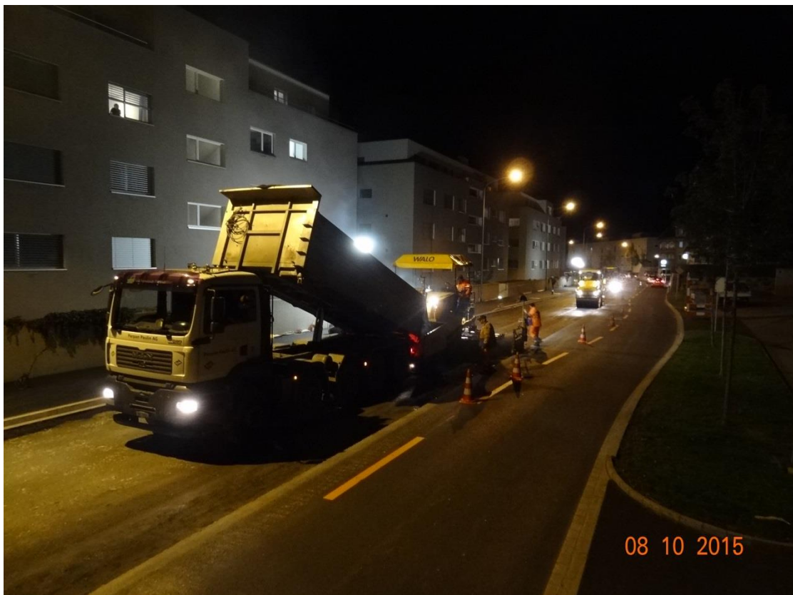
Belagseinbau an der talseitigen Fahrspur während der Nacht
