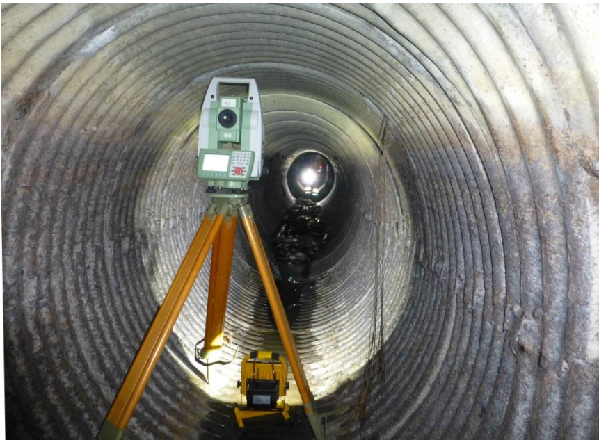
Detail- und Höhenaufnahmen im Mühlbachkanal alte KEB
