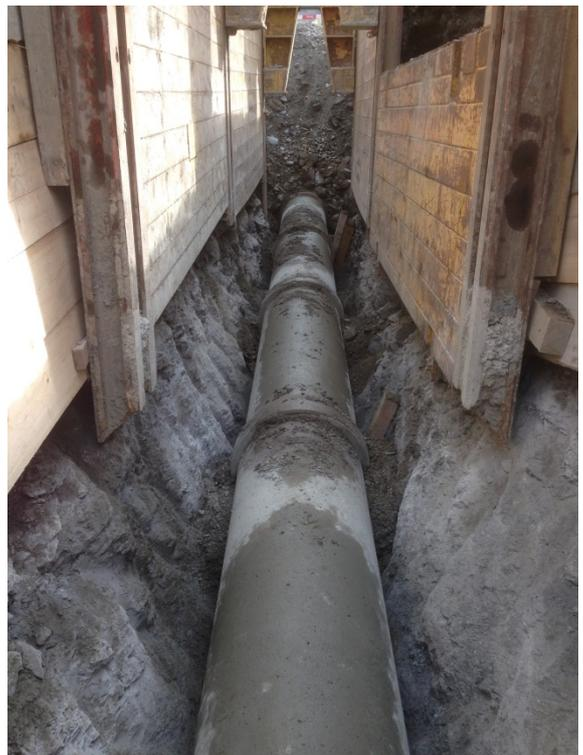
Kanalisationsleitung mit Durchmesser 500 mm.
