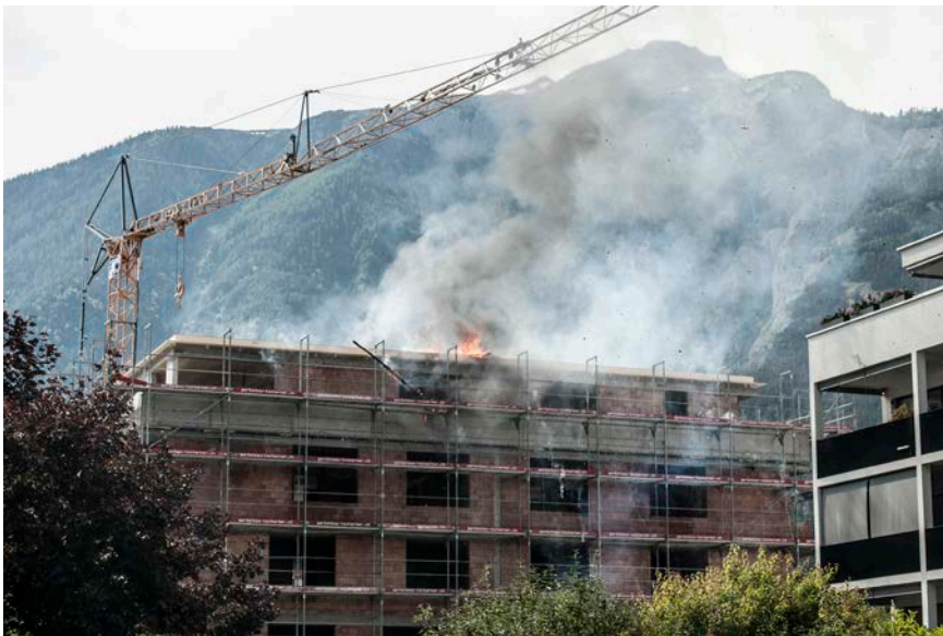
Brand auf dem Flachdach eines Neubaus vom 6. Juni. Auf dem Flachdach eines Neubaus geriet dort gelagertes Holz für den Bau in Brand. Da ebenfalls Gasflaschen auf dem Dach lagerten, musste die Feuerwehr mit äußerster Vorsicht vorgehen. Eine der Gasflaschen explodierte, eine weitere wurde dadurch vom Dach geschleudert. Die übrigen Gasflaschen wurden mit dem Wasserwerfer des Hubretters gekühlt und der Brand danach gelöscht.
