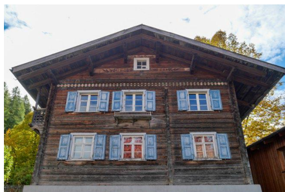
Ansicht Strassenfassade von Nordosten
