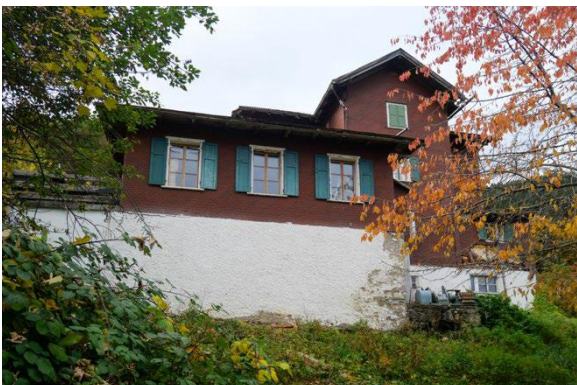
Ansicht von Norden mit Tanzsaalanbau
