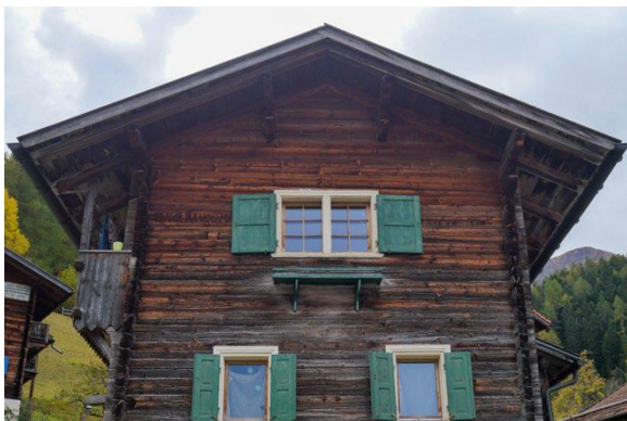
Teilansicht der Talseite im Norden
