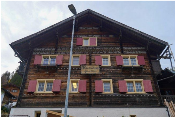
Ansicht Wohnhaus von Norden
