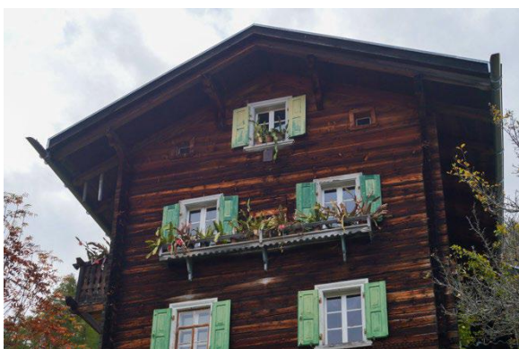
Teilansicht talseitige Nordwestfassade
