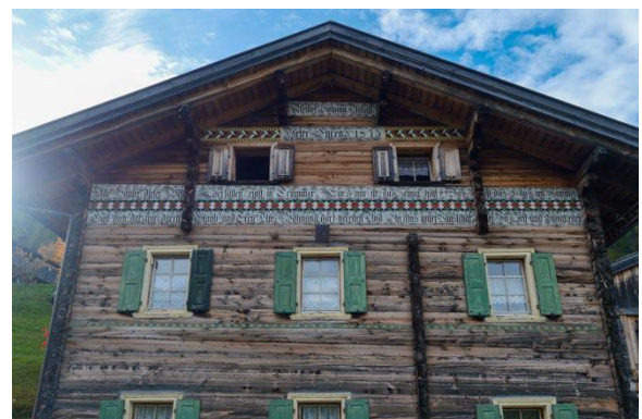
Ansicht Strassenfassade von Norden
