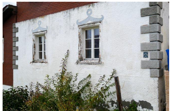
Gemalte Fensterbekrönung Westfassade
