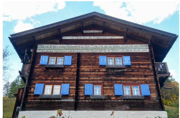
Ansicht der Talsfassade von Nordwesten
