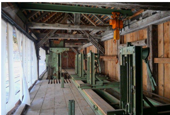
Ansicht des seitlich offenen Sägeraums
