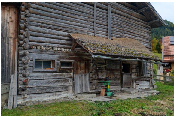
Teilansicht Strassenseite im Norden
