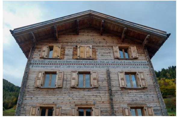
Teilansicht der Strassenfassade
