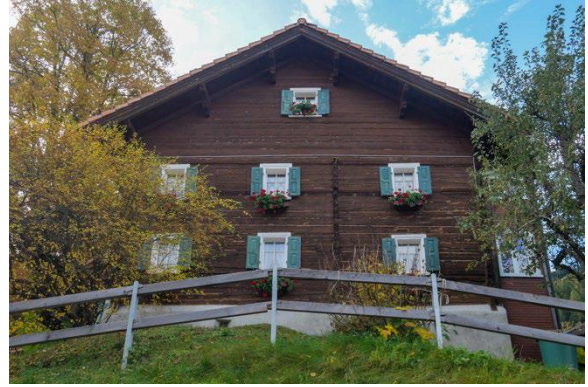
Ansicht Tal- und Strassenfassade im Norden
