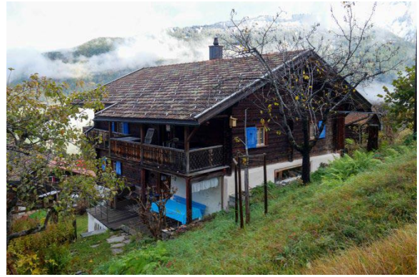
Ansicht von Osten
