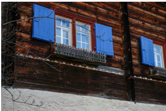
Fries an der Nordwestfassade
