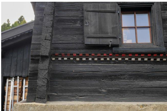
Würfelfries an der Nordfassade
