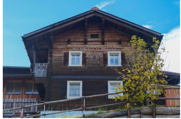
Nordfassade zum Tal
