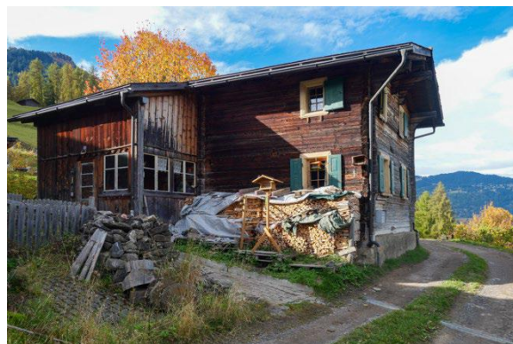
Ansicht von Osten
