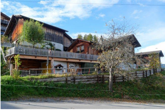
Gesamtansicht von Nordosten
