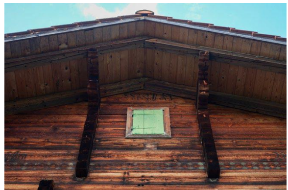
Giebel mit Inschrift an der Nordwestfassade
