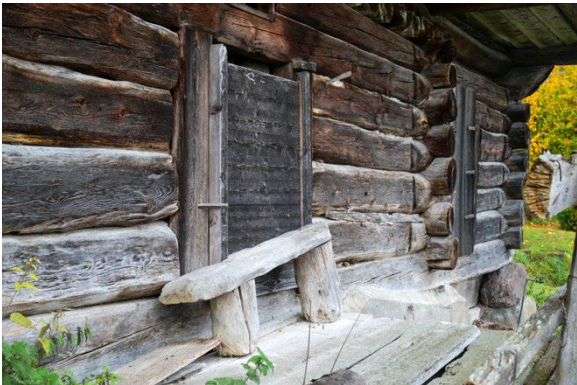
Eingänge an der Nordseite
