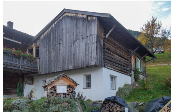
Ansicht Stall von Nordwesten
