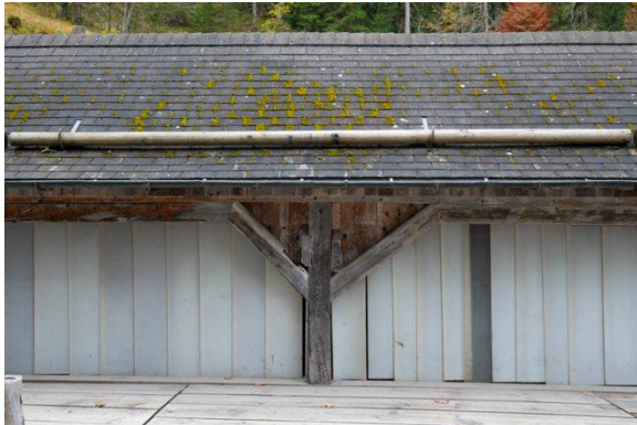
Teilansicht der Strassenseite
