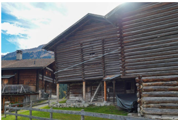
Ansicht vom Wendeplatz im Norden
