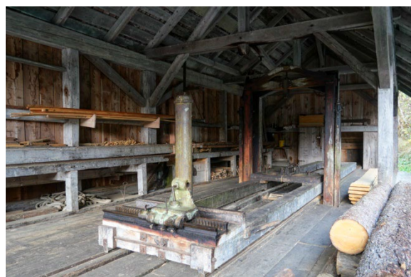
Ansicht offener Sägeraum
