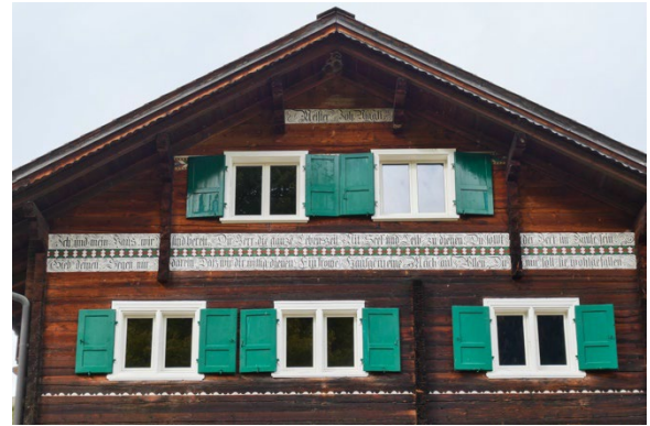
Teilansicht von Südosten
