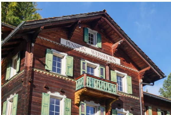
Teilansicht von Südosten
