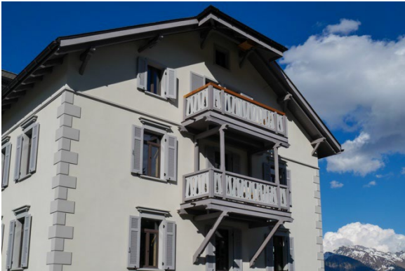
Teilansicht von Südseite
