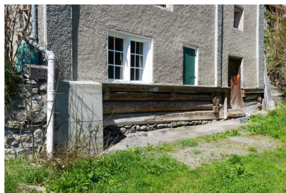
Holzbalkenlagen im Sockel
