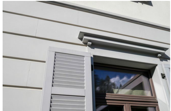
Rekonstruierte Wandverkleidung und Fensterverdachung
