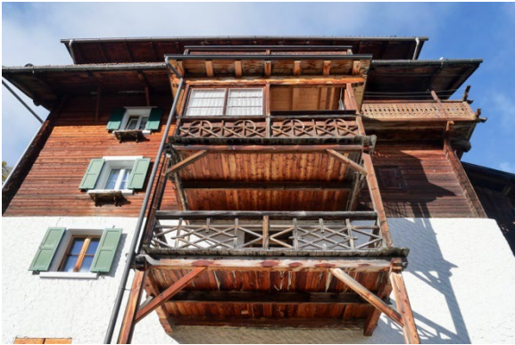
Balkonvorbau zur Strassen und Talseite
