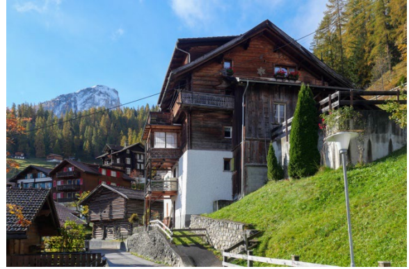
Teilansicht von Norden
