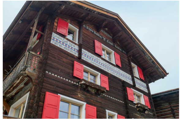
Teilansicht von Südosten
