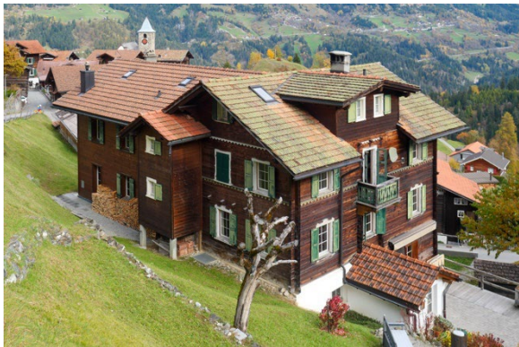
Teilansicht von Südwesten
