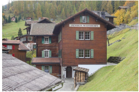
Teilansicht von Norden
