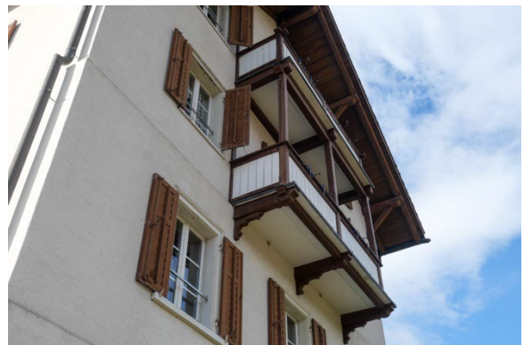
Balkone an der Nordseite
