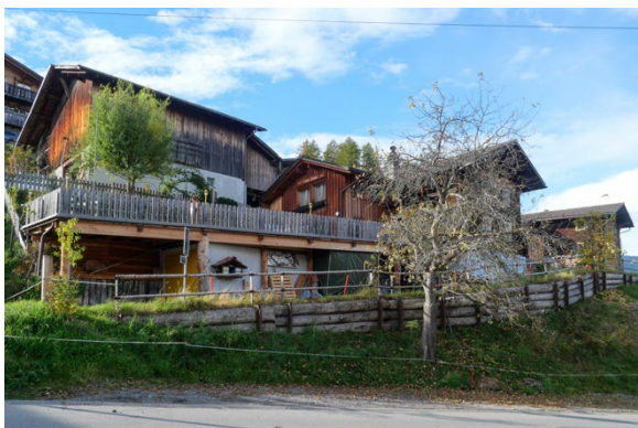
Gesamtansicht von Nordosten
