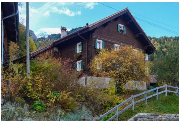
Ansicht von Nordosten
