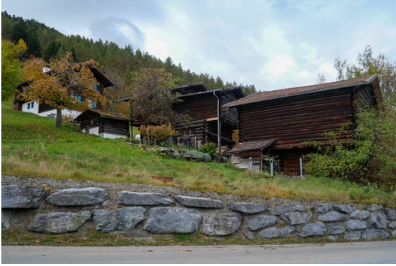
Ansicht von Osten mit Nachbargebäuden
