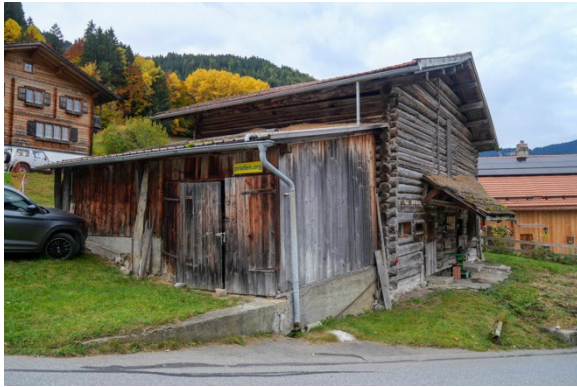
Ansicht von Nordosten
