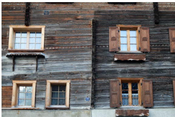
Gwättköpfe und Frieze an der Nordfassade
