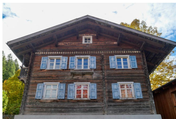
Ansicht Strassenfassade von Nordosten
