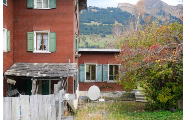
Ansicht des Tanzsaalanbaus im Osten
