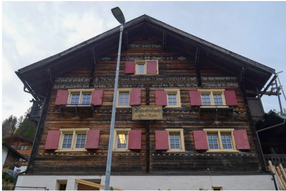
Ansicht Wohnhaus von Norden
