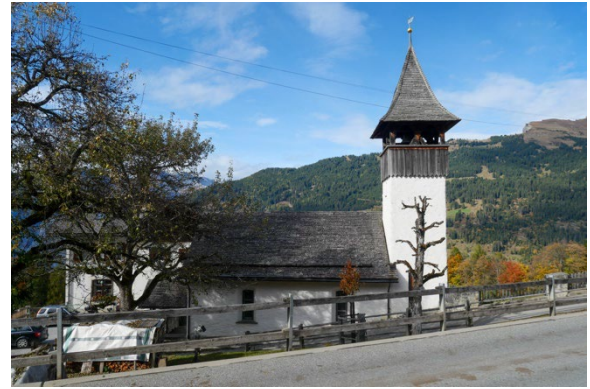
Ansicht von Süd
