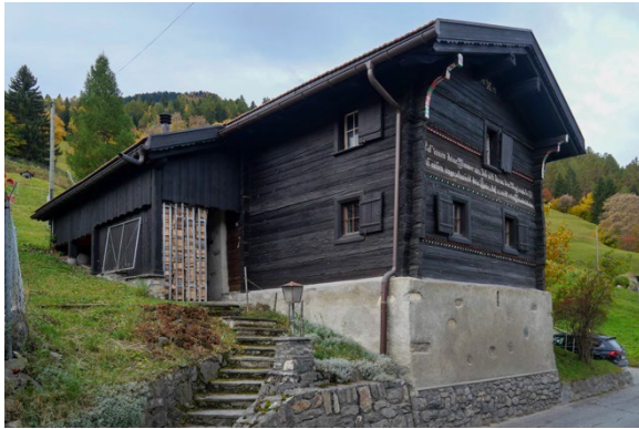
Ansicht von Nordosten
