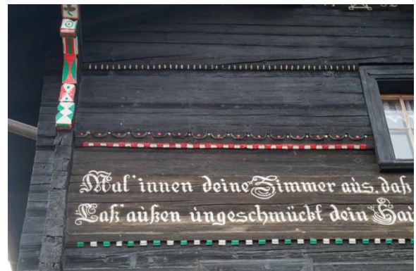
Frieze und Bemalung an der Nordfassade
