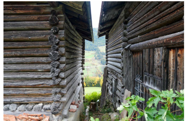
Zwischenraum zum Nachbargebäude
