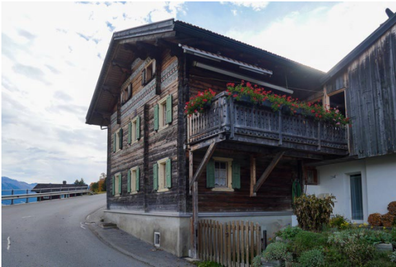
Ansicht Wohnhaus von Nordwesten
