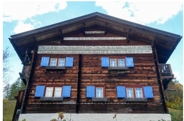
Ansicht der Talsfassade von Nordwesten
