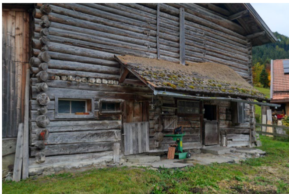
Teilansicht Strassenseite im Norden
