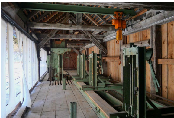
Ansicht des seitlich offenen Sägeraums
