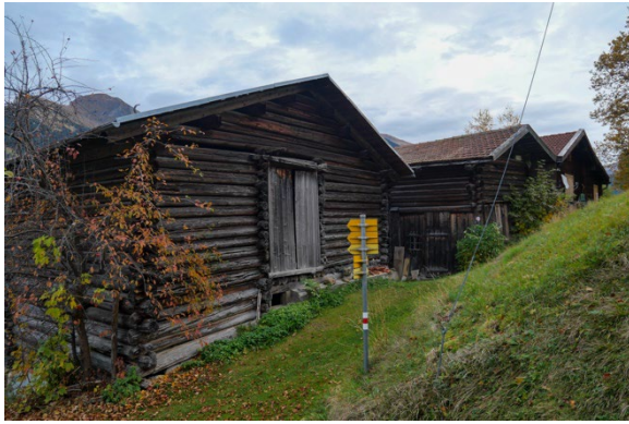
Ansicht von Südwesten mit Nachbargebäuden
