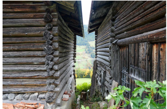
Zwischenraum zum Nachbargebäude
