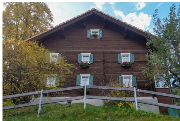
Ansicht Tal- und Strassenfassade im Norden
