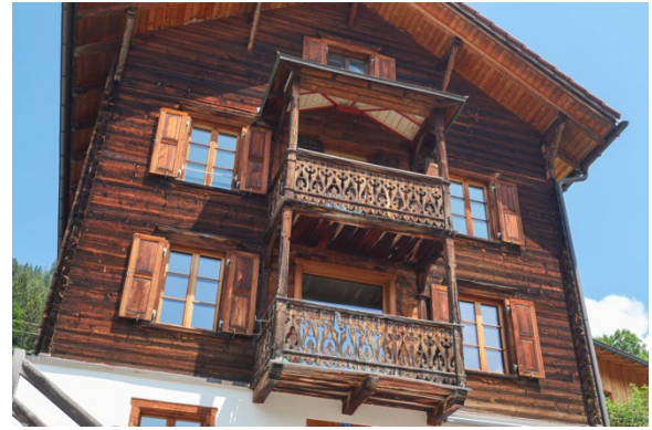
Südfassade mit Balkonvorbau
