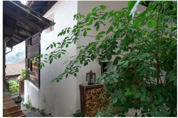
Teilansicht von Nordosten
