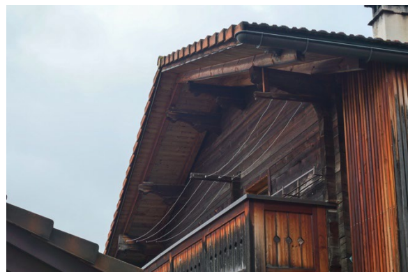
Teilansicht Giebel Südostseite
