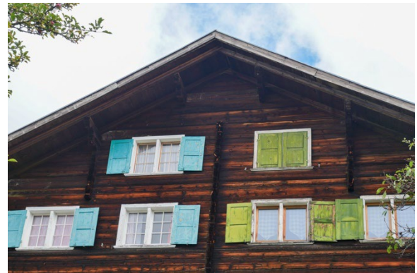
Teilansicht Giebel Südwestfassade
