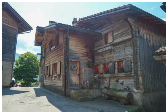
Ansicht von Nordwesten mit Eingangsvorbau
