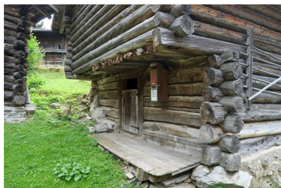
Teilansicht Nordseite mit Vorschub und Eingang
