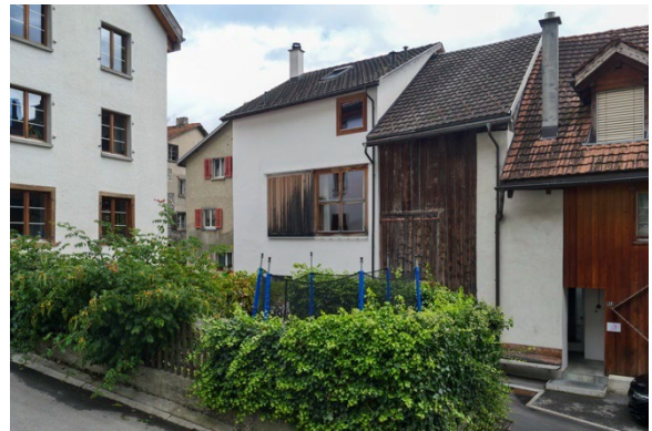
Ansicht von Westen
