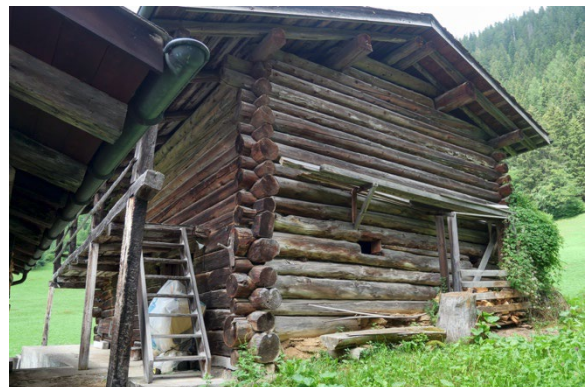
Ansicht von Osten
