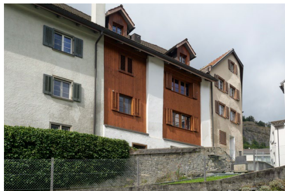
Ansicht von Osten
