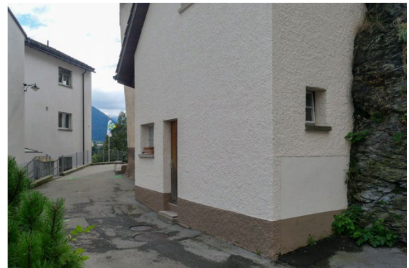
Eingang Anbau Nordseite
