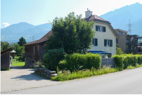
Ansicht von Westen
