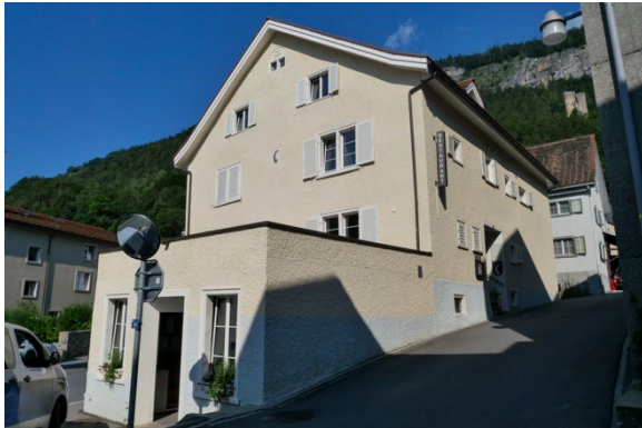
Ansicht von Osten
