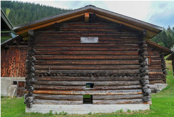
Ansicht von Südseite
