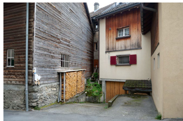
Teilansicht von Nordwesten
