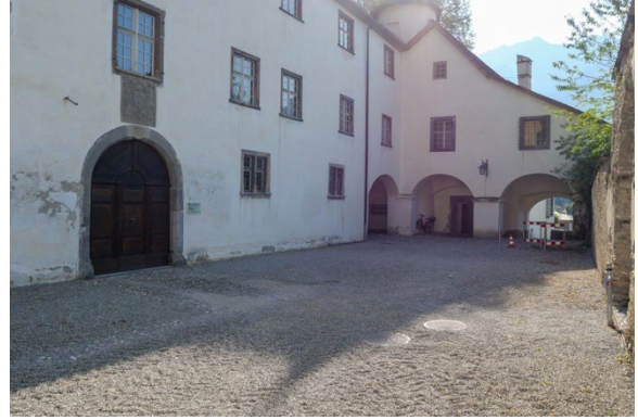
Ansicht Ostfassade und Durchfahrt
