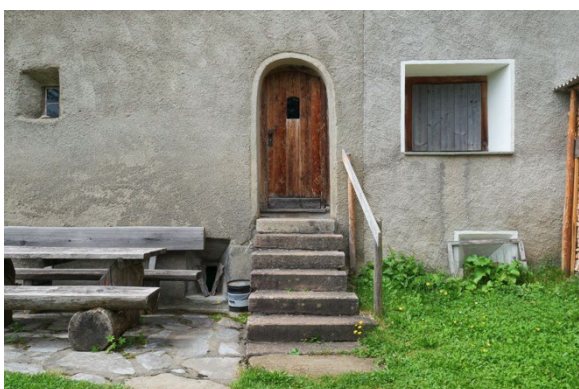
Teilansicht Ostseite mit Eingang
