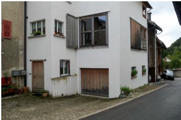
Teilansicht von Nordwesten
