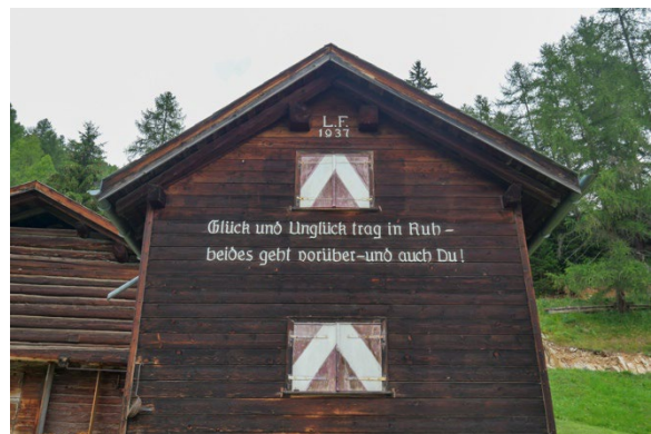
Teilansicht Südseite mit Hausspruch
