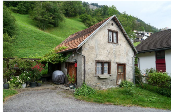
Ansicht ehemalige Schmiede von Südosten
