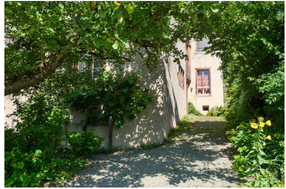
Teilansicht der Hauszugangs von Osten
