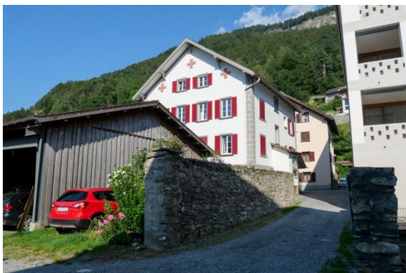
Ansicht von Osten
