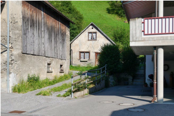
Ehemalige Schmiede von der Strasse her
