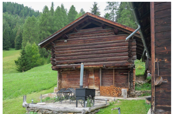
Ansicht von Südseite
