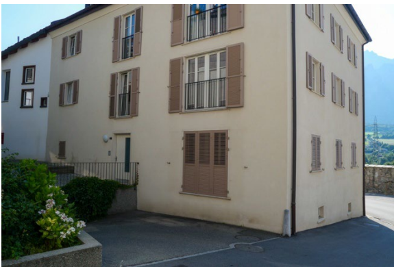
Teilansicht von Südwesten
