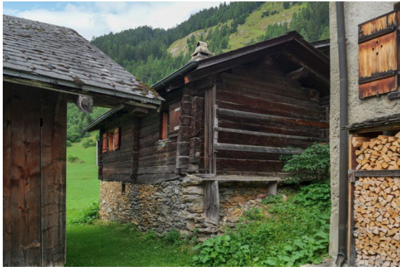
Ansicht von Osten
