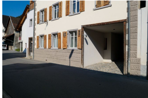
Teilansicht von Nordosten mit Durchfahrt
