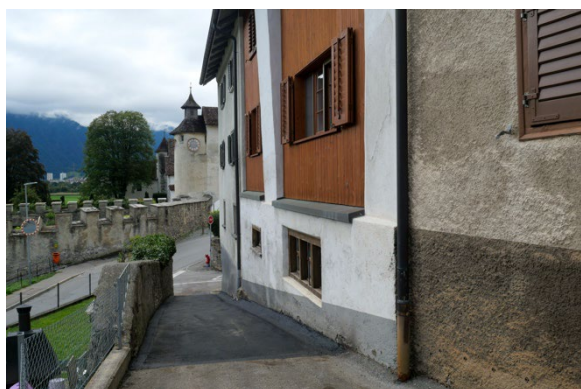
Teilansicht von Nordosten
