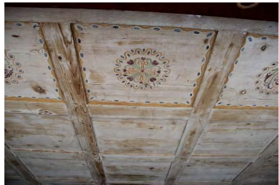
Deckenbemalung der einst zweiseitig offenen Veranda
