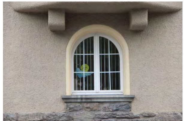
Erkerabstützung und Rundbogenfenster
