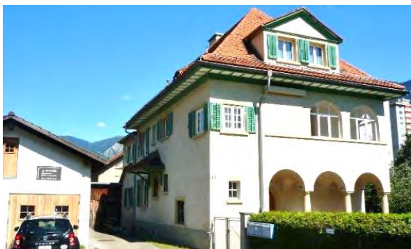
Büro- und Wohnhaus, Rheinstrasse 186
