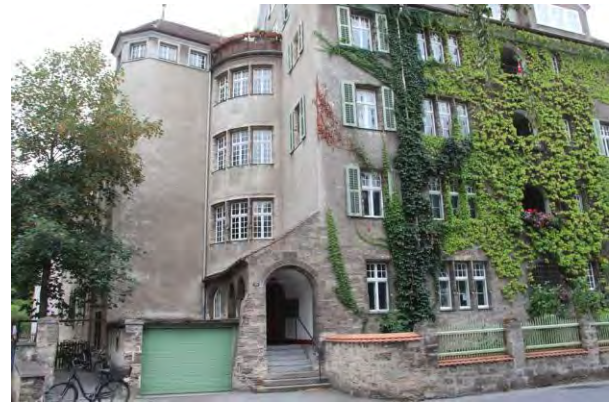
Ansicht von NO mit Haupteingang und Treppenturm
