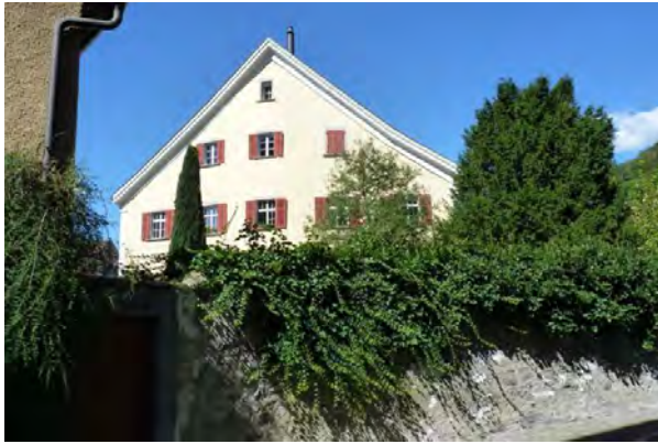
Ansicht von Süden (Museumstrasse)
