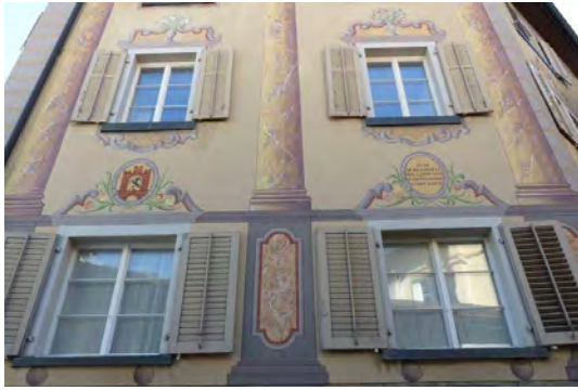
Detailaufnahme Fassadenbemalung (Ostfassade)
