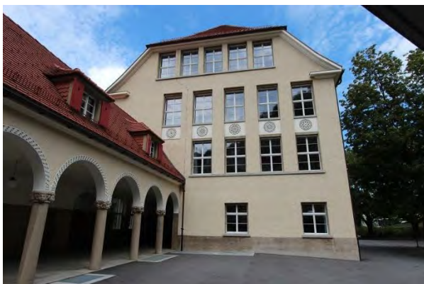
Ansicht von Süden, Hauptbau
