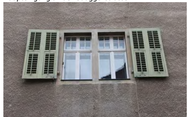
Gekuppelte Kreuzstockfenster an der Südfassade
