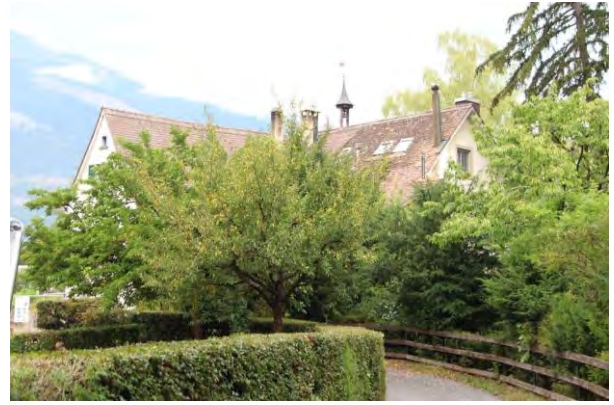
Ansicht von SO
