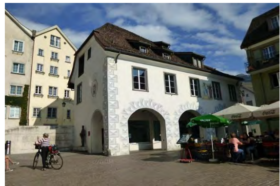
Ansicht von Westen
