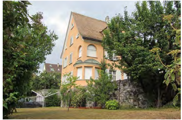
Ansicht von Loëstrasse aus, Ansicht West
