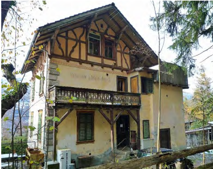
Bondastrasse 132, von Osten
