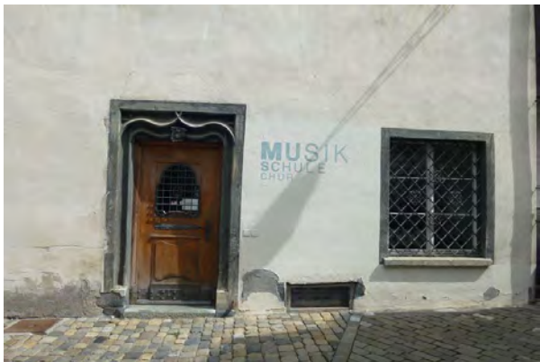
Eingangstür. Ansicht West
