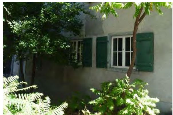
Fenster an der Südfassade
