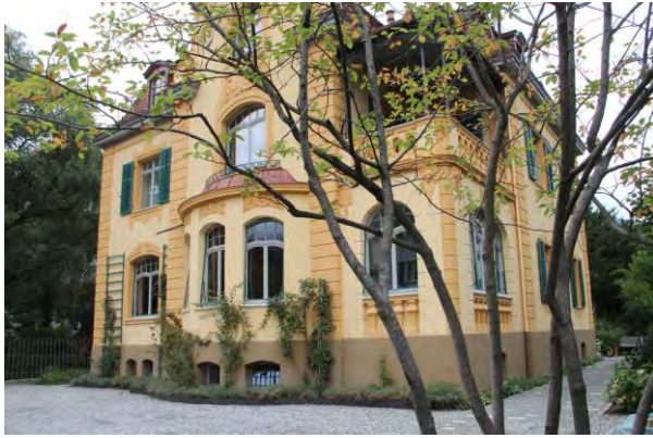
Ansicht von SO
