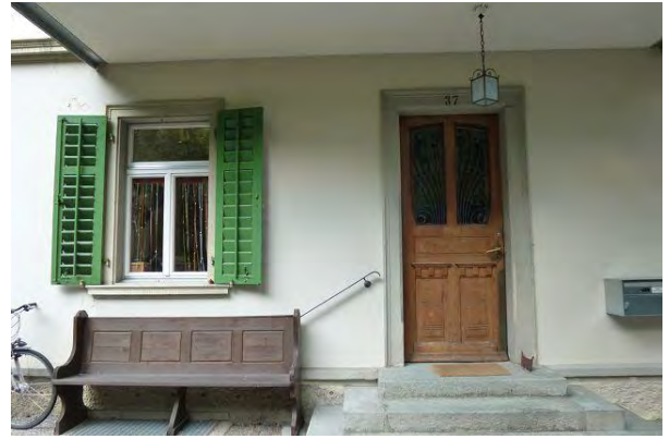
Ansicht von Osten, Eingang
