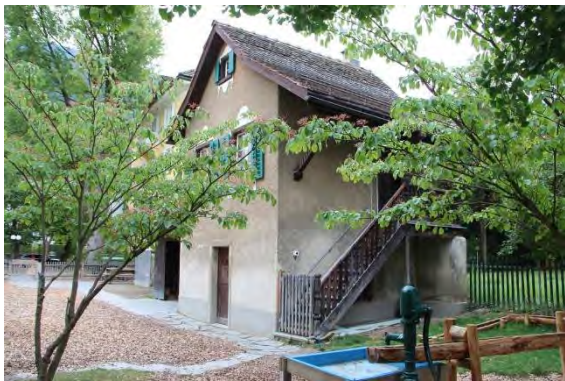
Ansicht von NW
