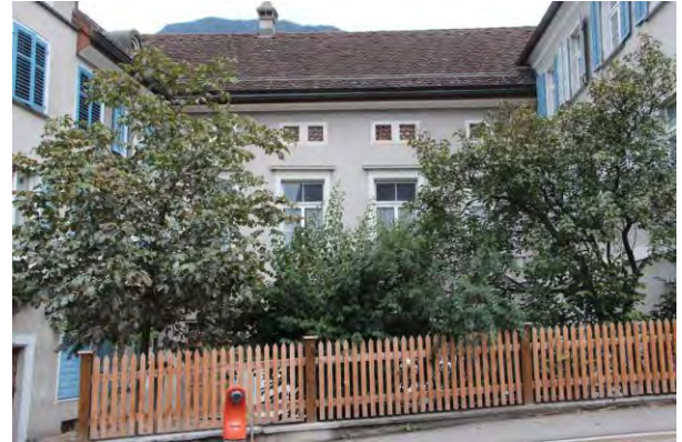
Hof zwischen dem Haus Malixerstr. 9 und dem Haus Hohenbühlweg 2
