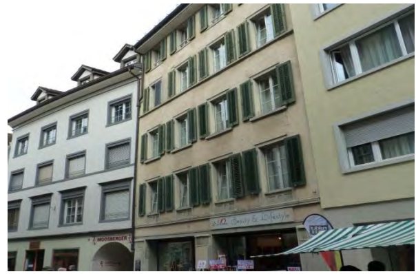
Detailaufnahme Fassadenübergänge (Süden)
