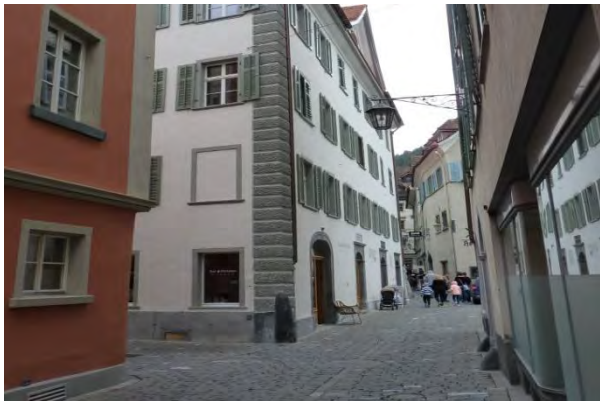
Ansicht von Norden nach Süden
