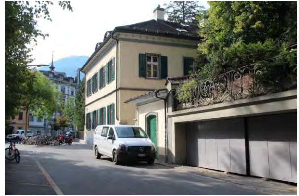
Ansicht von der Oberen Plessurstrasse (N)
