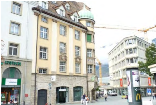
Ansicht von Osten
