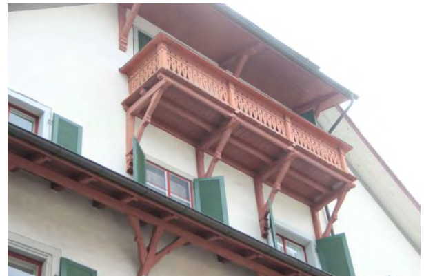
Sekundär (um 1900?) angefügte Vordächer und Balkon auf der Westseite
