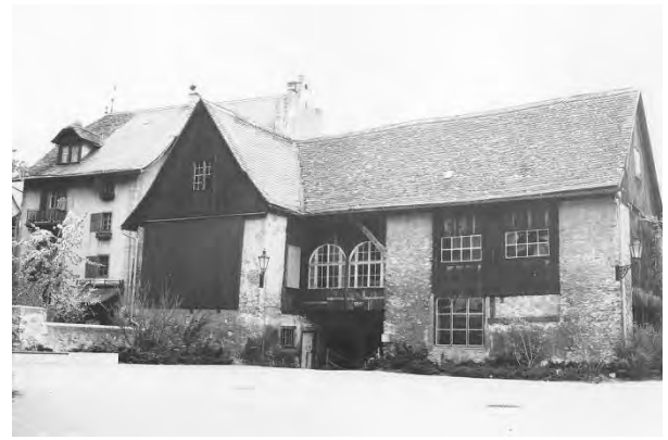
Gleiche Ansicht auf einer früheren Aufnahme (o.J.), Denkmalpflege GR
