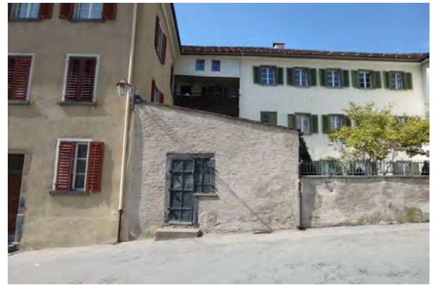
Nebengebäude, Ansicht Süd
