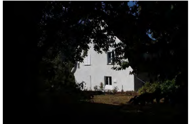
Ansicht von Osten
