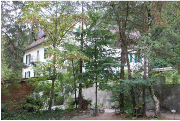
Ansicht von NW
