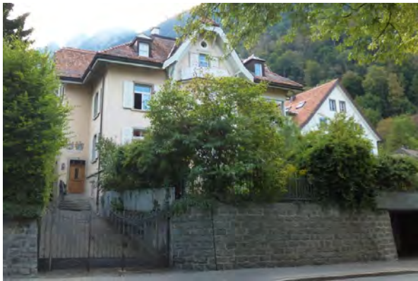
Ansicht von Loëstrasse aus, Einfriedung
