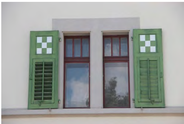
Ansicht von Westen, Fenster OG
