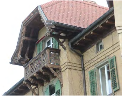
Reich profiliertes Holzwerk am Dachbalkon und an der Vordachkonstruktion des Treppenhausrisalites auf der NW-Seite
