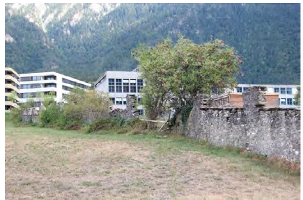
Einfriedung aus Bruchsteinmauerwerk
