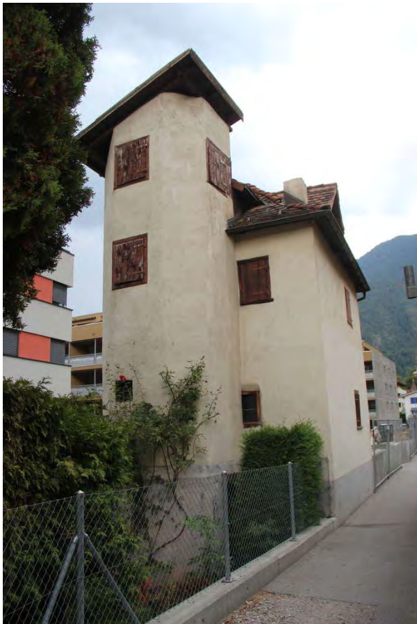
Ansicht von W
