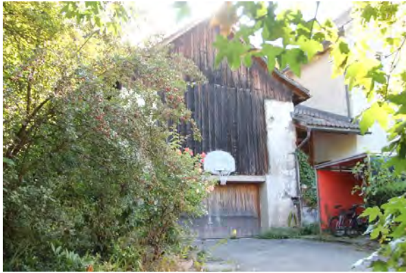
Ansicht von Westen, ehem. Stallgebäude
