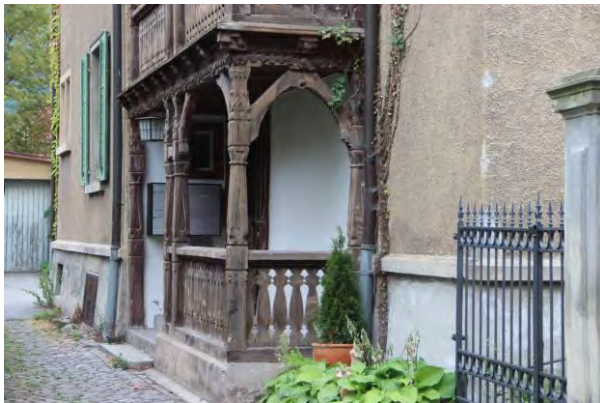
Hölzerner, beschnittener Eingangsportikus auf der NW-Seite
