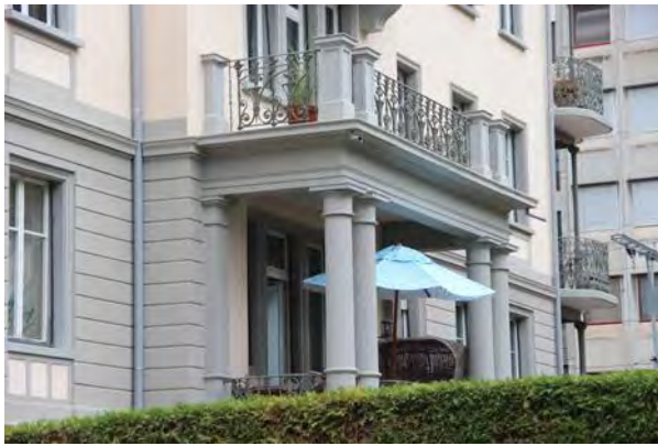
Oben Altane und Balkon auf der Südseite
