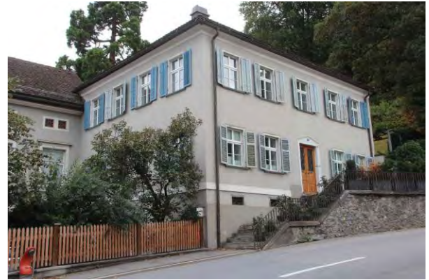
Ansicht von NW
