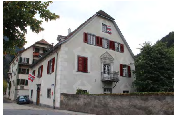
Ansicht von NW
