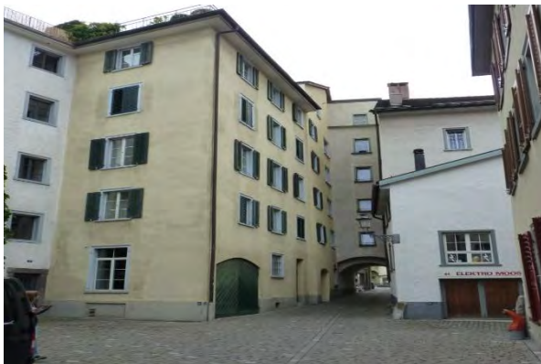
Ansicht von Norden, Paradiesplatz
