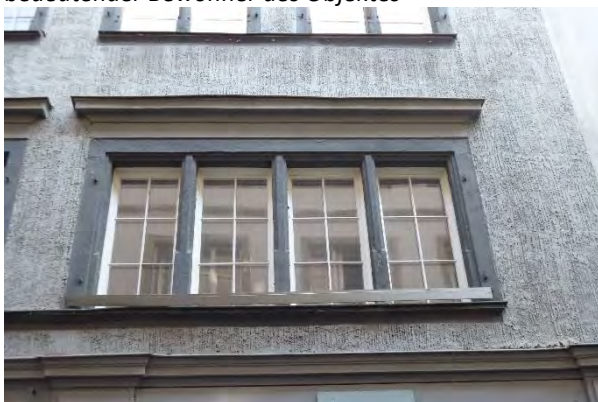
Detailaufnahme Fenster (Südfassade)
