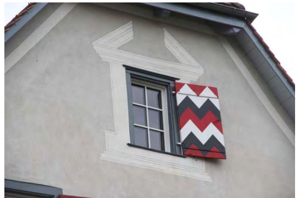
Fenster am westl. Giebfeld mit Sgraffitoumrahmung (gesprengter Giebel)
