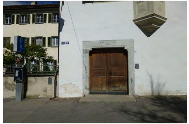
Eingangstür, Ansicht Süd
