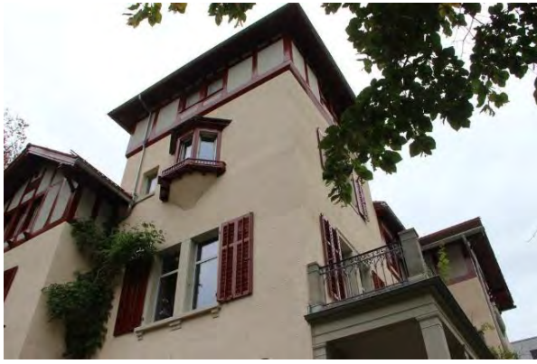
Eckturm an der Südostecke
