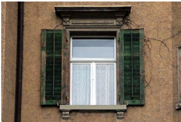
Kreuzstockfenster mit klassizistischen Gewänden und gerader Verdachung, Steinsims auf Konsolen
