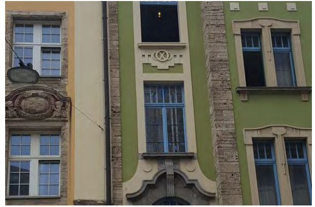
Detailaufnahme Fenster (Norden)
