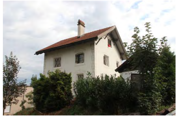
Wohnhaus von SW gesehen
