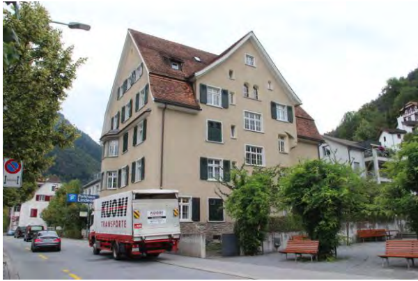
Ansicht von NW
