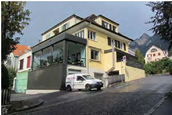
Ansicht von Sonnenbergstrasse aus, Ansicht Süd-West
