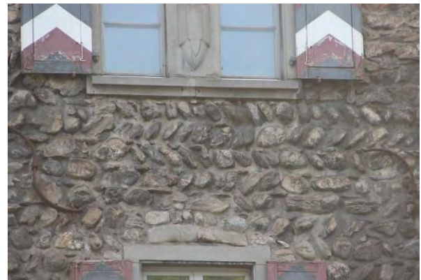
Ansichten von der Grabenstrasse her und Details des Mauerwerks, hinzuweisen ist auf die Partien mit den ährenförmig angeordneten Steinen, dem sog. Opus spicatum, einer bereits in der Antike gebräuchlicher, im Mittelalter oft eingesetzten Mauertechnik
