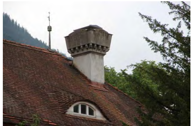
Markantes Kamin und Fledermausgaube auf dem mit Biberschwanzziegeln gedecktem Dach
