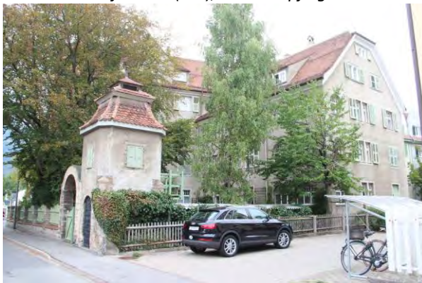
Ansicht von SW mit Trafohäuschen in der Manier eines ortstypischen Gartenhäuschens
