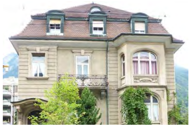
Ansicht Fassade zur Strassenseite (Westen)
