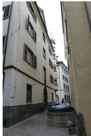
Blick von Osten auf die nördliche Fassade
