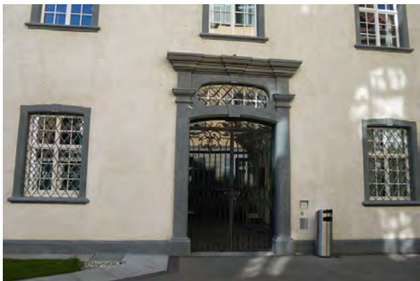
Eingangstür. Ansicht Ost
