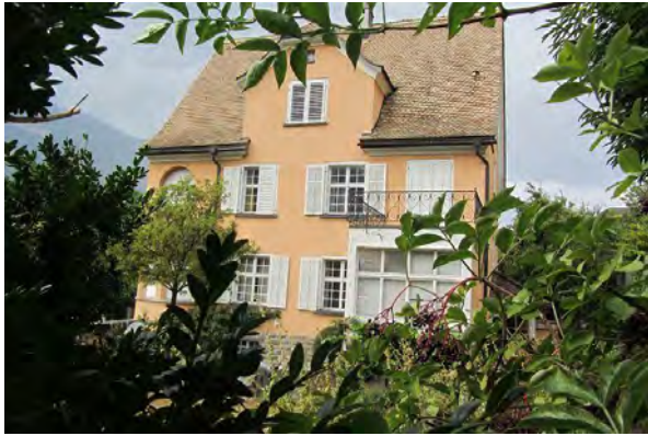
Ansicht von Rebhaldenweg aus, Ansicht Süd
