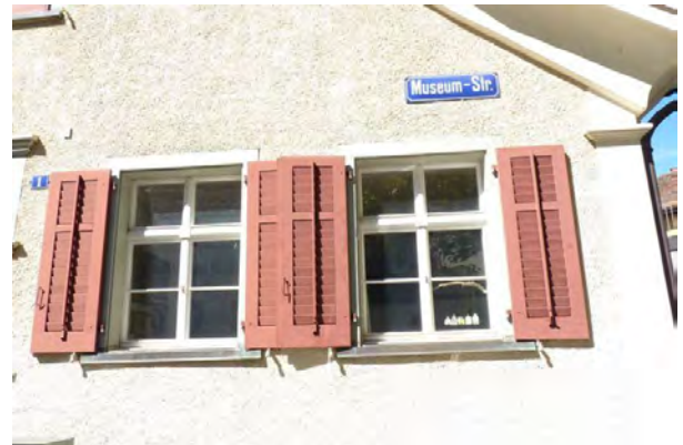
Detailaufnahme Fenster (Süden)
