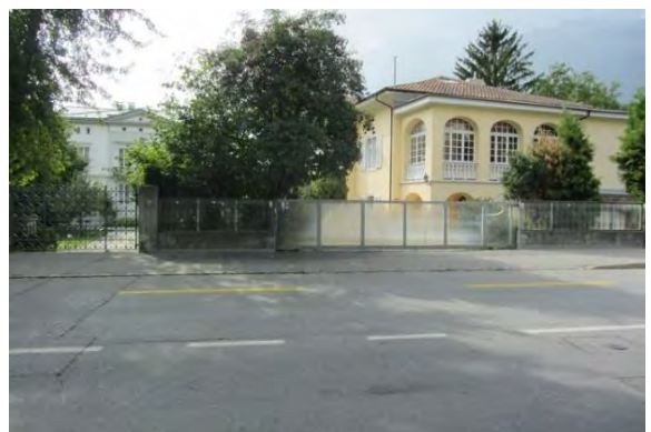
Wohnhaus, Ansicht von Osten
