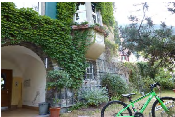
Sockelmauer fortgesetzt als innere Gartenmauer
