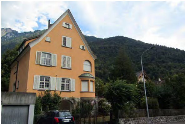
Ansicht von Loëstrasse aus, Ansicht West
