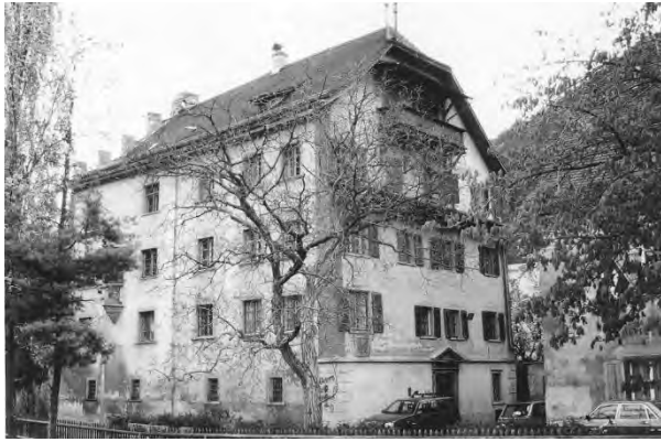
Ansicht von NW, historische Aufnahme (o.J.), Denkmalpflege GR
