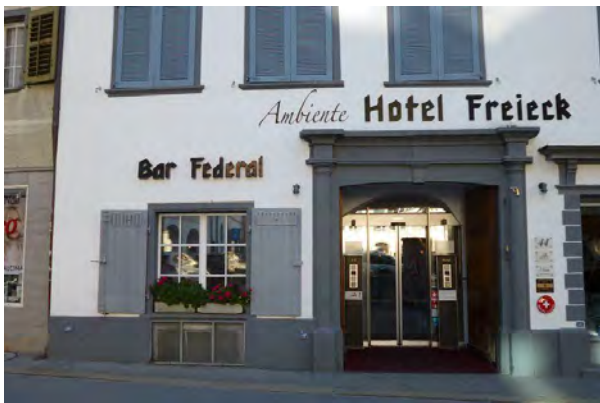
säulengerahmtem Eingang, Ansicht Ost
