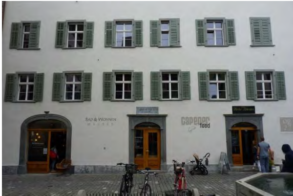
Ansicht von Westen
