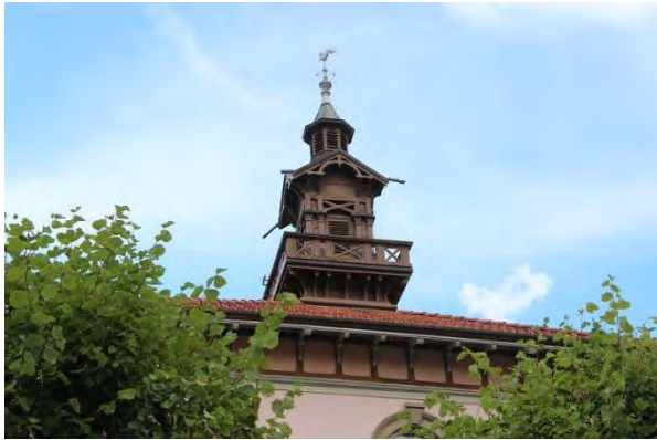
Ansicht von Westen, Dachreiter
