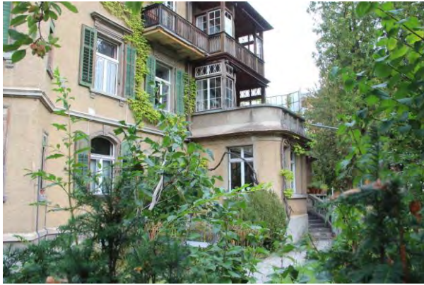
Fassade SO mit Terrassenvorbau und
