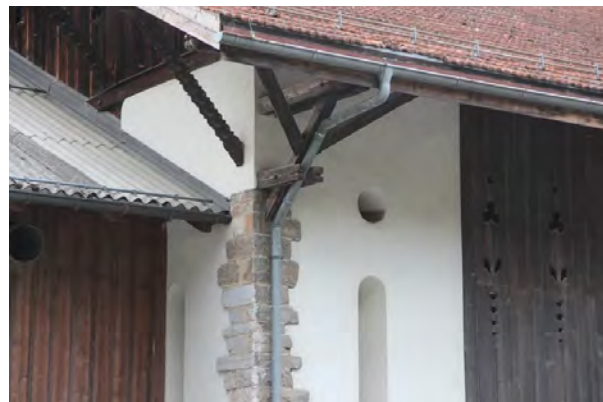
Ansicht von Süden, Eckpfeiler
