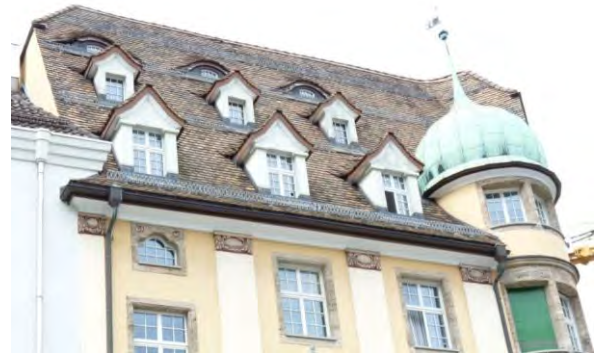
Blick auf die östliche Dachseite
