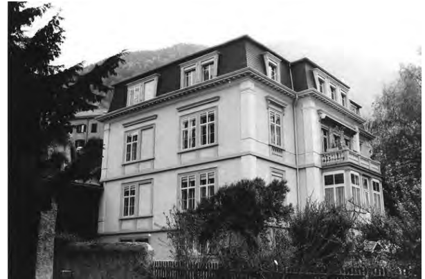
Gleiche Ansicht vor der Renovation
