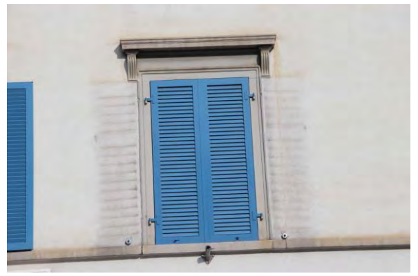
Fenster des 1. Obergeschosses
