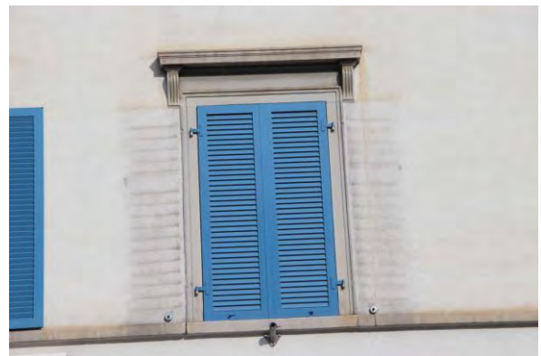
Fenster des 1. Obergeschosses
