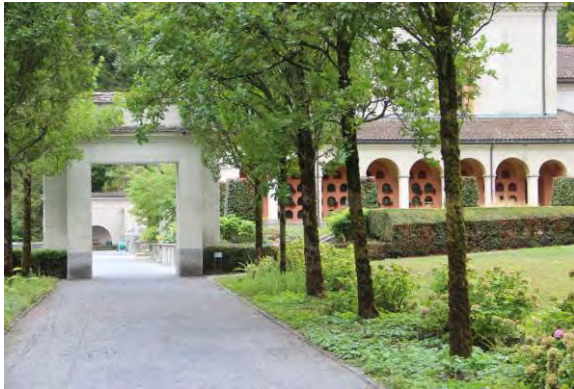
Eingangsportal zur Anlage im NW
