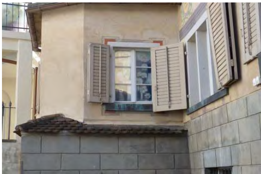
Übergang Hauptfassade zum angegliederten Pavillon (Ostseite)
