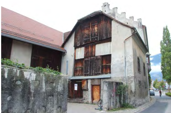
Ansicht von Osten mit dem Ökonomieteil im Vordergrund
