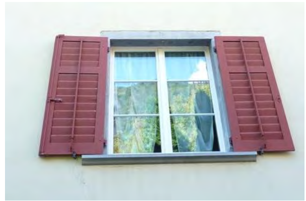
Detailaufnahme Fenster (Ostfassade)
