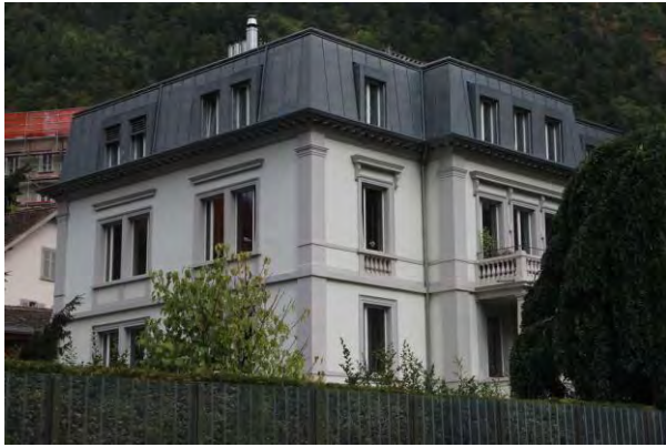
Ansicht von W
