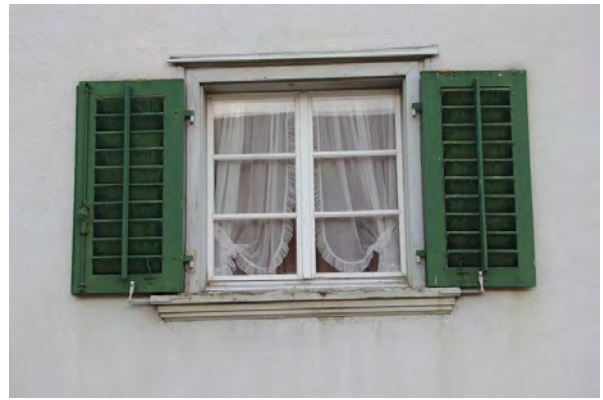
Ansicht von Norden, Fenster EG
