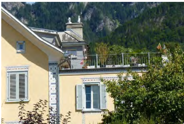
Übergang Wohntrakt zum ehem. Werkstatttrakt
