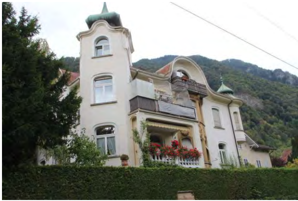
Ansicht von W
