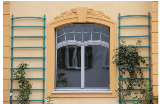
EG-Fenster an der Südfassade, die Fensterteilung in der Manier des Jugendstils ist neueren Datums
