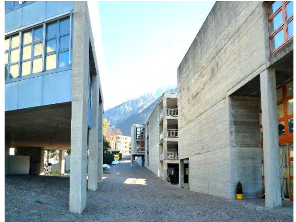
Eingänge Schultrakt und Mensa, von Westen.
