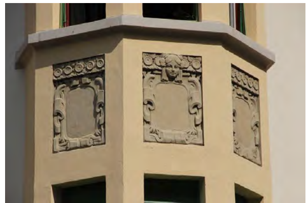
Ansicht von Süden, Erker
