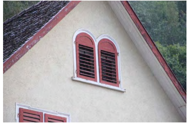
Gekuppelte Bogenfenster im Giebfeld
