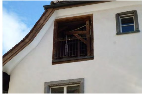
Ansicht von Norden, Luke mit Holzaufzug
