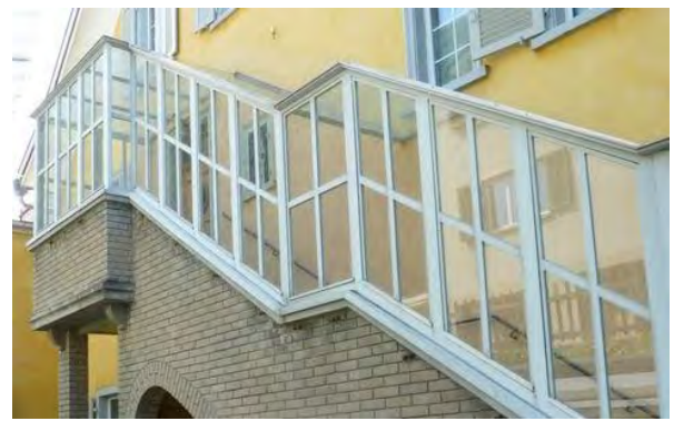
Gedeckter Treppenaufgang an der Ostfassade
