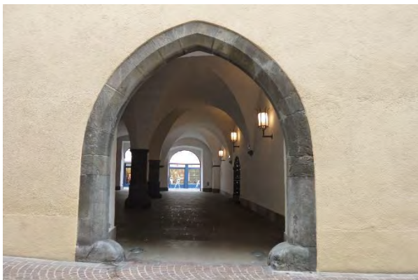
Torbogen zur Poststrasse hin (Westen)
