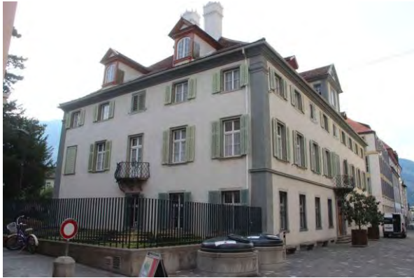
Ansicht von der Poststrasse, von Südosten
