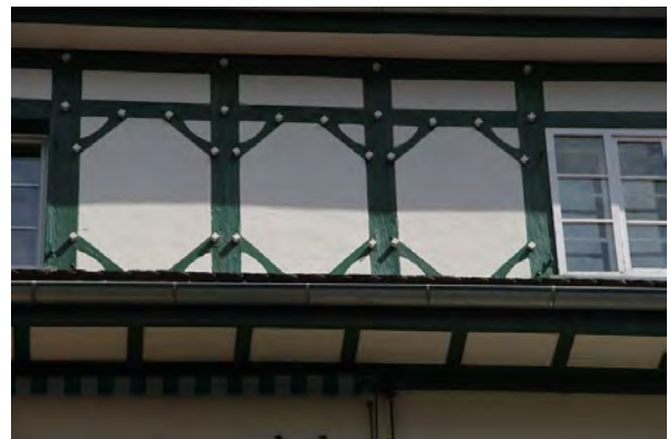
Ansicht von Süden, Dachgeschoss Fachwerk
