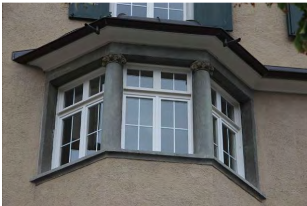
Erker auf der Nordseite
