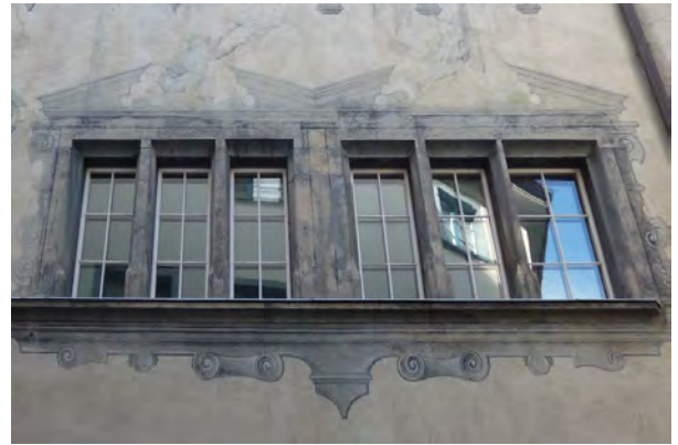
Fenster, erstes Obergeschoss
