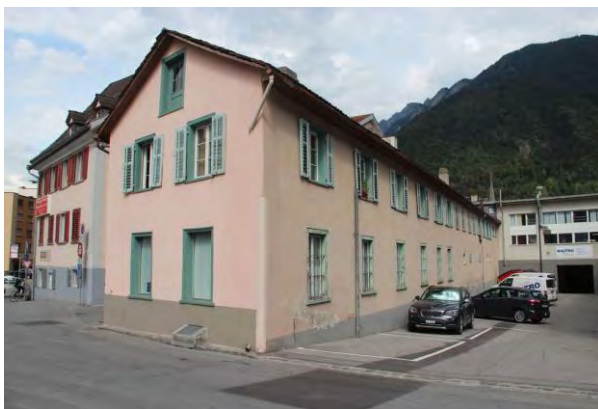
Ansicht von SW
