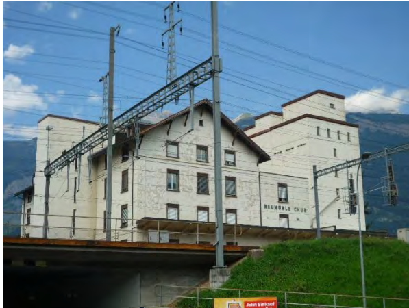
Gürtelstrasse 89, von Osten (Gleisanschluss)
