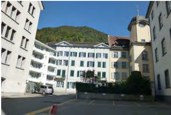
Karlihof, Ansicht West
