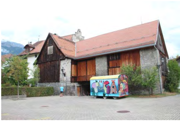
Ansicht des Ökonomieteils
