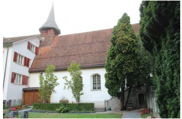
Ansicht von Westen
