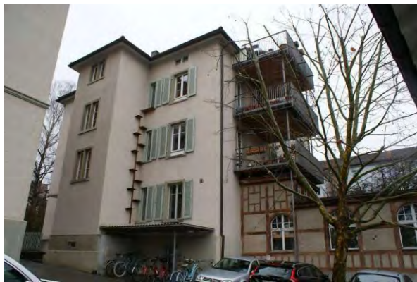
Nordwestansicht (Nr. 35 und Zwischenbau)
