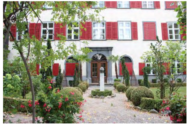
Westfassade des Hauptgebäudes
