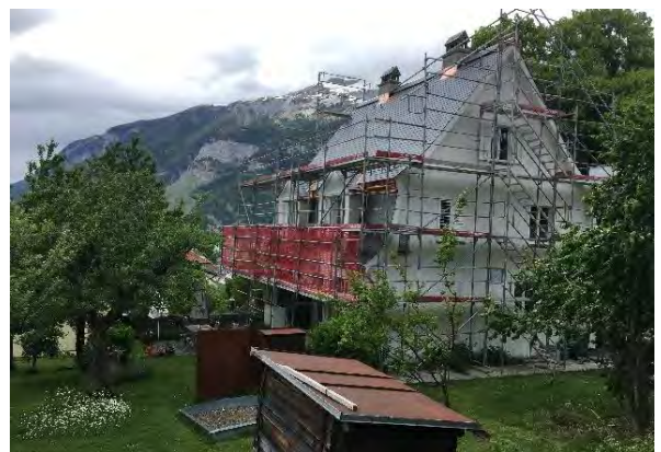
Ansicht von Osten
