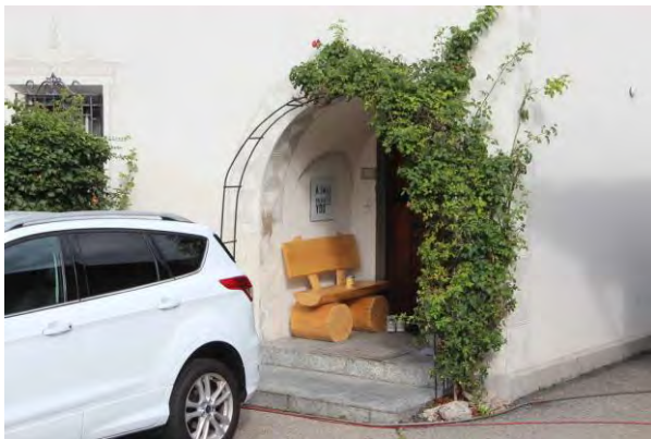
Eingezogener und überwölbter Hauseingang
