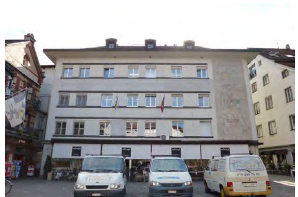
Ansicht von Westen
