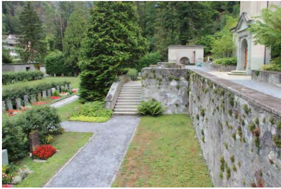
Terrassenmauer gegen das Gräberfeld
