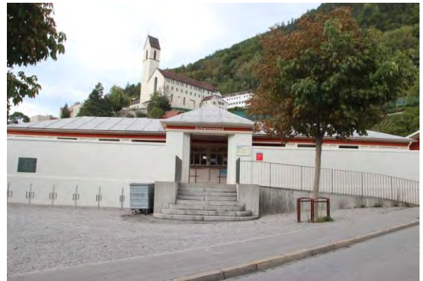
Eingang mit Freitreppe (2009) auf der Südwestseite
