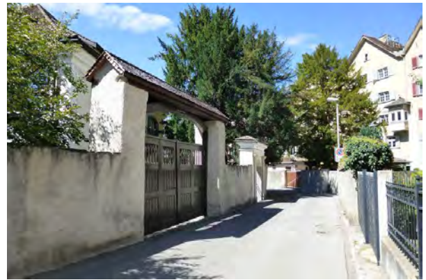
Blick Richtung Westen von der Jochstraße aus, Einfahrtstore im Norden
