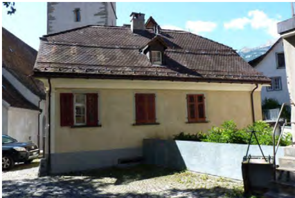
Ansicht von Osten
