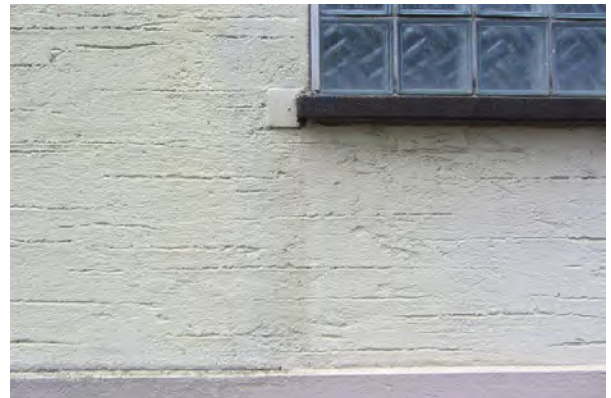
Ansicht von Norden, Putzstruktur
