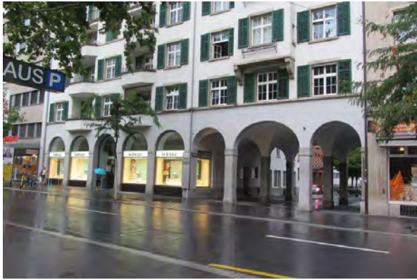
Ansicht von Süden, Durchfahrt und Schaufenster
