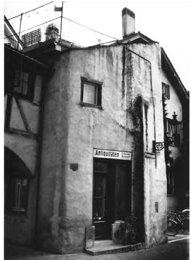
Historische Aufnahme von NW (o.J.), Denkmalpflege GR
