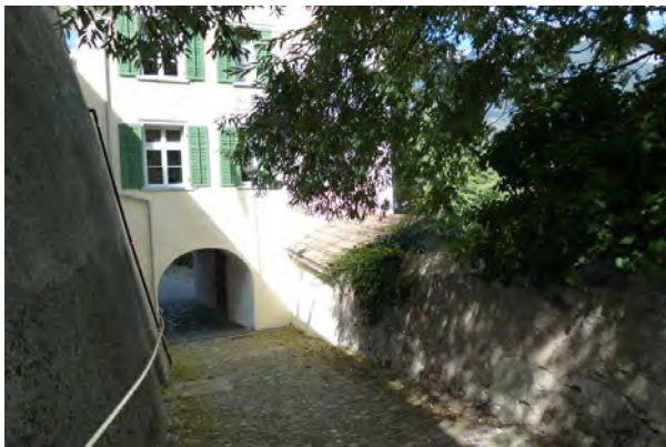
Ansicht von Westen, Durchfahrt
