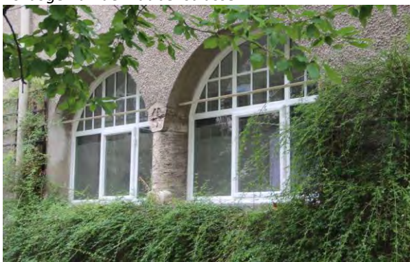
Bogenfenster an der Westfassade
