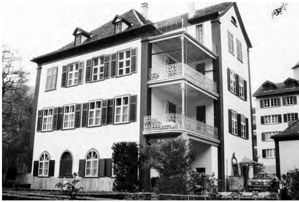
Historische Aufnahme (o.J.), Denkmalpflege GR: Ansicht von SO auf die Südfassade, den Treppenhausrisalit auf der Ostseite und den sek. Verandaanbau von 1899
