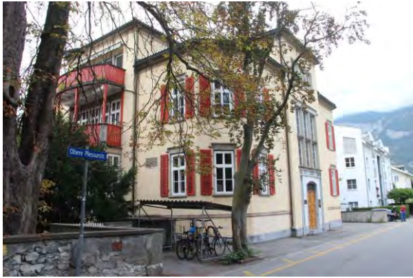
Ansicht von Osten
