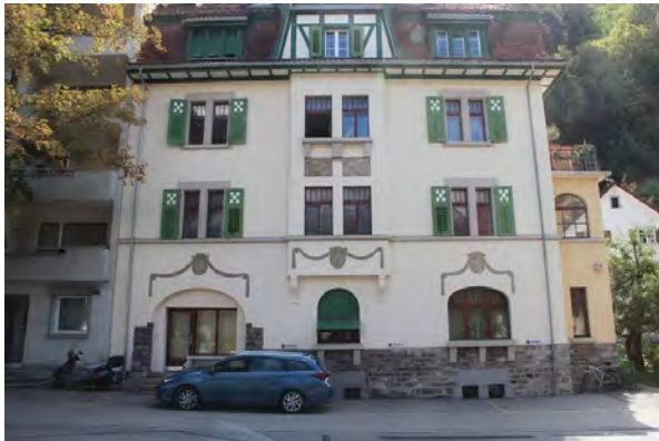
Ansicht von Westen
