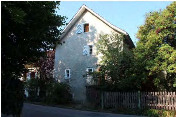
Ansicht von Osten, Wohnhaus
