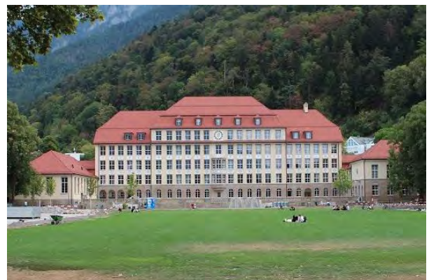
Ansicht von Westen mit Quaderwiese
