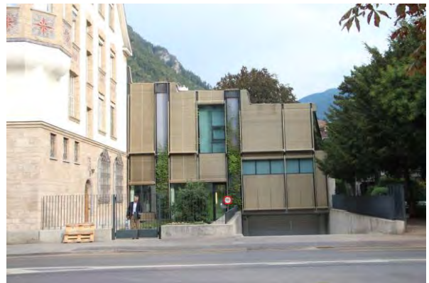
Dito, mit Erweiterungsbau 2003
