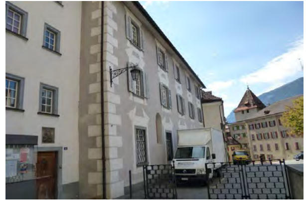
Ladeneingang mit Schaufenstern, Ansicht Ost
