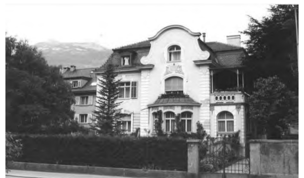
Historische Aufnahme (o.J.), Denkmalpflege GR
