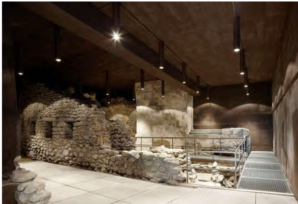
Ansicht der unterirdischen Anlage von NW
