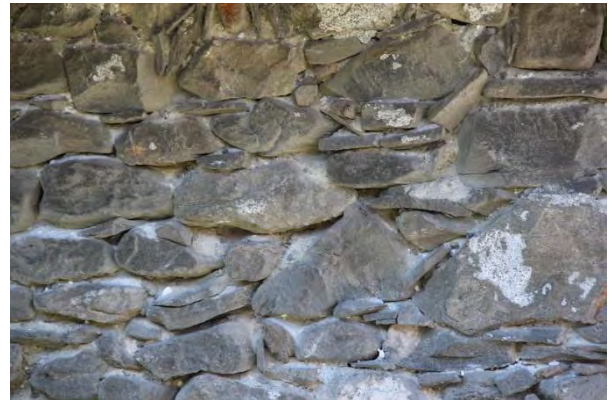
Lesesteine Mauerwerk (Ostfassade)
