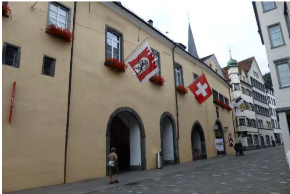
Ansicht von Westen
