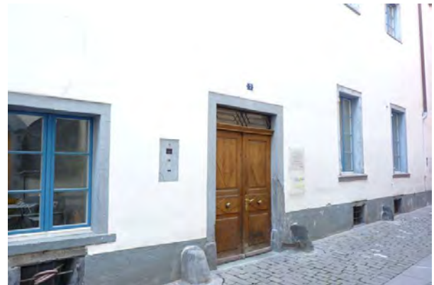
Zugangsbereich von der Rabengasse
