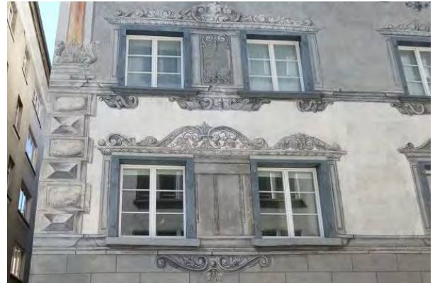
Ansicht Ost, Fassadenbemalung
