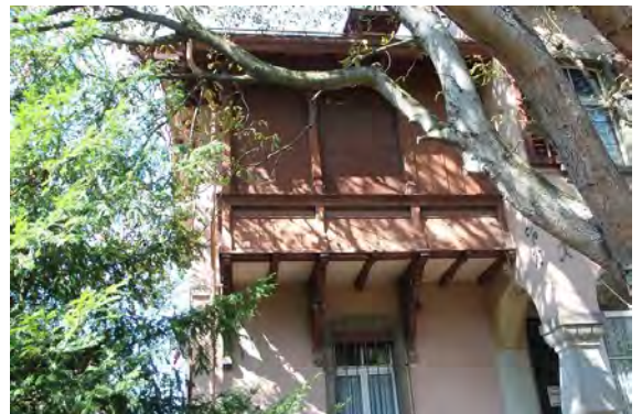
Ansicht von Osten
