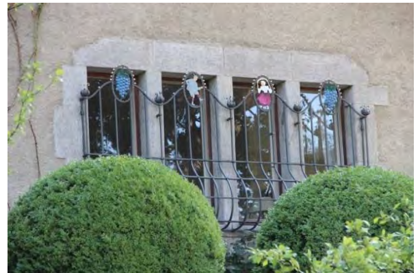
Fenster mit schmiedeeisernen Gitter, Westfassade
