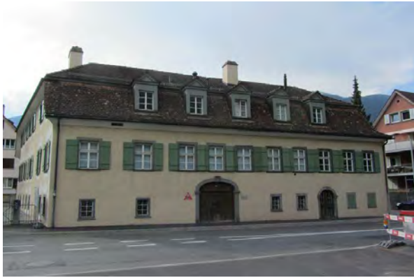
Ansicht von Osten, von Masanserstrasse aus
