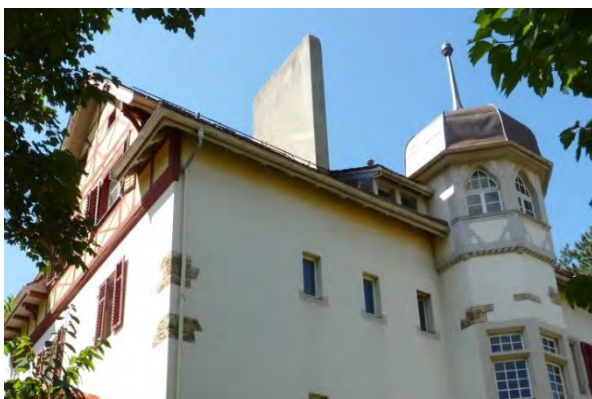
Blick auf die nördliche Dachseite mit Reihenkamin
