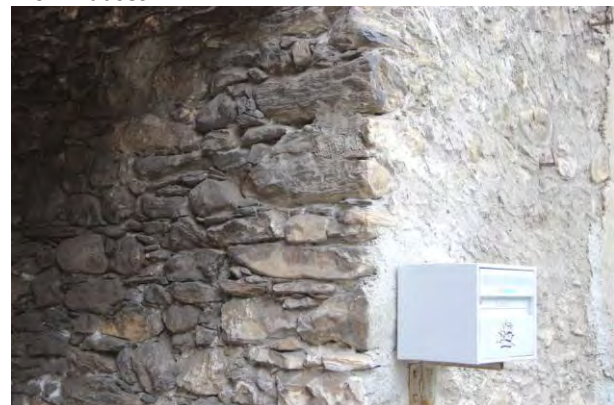
Natursteinmauerwerk des Ökonomieteils
