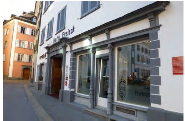
Ladeneingang mit Schaufenstern, Ansicht Ost
