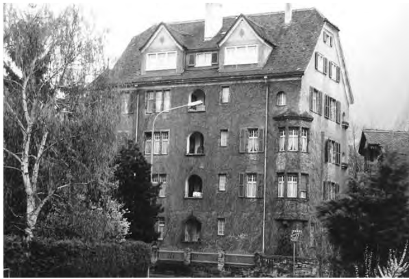
Historische Aufnahme (o.J.), Denkmalpflege GR
