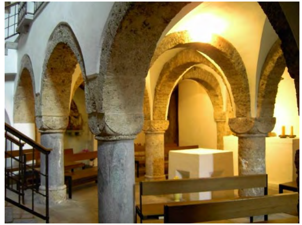
Krypta (Foto baukultur.gr.ch)
