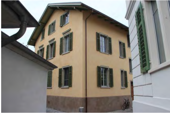
Ansicht von Osten
