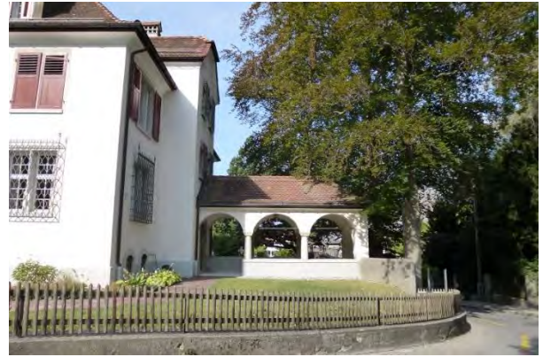
Ansicht von Osten
