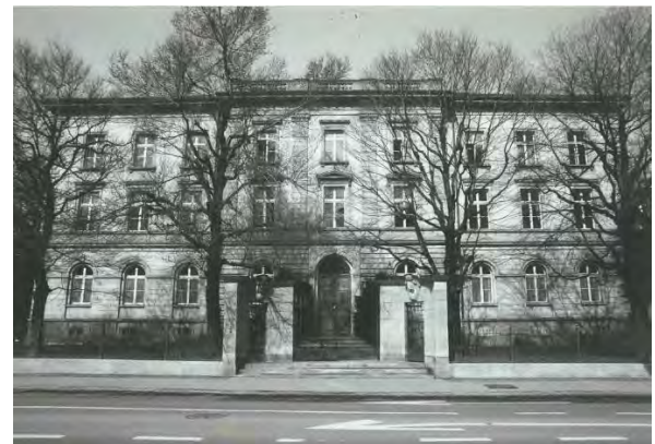
Hauptfassade, Foto Denkmalpflege, o. J.
