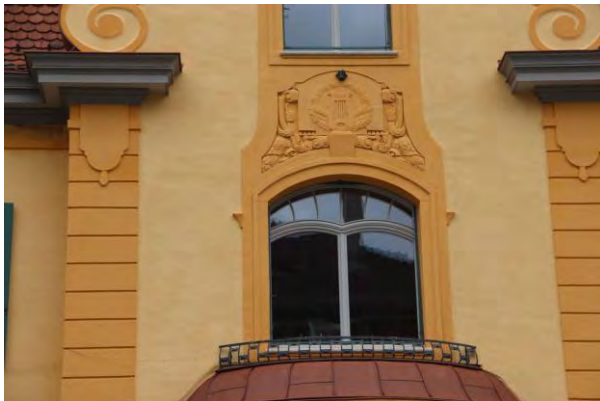
Fenster über dem Ständerker an der Südfassade
