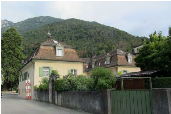
Ansicht von Westen, von Salisstrasse aus
