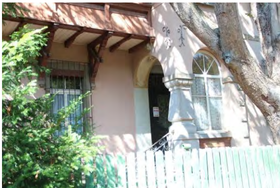
Ansicht von Osten
