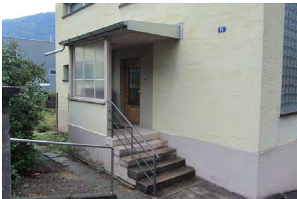
Ansicht von Osten, Eingang
