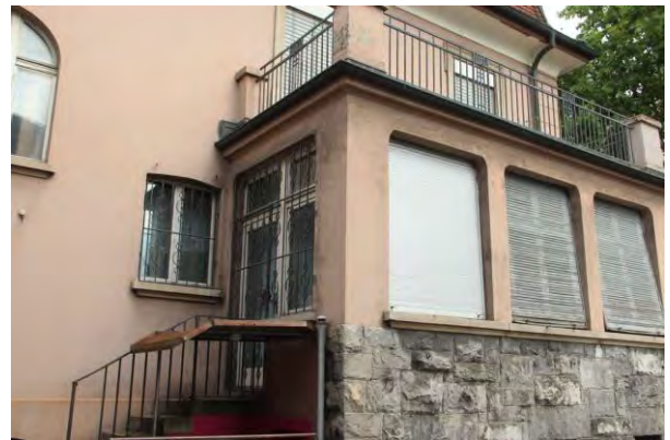
Westfassade, Veranda mit Zinne
