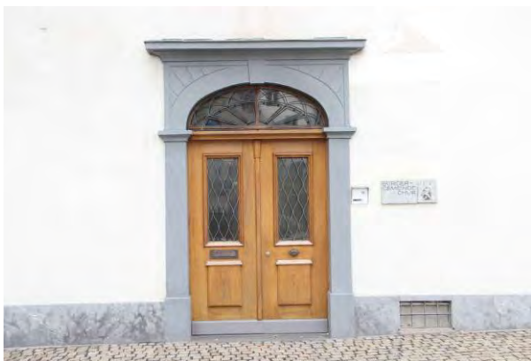
Eingangstüre an der N-Fassade mit Jugendstilornamenten (1909?)
