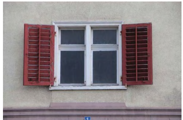
Kreuzstockfenster (urspr. mit Sprossenteilung)
