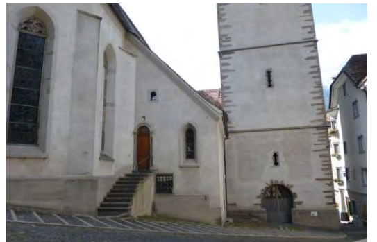
Ansicht von Osten
