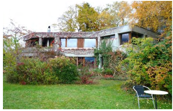
Einfamilienhaus Prasserieweg 5, Ansicht von Süden.
