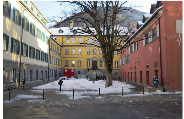
Ansicht von Nikolaistrasse aus, Ansicht Nord-West
