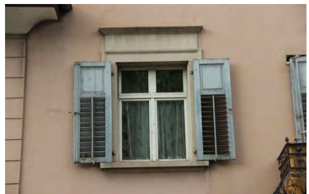
Fenster im Obergeschoss
