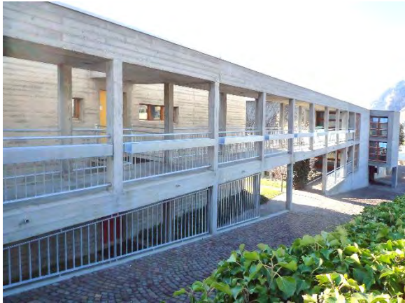
Wohnheim und Personalwohnungen, von Osten.
