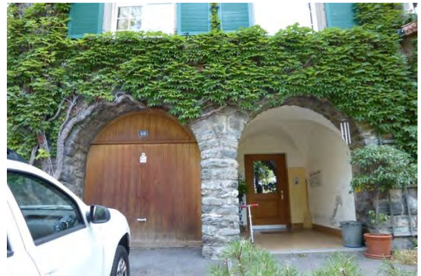
Eingang und Garageneinfahrt, Westfassade
