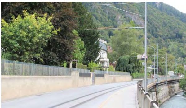
Lage über Plessur und Plessurquai
