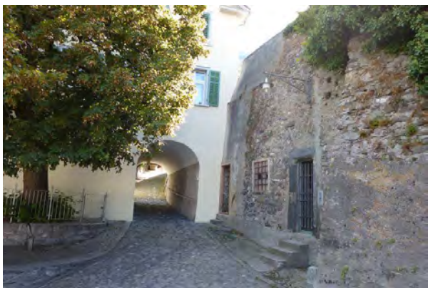
Ansicht von Osten, Durchfahrt
