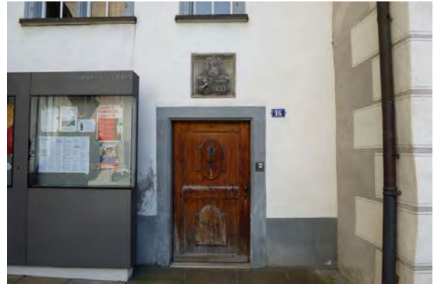
Eingangstür, Ansicht Nord
