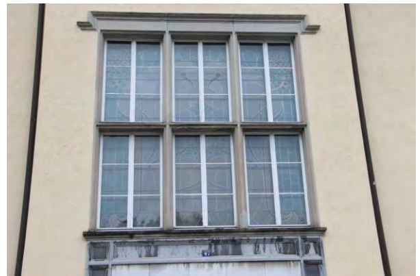
Jugendstilfenster (um 1900) des Treppenhauses
