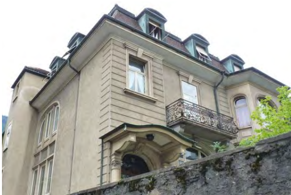
Detailansicht der Fassadengestaltung (Süden)
