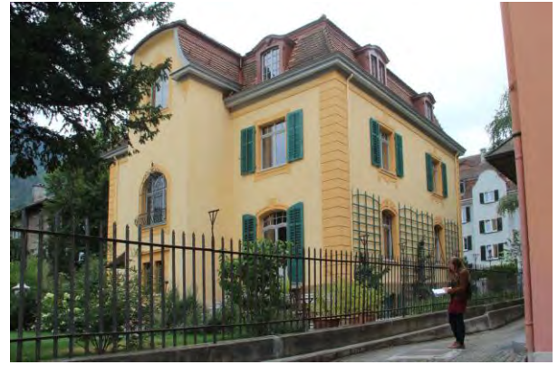
Ansicht von NW
