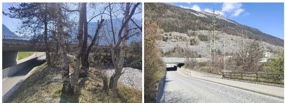
Fotos: Autobahnunterführung Untere Plessurstrasse / Autobahnunterführung Felsenaustrasse
