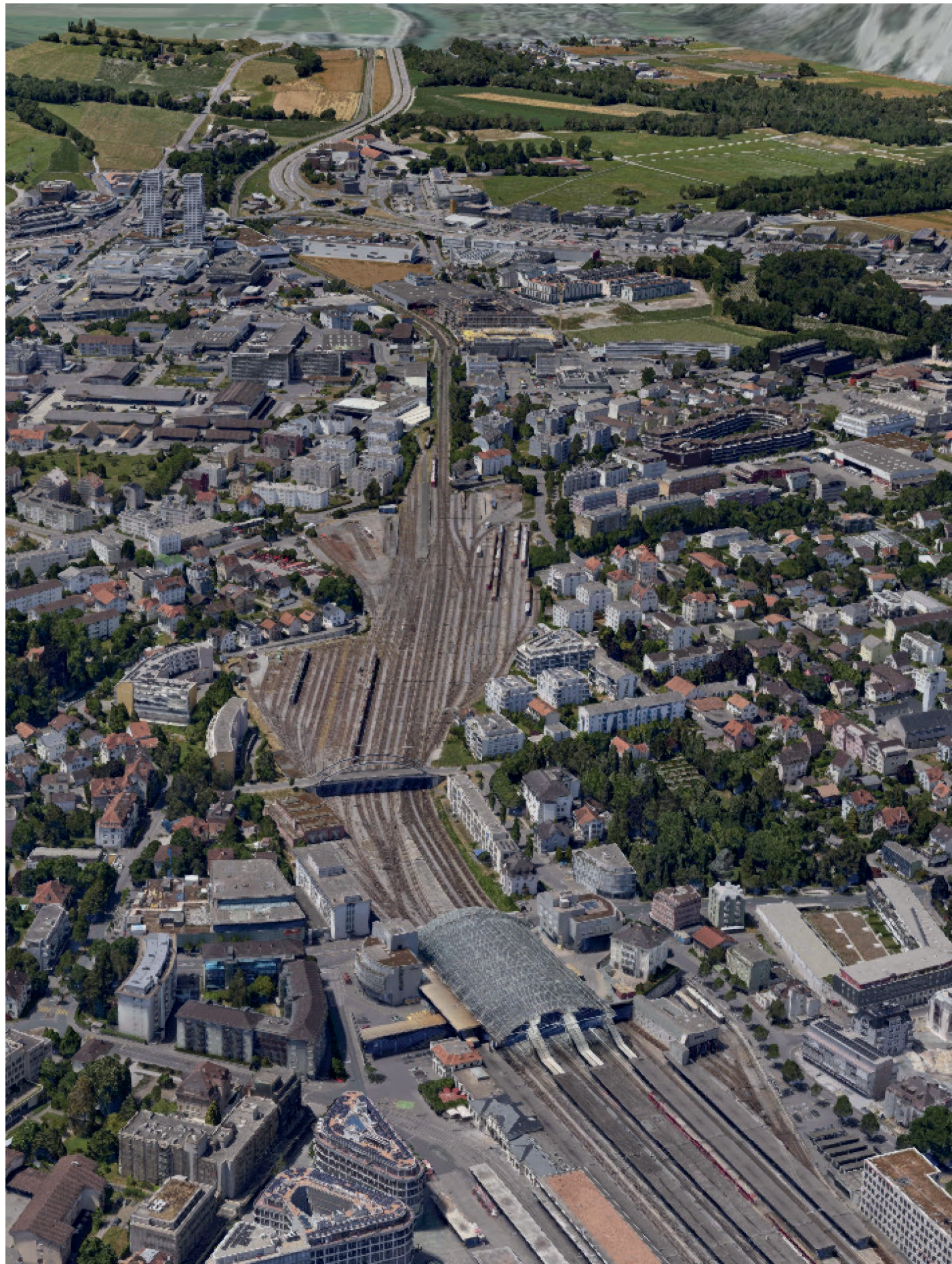
Aufstockung Lokremise Chur
