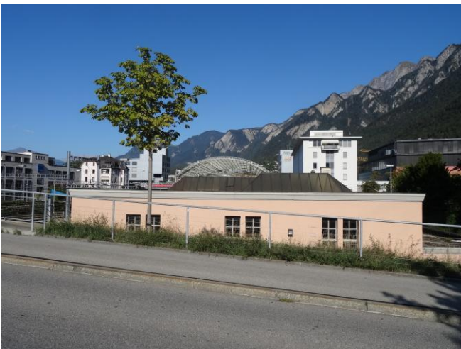
Bestehender Hallenbau von Friedaubrücke her, Bild R+K
