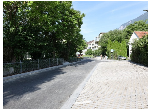
Fertiggestellte Oberalpstrasse mit Parkplatz aus Rasengittersteinen
