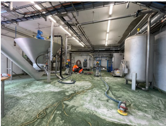
Vorbehandlung/Schleifarbeiten des gesamten Bodens im Rechengebäude für die neue Beschichtung
