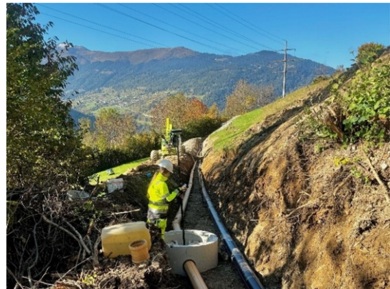
Schwiirainweg Maladers, Aufnahme Wasser-/Abwasserleitung
