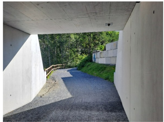
Tunnelausgang mit angrenzendem Absperrzaun
