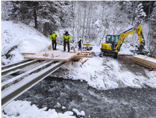
Sanierung Brücke Füxliweg, Tschierschen
