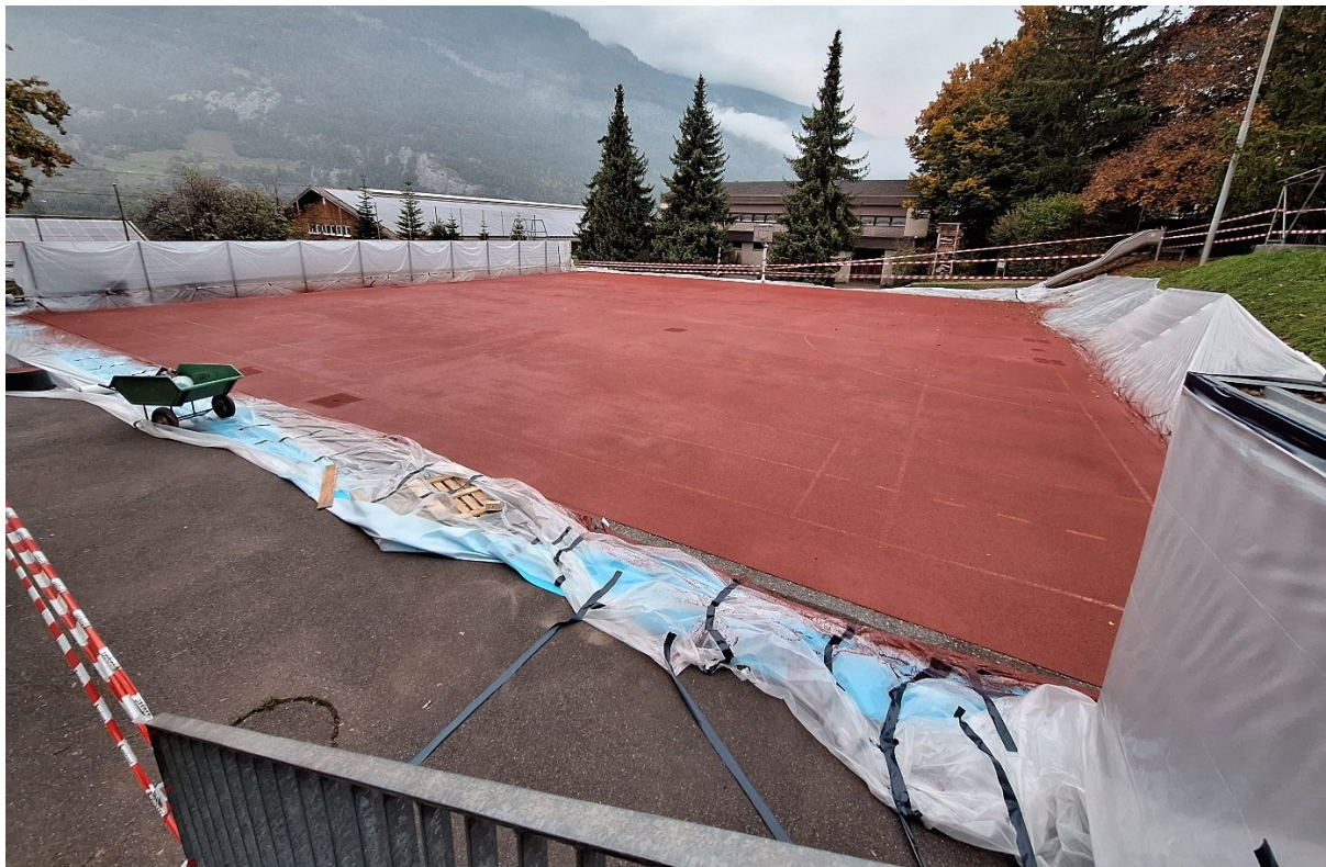
Allwetterplatz im Schulhaus Masans während Sanierungsarbeiten
