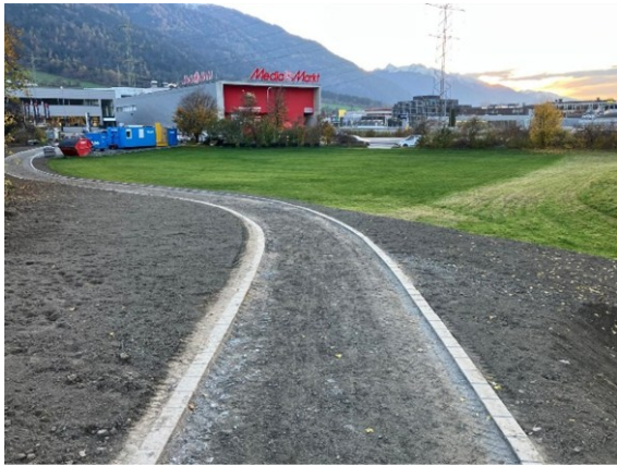
Einstieg Fuss- und Velo Verkehrsweg beim Media-Markt
