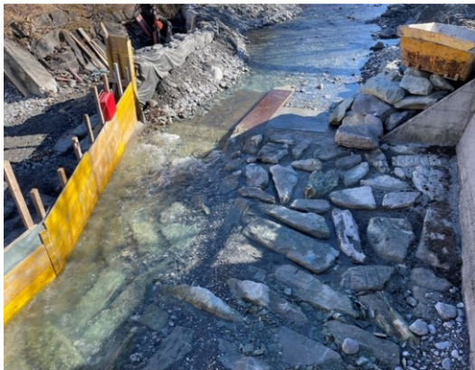
Ples-sur, Anschluss BAFU Messschwelle
