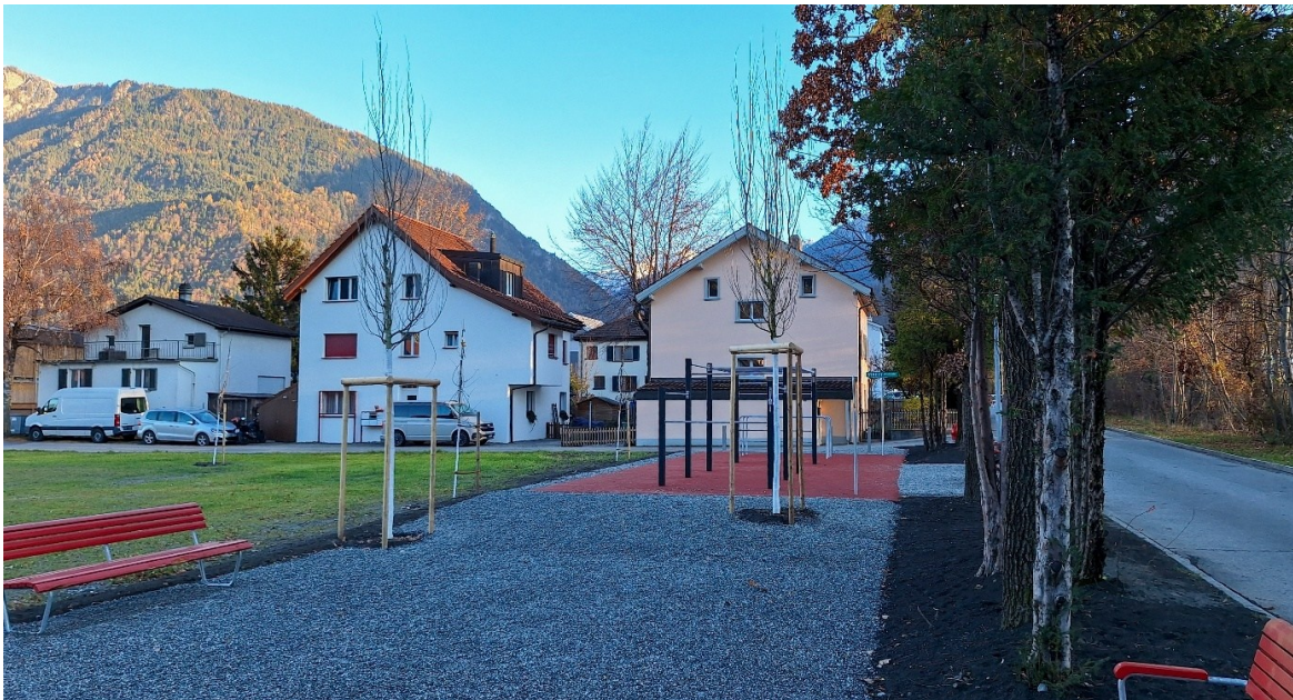
Platz mit Streetworkoutanlage nach Fertigstellung im November
