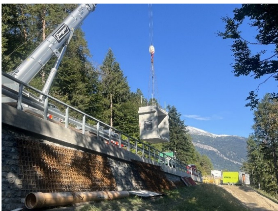
Einbau Unterführung mit Fertigelementen
