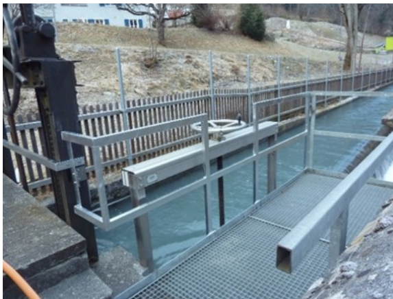
Mühlbach Sandstrasse Trennbauwerk
