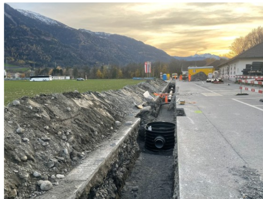
Kanalisationsarbeiten Erschliessung Schützenhaus
