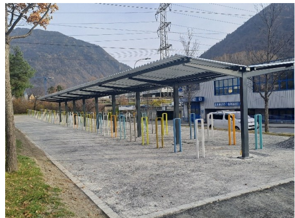
Fertiggestellte Veloparkierung Föhrenwäldli
