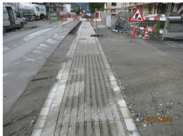
Überfahrelement Rasenliner Cadonaustrasse
