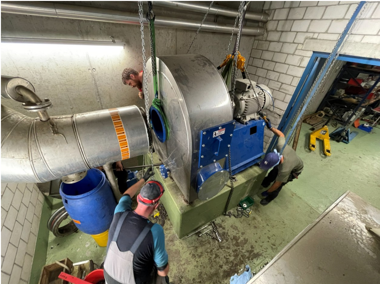
Montage des neuen Kreislaufgas-Ventilators VM1030
