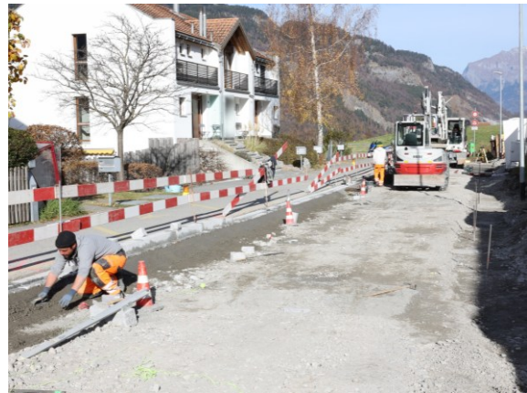
Einbau Tragschicht Cadonastrasse
