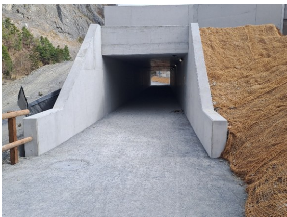
Eingangsportal Tunnel Rheinpromenade
