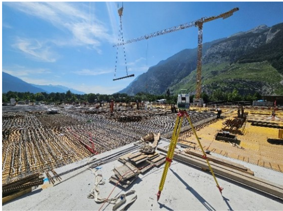
Messe- und Eventhalle, Bauvermessung
