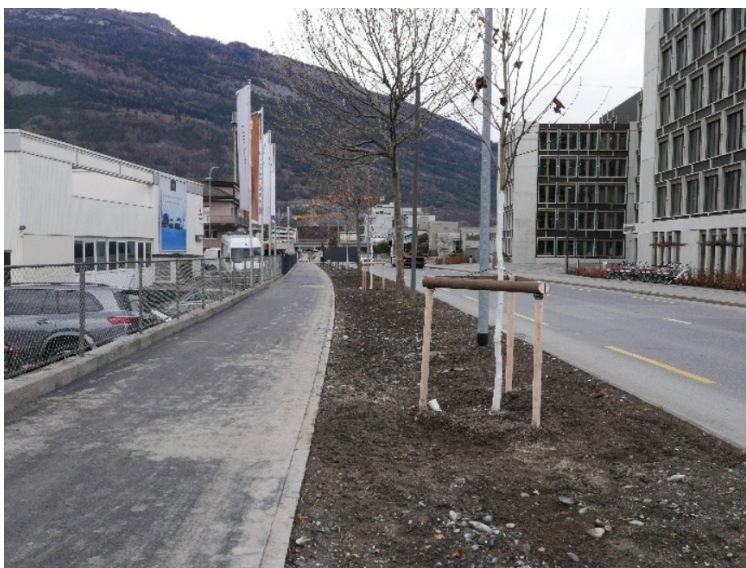
Ringstrasse, Versickerungsmulde mit Ersatzpflanzung
