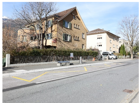
Fertiggestellte Bushaltestelle Sonnenbergstrasse
