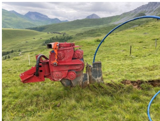
Bodenschonende Verlegung der Wasserleitungen mittels einem Kabelpflug, Alp Tschuggen
