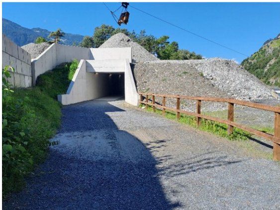
Tunnel mit Blick auf Materialeiseilbahn der Calanda Gruppe AG
