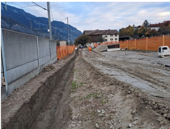
Baustelle LV-Verbindung Stampaweg
