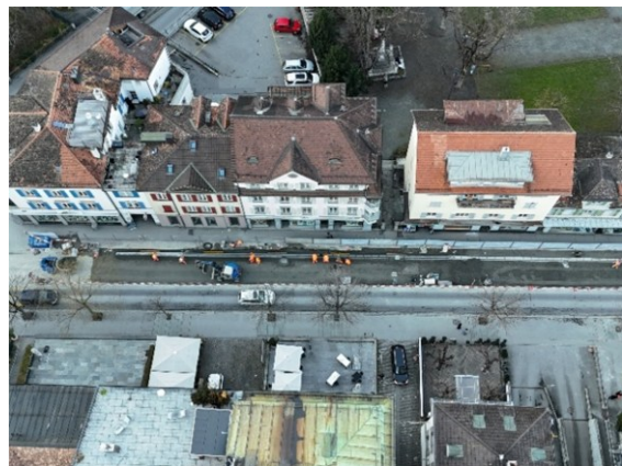
Drohnenaufnahme Randabschlüsse Grabenstrasse
