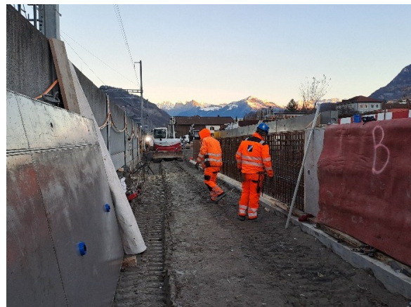
Erstellung Stützbauwerk LV-Verbindung Stampaweg
