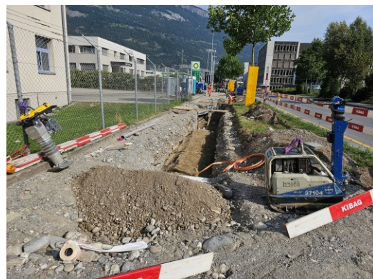
Baulicher Unterhalt Trottoir Ringstrasse
