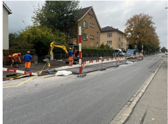
Baustelle Bushaltestelle Sonnenbergstrasse
