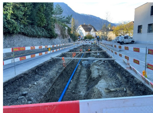
Grabarbeiten Wasserleitung Kreuzgasse
