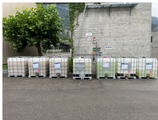
Eine von vielen Anlieferungen: IBC-Container mit Fällmittel während der Reparatur des Stapeltanks
