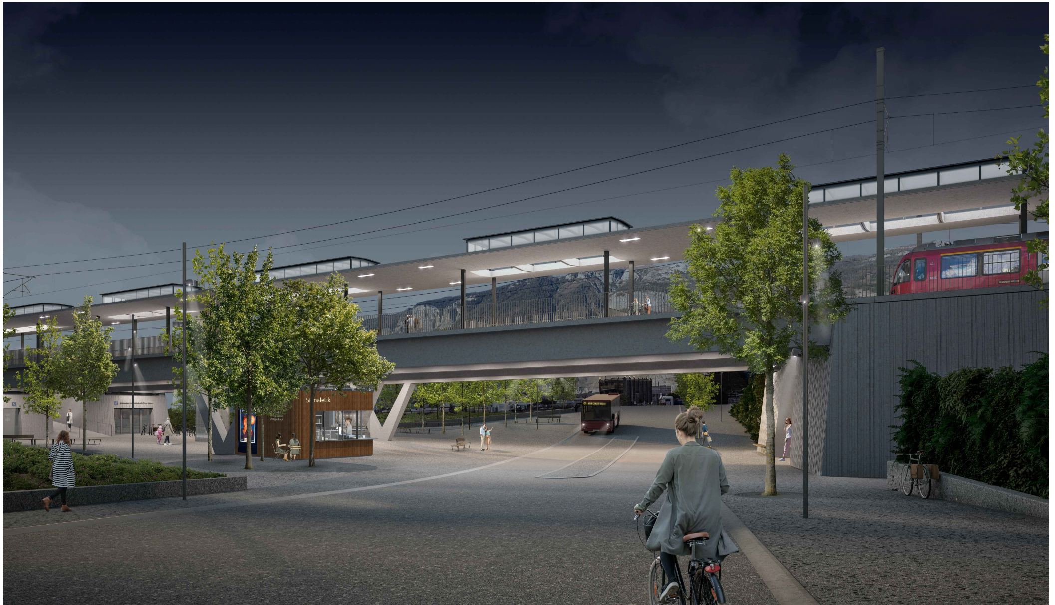
Neue Brücke über den Bahnhofplatz
