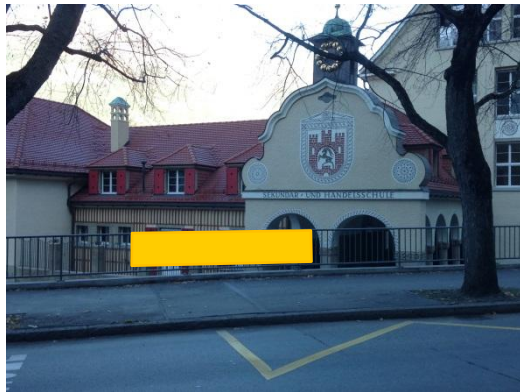
15 Loestrasse, Geländer Schulhaus Quader
