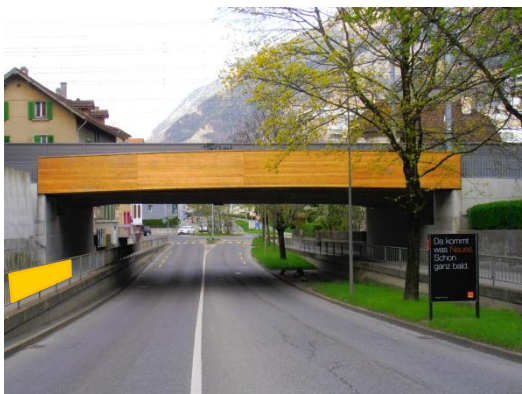
13 Ringstrasse, Geländer vor Unterführung links
