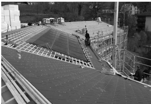
Montage von Sonnenkollektoren auf dem Dach des Bürgerheims Chur.
