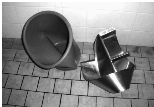
Mutwillige Zerstörungen in öffentlichen WC-Anlagen.
