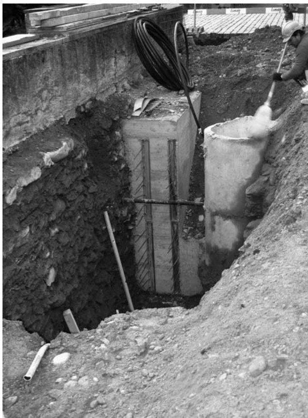
Etappenweise Hinterbetonierung und Sicherung der Stützmauer.
