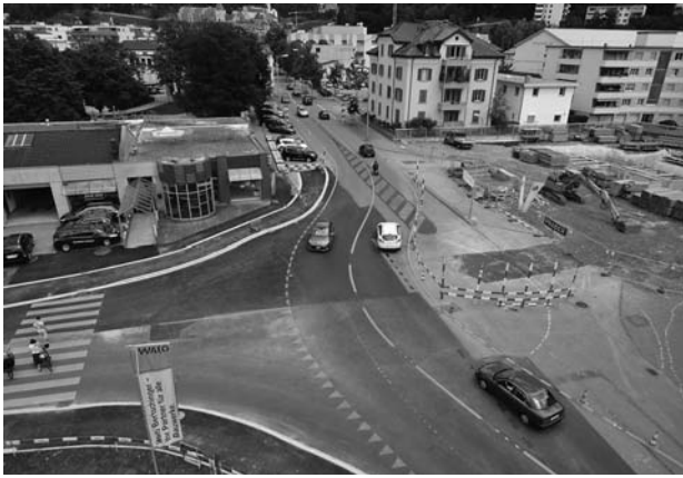
Verkehrsumleitung während der Bauarbeiten.
