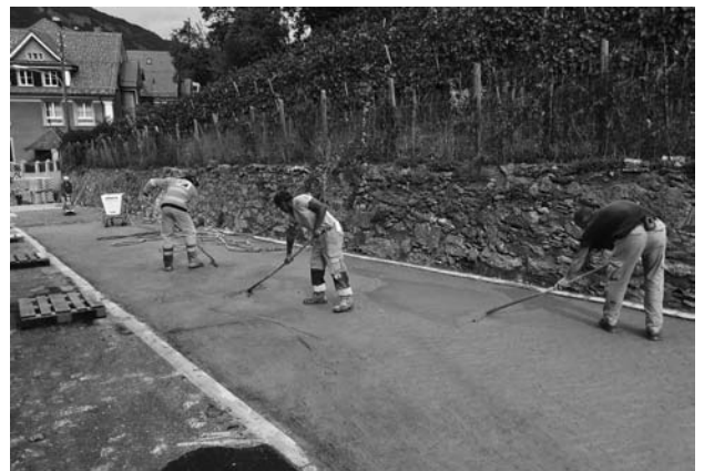
Ausfügen der Pflästerung mit Traskalk.
