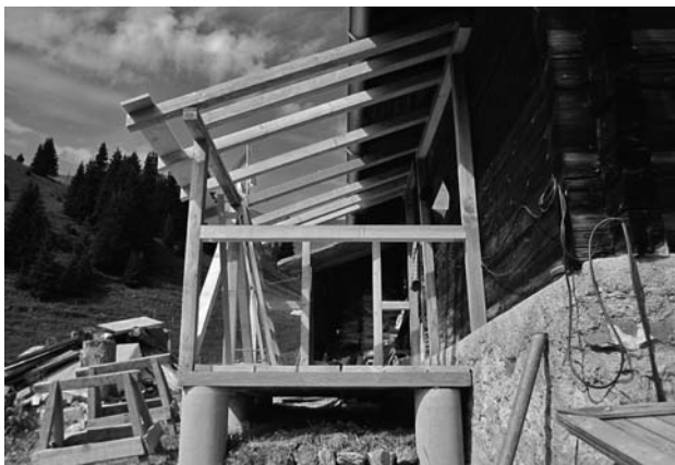
Der neue Holzschopf für die Alphütte Campadiel im Rohbau.
