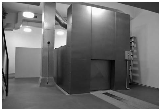
Neuer Ofen im sanierten Ofenraum.
