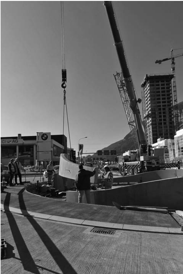
Versetzen der Brunnenelemente.
