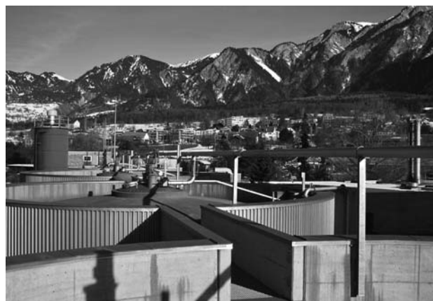
Die neu erstellte Gasleitung über den Faulräumen.
