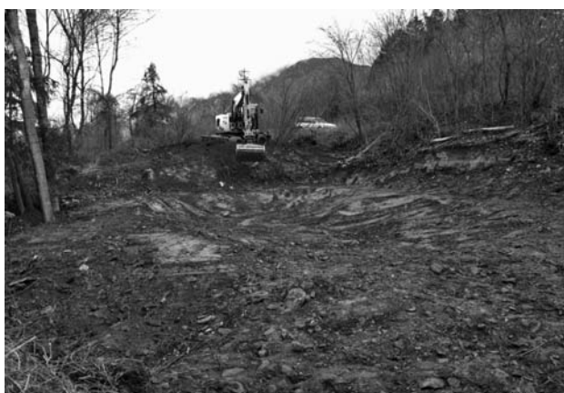
Weihermodellierung mit Hydraulikbagger.
