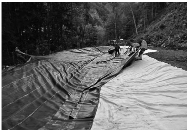
Verlegen der Weiherfolie.
