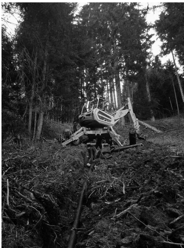
Verlegung von neuen Leitungsrohren für die Entwässerung Erlenrutsch im Gebiet Weisse Hütte.
