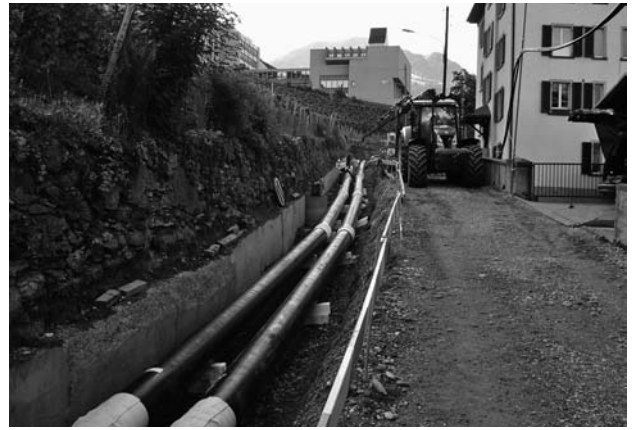
Fernwärme-Leitungsbau.
