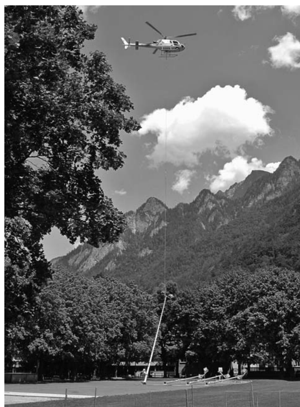
Versetzen der Kandelaber mit Helikopter.
