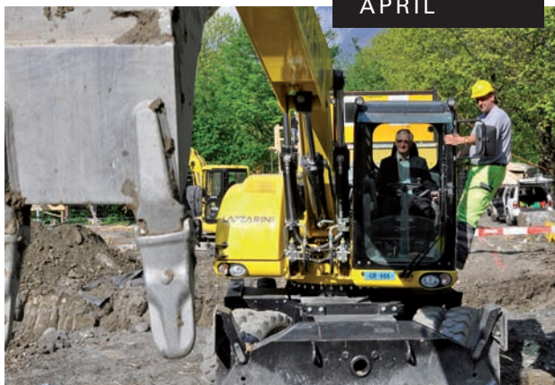
Spatenstich zum Erweiterungsbau des Schulhauses Quader; «Baggerführer» Stadtrat Roland Treppe lanciert den Spatenstich.
