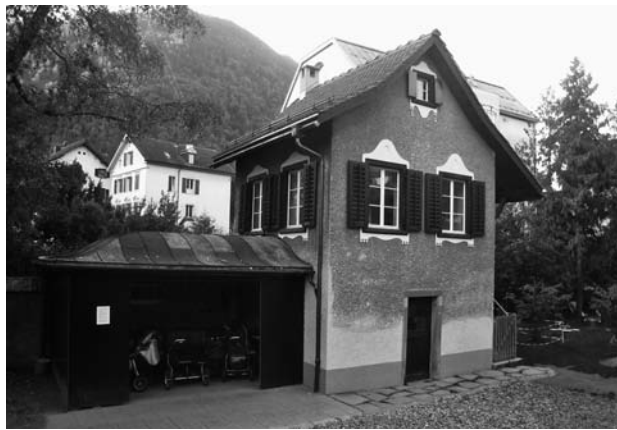
...und nach der Renovation.
