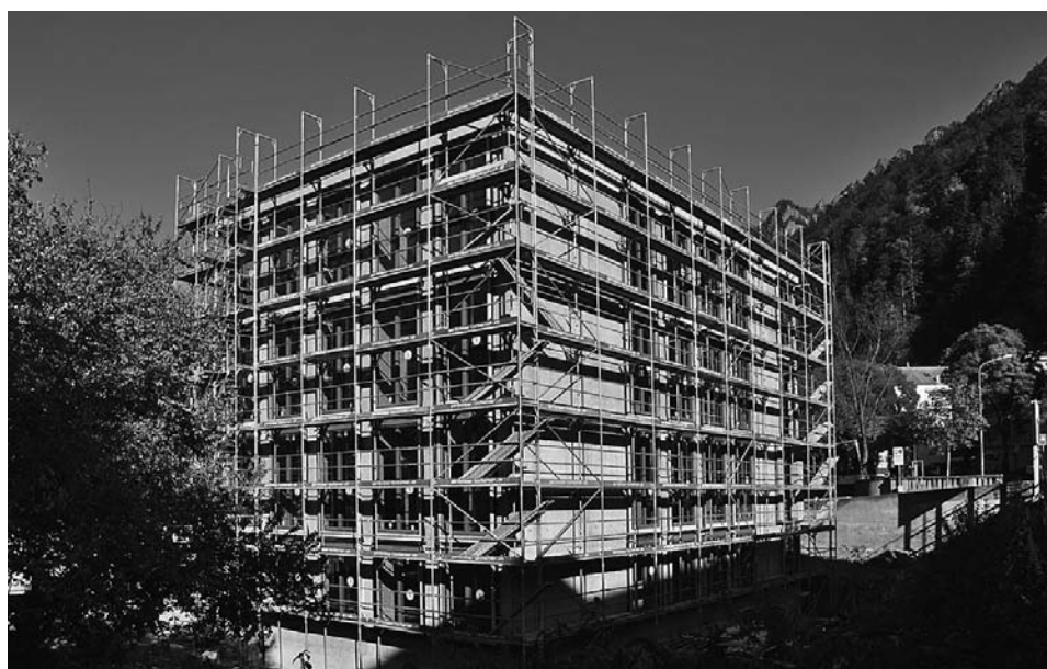
Im Rohbau im Herbst fertiggestellt. Jetzt folgt noch der Innenausbau.
