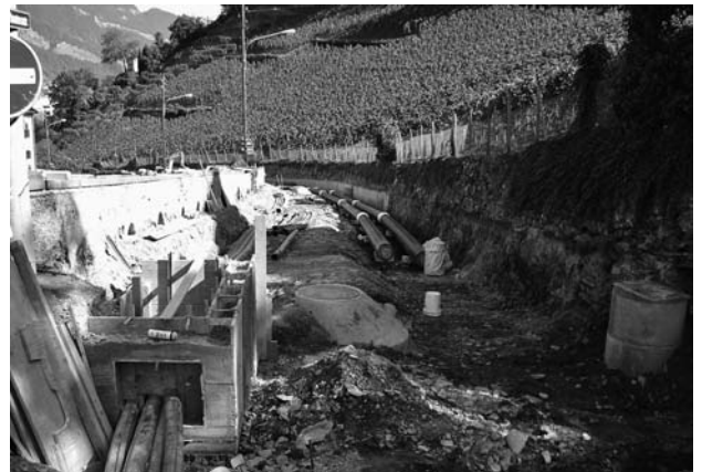
Fernwärme- und Werkleitungsbau.
