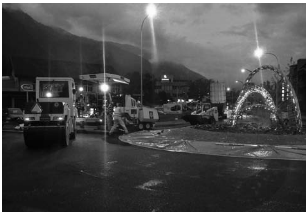
Einbau Deckbelag Ringstrasse, Kreisel Felsenaustrasse.
