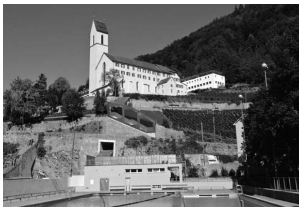
Treppenverbindung zwischen den Kantonsschulen Halde und Cleric, Freibad Sand.
