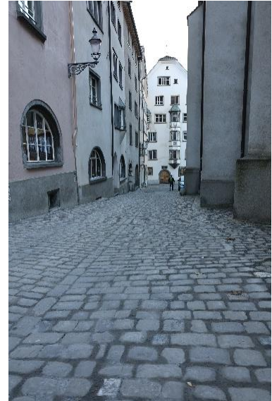
Sanierte Pflasterung in der Kirchgasse
