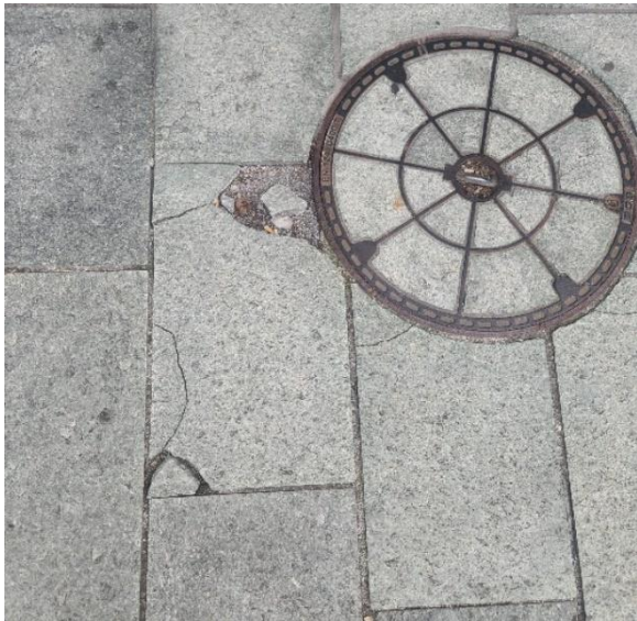
Gerissene Plattenbeläge
