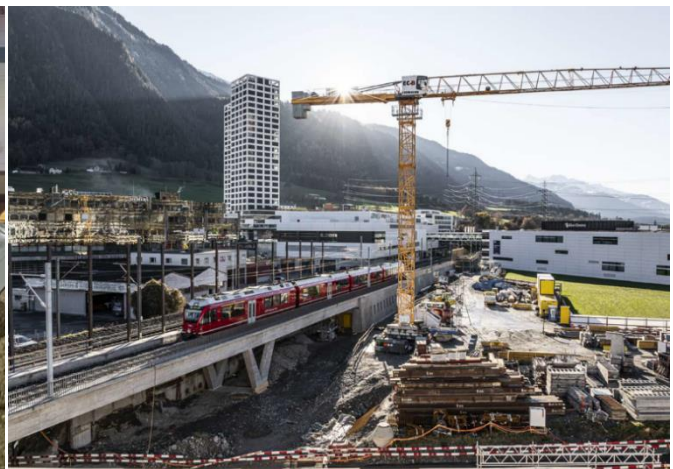
Stützbauwerk mit neuem Bahngleis
