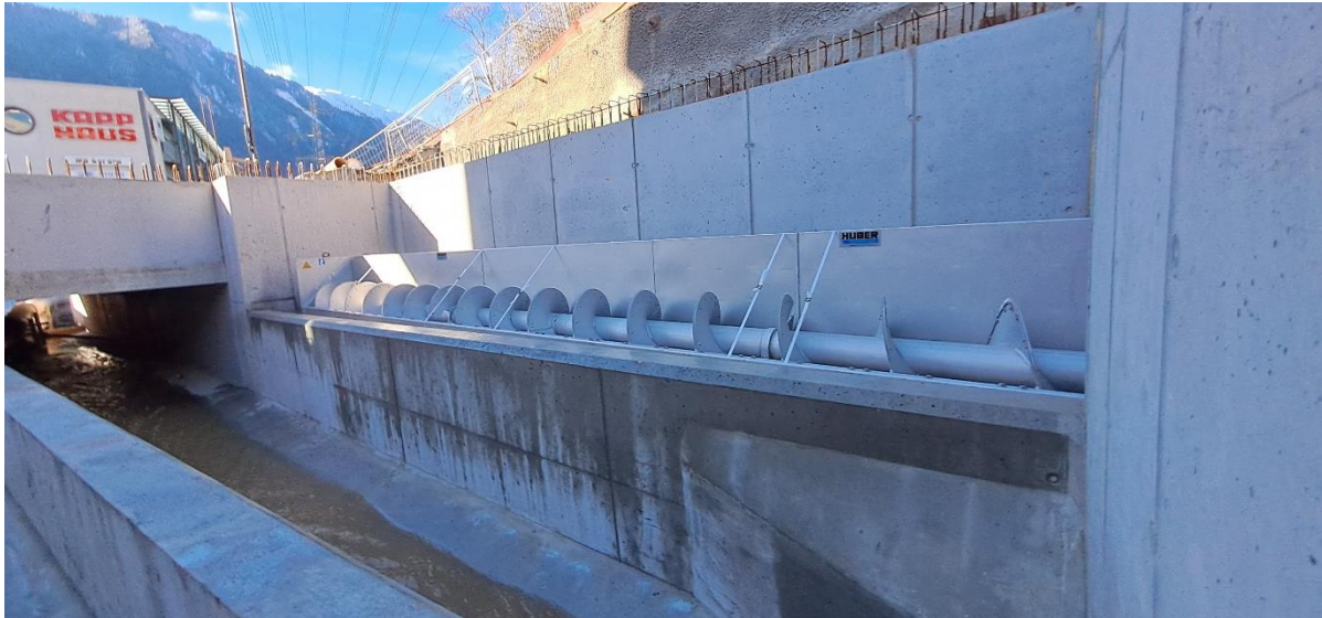
Einbau mechanische Vorreinigung HE116
