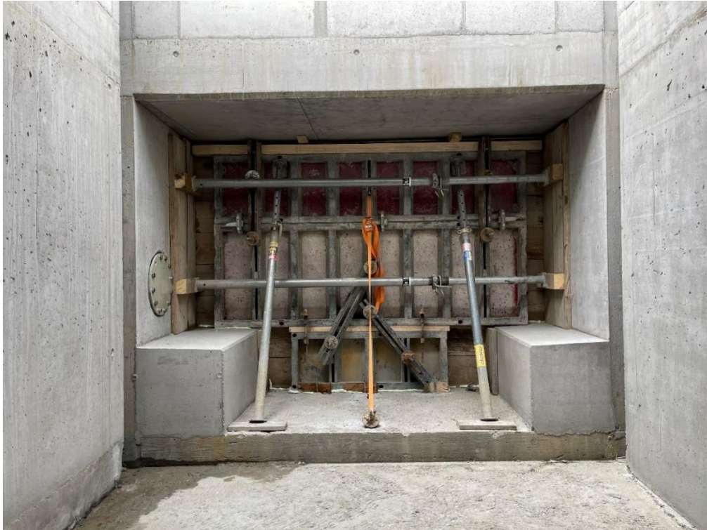
Abschottung im neuen Einlaufbauwerk zum Hauptsammelkanal
