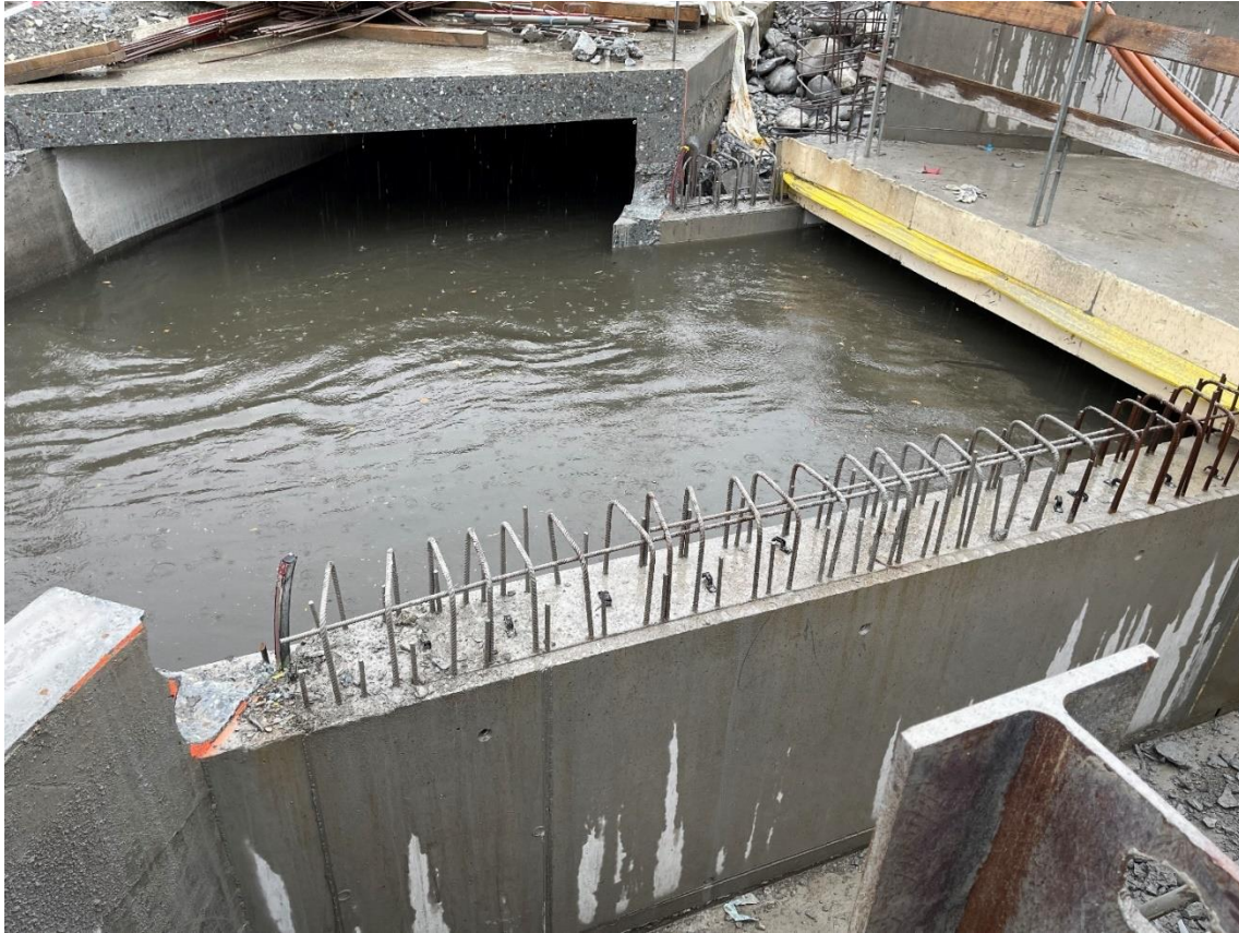
Niveau Abwasser im Zulaufkanal zum Regenbecken während der Bauarbeiten
