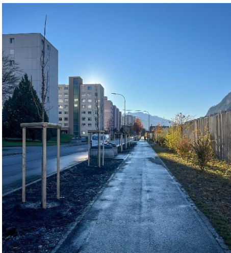
Neue Baumreihe Austrasse mit Retentionsstreifen
