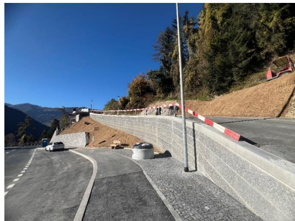
Sanierte Stichstrasse Sax und Stützmauer Sax, neben sanierter Arosastrasse inkl. Postautohaltestelle
