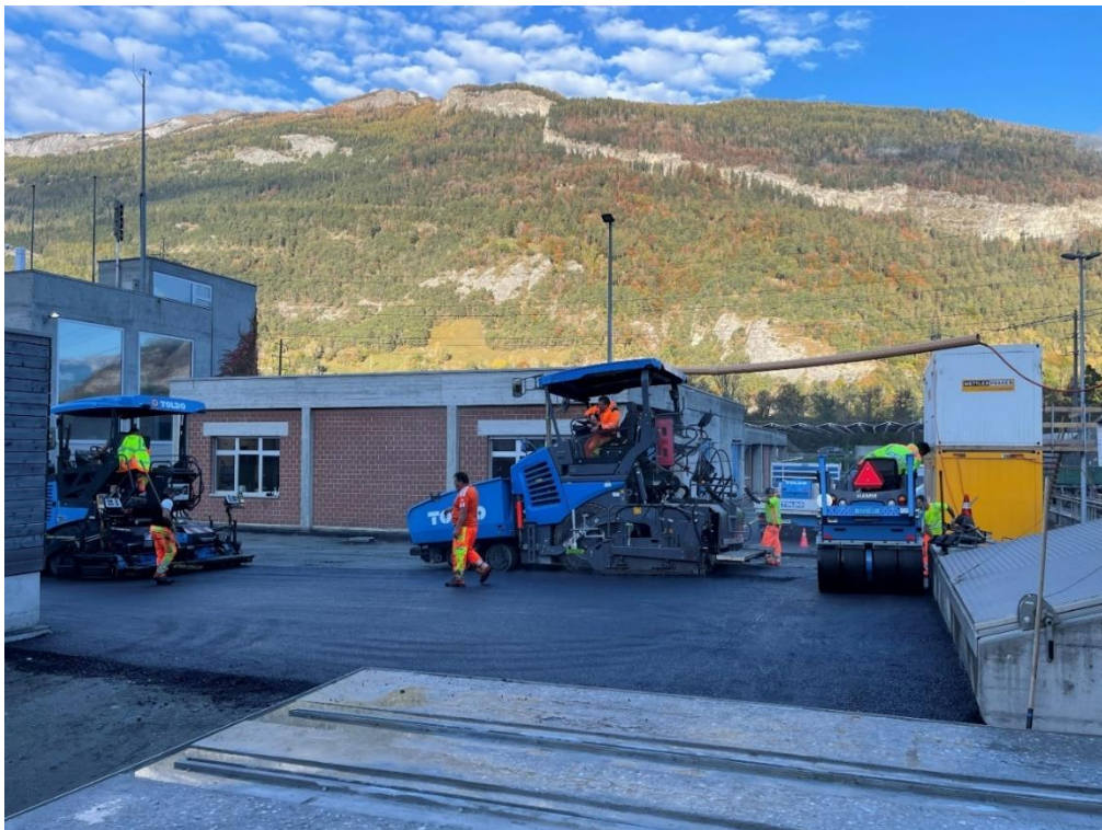
Belagsarbeiten Zufahrtbereich Areal ARA
