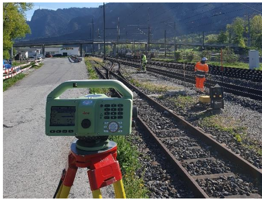
Rheinstrasse Trimmis, Setzungsmessungen RhB Gleise
