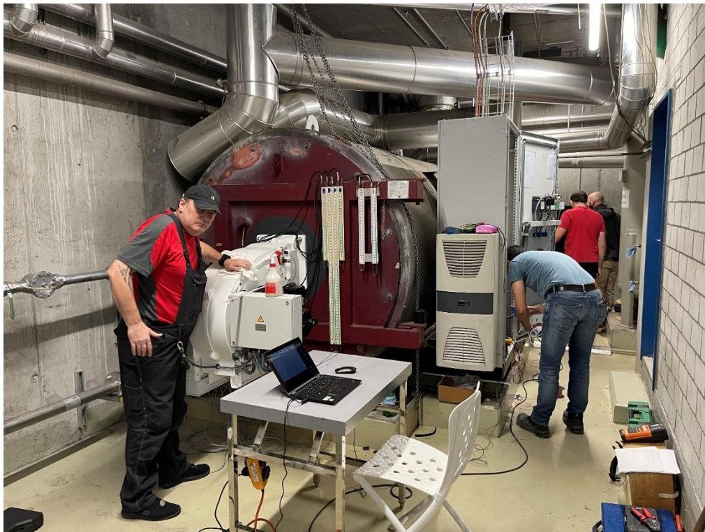
Reinigung und Inbetriebnahme des neuen Gasbrenners
