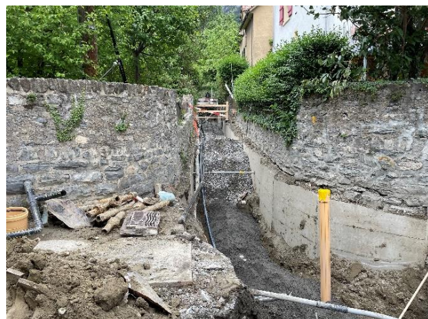
Werkleitungsbau auf engstem Raum (Lachenweg)
