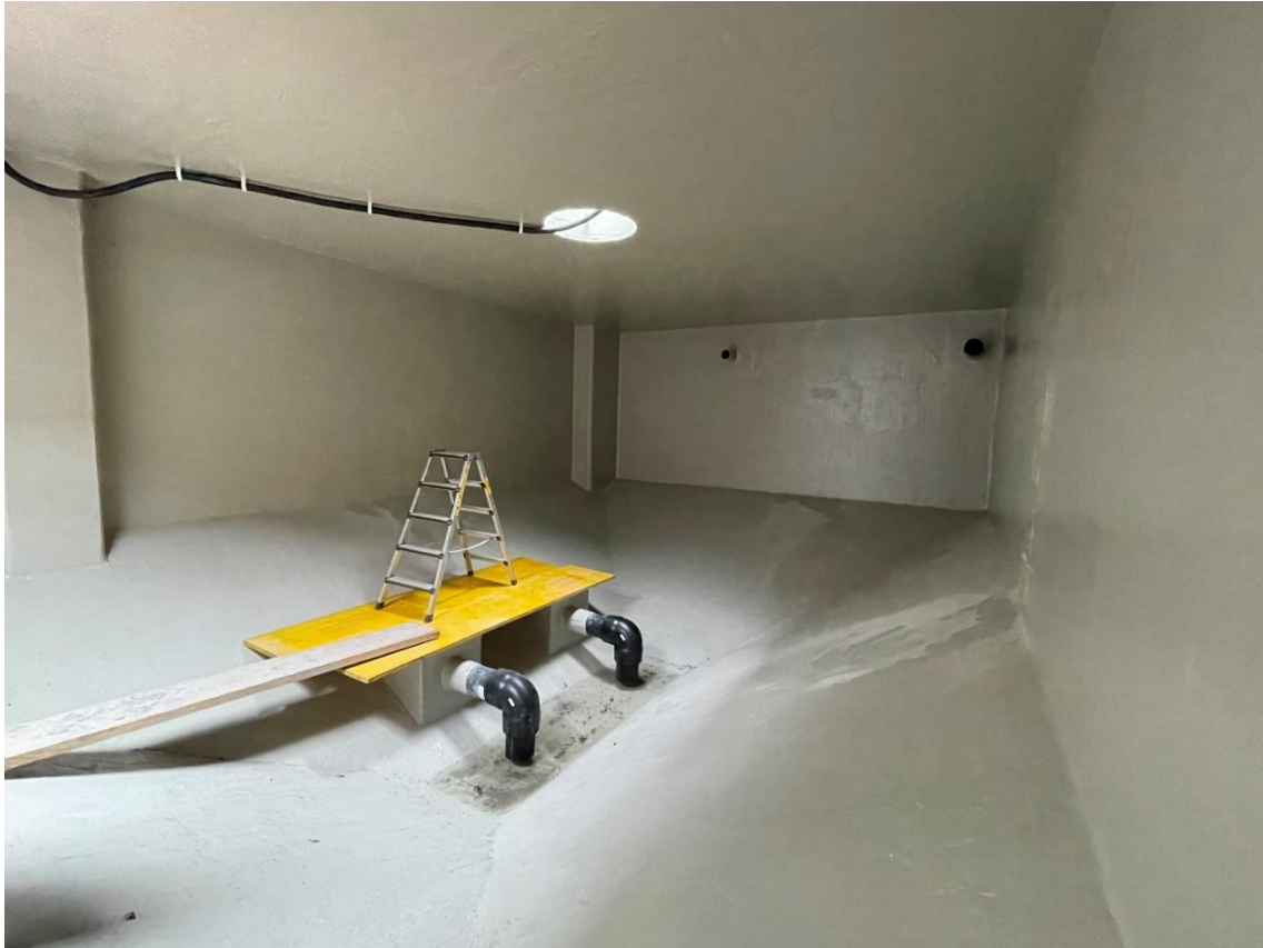
Fremdschlammschacht nach Betonsanierung und mit neuer Beschichtung
