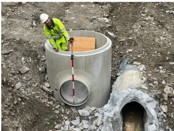
Giacometti- /Wiesentalstr., Aufnahme Abwasserschacht
