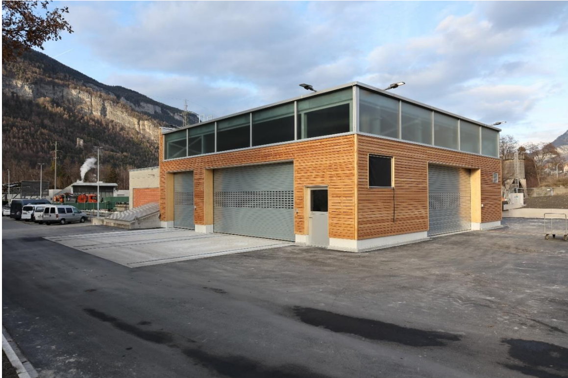
Rechengebäude isoliert mit Holzverschalung und Lichtband, PVA auf dem Flachdach
