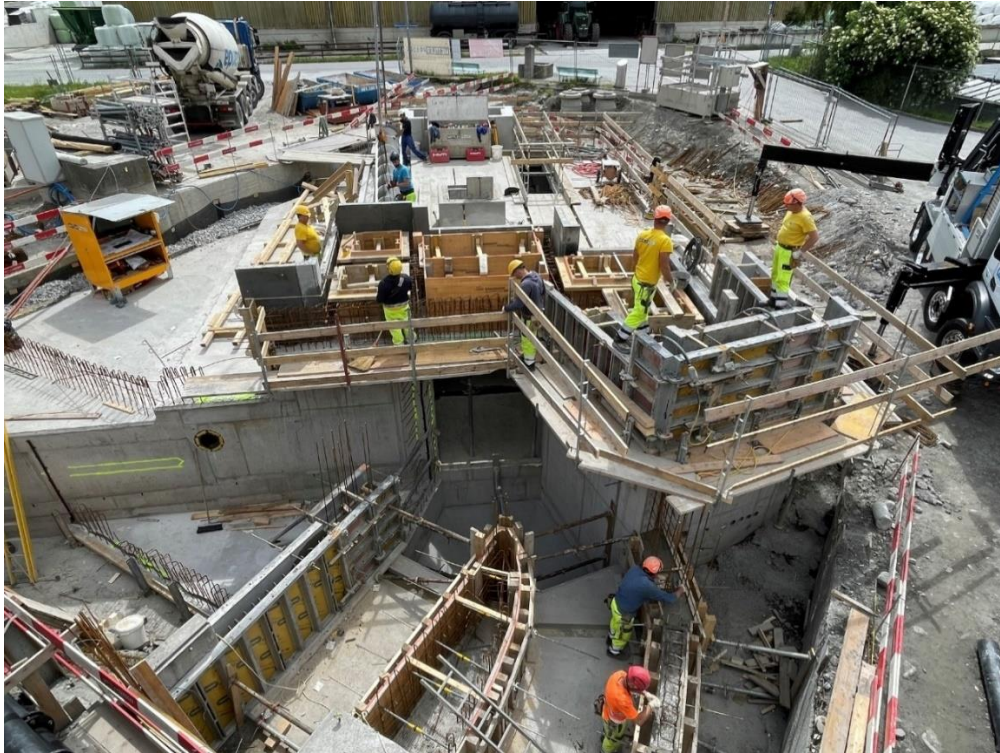
Schalungsarbeiten Einlaufbauwerk und Zulaufbereich ARA Strasse 1 + 2
