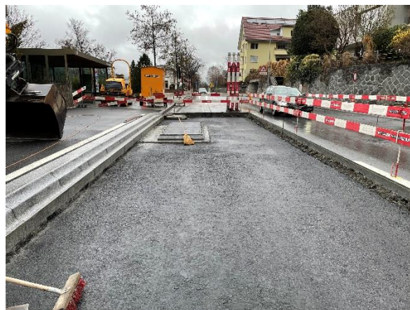
Bushaltestelle Kreuzspital vor Schalungsarbeiten der Betonfahrbahn
