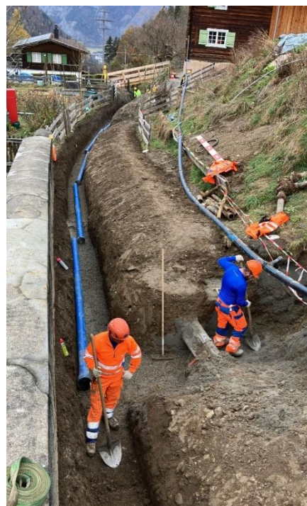
Werkleitungsbau Maladers, Churerweg
