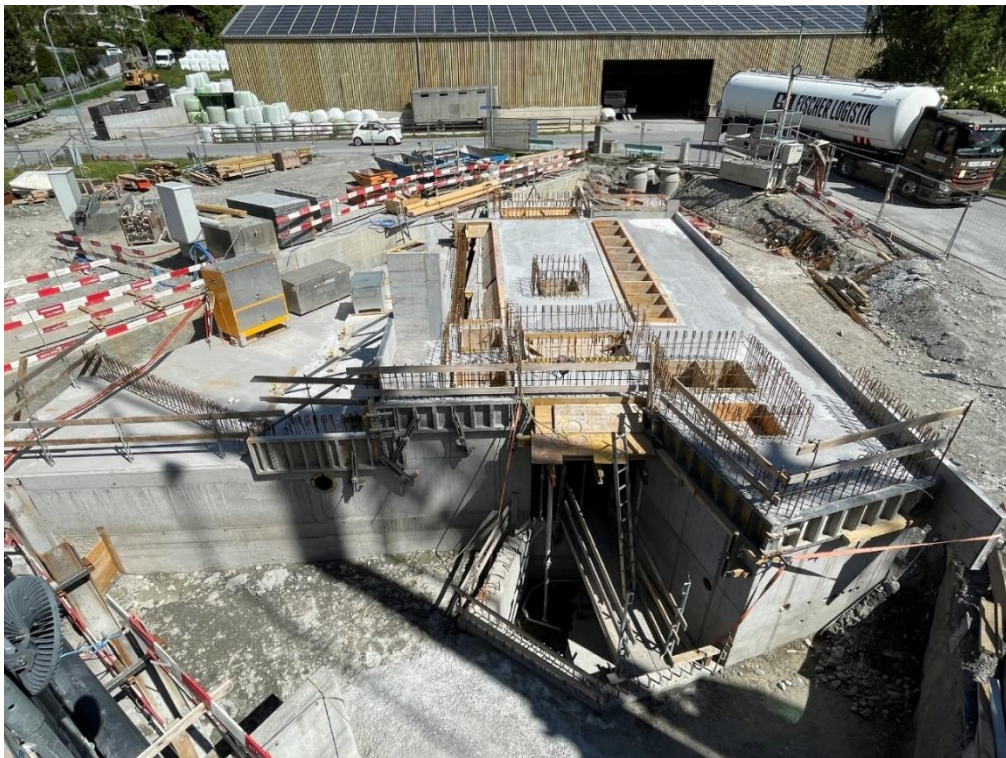
Decke Kanal Regenbecken mit Öffnungen Siebanlage und Zustiege
