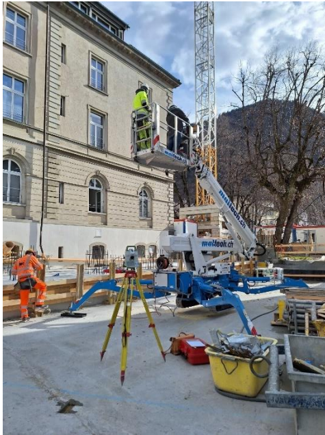
Staatsgebäude, Absteckungen für Stahlbau
