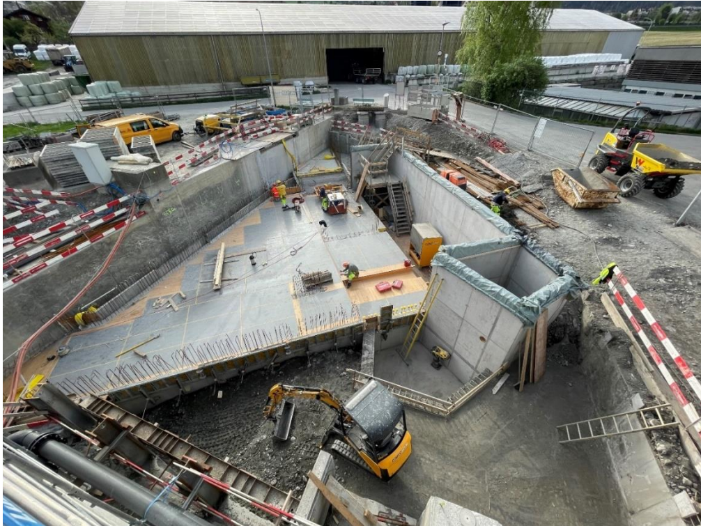
Schalung Decke Einlaufbauwerk UG bzw. Boden zum Regenbecken
