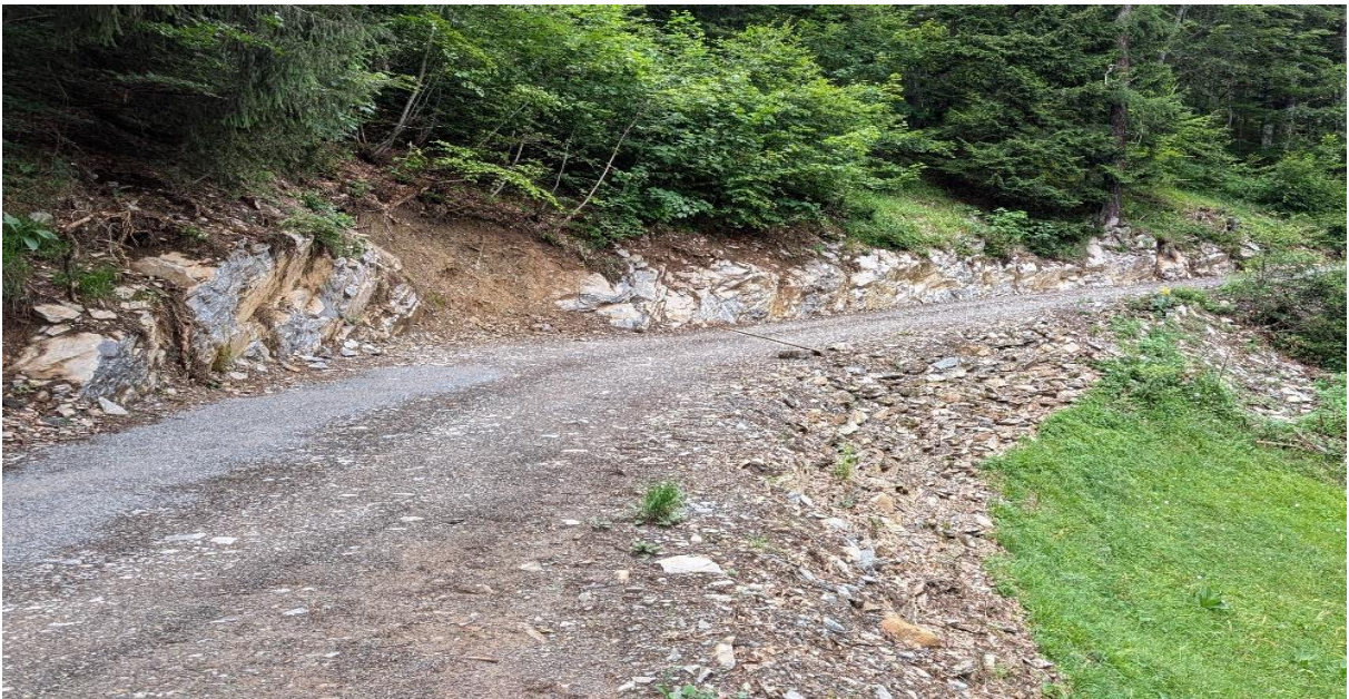
Wegunterhalt Heraberg. Das abgetragene Material wurde vor Ort verwendet
