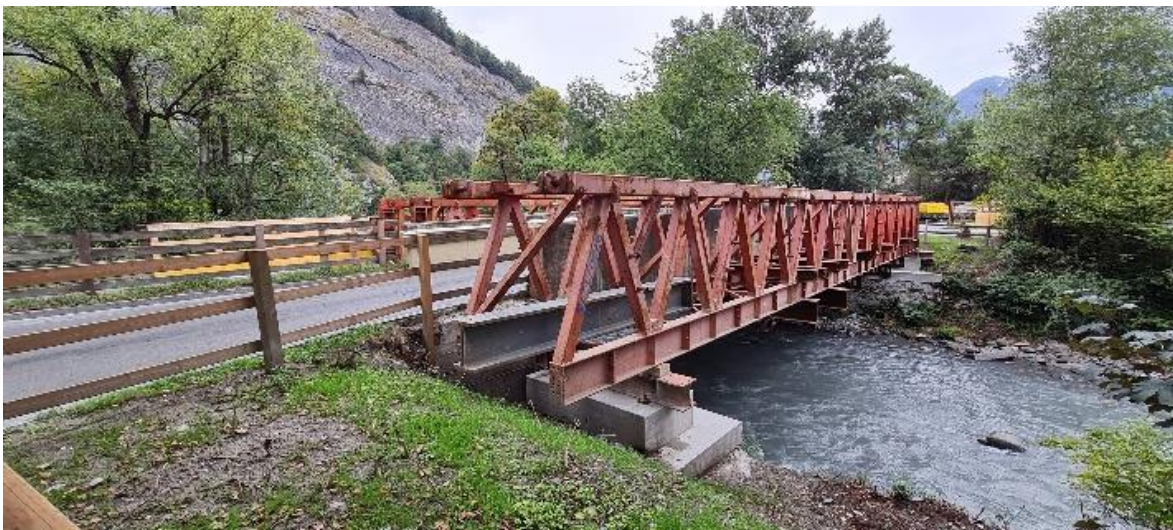
Aubrücke mit Lehrgerüst
