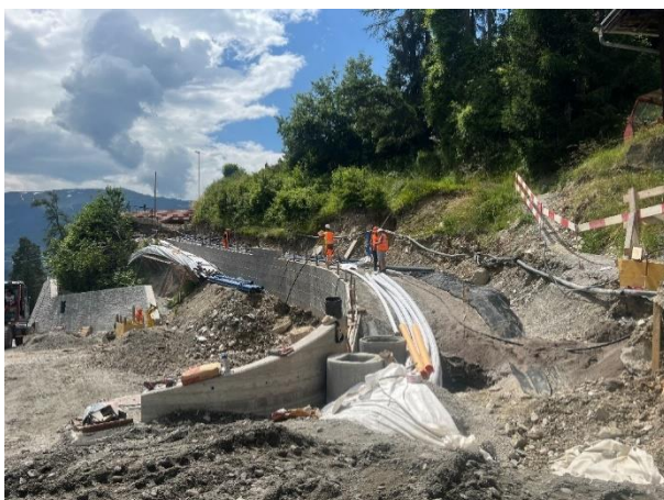
Werkleitungsbau und Bau talseitige Stützmauer
