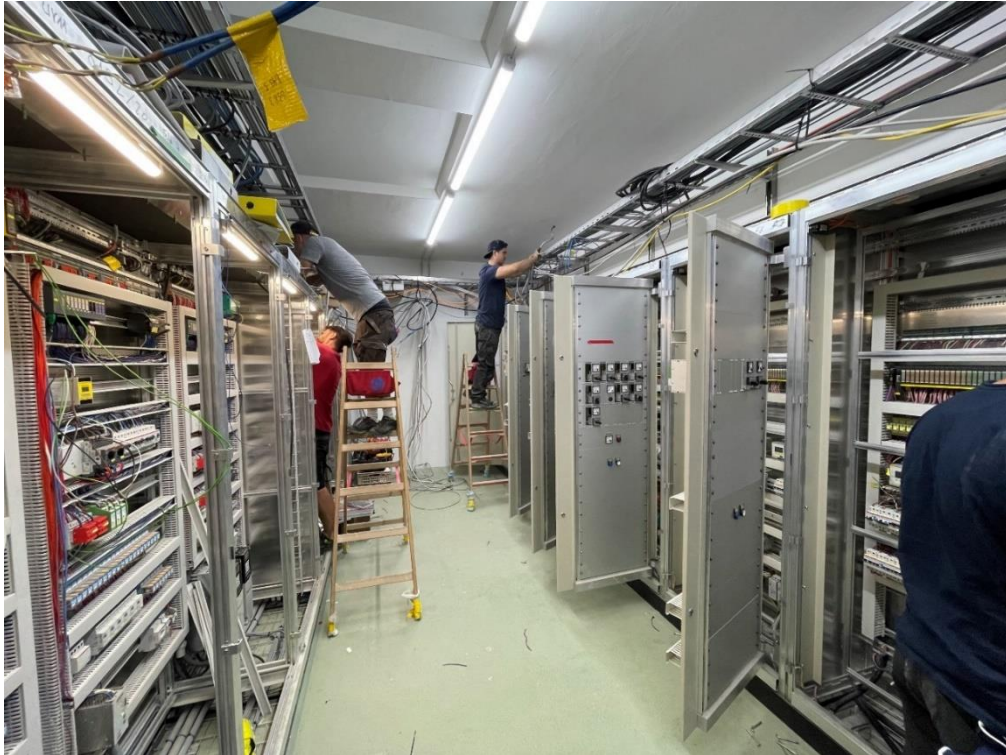
Ausserbetriebnahme der alten UV rechts und gleichzeitiger Inbetriebnahme der neuen UV links
