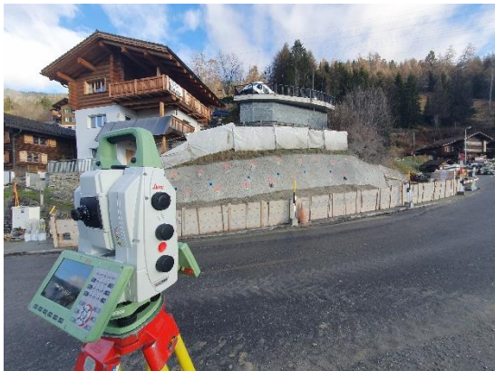
Sax Maladers, Überwachungsmessungen Stützmauer
