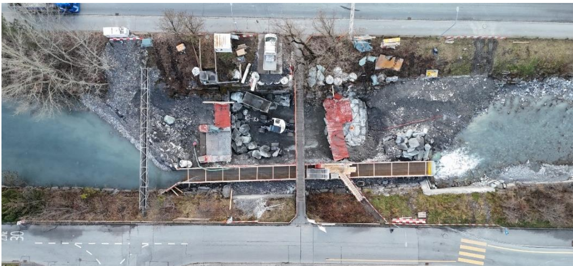
Plessur Hochwasserschutz bei Niedrigwasser in den Monaten November bis spätestens März
