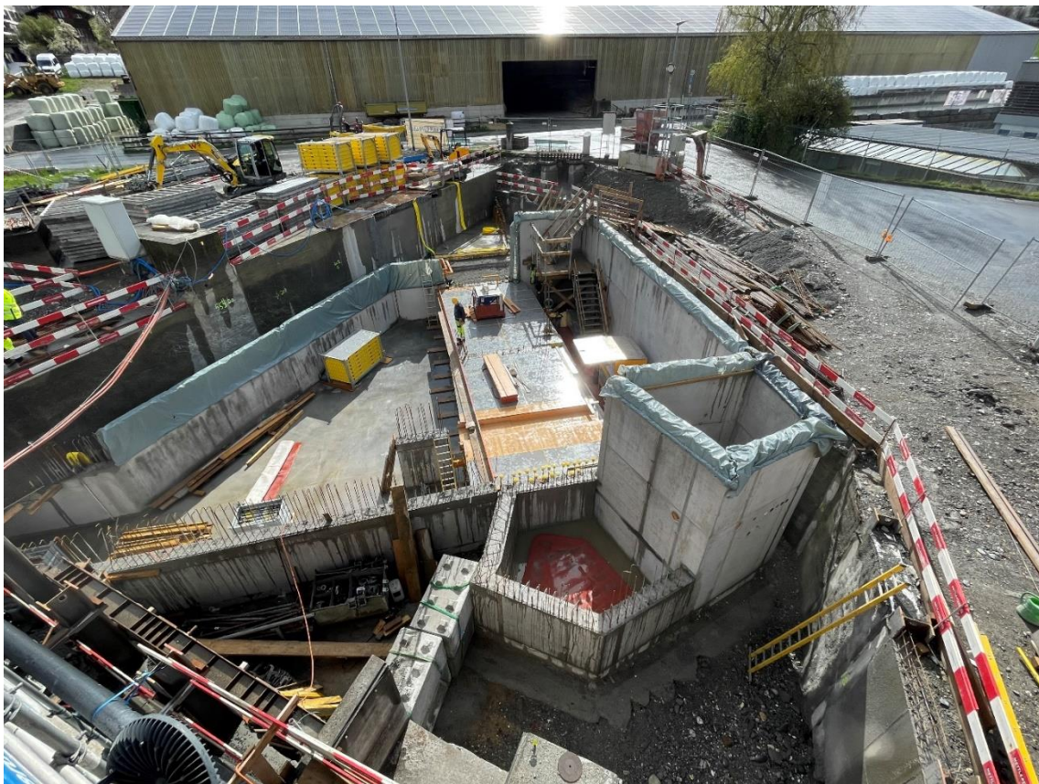
Einlaufbauwerk UG mit Stein-/Kiesfang
