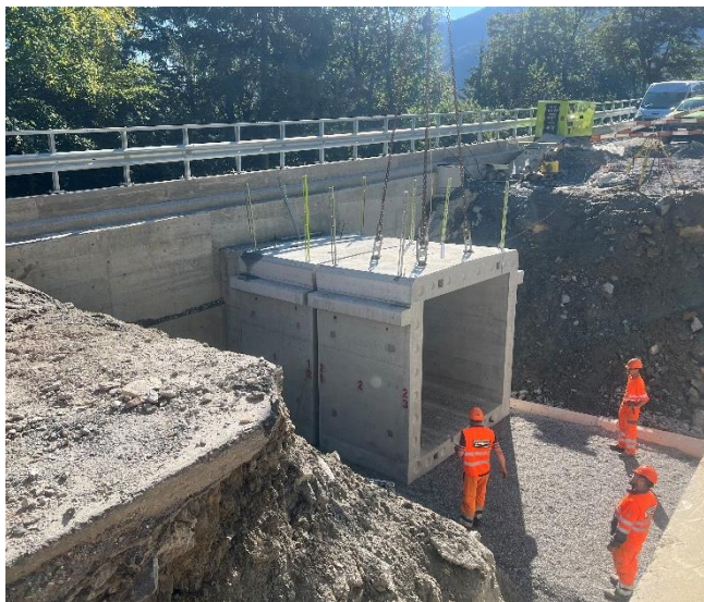
Einbau der vorfabrizierten Betonelemente
