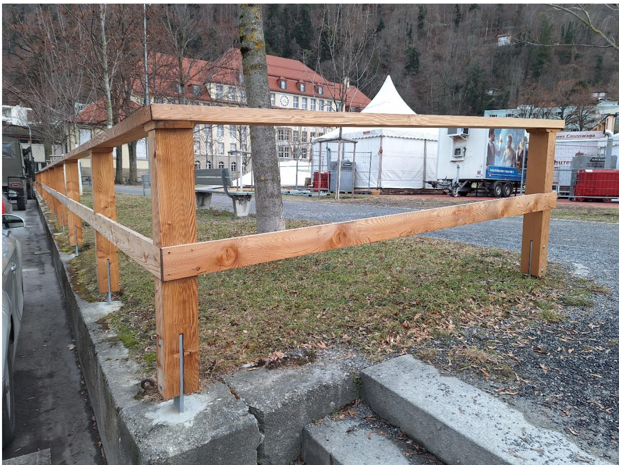
Neuer Holzzaun bei Quaderwiese mit einbetonierten Metallfüssen
