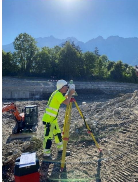
Überbauung Töbeli, Ausführungskontrolle Baugrube
