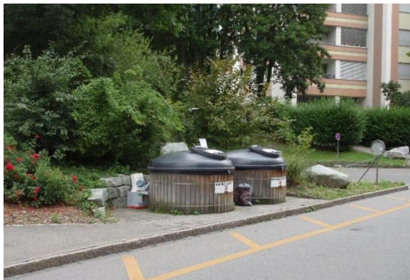
Alte nicht behindertengerechte Moloks
