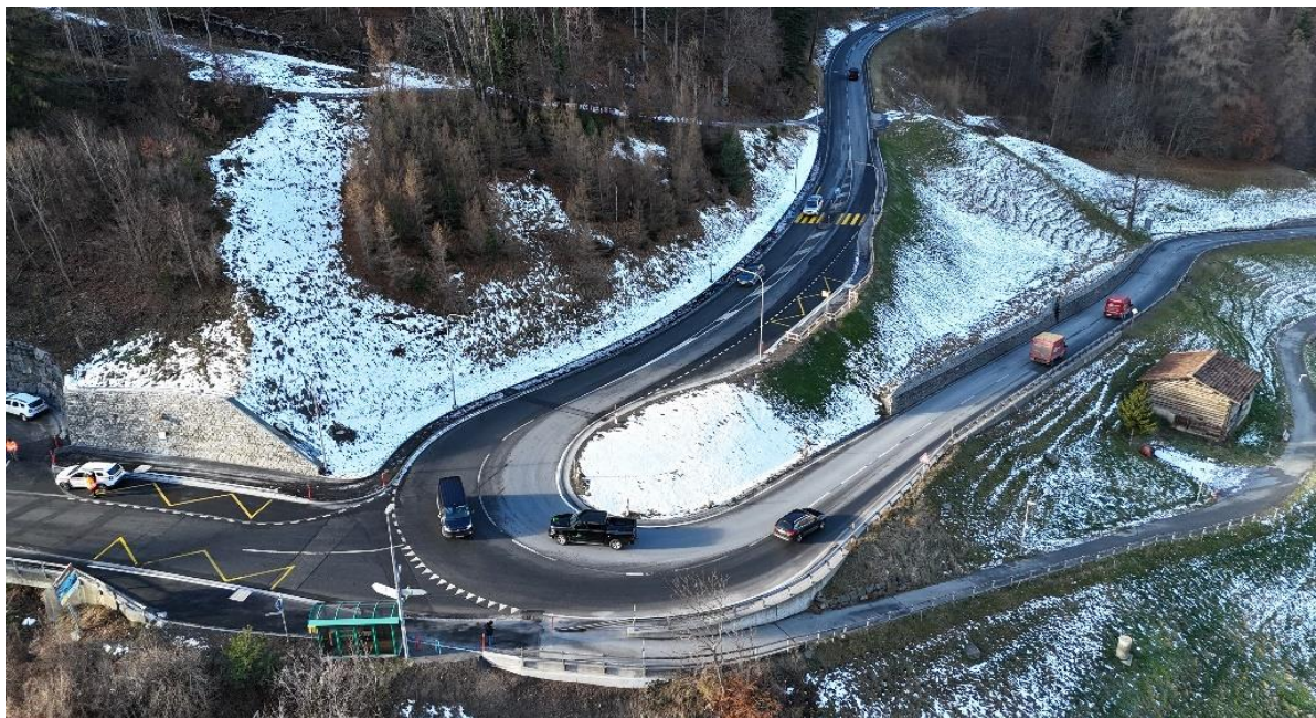
Übersicht Gesamtbauwerk Araschgerrank
