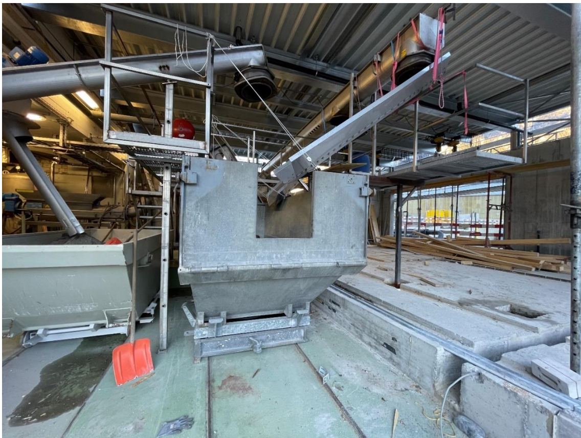
Provisorium Grobstoffaustrag während Bauarbeiten der 1. Etappe
