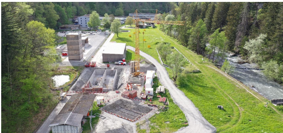
Baumeisterarbeiten Regenbecken Maladers inkl. Trennbauwerk
