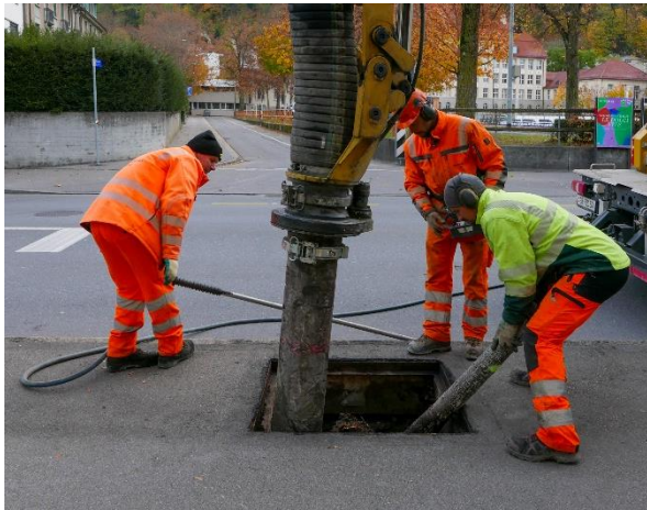
Vorbereitung der Ersatzpflanzung in einer Baumgrube, entfernen Baumstrunk und altes Substrat mit dem Saugbagger
