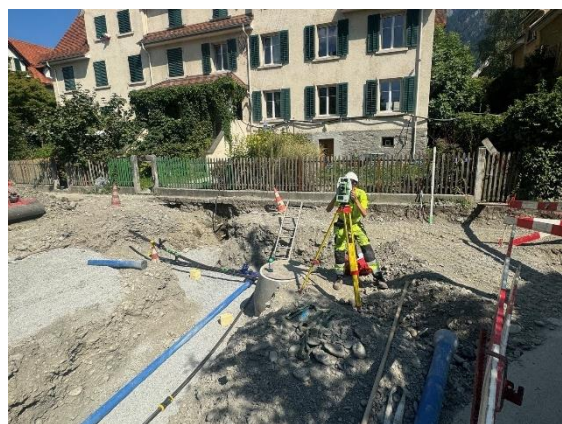
«Stampagarta», Aufnahme Wasserleitung und Gasleitung
