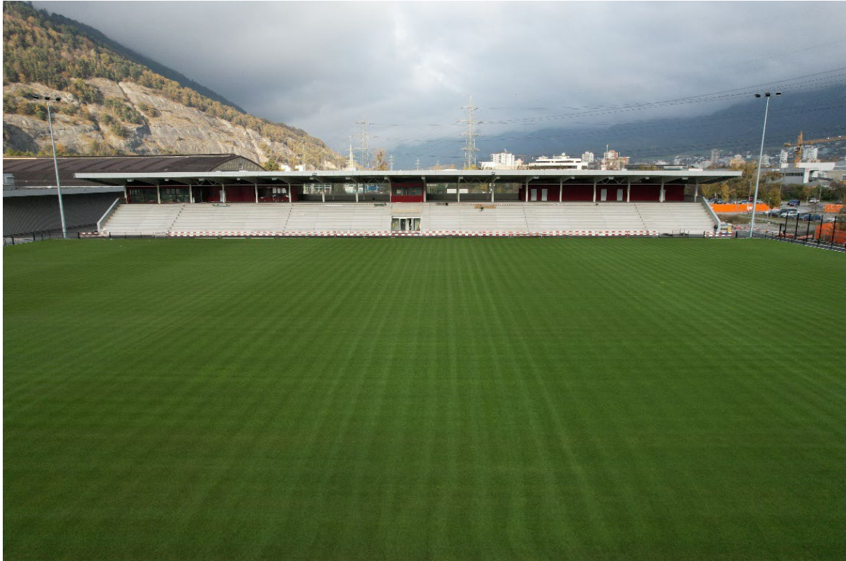
Bau Tribünengebäude mit Naturrasenplatz Nr. 1
