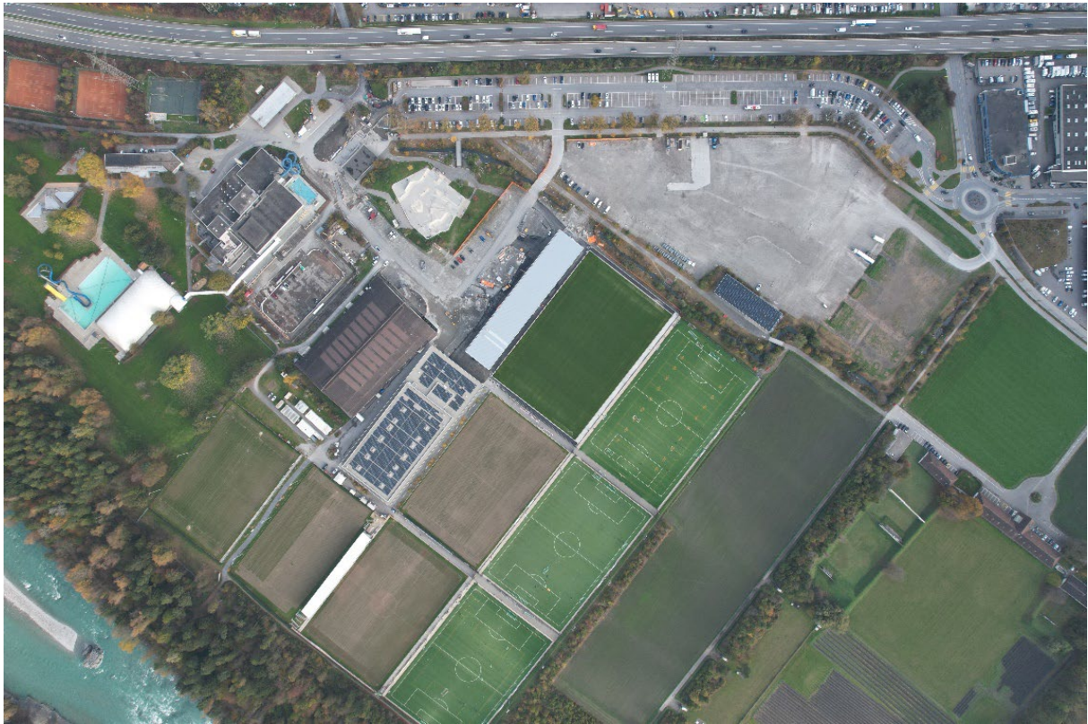
Luftbild Areal Sport- und Eventanlagen November 2024
