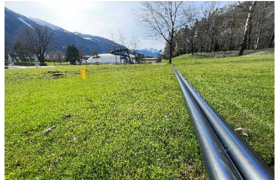
Installation Bewässerungsanlage Freibad Obere Au
