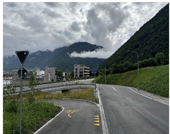
Zufahrt in die Umfahrung Süd von der Triststrasse
