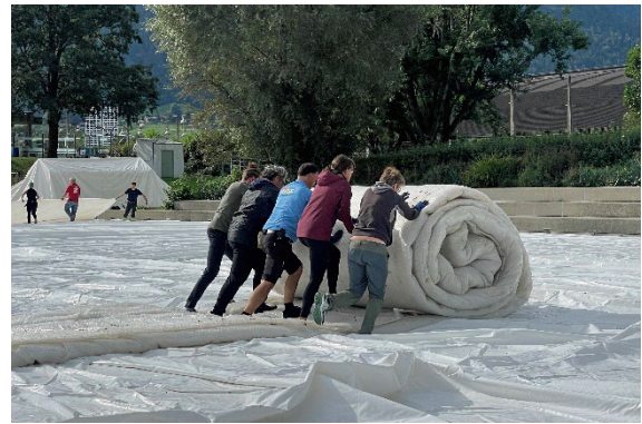
Aufbau Traglufthalle 50m Becken Obere Au
