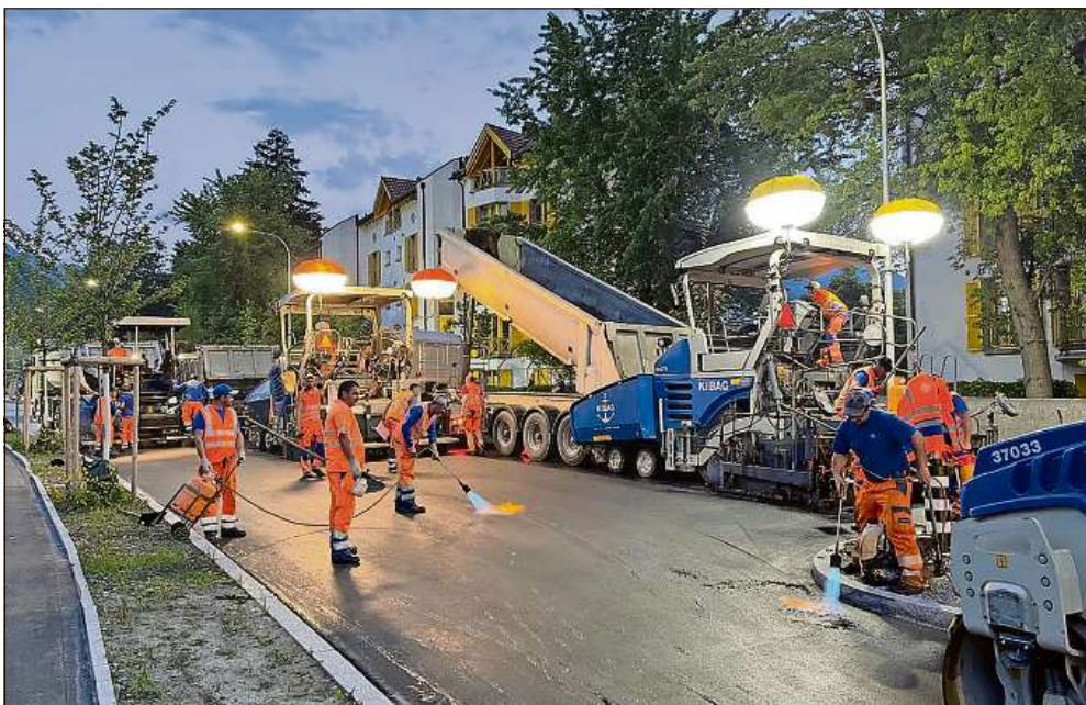
Diese Woche erfolgte der Einbau des Deckbelags Masanserstrasse, im Abschnitt Weisstorkelgasse – Kreisel Scalärastrasse.
