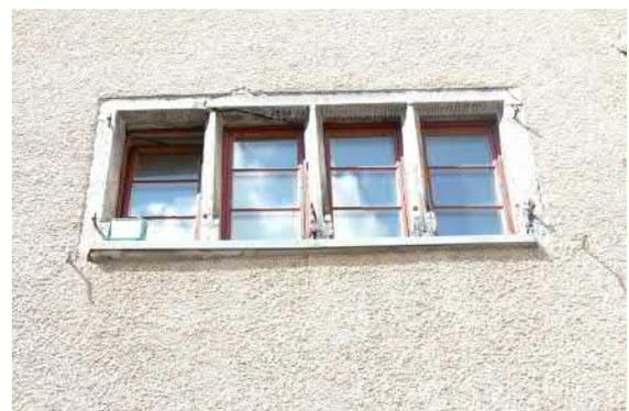
*Detailaufnahme Fenster 2. Obergeschoss (Risse und Substanzverlust an den Voluten)*
