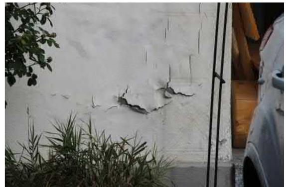
*Schaden an der Hauswand durch falsche Materialwahl bei der letzten Renovation*
