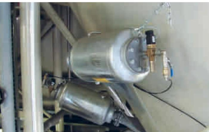
*An den Silowänden montierte Luftstossgeräte*
