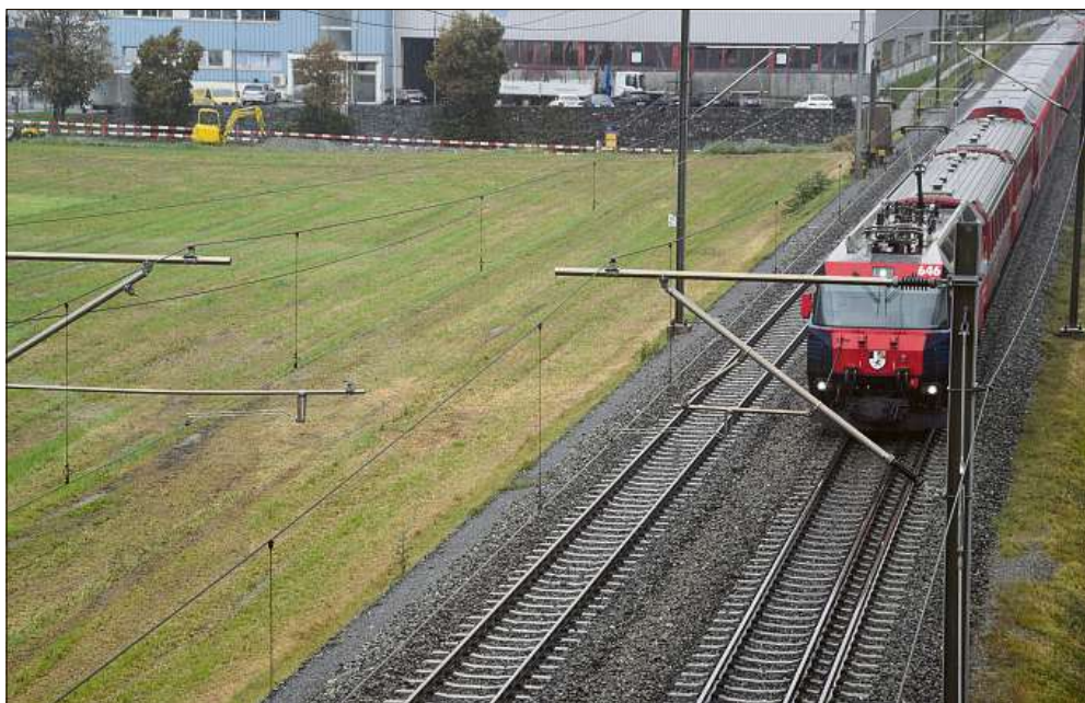
Am kommenden Montag starten die ersten Bauarbeiten am neuen Bahnhof Chur West. Die ersten Bagger sind schon aufgefahren.
