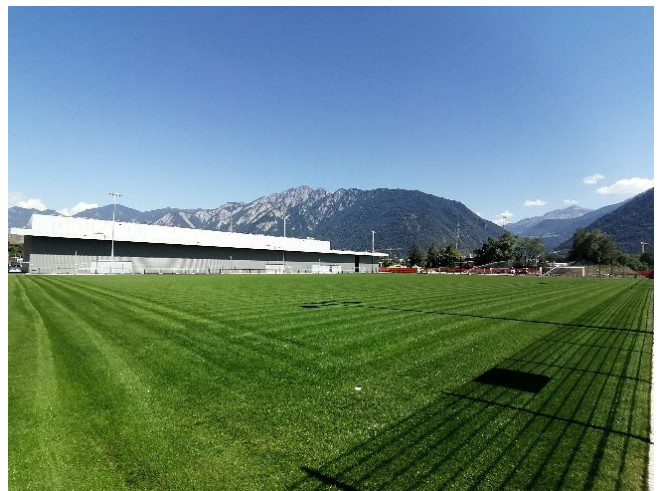
Ansicht Süd Trainingshalle und Rasensportanlage
