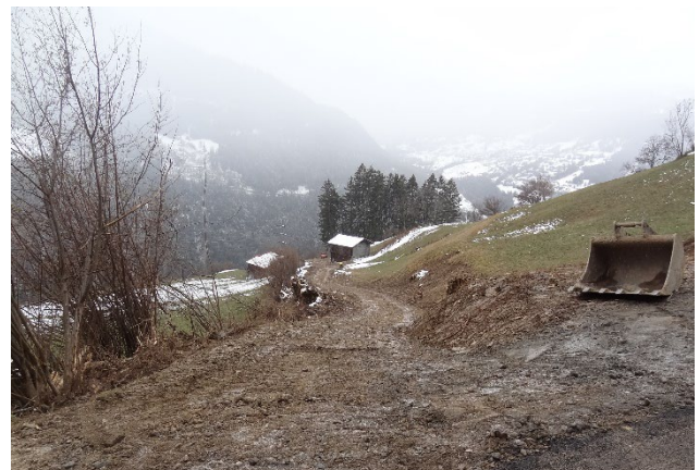
Instandstellung Gelände nach Einbau der Leitung
