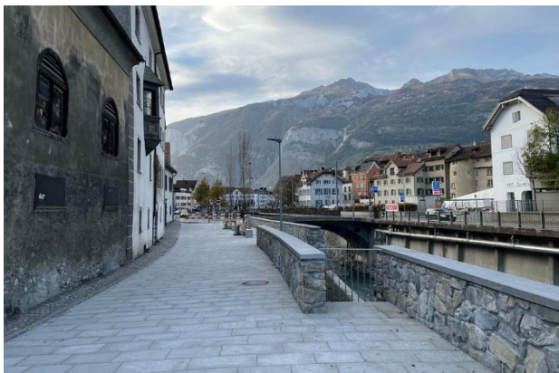
Bodmerstrasse Richtung Metzgerbrücke
