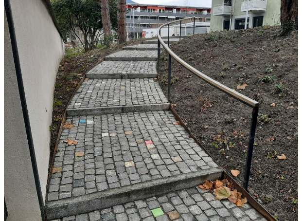
Neuer Zugang von der Oberalpstrasse in den Friedhof Daleu
