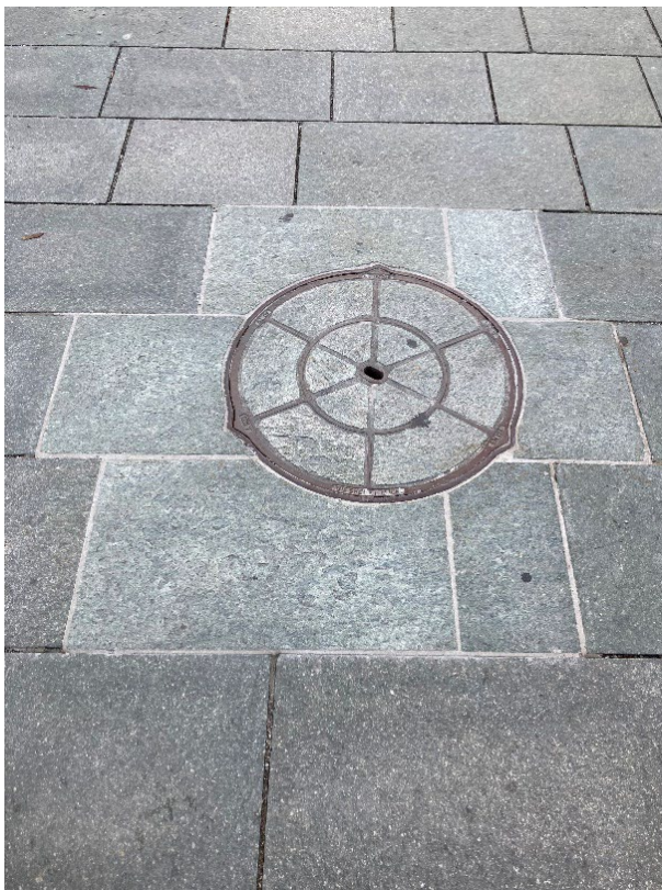
Sanierte Schachtumrandung
