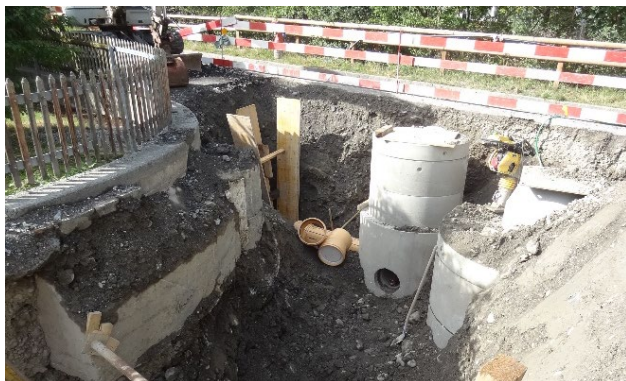
Neue Abwasser- und Meteorwasserschächte
