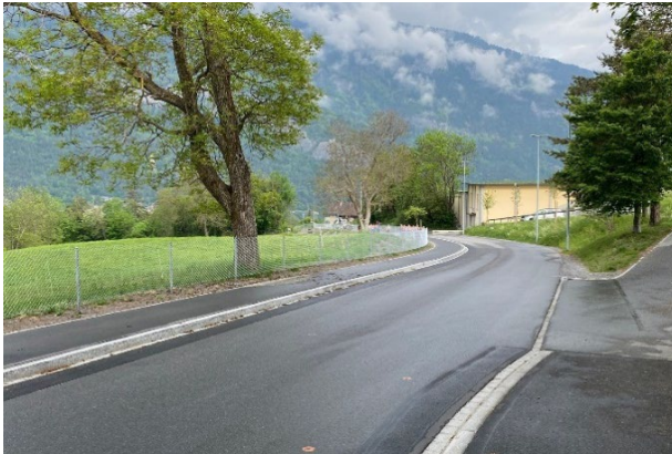
Fertig erstelltes Trottoir Blickrichtung Jüstliweg
