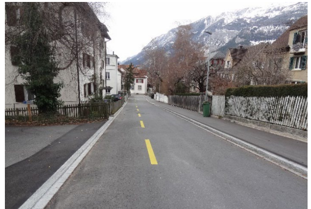
Splügenstrasse nach Fertigstellung
