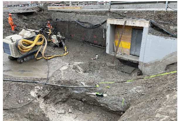
Tristweg, Baugrubensicherung bei Unterführung
