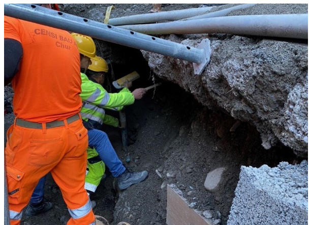
Unterfangung der bestehenden EW Leitungen
