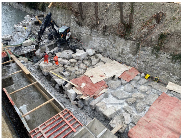
Erstellung der Blockrampe
