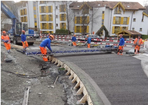
Betonieren Einlenker Kreisel
