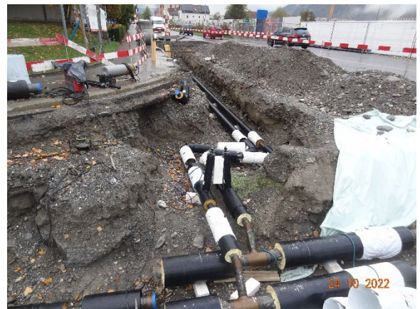
Neubau Fernwärmeleitung der IBC
