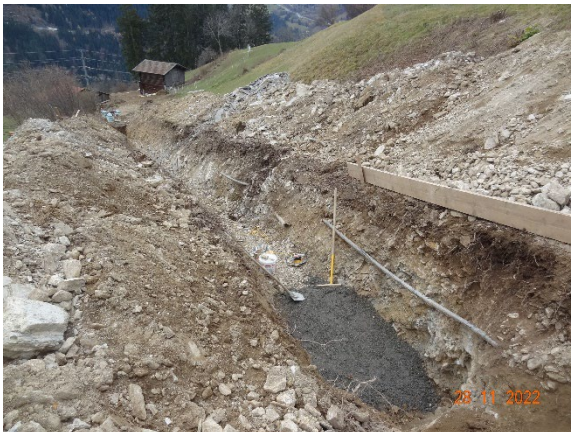
Graben für die neue Abwasserleitung
