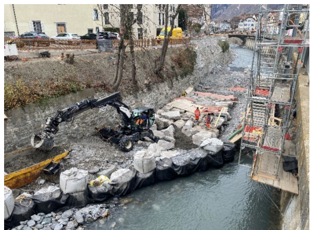
Umleitung der Plessur mittels Sandsäcken
