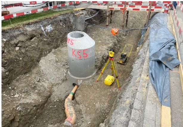
Erstellen Abwasserleitung
