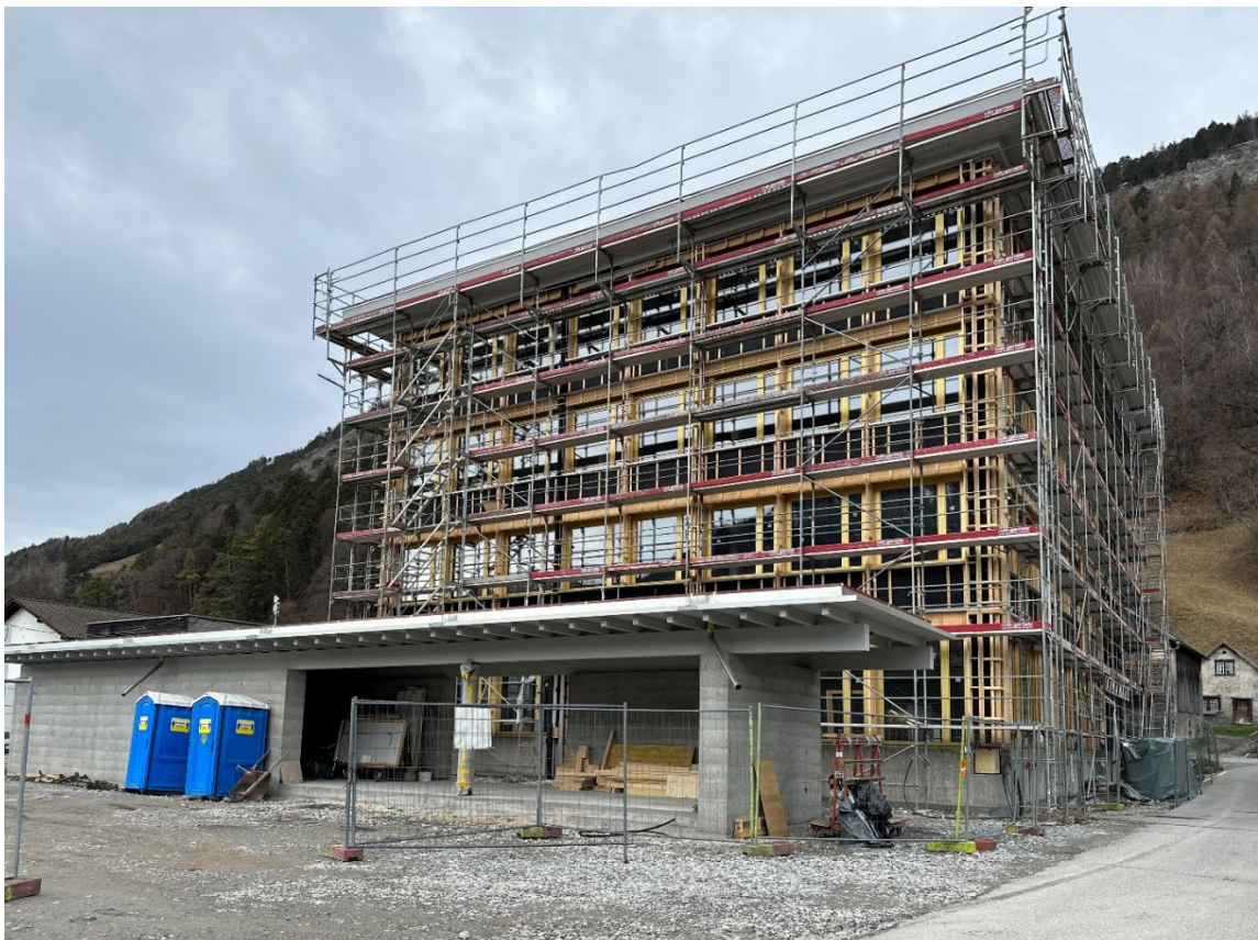
Südwestfassade Schulhausneubau Haldenstein mit Velounterstand in Stampfbeton
