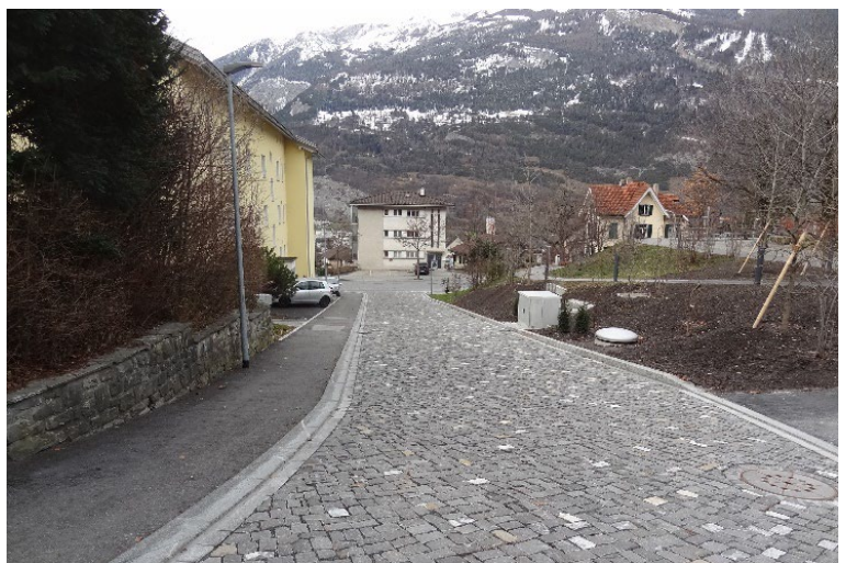
Neue Pflasterung mit Guber Natursteinen
