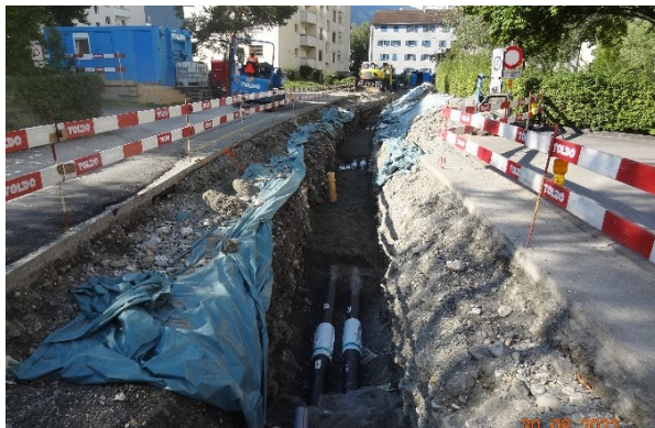
Verlegen Fernwärme Sardonastrasse
