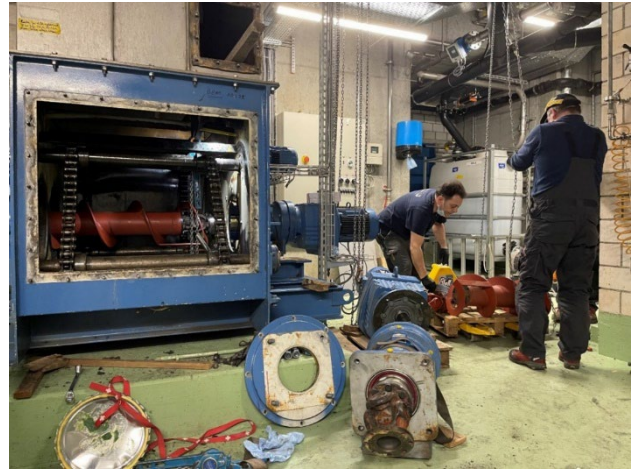
Revision Dickschlammtrichter Dekanter
