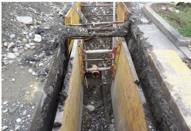
Neubau Abwasserleitung Ringstrasse
