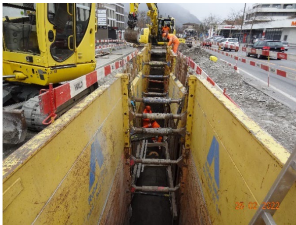
Abwasserleitung Höhe Hof Masans
